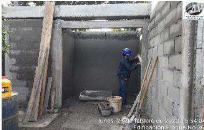
PAÑETES MUROS INTERNOS
