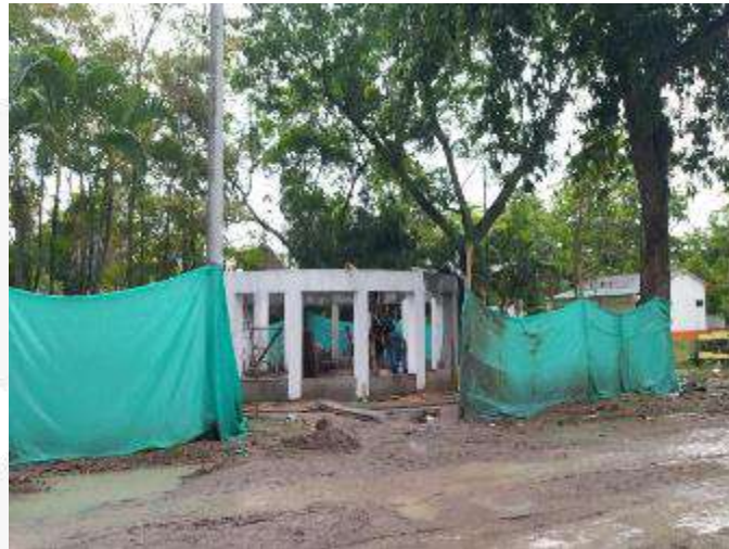
ADECUACION Y CONFORMACION TERRENO AREA DE CAJAS Y DESAGUES
