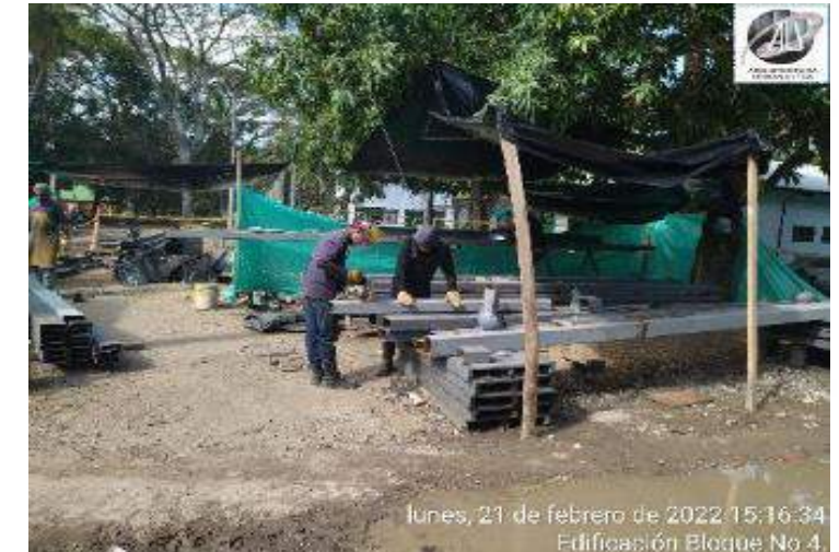
FABRICACION ESTRUCTURA METALICA
