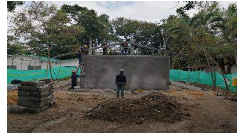
INSTALACION DE ESTRUCTURA METALICA
