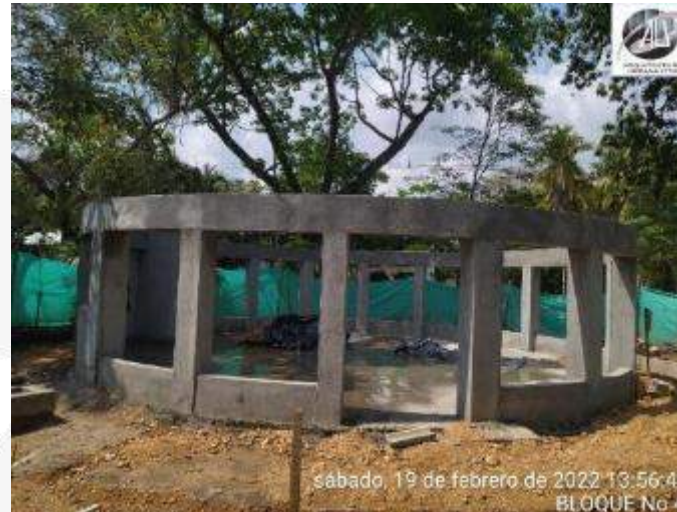
PAÑETES DE ESTRUCTURA Y MAMPOSTERIA
