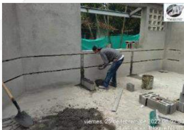
CONSTRUCCION DE ESTRUCTURA SOPORTE MOVILIARIO
