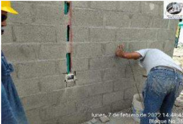
INSTALACION TUBERIA Y CAJAS ELECTRICAS
