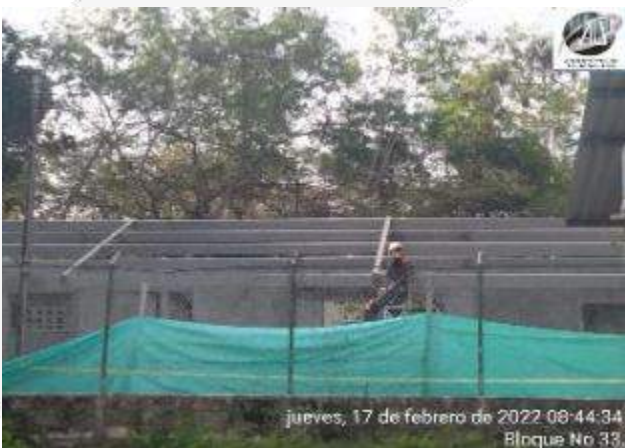
INSTALACION ESTRUCTURA METALICA CUBIERTA
