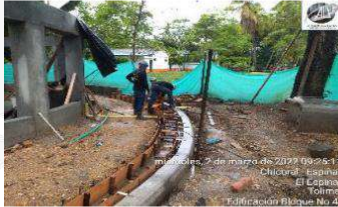
ENCOFRADO Y CONSTRUCCION CARCAMO PERIMETRAL
