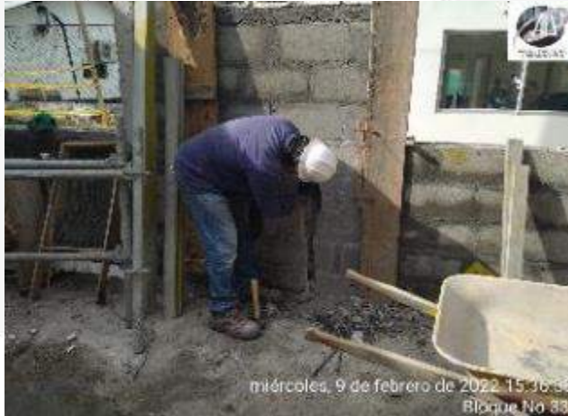
CONSTRUCCION DE COLUMNETAS DE CONFINAMIENTO MAMPOSTERIA
