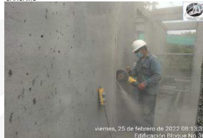
CORTE Y REGATA PARA INSTALACION TUBERIA HIDRAULICA Y ELECTRICA
