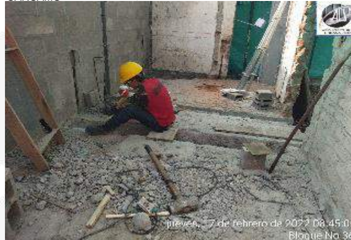
REGATA PARA INSTALACION TUBERIA HIDRAULICA
