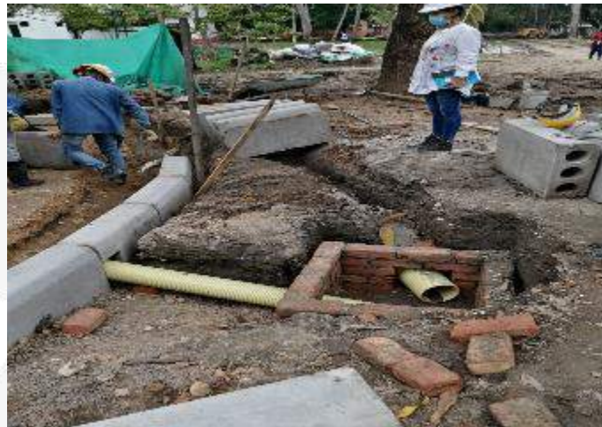
INSTALACION TUBERIA NOVAFORT Y CONSTRUCCION CAJA DE INSPECCION DRENAJE CARCAMO
