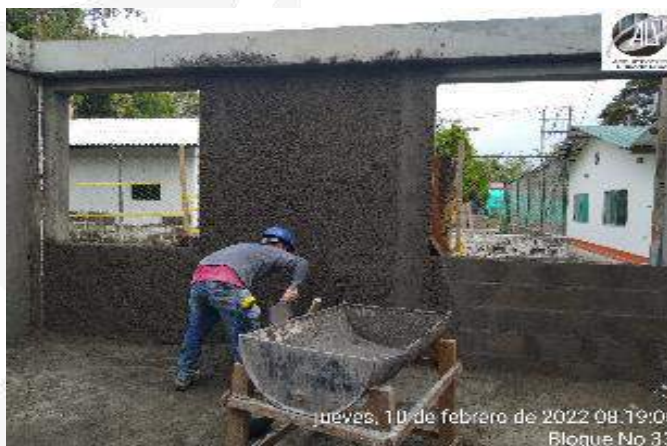
PAÑETES DE MUROS INTERNOS
