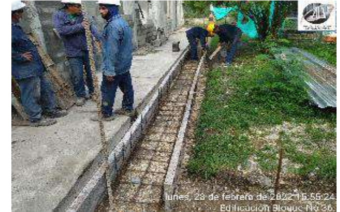
INSTALACION ACERO DE REFUERZO CARCAMO PERIMETRAL
