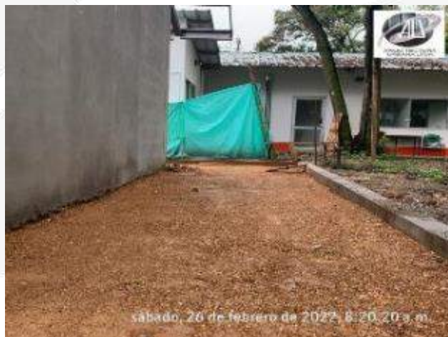
RELLENO Y CONFORMACION TERRENO PARA CONSTRUCCION ANDEN PERIMETRAL
