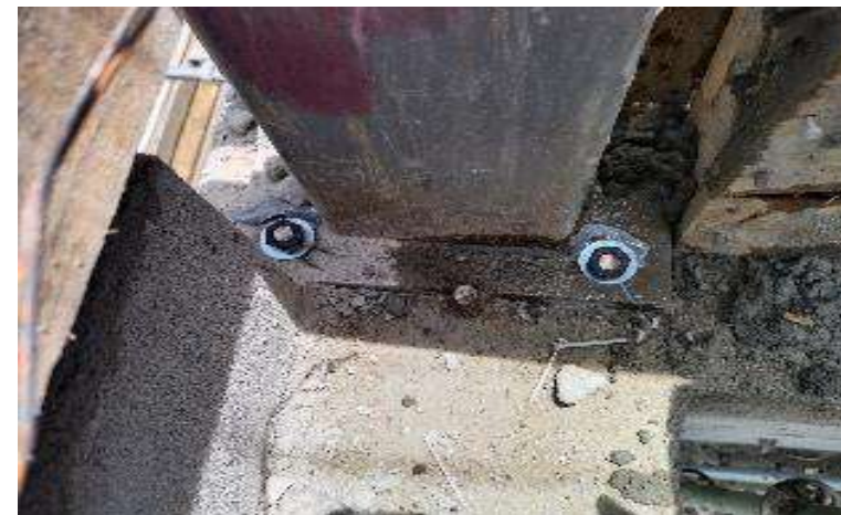
INSTALACION ANCLAJES ESTRUCTURA METALICA A VIGA AEREA.
