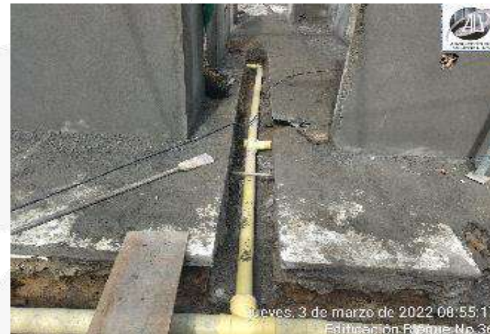
INSTALACION DE TUBERIA HIDROSANITARIA
