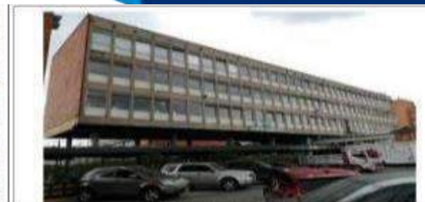
Fotografía 4. Parte de Fachada de la Torre Oriental
