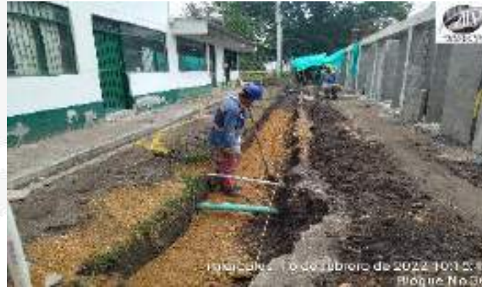
RELLENO Y CONFORMACION TERRENO PARA CONSTRUCCION CARCAMO
