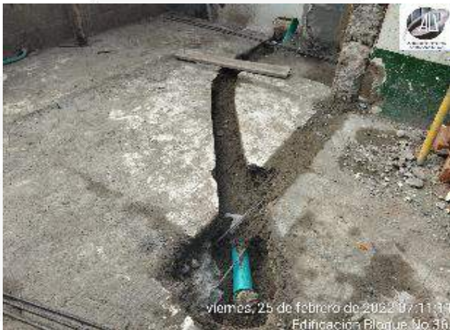
INSTALACION SOBRE PISO DUCTO TUBERIA ELECTRICA
