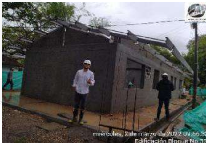
CONFORMACION Y RELLENO AREA DE ANDENES
