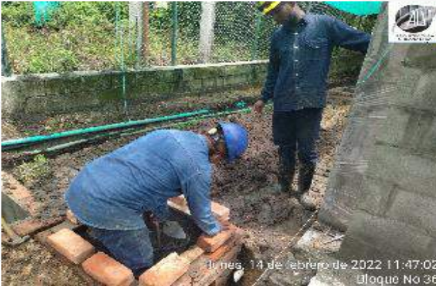
CONSTRUCCION CAJAS DE INSPECCION
