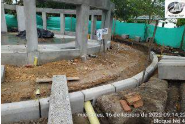
INSTALACION DE SARDINEL PREFABRICADO
