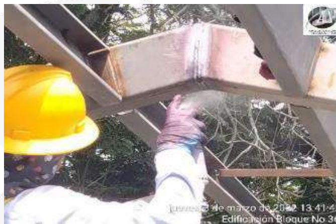
APLICACIÓN PINTURA PARA PUEBAS DE TINTE ESTRUCTURA METALICA
