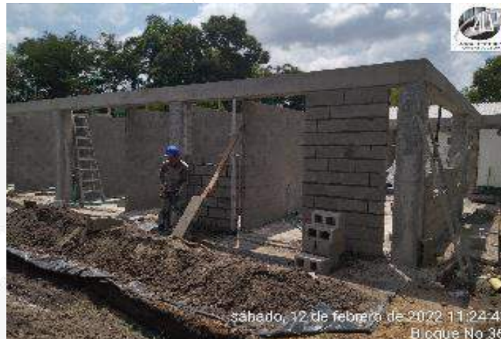
CONSTRUCCION DE MAMPOSTERIA Y COLUMNETAS DE CONFINAMIENTO
