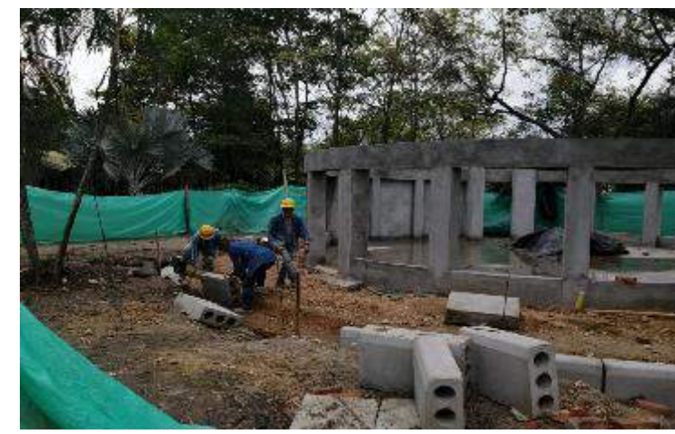
INSTALACION SARDINEL PREFABRICADO PARA CONFINAMIENTO DE ANDEN PERIMETRAL
