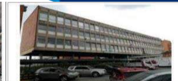
Fotografía 4. Parte de Fachada de la Torre Oriental
