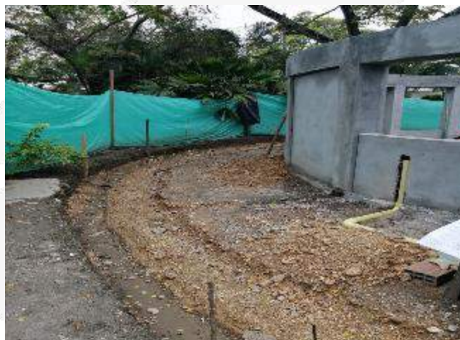
RELLENO PARA MEJORAMIENTO CAPACIDAD PORTANTE DE TERRENO ZONA DE CARCAMO Y ANDEN
