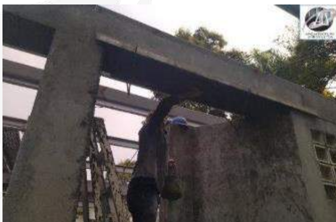
CONSTRUCCION PAÑETES, FILOS Y DILATACIONES
