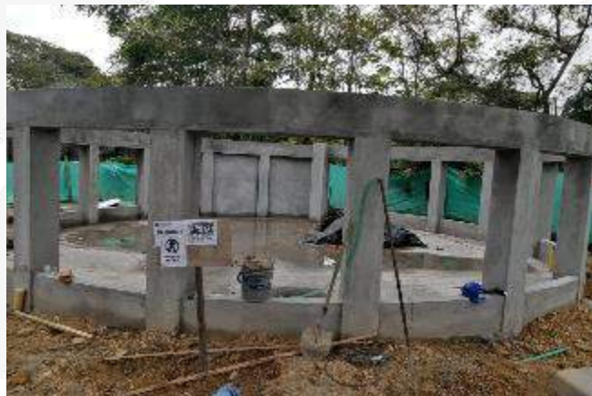
PAÑETE DE ESTRUCTURA Y MAMPOSTERIA
