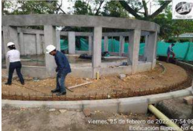
INSTALACION DE SARDINEL PREFABRICADO
