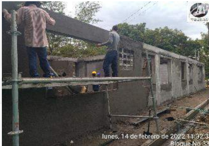
PAÑETE MAMPOSTERIA FACHADAS LATERALES
