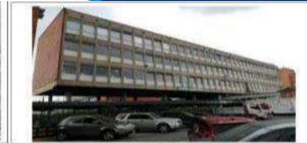
Fotografía 4. Parte de Fachada de la Torre Oriental
