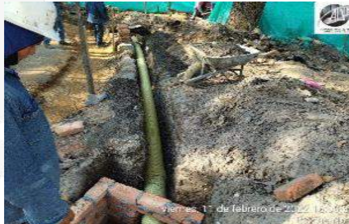
INSTALACION TUBERIA NOVAFORT DRENAJE CARCAMO
