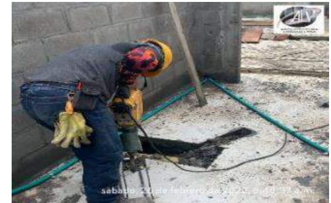
CORTE Y DEMOLICION DE PISOS MECANICA PARA INSTALACION TUBERIAS
