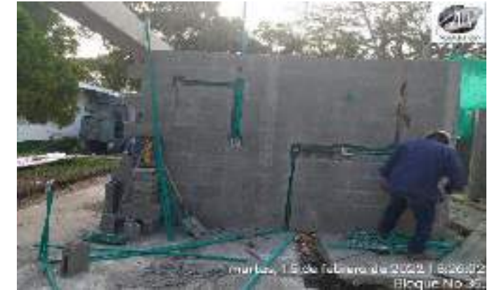
INSTALACION TUBERIA ELECTRICA SOBRE MUROS INTERNOS
