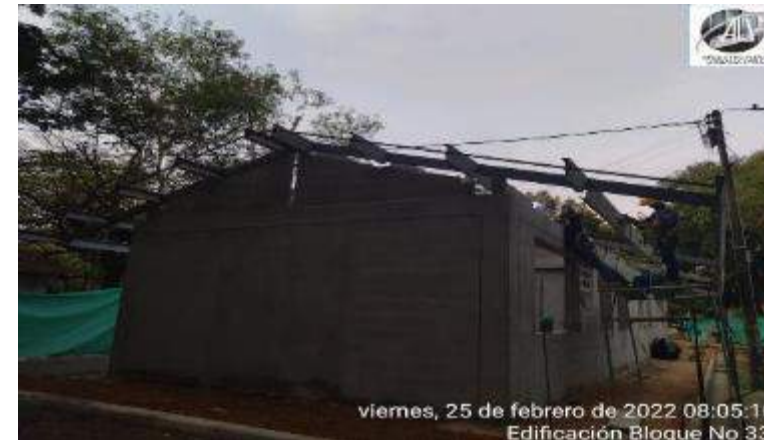
INSTALACION ESTRUCTURA METALICA CUBIERTA
