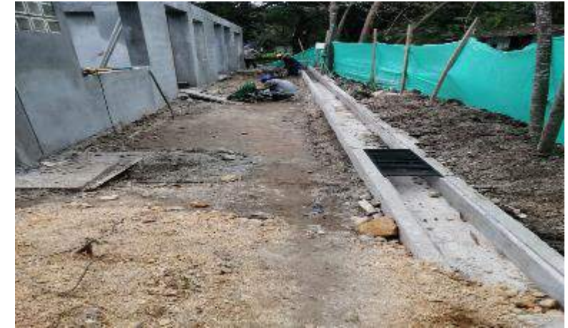
DESENCOFRADO Y CONSTRUCCION CARCAMO.
