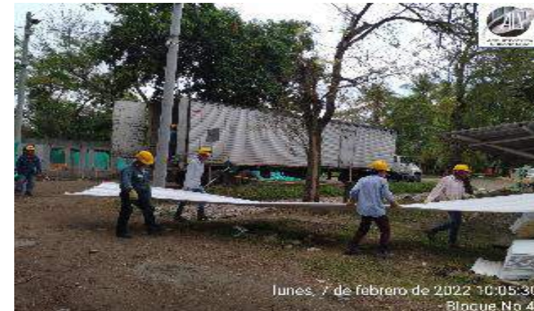
SUMINISTRO Y ACOPIO TEJA UPVC PARA CUBIERTA
