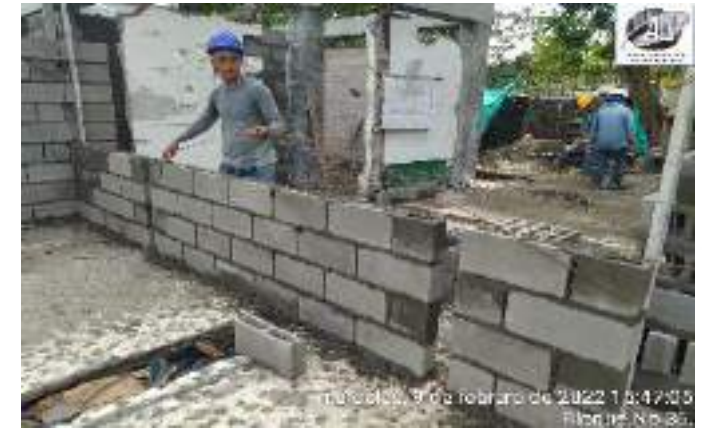
CONSTRUCCION MAMPOSTERIA CONFINADA
