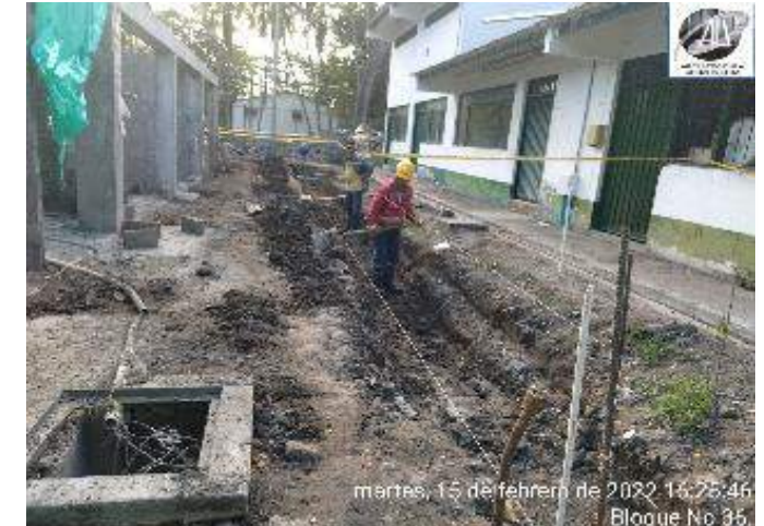
EXCAVACION MANUAL PARA CONSTRUCCION CARCAMO
