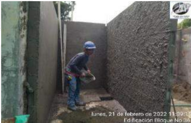
PAÑETES MUROS INTERNOS
