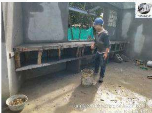
CONSTRUCCION MESONES EN CONCRETO
