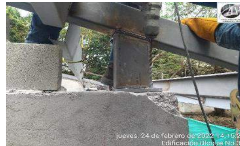
ANCLAJE PLATINAS Y ESTRUCTURA METALICA A VIGA AEREA EN CONCRETO.
