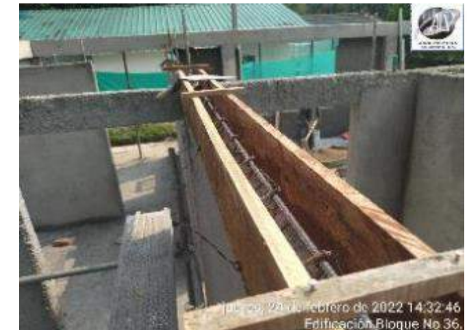
CONSTRUCCION DE VIGUETAS DE CONFINAMIENTO MAMPOSTERIA
