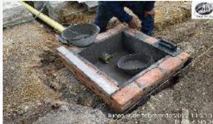
CONSTRUCCION CAJAS DE INSPECCION SANITARIAS
