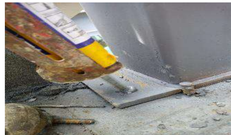
APLICACIÓN DE EPOXICO DE SIKA PARA ANCLAJES ESTRUCTURA METALICA
