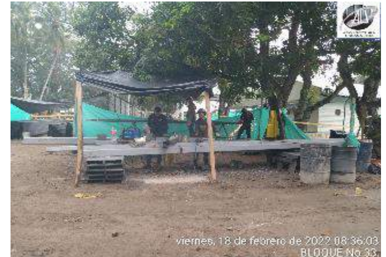
FABRICACION ESTRUCTURA METALICA
