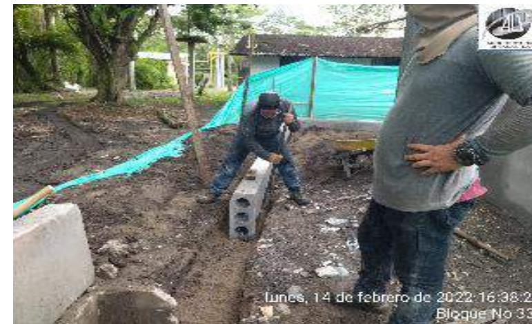
INSTALACION SARDINEL PREFABRICADO PERIMETRAL.
