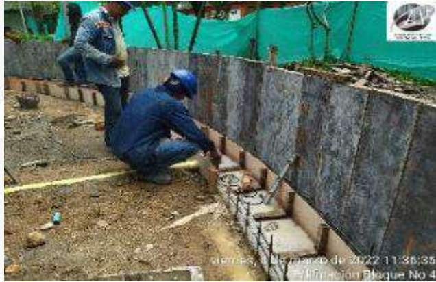
ENCOFRADO PARA CONSTRUCCION CARCAMO PERIMETRAL
