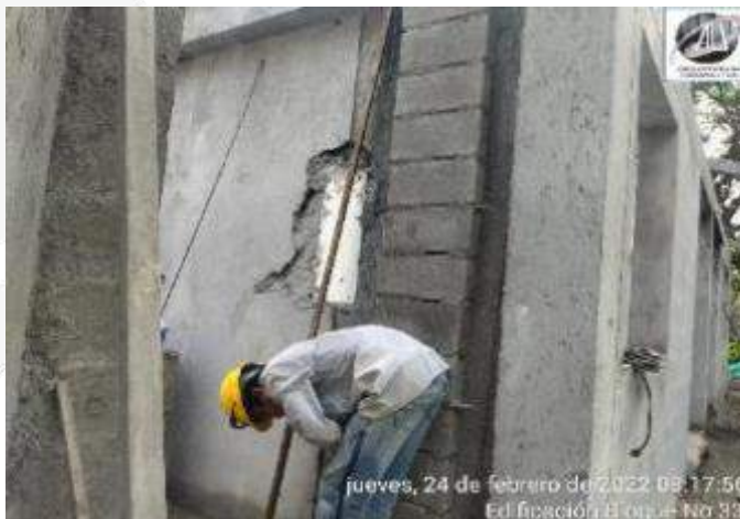
PAÑETE MAMPOSTERIA FACHADAS LATERALES
