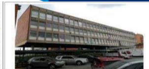
Fotografía 4. Parte de Fachada de la Torre Oriental
