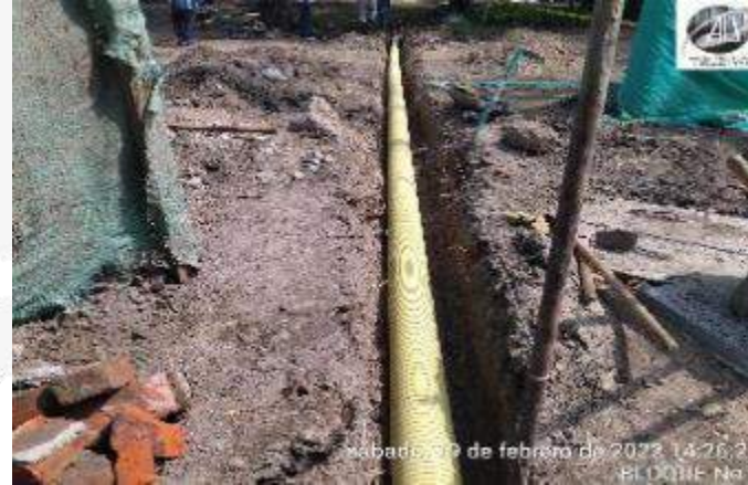
INSTALACION TUBERIA NOVAFORT DRENAJE CARCAMO
