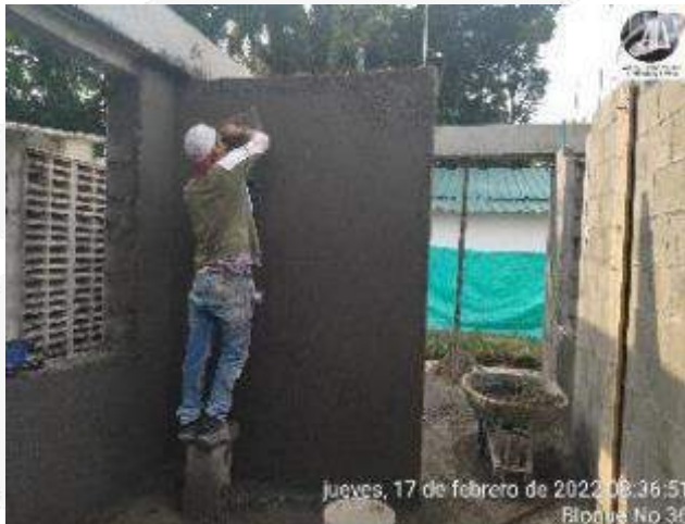
PAÑETES MUROS INTERNOS
