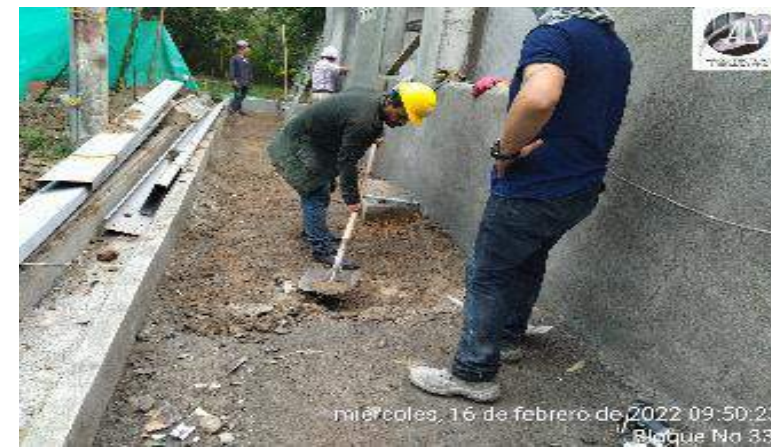
EXCAVACION, RETIRO Y CONFORMACION TERRENO PARA CONSTRUCCION ANDEN
