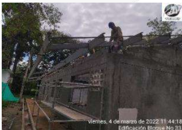
INSTALACION ESTRUCTURA METALICA
