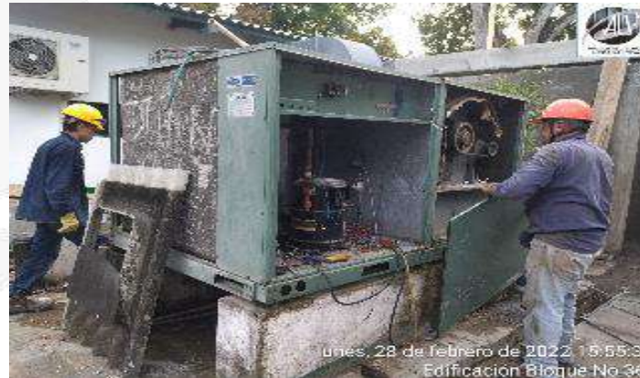
DESMONTE MANUAL UNIDAD CENTRALIZADA DE REFRIGERACION
