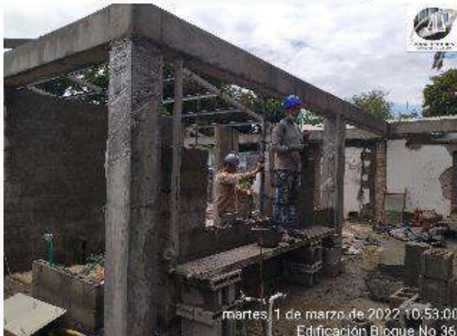
CONSTRUCCION MAMPOSTERIA CONFINADA
