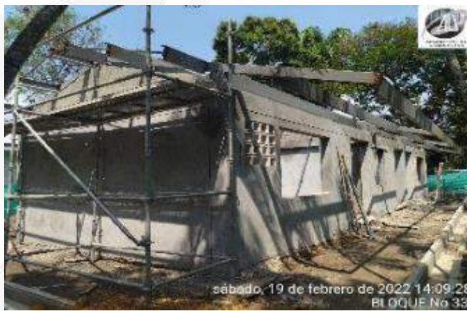
INSTALACION ESTRUCTURA METALICA CUBIERTA ANDENES DE CIRCULACION
