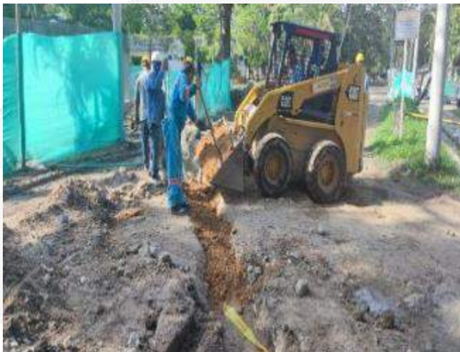
RELLENO AREA DE TUBERIA DE DRENAJE
