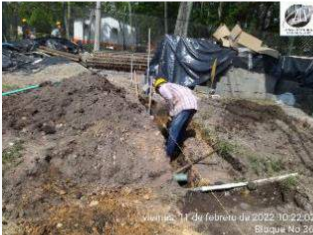
EXCAVACION MANUAL PARA CARCAMO PERIMETRAL
