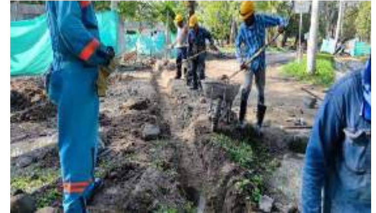
EXCAVACION MANAUL PARA ISNTALACION TUBERIA DRENAJE
