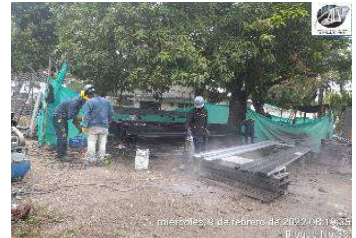
FABRICACION Y APLICACIÓN ANTICORROSIVO ESTRUCTURA METALICA
