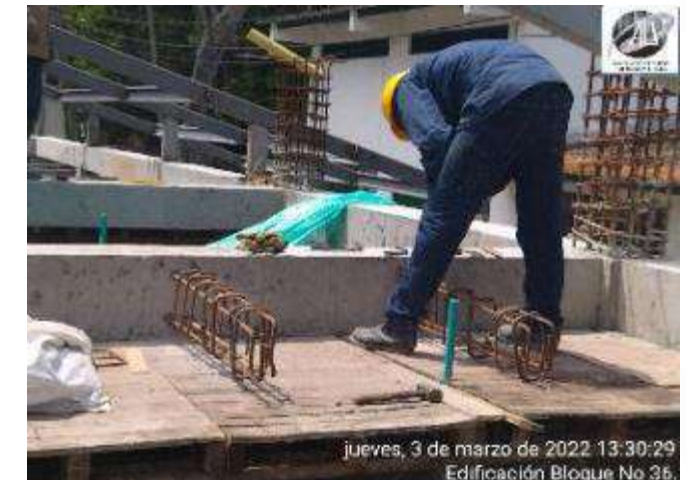
ARMADO ACERO DE REFUERZO PARA CONSTRUCCION PLACA ELEVADA TANQUES
