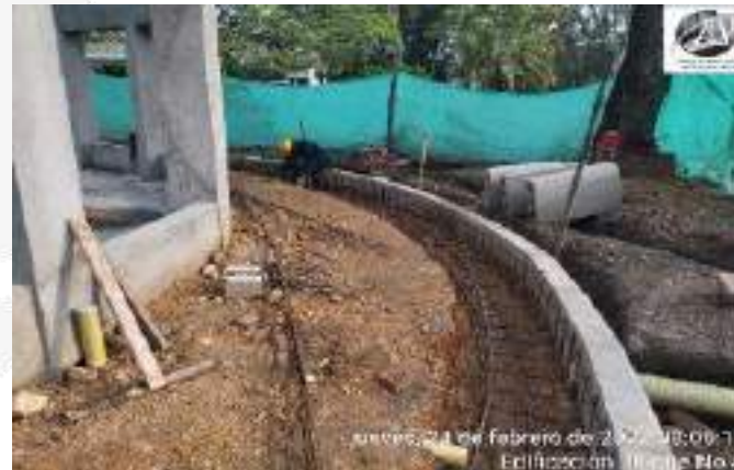
INSTALACION MALLA ELECTROSOLDADA REFUERZO CARCAMO
