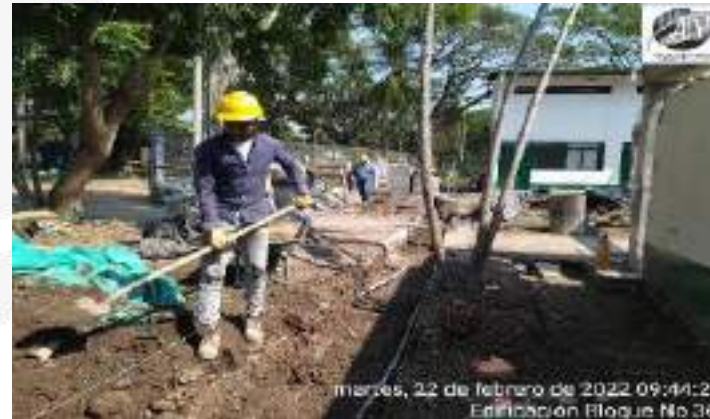
RELLENO Y CONFORMACION TERRENO PARA CONSTRUCCION CARCAMO
