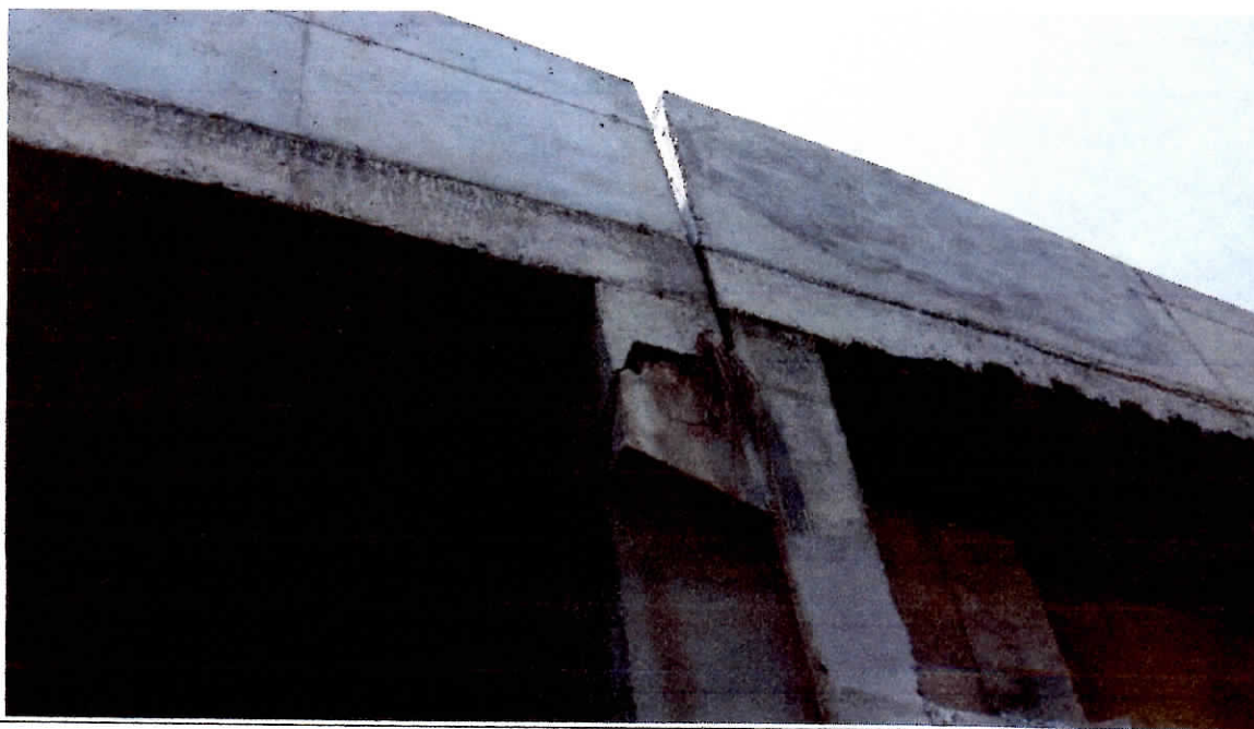
SEPARACION DE JUNTA CONSTRUCTIVA EN NEW JERSEY CALZADA NORTE
