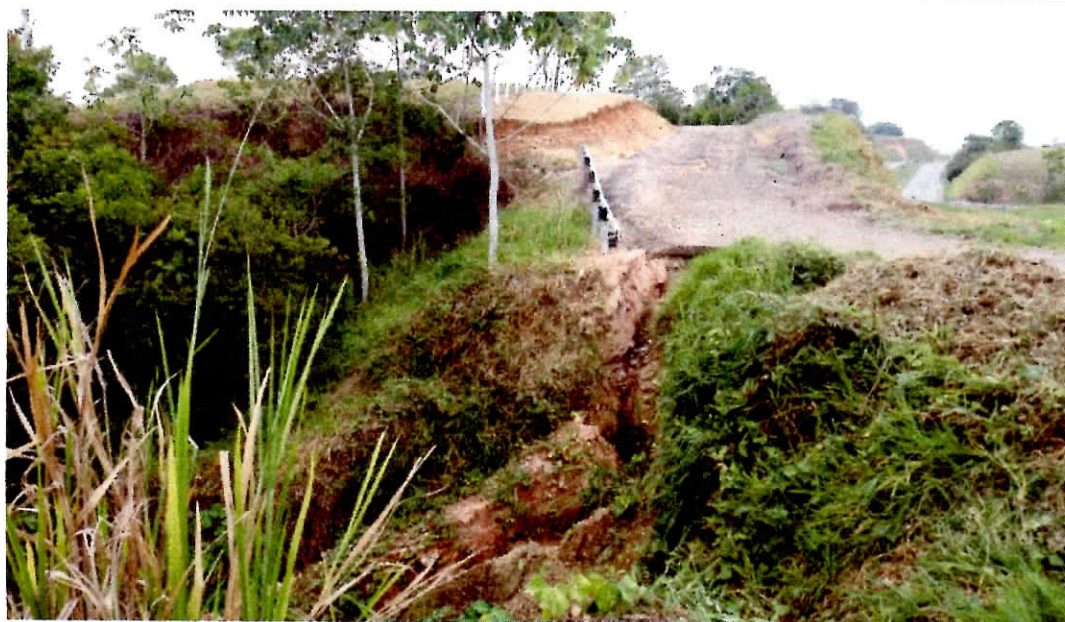
Foto 2. Socavacion generada por aguas que provienen de la
