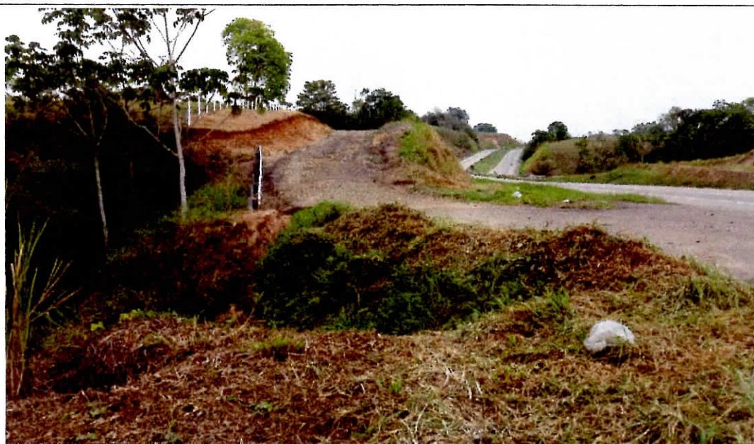
Foto 2. Socavacion generada por aguas que provienen de la
