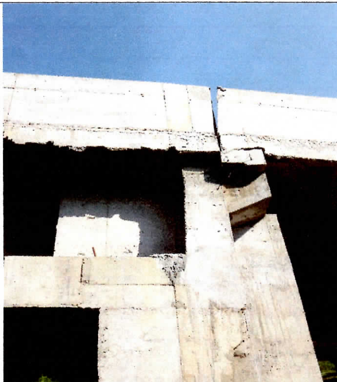
SEPARACION DE JUNTA CONSTRUCTIVA EN NEW JERSEY CALZADA NORTE
