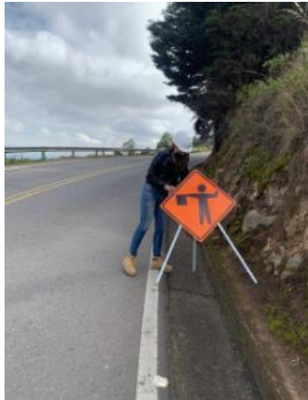
Imagen. Instalación de PMT, foto tomada el 4 de marzo de 2022, 8;10am, ESEVI-Tunja
