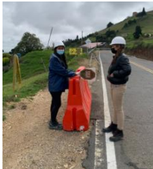
Imagen. Instalación de PMT, foto tomada el 29 de marzo de 2022, 9;10am, ESEVI-Tunja
