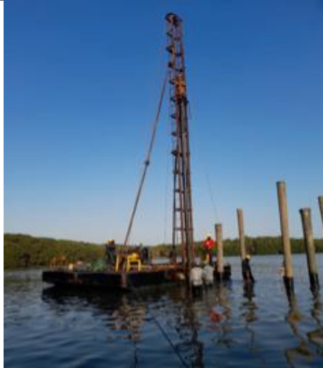
Imagen 8: Hincado de pilotes módulo 6.
