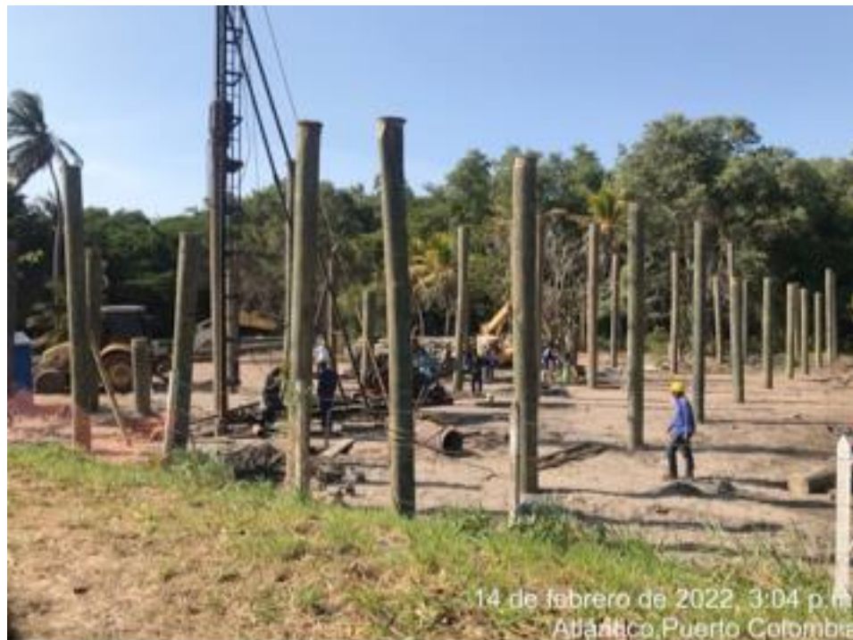
Imagen 1: Hincado de pilotes Estación III
