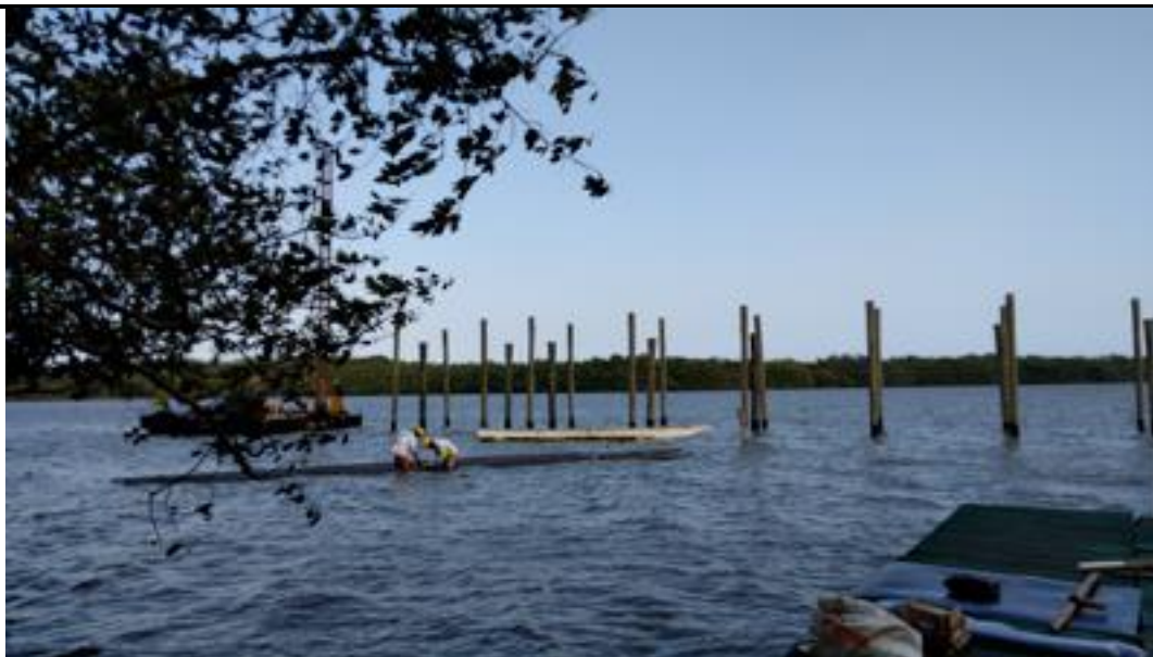
Imagen 6: Hincado de pilotes Módulo 6.
