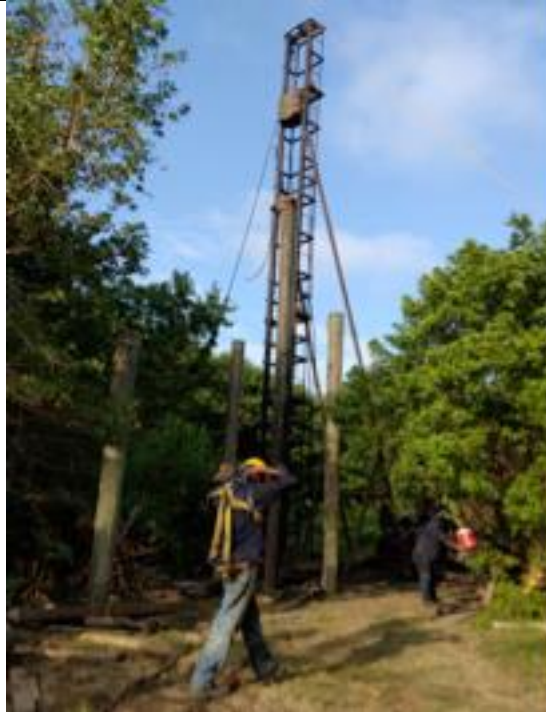
Imagen 5: Hincado de pilotes Módulo 15.
