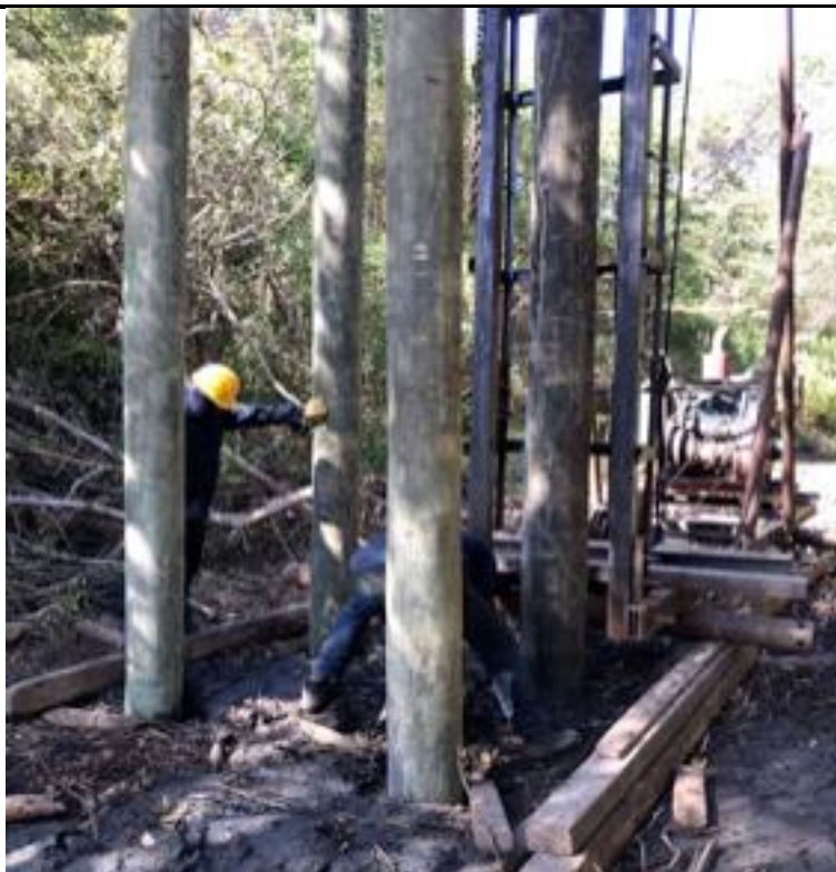
Imagen 7: Hincado de pilotes Módulo 17.
