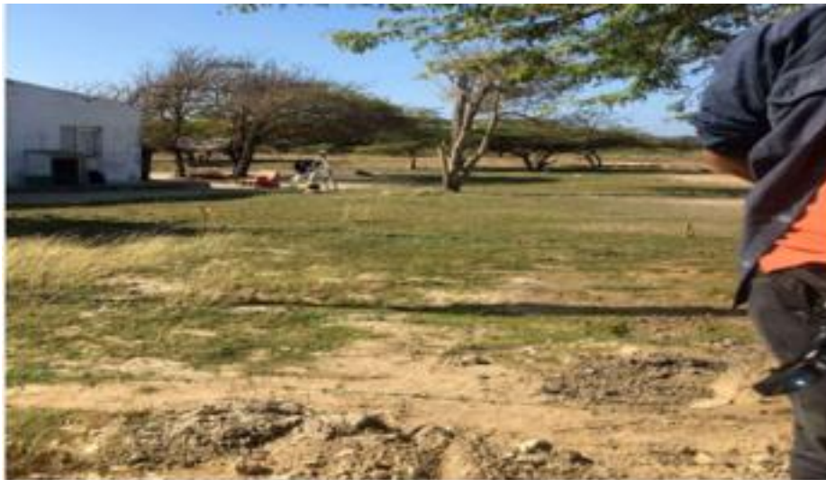
Imagen 10: Trabajos de topografía en la línea férrea.
