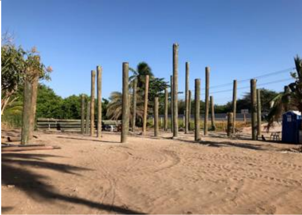
Imagen 3: Hincado de pilotes frente tierra.
