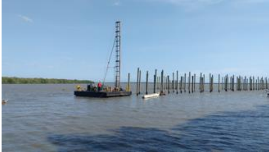
Imagen 2: Hincado de pilotes frente de agua
