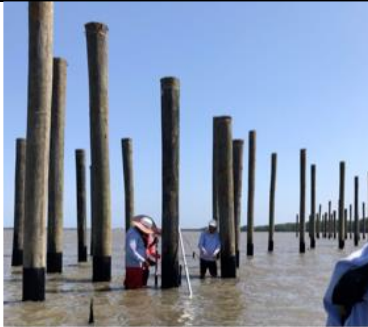
Imagen 4: Hincado de pilotes modulo 5.
