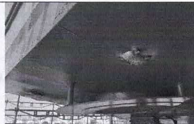
Instalación Ánodos de sacrificio
