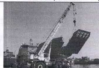
Mantenimiento Rampa - Instalación
