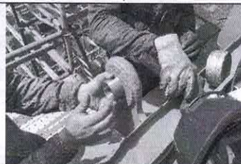
Mantenimiento Rampa – Cambio Bujes
