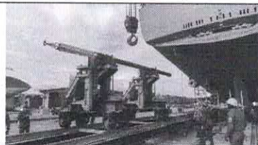
Desmonte Ejes de propulsión
