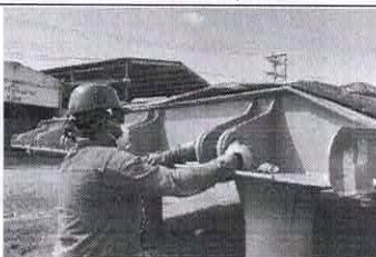
Mantenimiento Rampa – Cambio Bujes
