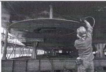
Aplicación capa pintura anticorrosiva casco
