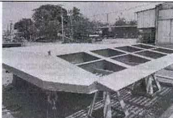
Mantenimiento Rampa – Pintura
