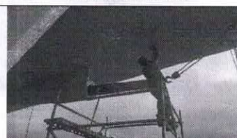
Desmonte Ejes de propulsión
