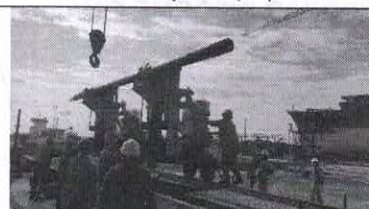
Desmonte Ejes de propulsión
