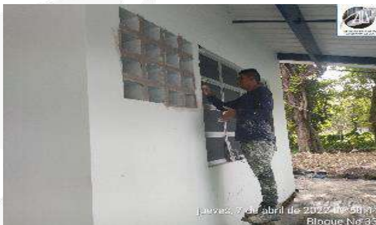
INSTALACION DE VENTANERIA EN ALUMINIO
