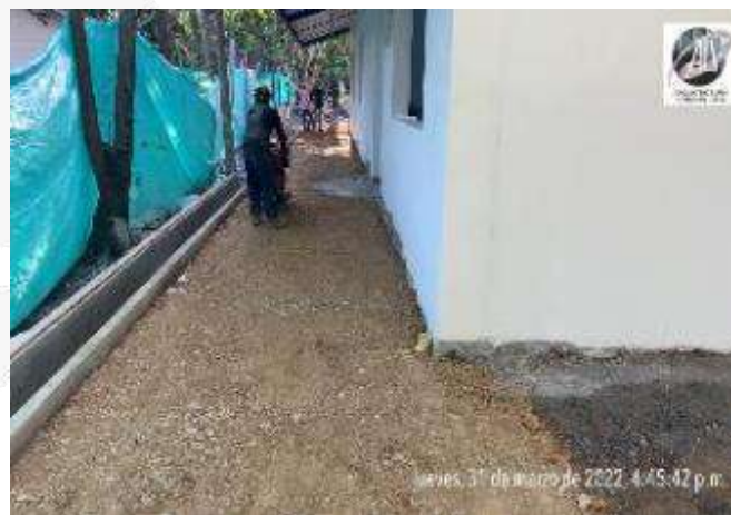
RELLENO Y CONFORACIÓN TERRENO PARA CONSTRUCCION DE ANDEN
