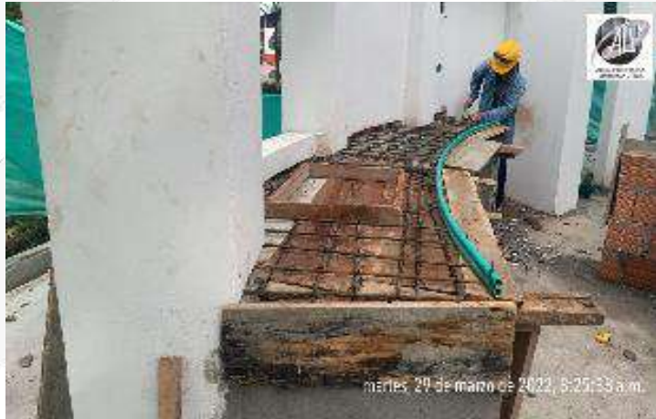
CONSTRUCCION DE MESONES EN CONCRETO
