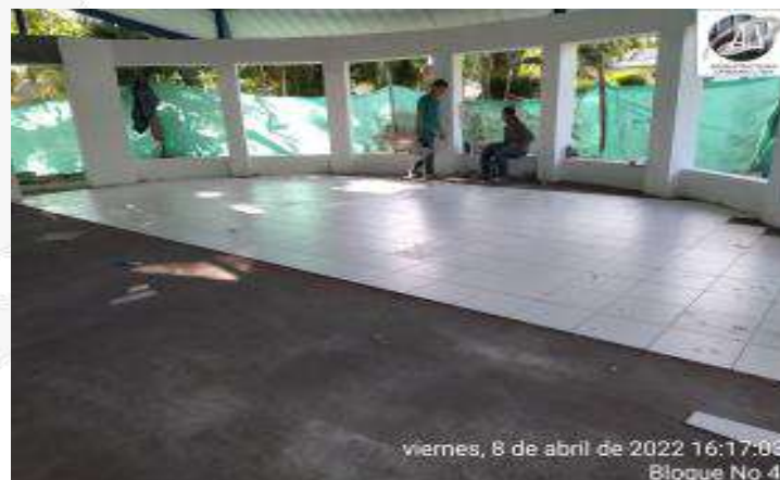
INSTALACION DE ENCHAPES PISOS
