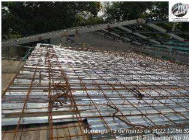
CONSTRUCCION PLACA ENTRE PISO PARA TANQUES DE RESERVA
