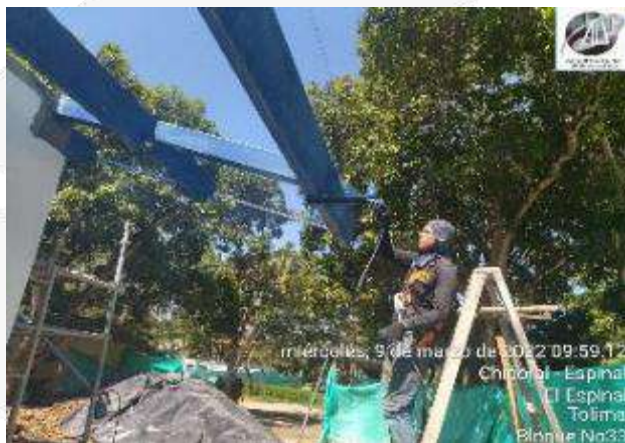
INSTALACION ESTRUCTURA METALICA
