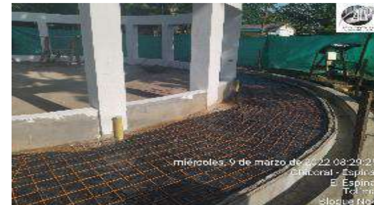
INSTALACION ACERO DE REFUERZO PARA CONTRUCCION ANDEN
