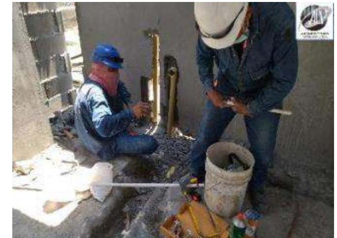
INSTALACION TUBERIA HIDROSANITARIA
