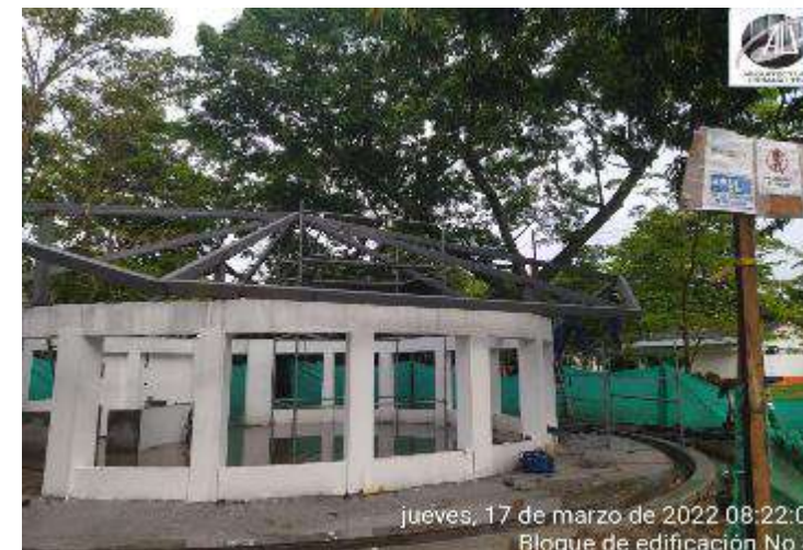
INSTALACION ESTRUCTURA METALICA CUBIERTA
