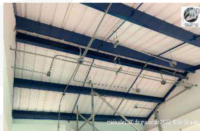
INSTALACION TUBERIA MT PARAS LUMINARIAS CUBIERTA
