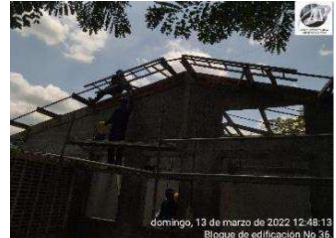
INSTALACION ESTRUCTURA METALICA
