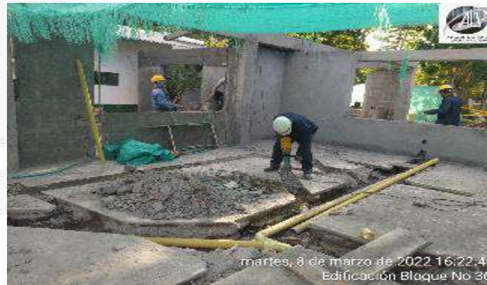
INSTALACION TUBERIA HIDROSANITARIA
