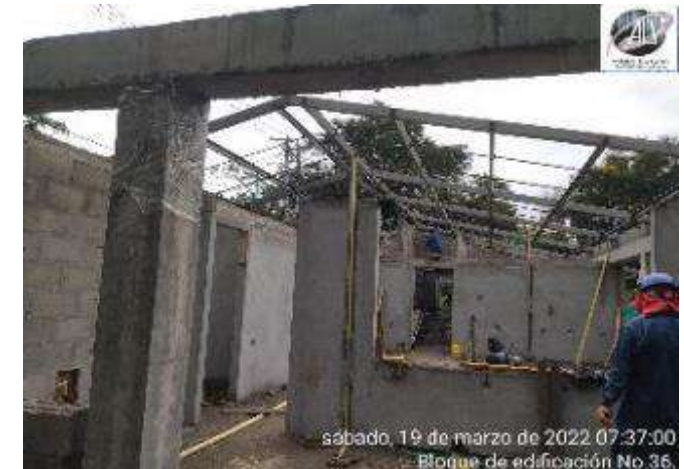
INSTALACION ESTRUCTURA METALICA
