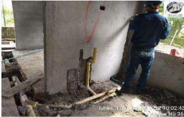
INSTAALCION TUBERIA HIDROSANITARIA
