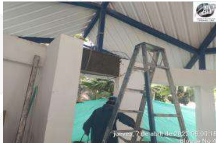
ACABADO DE ESTUCO Y PINTURA MUROS Y ESTRUCTURA INTERNA
