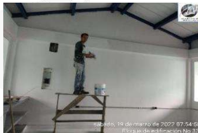
ESTUCO Y PINTURA MUROS INTERNOS
