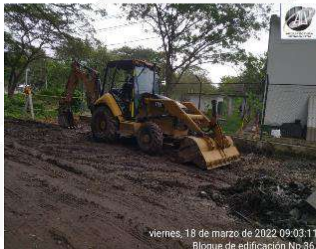
CARGUE Y RETIRO DE MATERIAL CONTAMINADO
