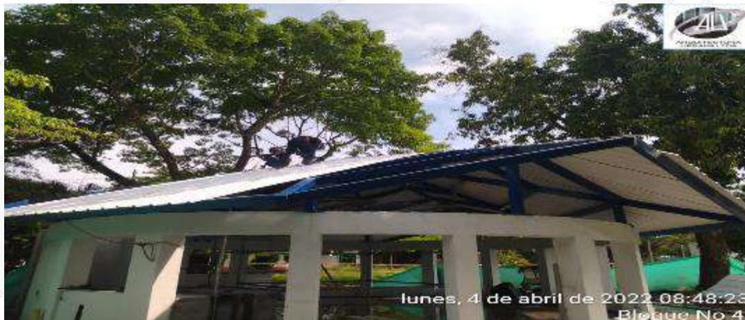
INSTALACION CUBIERTA UPVC
