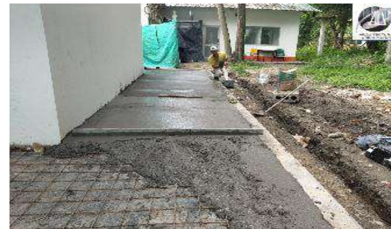
CONSTRUCCION DE ANDEN PERIMETRAL
