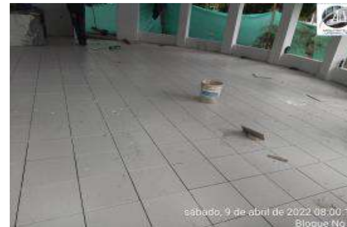
INSTALACION DE ENCHAPES PISOS, GAURDAESCOBAS Y EMBOQUILLADO
