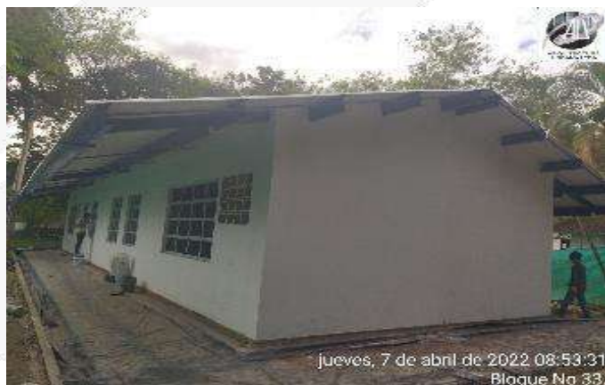
INSTALACION DE VENTANERIA EN ALUMINIO
