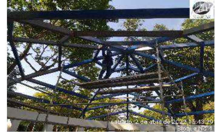
ACABADO DE PINTURA ANTICORROSIVO ESTRUCTURA METALICA
