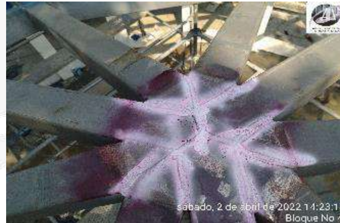
PRUEBA DE TINTE ESTRUCTURA METALICA
