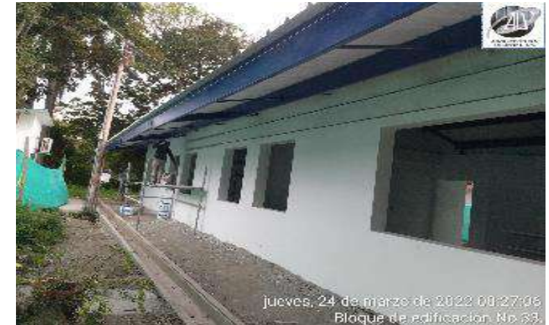
CONSTRUCCION DE DILATACIONES FACHADAS
