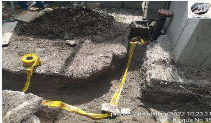
INSTAALCION TUBERIA DE GAS
