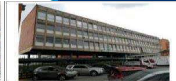
Fotografía 4. Parte de Fachada de la Torre Oriental
