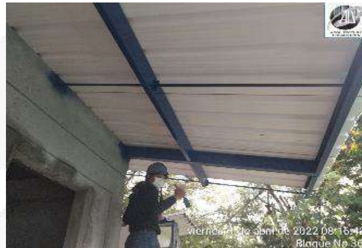
REMATE DE ACABADOS PINTURA ESTRUCTURA METALICA
