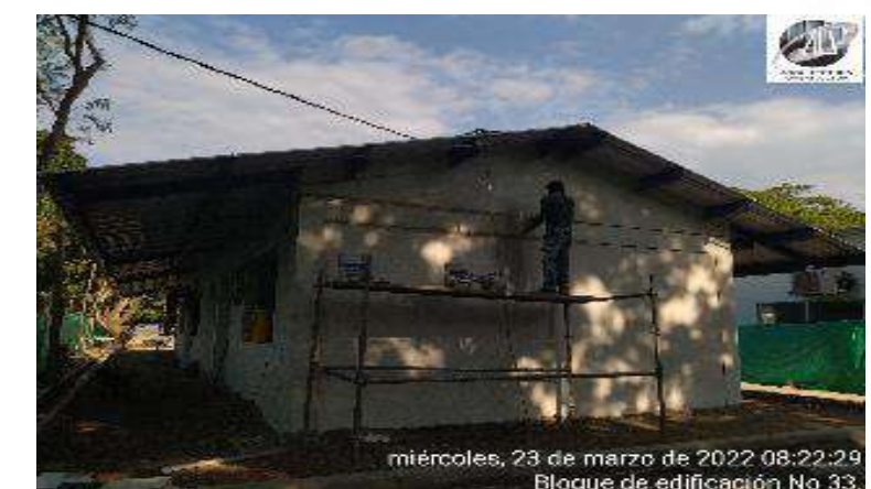
CONSTRUCCION DE DILATACIONES FACHADAS
