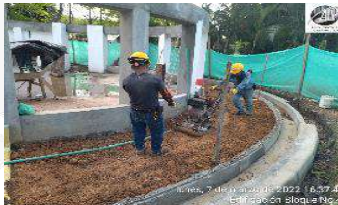
RELLENO Y CONFORMACION TERRENO PARA CONSTRUCCION ANDEN PERIMETRAL
