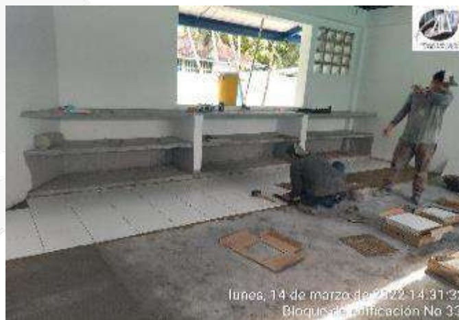
INSTALACION ENCHAPES PISOS
