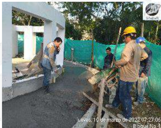
CONSTRUCCION ANDEN PERIMETRAL EN CONCRETO
