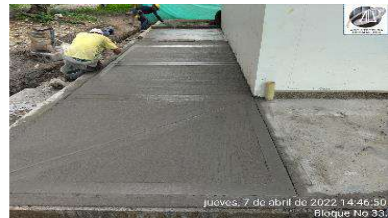
ACABADO DE ANDEN PERITRAL EN CONCRETO DILATADO Y ESCOBIADO
