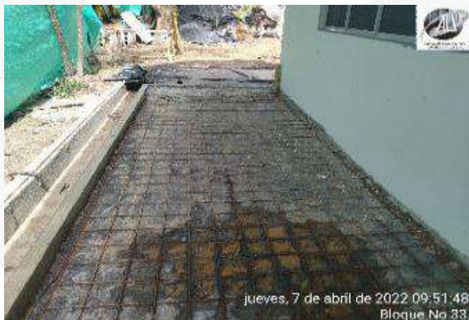
INSTALACION D EMALLA ELECTROSOLDADA PARA ANDEN PERIMETRAL
