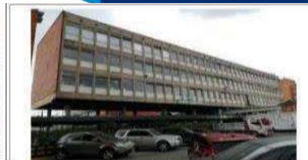
Fotografía 4. Parte de Fachada de la Torre Oriental
