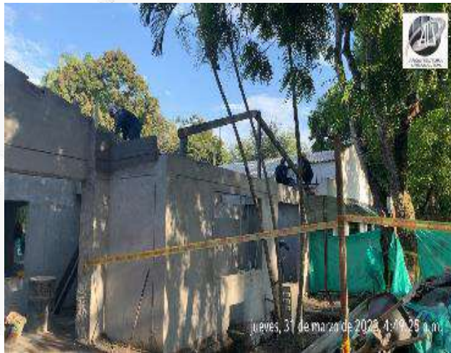
INSTALACION ESTRUCTURA METALICA
