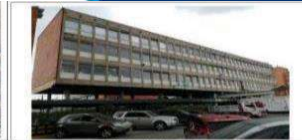
Fotografía 4. Parte de Fachada de la Torre Oriental
