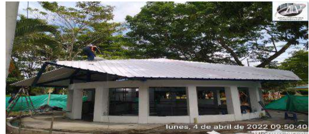
INSTALACION CUBIERTA UPVC
