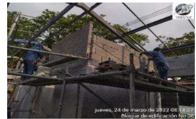
CONSTRUCCION MAMPOSTERIA CONFINADA AREA DE TANQUES DE RESERVA
