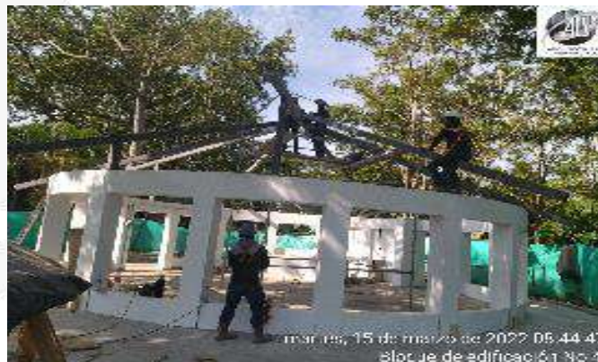
MODULACION E HINCADO ESTRUCTURA METALICA
