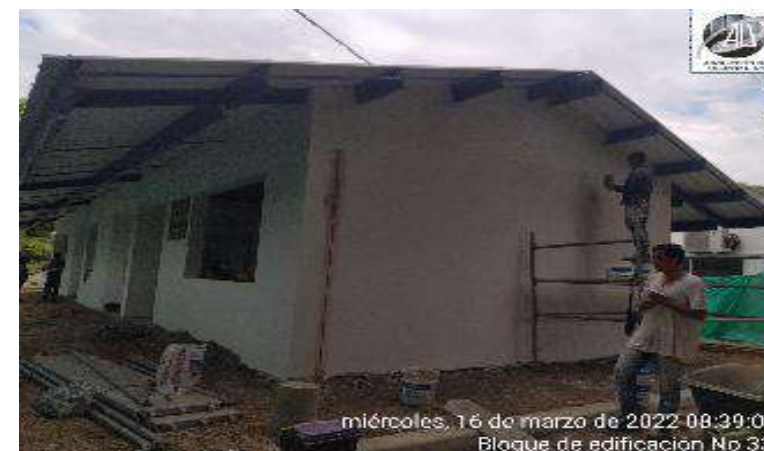
INSTALACION DE CUBIERTA Y CABALLETE UPVC
