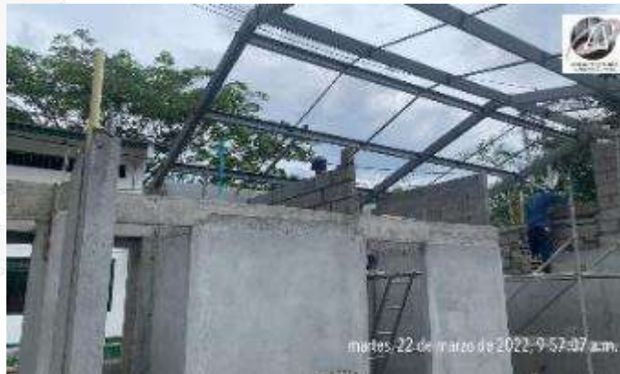
INSTALACION ESTRUCTURA METALICA
