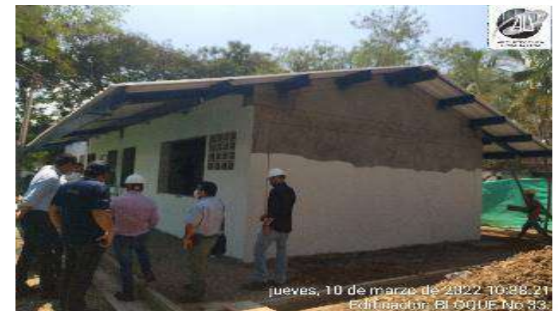
INSTALACION DE CUBIERTA UPVC Y RECORRIDO AVANCE DE OBRA DIRECCION REGIONAL SENA, SUBDIRECCION CAG SENA Y FINDETER.
