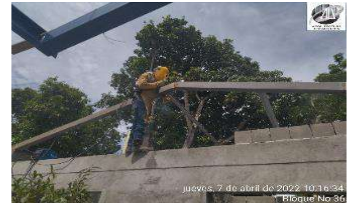
INSTALACION DE ESTRUCTURA METALICA
