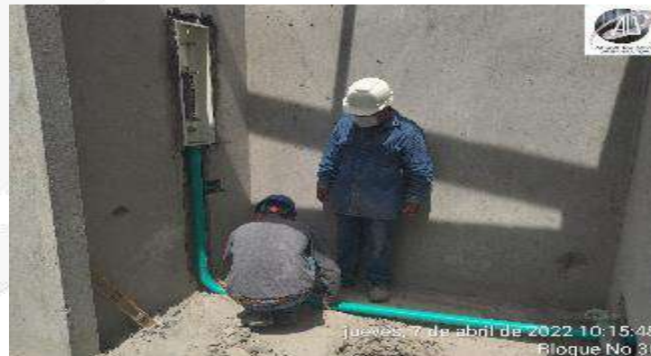
INSTALACION DE TUBERIA Y TABLEROS ELECTRICOS
