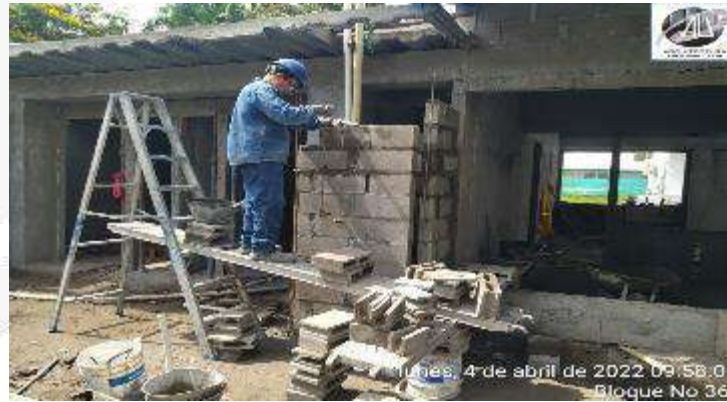
CONSTRUCCION MAMPOSTERIA CONFINADA
