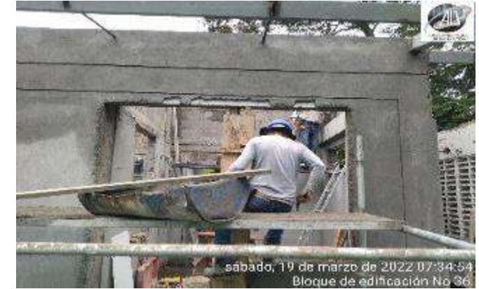
CONSTRUCCION PAÑETES, FILOS Y DILATACIONES MAMPOSTERIA INTERNA Y EXTERNA
