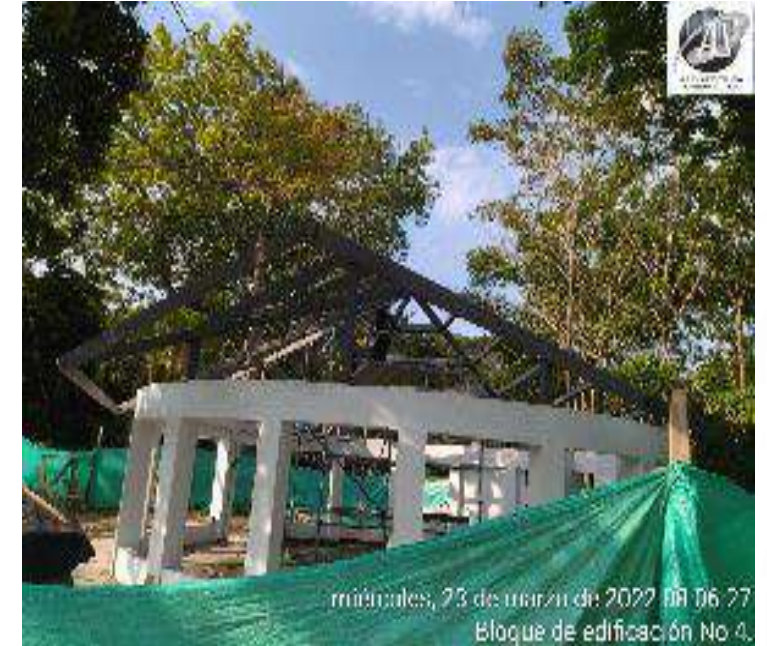
ACABADO DE PINTURA ESTRUCTURA METALICA
