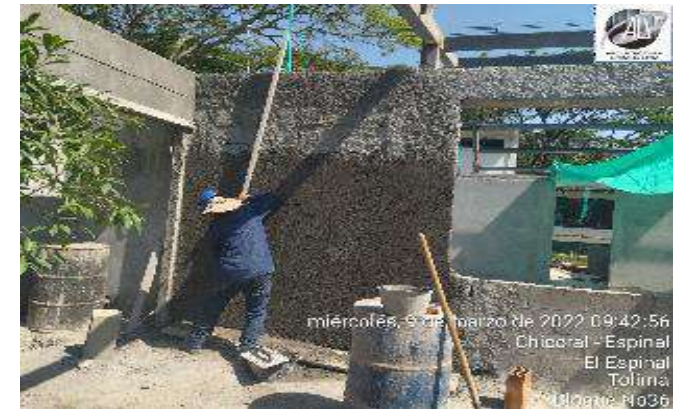
CONSTRUCCION PAÑETES MAMPOSTERIA INTERNA Y EXTERNA
