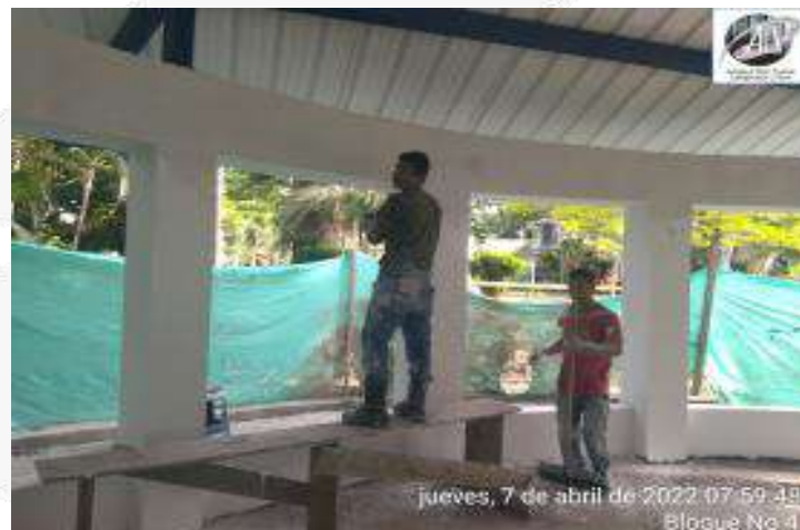
DETALLE DE ACABADO FILOS, ESTUCO Y PINTURA
