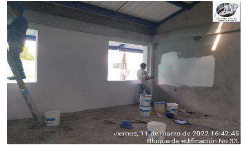
ESTUCO Y PINTURA MAMPUESTERIA INTERNA Y EXTERNA.
