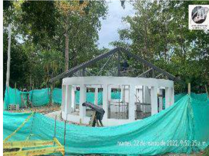
PRUEBA DE TINTE ESTRUCTURA METALICA
