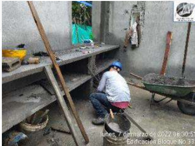
CONSTRUCCION MESONES EN CONCRETO
