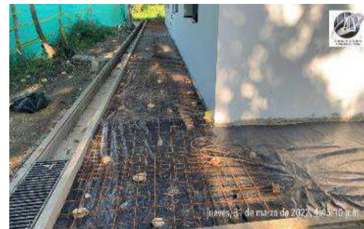
INSTALACION DE MALLA ELECTROSOLDAD PARA CONSTRUCCION DE ANDEN PERIMETRAL
