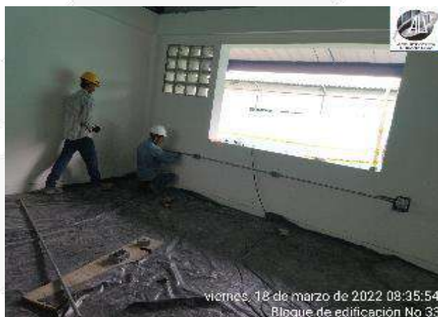
INSTALACION TUBERIA ELECTRICA MT PARA PUNTOS ADICIONALES SENA
