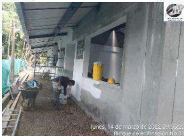
ESTUCO MUROS FACHADAS
