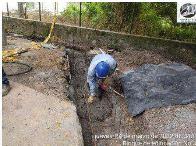
CONSTRUCCION CARCAMO DE DESCOLE AGUAS LLUVIAS
