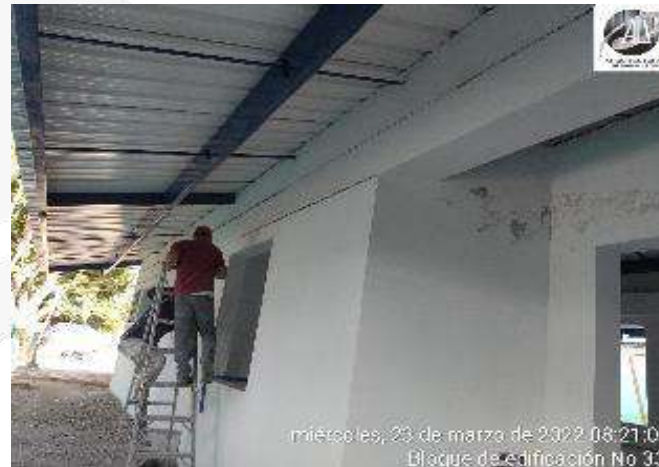
ESTUCO Y PINTURA FACHADAS
