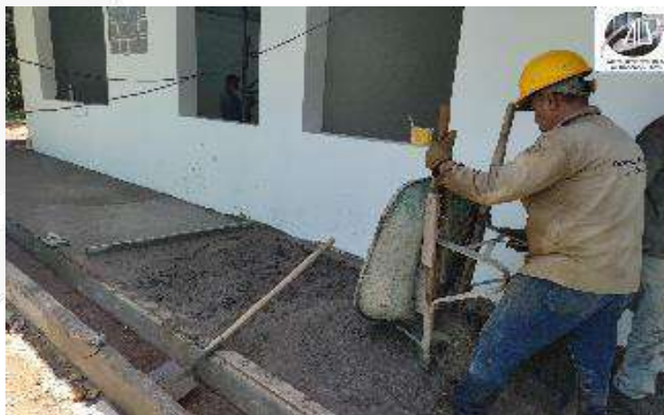
CONSTRUCION DE ANDEN PERIMETRAL
