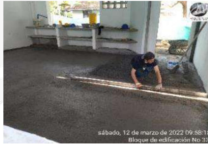
CONSTRUCCION ALISTADO PARA PISOS
