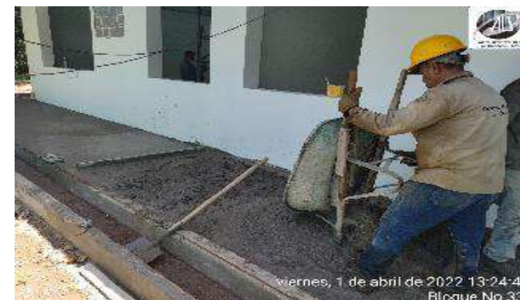
CONSTRUCCION DE ANDEN PERIMETRAL
