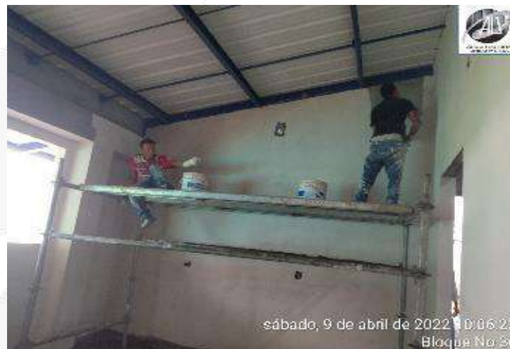
ESTUCO Y PINTURA SOBRE MAMPOSTERIA INTERNA
