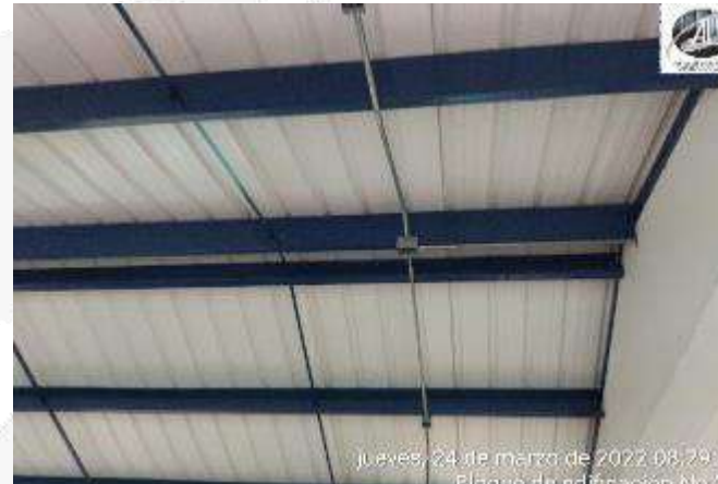
INSTALACION TUBERIA MT PARAS LUMINARIAS CUBIERTA
