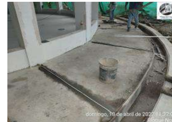
INSTALACION DE DILATACIONES PARA CONSTRUCCION DE ANDEN PERIMETRAL EN GRANITO
