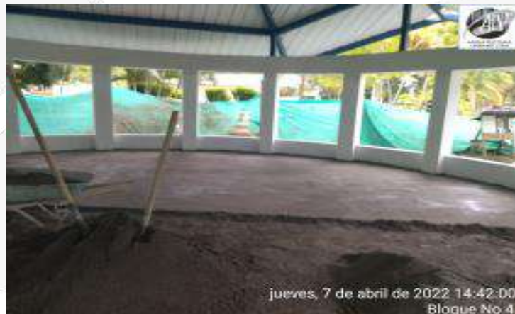
CONSTRUCCION DE ALISTADO DE PISOS
