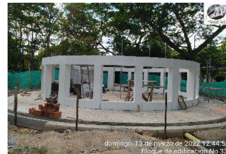
ESTUCO Y PINTURA MAMPOSTERIA Y ESTRUCTURA
