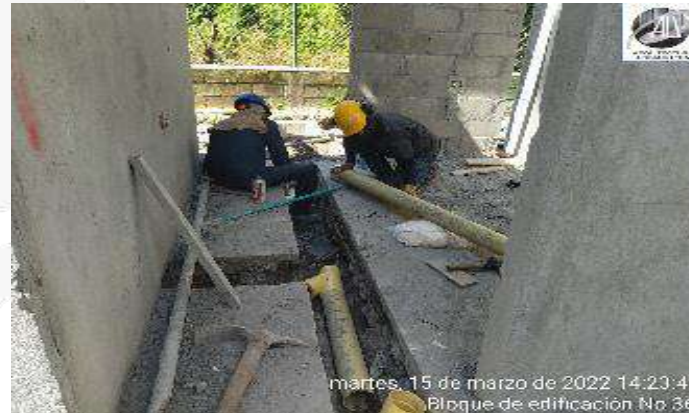
INSTALACION TUBERIA HIDROSANITARIA
