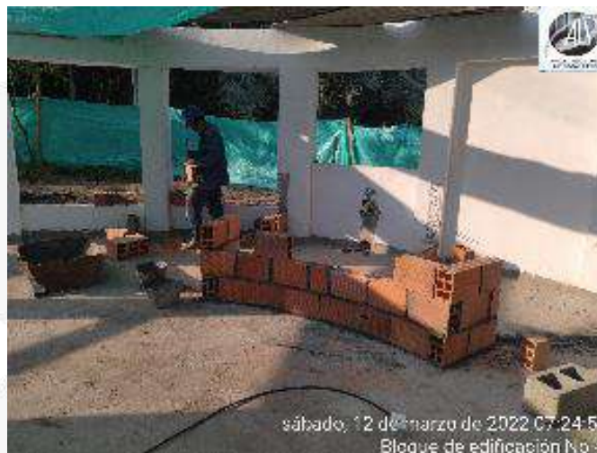
CONSTRUCCION DE MESON EN MAMPOSTERIA PARA CAFETERIA BLOQUE 4
