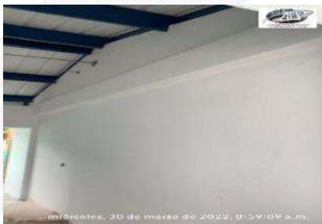
ACABADO DE MUROS INTERNOS
