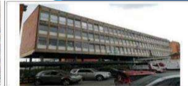
Fotografía 4. Parte de Fachada de la Torre Oriental
