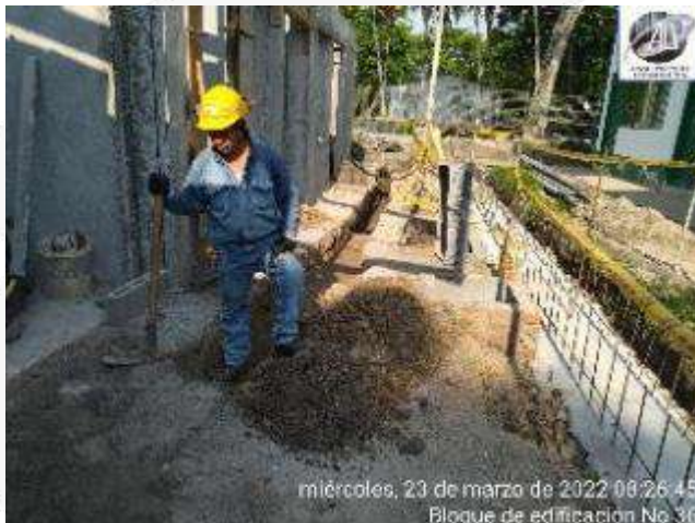
RELLENO MATERIAL SELECCIONADO PARA CONSTRUCCION ANDEN PERIMETRAL
