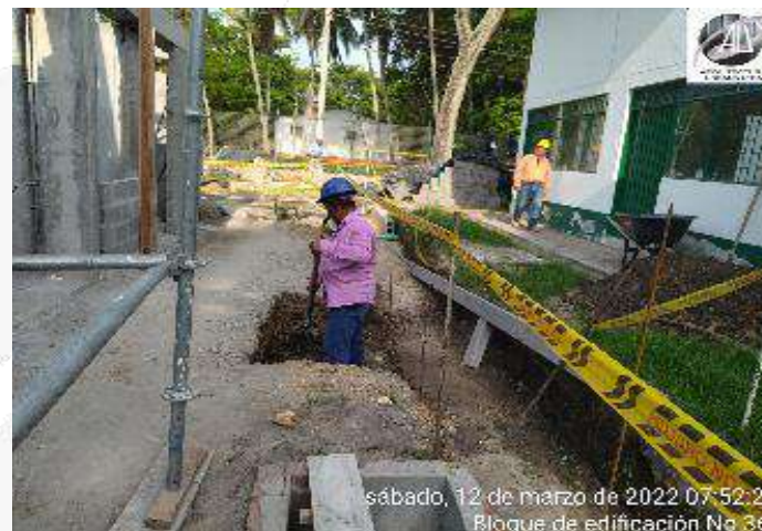
CONSTRUCCION CAJAS DE INSPECCION RED FLUVIAL
