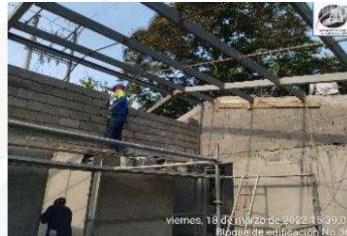
CONSTRUCCION MAMPOSTERIA CONFINADA
