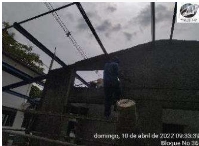
CONSTRUCCION DE PAÑETES Y DILATACIONES INTERNAS
