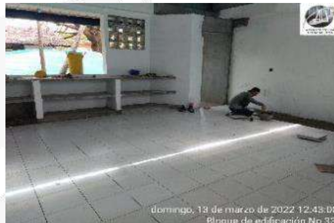
INSTALACION ENCHAPES PISOS
