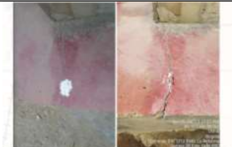
Fotografía 1. Evidencia de desplazamientos perimetrales Carrera 2B Este No. 89 C-04 Sur (registro inicio de obra e instalación de testigo vs 20 de abril de 2022 Registro fotográfico interventoría de obra.
