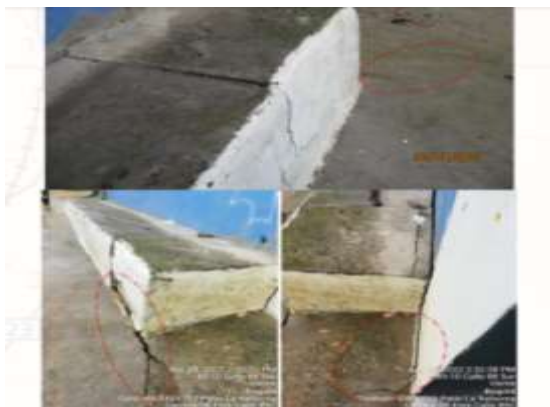
Fotografía 3. Evidencia de desplazamientos perimetrales Carrera 2B Este No. 89 C-03 Sur(registro acta de vecindad vs 20 de abril de 2022)
