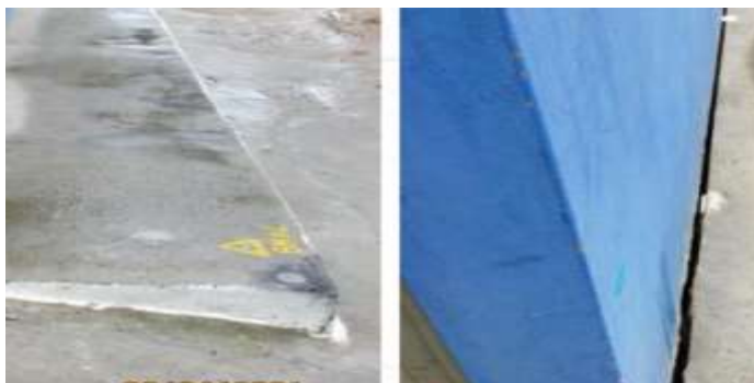
Fotografía 1. Evidencia de desplazamientos perimetrales Carrera 2B Este No. 89 C-04 Sur (registro inicio de obra e instalación de testigo vs 20 de abril de 2022 Registro fotográfico interventoría de obra.
