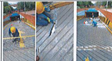
FOTOGRAFÍA No. 18: PARQ. No 9 UNILAGO 79 - Suministro e instalacion del Producto para tratamiento de Fisuras en rampa vehicular
