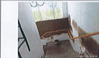
FOTOGRAFÍA No. 51: PARQ. No 13: CHICÓ 90 - Mantenimiento filtraciones muros perimetrales en 2 puntos fijos (Escaleras)20Mts
