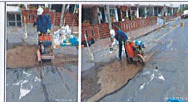
FOTOGRAFÍA No. 48: PARQ. No 12: CALLE 97 - Corte de pavimento - incluye equipo: cortadora de concreto
