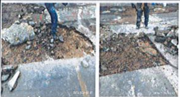
FOTOGRAFÍA No. 49: PARQ. No 12: CALLE 97 - Demolición de pavimento flexible e: 10 cm
