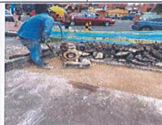
Georeferenciación Descripción PARQ. No 1: CALLE 125 - 127 Mejoramiento con subbase granular tipo B (Incluye extendido, humedecimiento y compactación)
