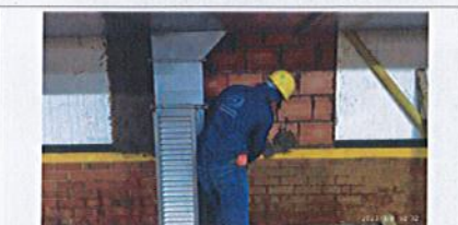
FOTOGRAFÍA No. 23: PARQ. No 10 CHICÓ 97 - Mantenimiento de Muro Contención
