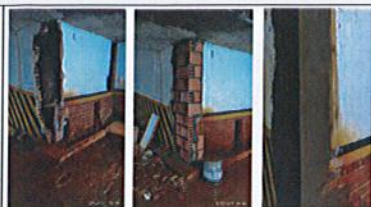
FOTOGRAFÍA No. 21: PARQ. No 10 CHICÓ 97 - Mantenimiento de Muro Contención
