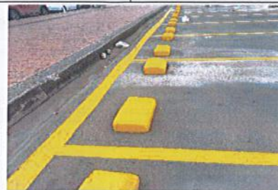
Georeferenciación Descripción PARQ. No 1: CALLE 125 - 127 Pintura tráfico amarillo Topellantas
