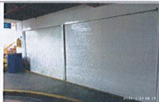
FOTOGRAFÍA No. 47: PARQ. No 9: UNILAGO 79 - Reparación lamina metalica de 4m2 afectada de puerta corredera local 1
