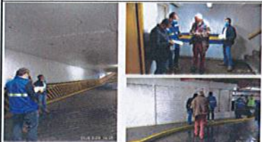
FOTOGRAFÍA No. 7: PARQ. No 9 UNILAGO 79 - Visita de Diagnóstico y verificación.
