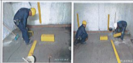
FOTOGRAFÍA No. 50: PARQ. No 13: CHICÓ 90 - Suministro e instalación de topellantas en concreto ( Incluye andajes y epoxico )
