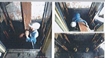
FOTOGRAFÍA No. 28: PARQ. No 13 CHICÓ 90 - Arreglo Filtracion en foso de ascensor
