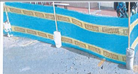
Georeferenciación Descripción PARQ. No 1: CALLE 125 - 127 Cerramiento En Polisombra
