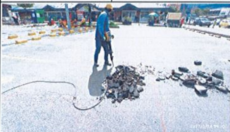
Georeferenciación Descripción PARQ. No 1: CALLE 125 - 127 Demolición de pavimento flexible e: 10 cm
