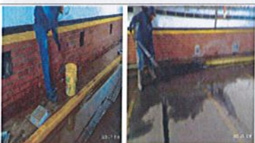
FOTOGRAFÍA No. 22: PARQ. No 10 CHICÓ 97 - Limpieza Canal Sótano 2
