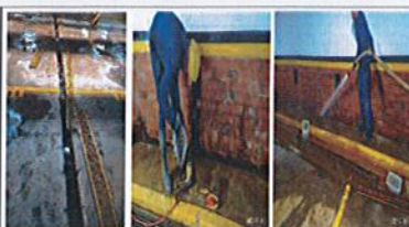
FOTOGRAFÍA No. 24: PARQ. No 10 CHICÓ 97 - Limpieza Canal Sótano 2
