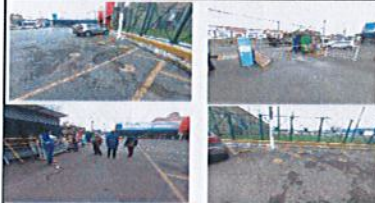
FOTOGRAFÍA No. 4: PARQ. No 6 SAN ANDRESITO RONCADOR - Visita de Diagnóstico y verificación.
