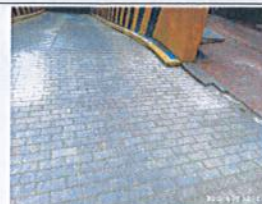
FOTOGRAFÍA No. 54: PARQ. No 13: CHICÓ 90 - Suministro e instalación de adoquín en concreto 8cm vehicular
