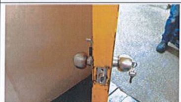
FOTOGRAFÍA No. 19: PARQ. No 9 UNILAGO 79 - Suministro e instalacion de chapa para puerta metalica baño de hombres
