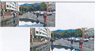
FOTOGRAFÍA No. 10: PARQ. No 12 CALLE 97 - Visita de Diagnóstico y verificación.
