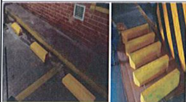
FOTOGRAFÍA No. 46: PARQ. No 8: COUNTRY 65 - Suministro e instalación de topellantas en concreto ( Incluye andajes y epoxico )
