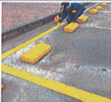
FOTOGRAFÍA No. 43: PARQ. No 1: CALLE 125 - Demarcación celdas de parqueos en pintura tráfico color amarillo (ancho 0.10cm)
