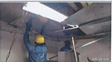
FOTOGRAFÍA No. 25: PARQ. No 10 CHICÓ 97 - Instalación de perfilera para cielo raso
