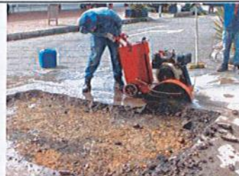
Georeferenciación Descripción PARQ. No 1: CALLE 125 - 127 Corte de pavimento - Incluye equipo: cortadora de concreto
