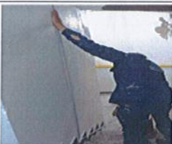
FOTOGRAFÍA No. 52: PARQ. No 13: CHICÓ 90 - Aplicación pintura tipo vinilo 3 manos de alta resistencia
