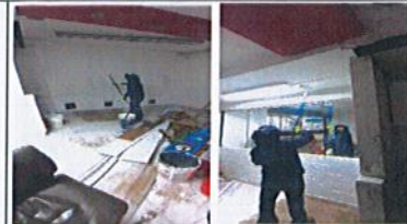
FOTOGRAFÍA No. 45: PARQ. No 8: COUNTRY 65 - Pintura tipo vinilo interior Muros en local dos manos
