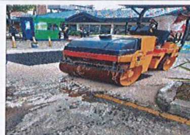
Georeferenciación Descripción PARQ. No 1: CALLE 125 - 127 Mezcla densa en caliente MD20 asfalto 80-100 (suministro, extendido, nivelación y compactación mecánica)
