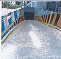
FOTOGRAFÍA No. 53: PARQ. No 13: CHICÓ 90 - Suministro e instalación de adoquín en concreto 8cm vehicular
