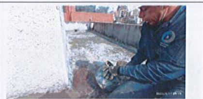
FOTOGRAFÍA No. 26: PARQ. No 8 COUNTRY 85 - Suministro e instalacion de impermeabilización con revestimiento en poliurea para cubierta acceso peatonal
