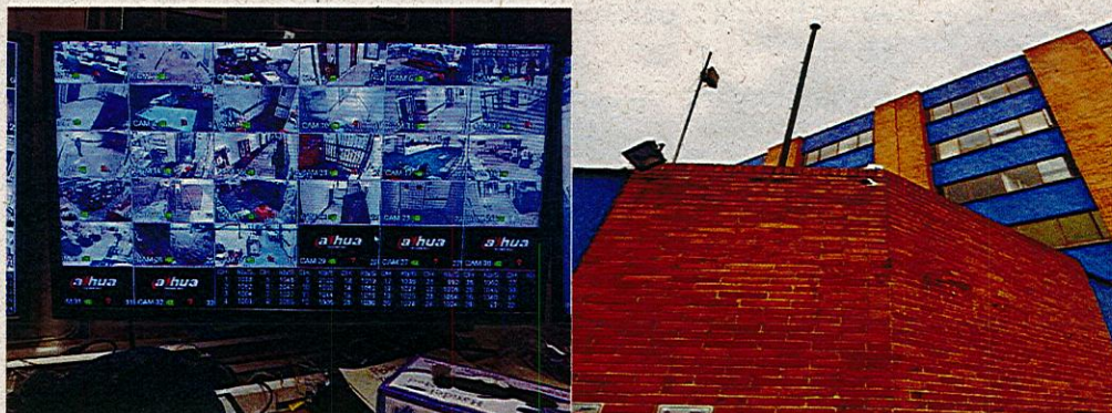
Instalación cámara entrada peatonal y cambio de cámara ingreso urgencias generales
