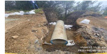
PR59+995 RN 6404 - CONSTRUCCIÓN DE ALCANTARILLAS, INSTALACIÓN DE TUBERÍA
