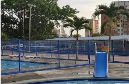
Fotografía 55: Estado actual intervención (Fuente propia)
