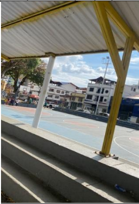
Fotografía 42: Estado actual intervención (Fuente propia)
