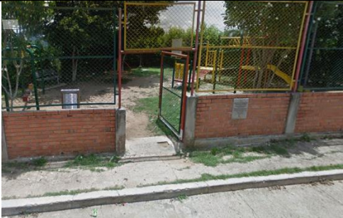
Fotografía 199: Estado actual intervención (Fuente propia)
