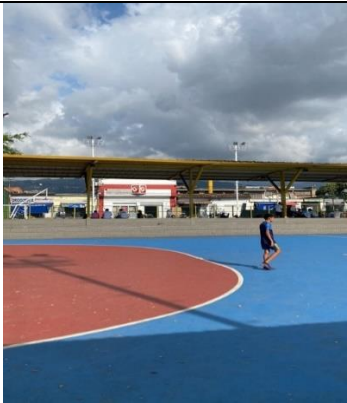
Fotografía 43: Estado actual intervención (Fuente propia)
