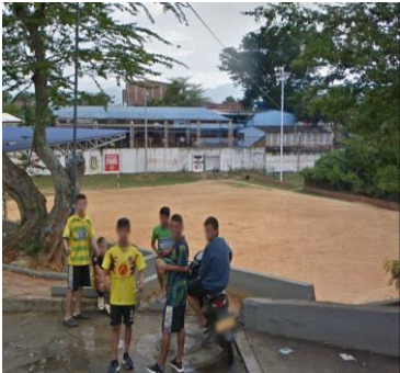
Fotografía 39: Estado actual intervención (Fuente propia)
