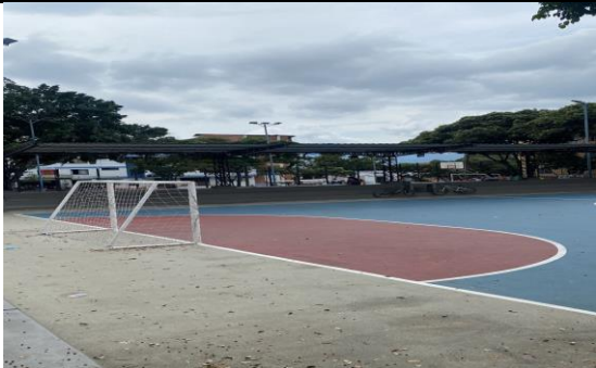
Fotografía 143: Estado actual intervención (Fuente propia)
