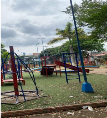
Fotografía 146: Estado actual intervención (Fuente propia)
