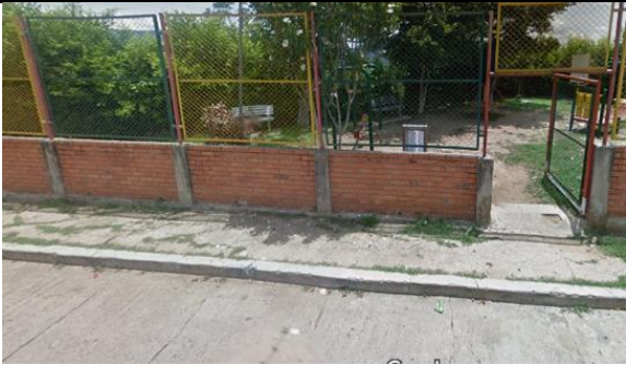
Fotografía 197: Estado actual intervención (Fuente propia)
