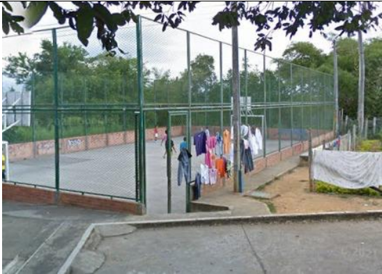
Fotografía 65: Estado actual intervención (Fuente propia)
