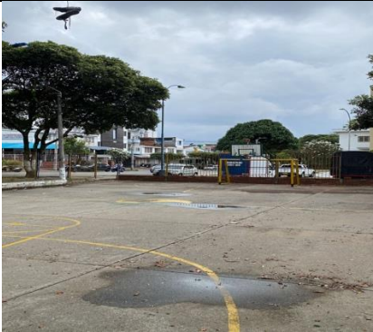
Fotografía 124: Estado actual intervención (Fuente propia)
