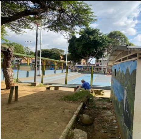
Fotografía 44: Estado actual intervención (Fuente propia)
