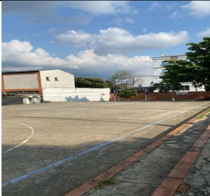
Fotografía 75: Estado actual intervención (Fuente propia)
