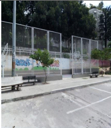
Fotografía 53: Estado actual intervención (Fuente propia)
