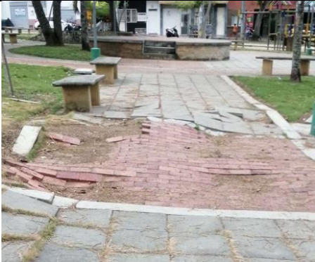
Fotografía 82: Estado actual intervención (Fuente propia)
