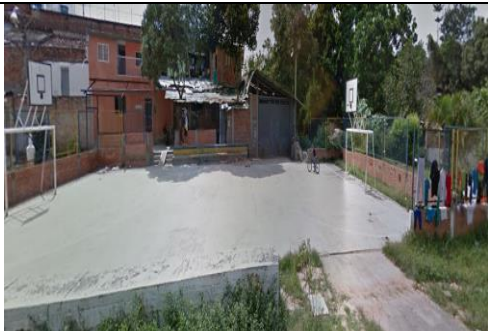
Fotografía 64: Estado actual intervención (Fuente propia)
