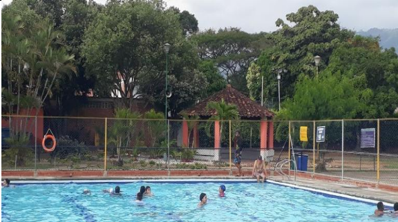
Fotografía 123: Estado actual intervención (Fuente propia)
