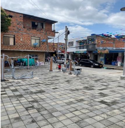
Fotografía 129: Estado actual intervención (Fuente propia)
