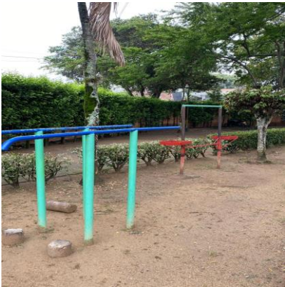
Fotografía 58: Estado actual intervención (Fuente propia)
