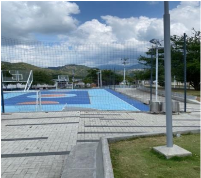
Fotografía 16: Estado actual intervención (Fuente propia)
