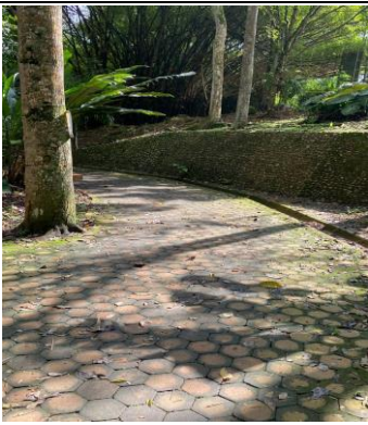
Fotografía 150: Estado actual intervención (Fuente propia)
