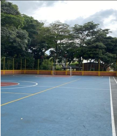
Fotografía 107: Estado actual intervención (Fuente propia)
