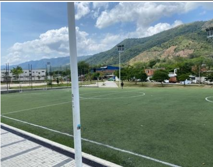
Fotografía 21: Estado actual intervención (Fuente propia)
