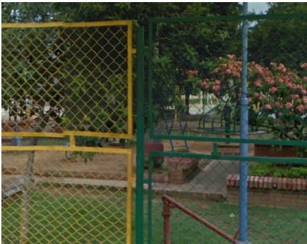
Fotografía 119: Estado actual intervención (Fuente propia)
