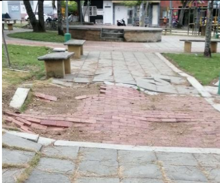
Fotografía 82: Estado actual intervención (Fuente propia)
