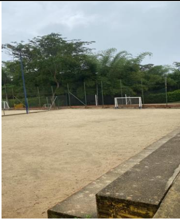
Fotografía 60: Estado actual intervención (Fuente propia)
