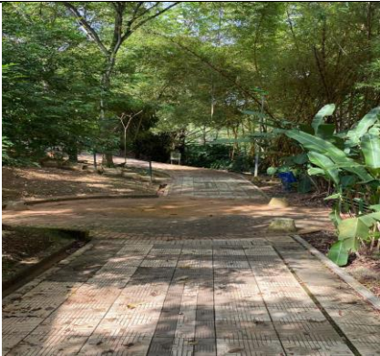
Fotografía 149: Estado actual intervención (Fuente propia)
