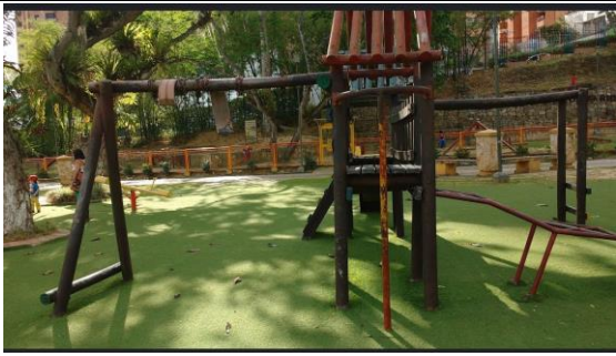
Fotografía 154: Estado actual intervención (Fuente propia)
