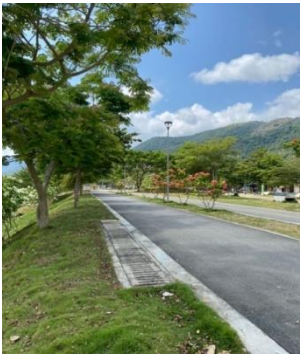
Fotografía 17: Estado actual intervención (Fuente propia)
