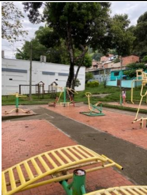
Fotografía 34: Estado actual intervención (Fuente propia)
