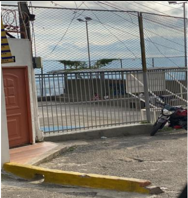
Fotografía 172: Estado actual intervención (Fuente propia)
