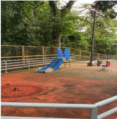
Fotografía 104: Estado actual intervención (Fuente propia)
