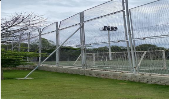
Fotografía 147: Estado actual intervención (Fuente propia)
