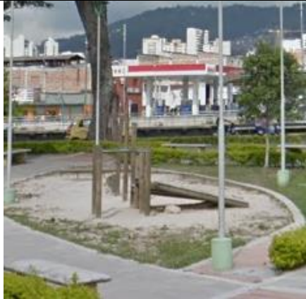
Fotografía 84: Estado actual intervención (Fuente propia)
