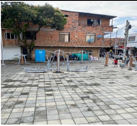
Fotografía 131: Estado actual intervención (Fuente propia)
