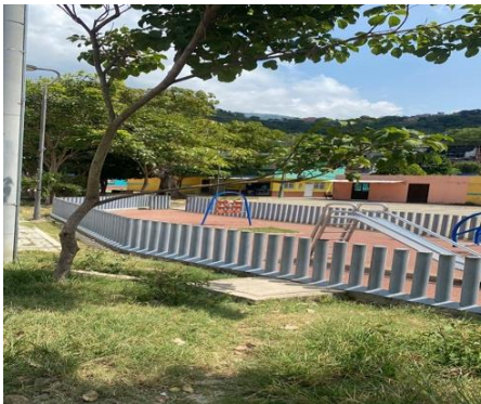
Fotografía 14: Estado actual intervención (Fuente propia)
