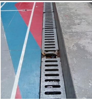
Fotografía 54: Estado actual intervención (Fuente propia)
