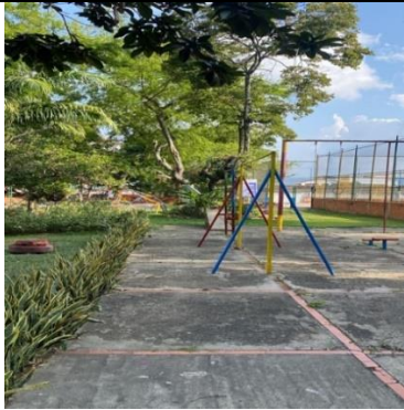
Fotografía 73: Estado actual intervención (Fuente propia)
