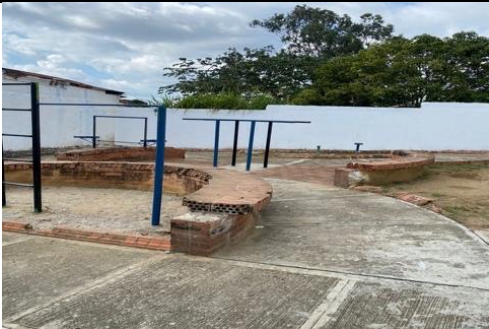
Fotografía 50: Estado actual intervención (Fuente propia)
