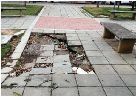
Fotografía 80: Estado actual intervención (Fuente propia)
