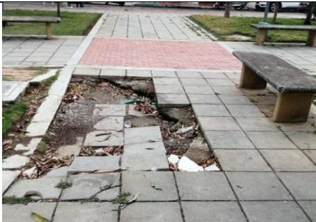
Fotografía 80: Estado actual intervención (Fuente propia)
