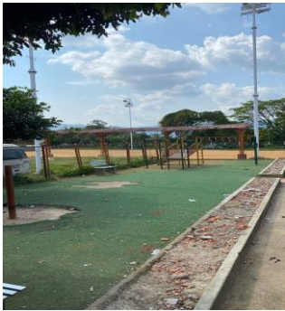
Fotografía 190: Estado actual intervención (Fuente propia)
