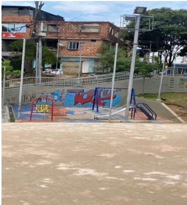
Fotografía 128: Estado actual intervención (Fuente propia)
