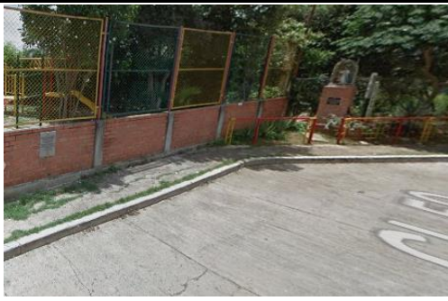
Fotografía 198: Estado actual intervención (Fuente propia)
