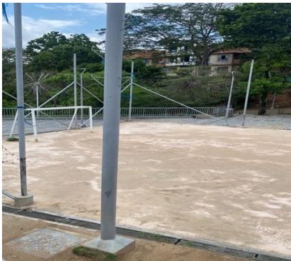
Fotografía 132: Estado actual intervención (Fuente propia)
