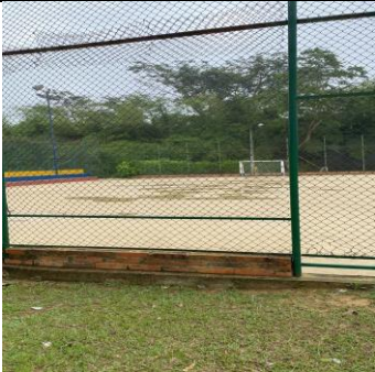
Fotografía 61: Estado actual intervención (Fuente propia)
