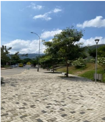
Fotografía 18: Estado actual intervención (Fuente propia)
