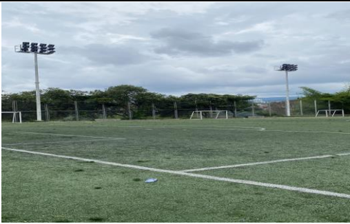
Fotografía 148: Estado actual intervención (Fuente propia)
