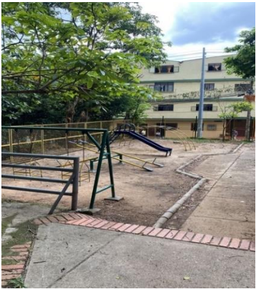
Fotografía 106: Estado actual intervención (Fuente propia)
