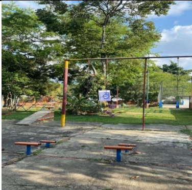
Fotografía 72: Estado actual intervención (Fuente propia)
