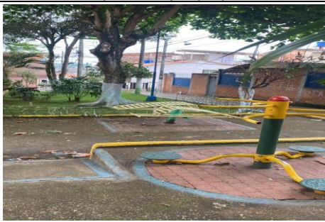
Fotografía 145: Estado actual intervención (Fuente propia)
