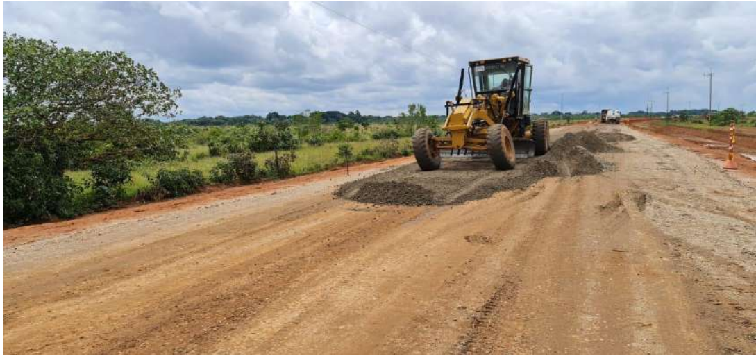
Ilustración 4 – Avance Construcción Sector K1+700 al K4+700
