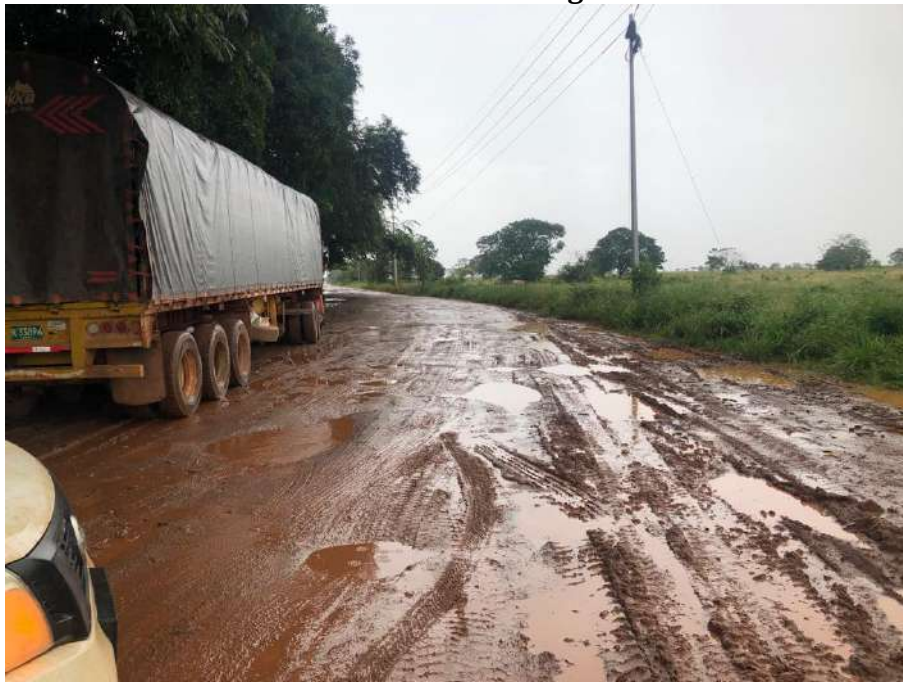
Ilustración 7 – Estado Actual Sector Los Mangos El Viento Km 38 al km 41
