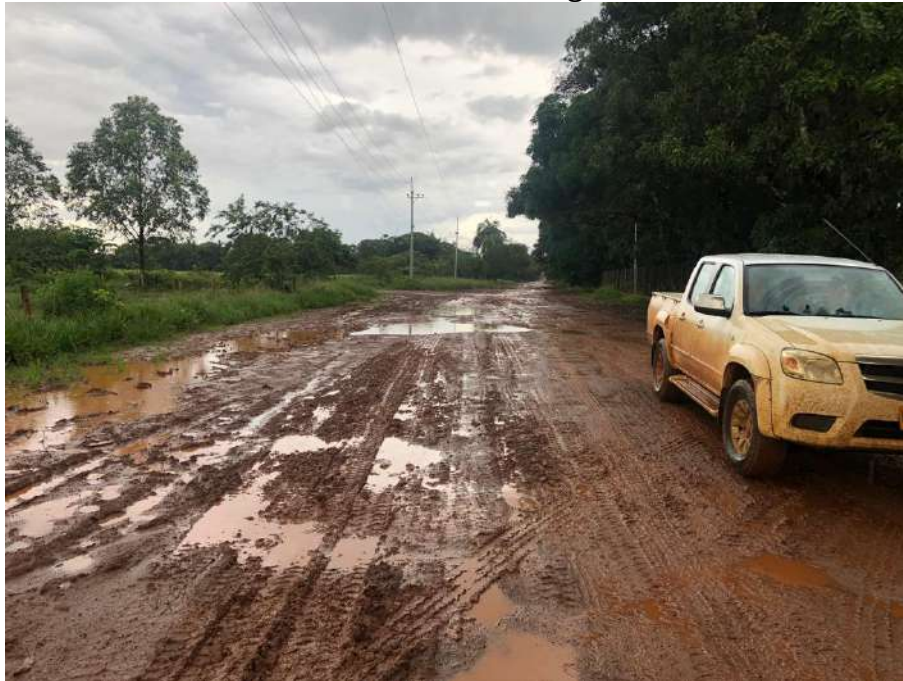
Ilustración 6 – Estado Actual Sector Los Mangos El Viento Km 38 al km 41
