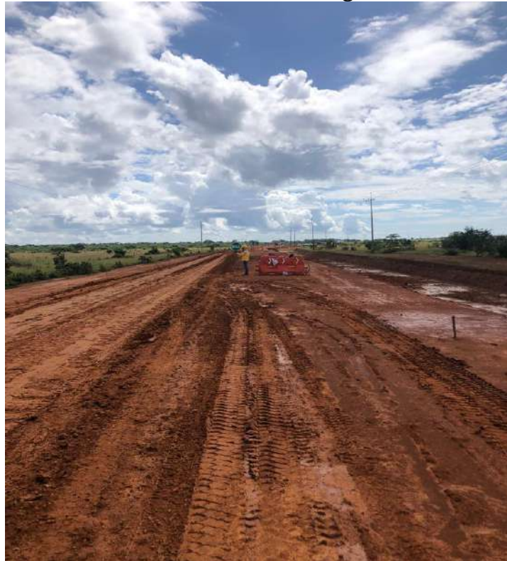
Ilustración 5 – Mantenimiento Sector Los Mangos El Viento Km 38 al km 41
