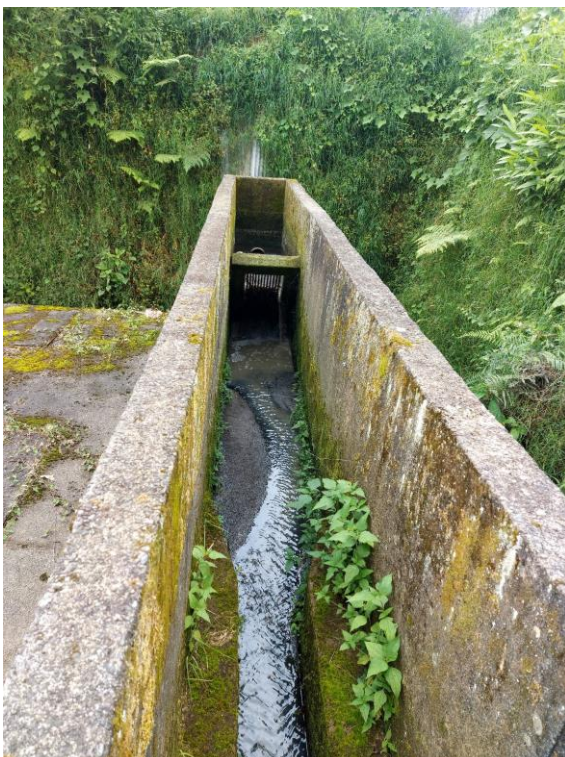
Ilustración 7. Sistema de cribado en condiciones normales. Ilustración 8. PTAR El matadero.
