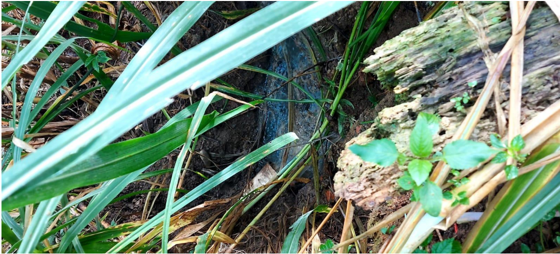
Fotografía 1. Flujo de aguas residuales hacia punto de vertimiento sobre la Quebrada La Orlanda en punto contiguo a las coordenadas latitud: 4° 31' 06,46" N, longitud: -75° 42' 55,90", ocasionado por el mal funcionamiento de la EBAR 1.
