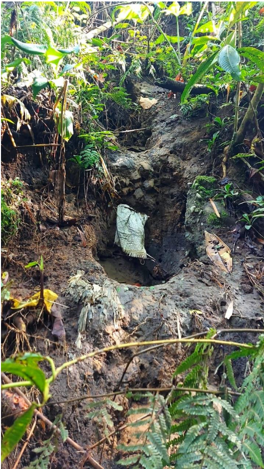
Fotografía 2: Fenómeno de remoción en masa por saturación de agua.
