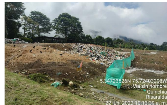
Visita de Seguimiento y Control Relleno Sanitario Río Grande, Quinchía
