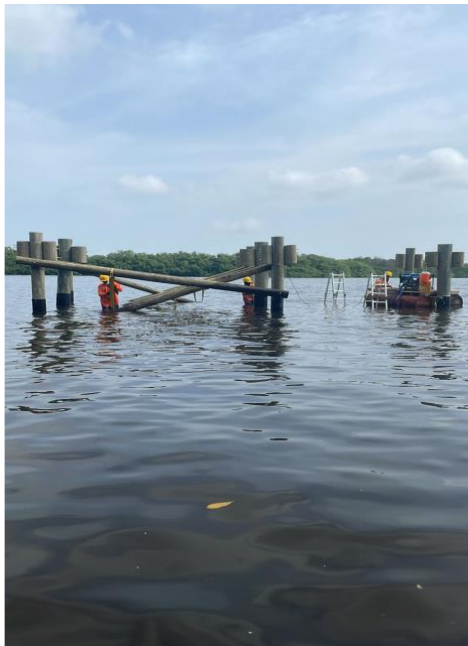
Instalación de riostras módulo 6
