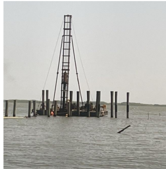
Hincado de pilotes modulo 45
