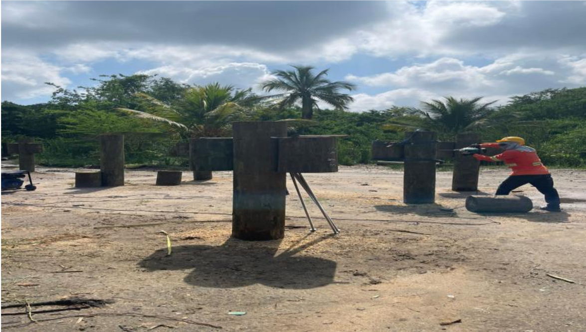
Instalación de tacos de madera.
