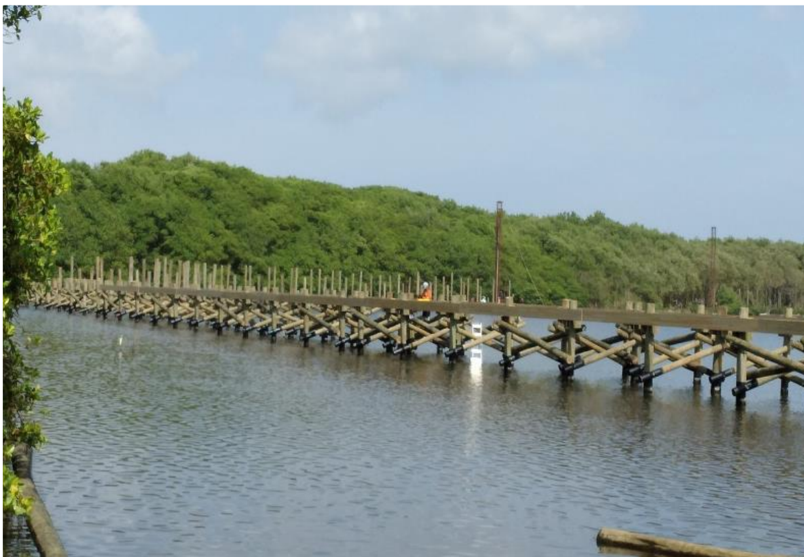
Instalación de Riostras módulo 7
