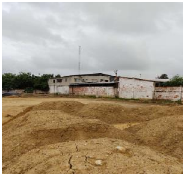
Suministro de material de mejoramiento.
