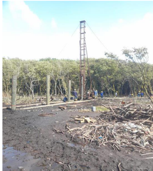
Hincado de pilotes estación la playita
