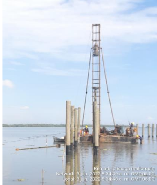
Hincado de módulo 46.
