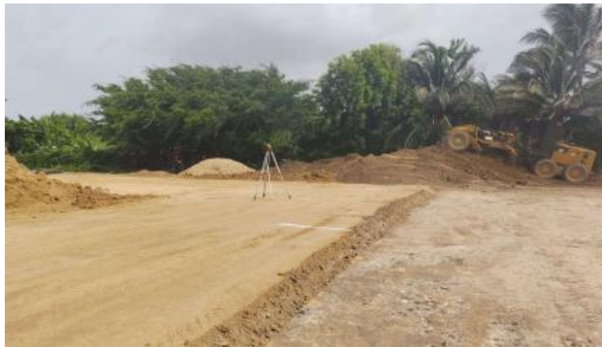
Colocación de material de reemplazo para terraplén de estructura de parqueadero Estación Las Flores.
