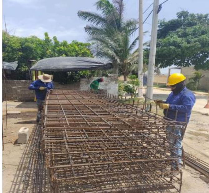
Figuración acero de refuerzo
