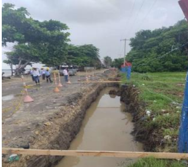
Mejoramiento con material seleccionado
