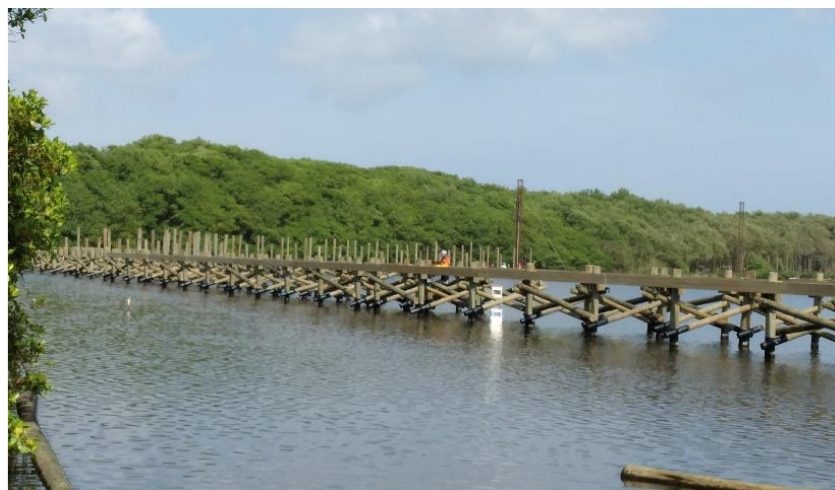
Instalación de riostras módulo 5,6 y 7.
