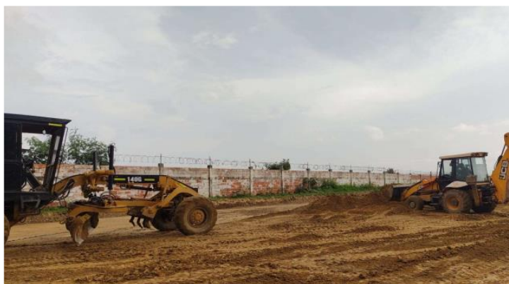
Conformación de material de mejoramiento para terraplén en el parqueadero de la Estación Las Flores.
