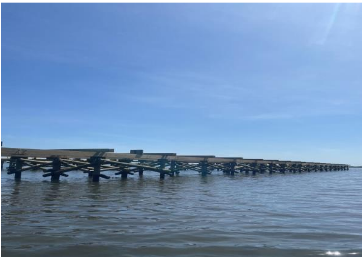
Instalación de viguetas módulo 1, 2 y 3.
