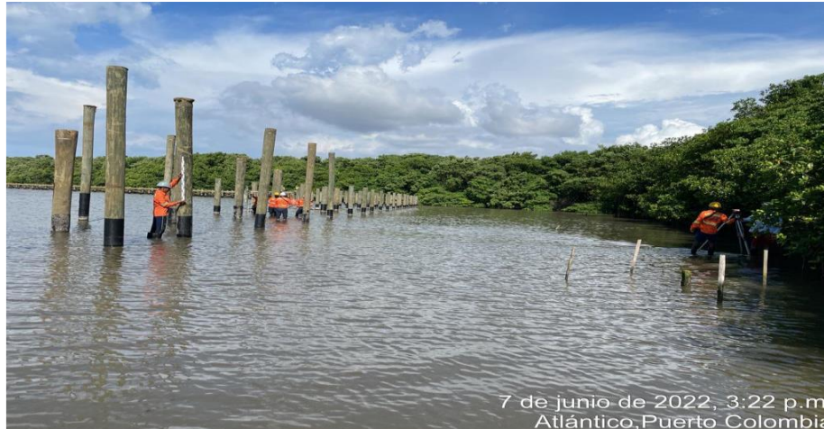
Cortes de pilotes modulo 8.
