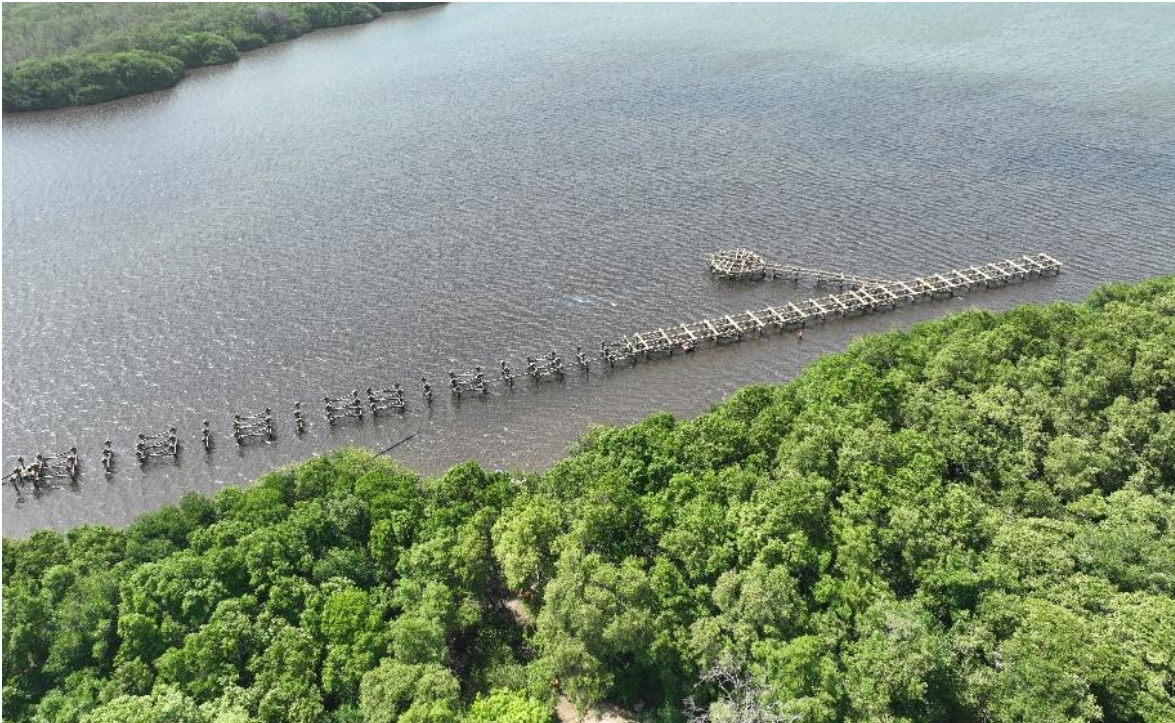
Instalación de riostras módulo 3
