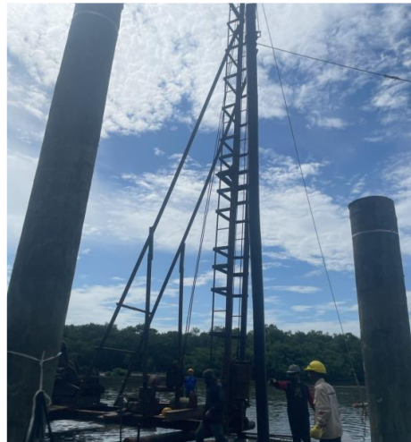
Hincado de módulo 10.
