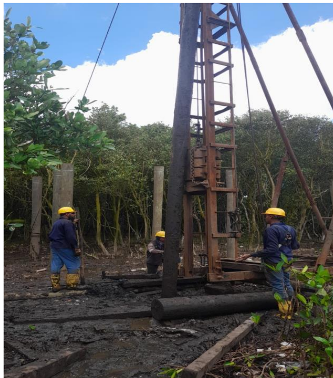
Hincado de módulo 13
