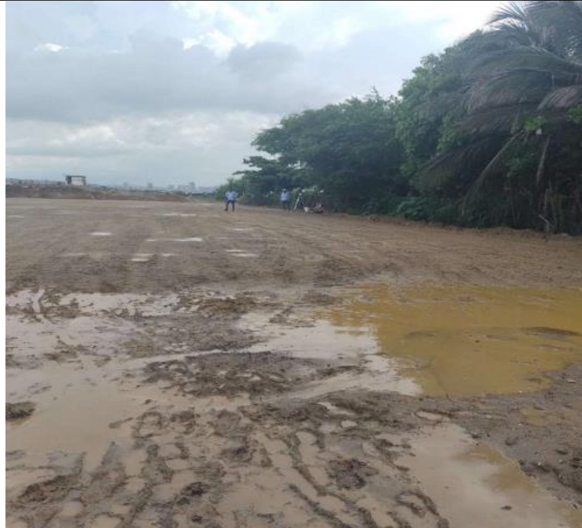
Subrasante parqueadero estación Las Flores.
