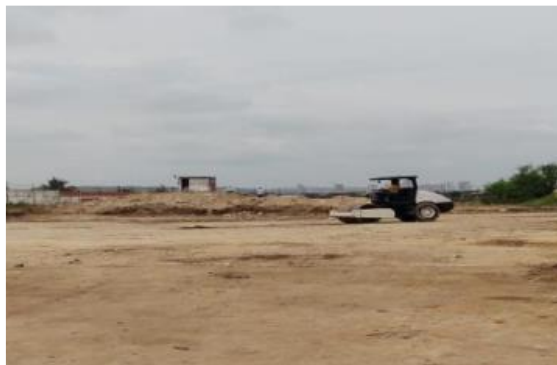
Compactación de subrasante en parqueadero
