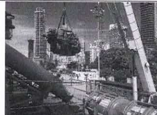
Mantenimiento Sistema Generación Energía Eléctrica – Desmante Motor Generador
