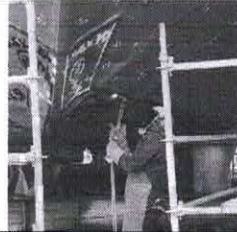
Mantenimiento Casco - Cambio de aceros
