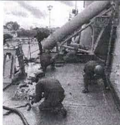
Mantenimiento Sistema Generación Energía Eléctrica – Desmante tapas de inspección
