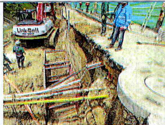
Foto 18. Vista entibado zona de excavaciones. Seguimiento del 09/06/2022
