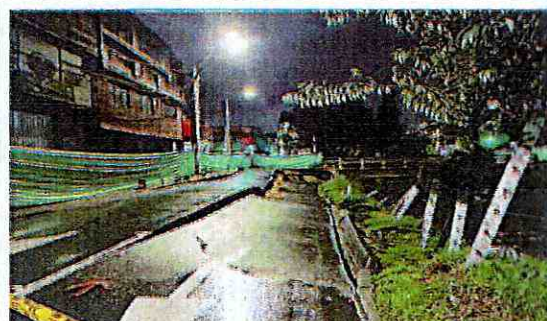
Foto 7 y 8. Vista general del colapso total del carril izquierdo y pérdida de soporte carril derecho vía vehicular de la Av. Calle 3 entre Carrera 58 y Carrera 60, (Seguimiento 0706/2022 21:00hrs)
