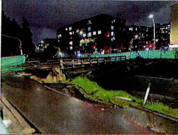
Foto 9. Vista Puente de la Carrera 60 a la altura de la Av. Calle 3 (Seguimiento 0706/2022 21:00hrs)
