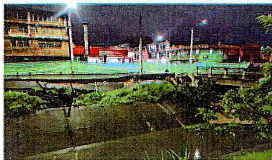
Foto 7 y 8. Vista general del colapso total del carril izquierdo y pérdida de soporte carril derecho vía vehicular de la Av. Calle 3 entre Carrera 58 y Carrera 60, (Seguimiento 0706/2022 21:00hrs)
