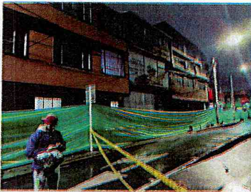
Foto 11. Vista General Predios localizados frente a la vía Vehicular de la Av. Calle 3 entre Carrera 58 y Carrera 60
