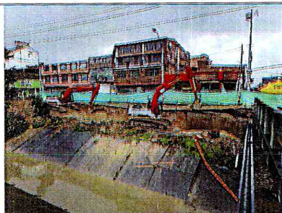
Foto 17. Vista maquinaria de la EAAB. Seguimiento del 09/06/2022
