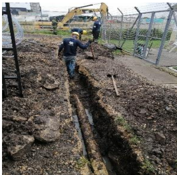
Tubería contrapendiente
