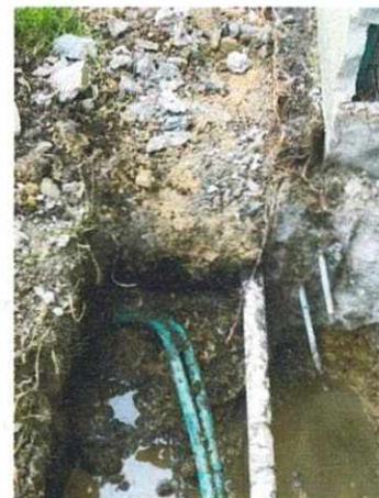
Viga de amarre sin estribo de refuerzo
