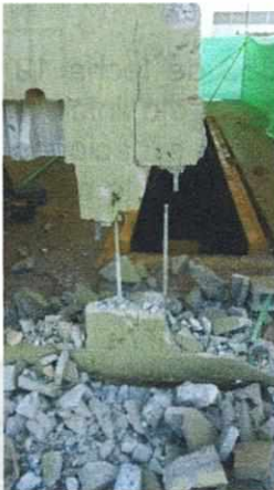
Refuerzo sin traslazo efectivo
