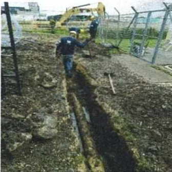
Tubería contrapendiente
