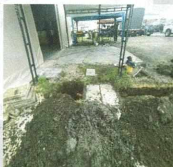
Caja salida baños
