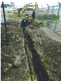
Tubería contrapendiente
