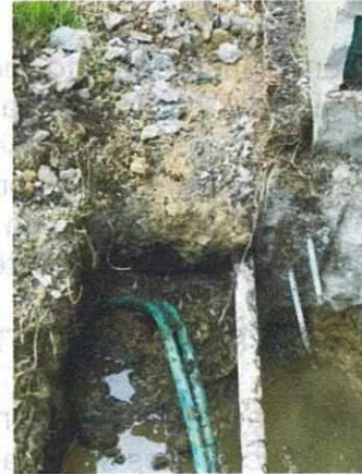
Viga de amarre sin flejes de refuerzo
