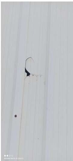
Foto 7. Cubierta en mal estado (tejas rotas)
