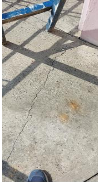
Foto 6. Agrietamiento de piso exterior en concreto
