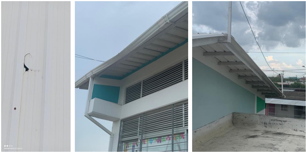
Foto 7. Cubierta en mal estado (tejas rotas)
