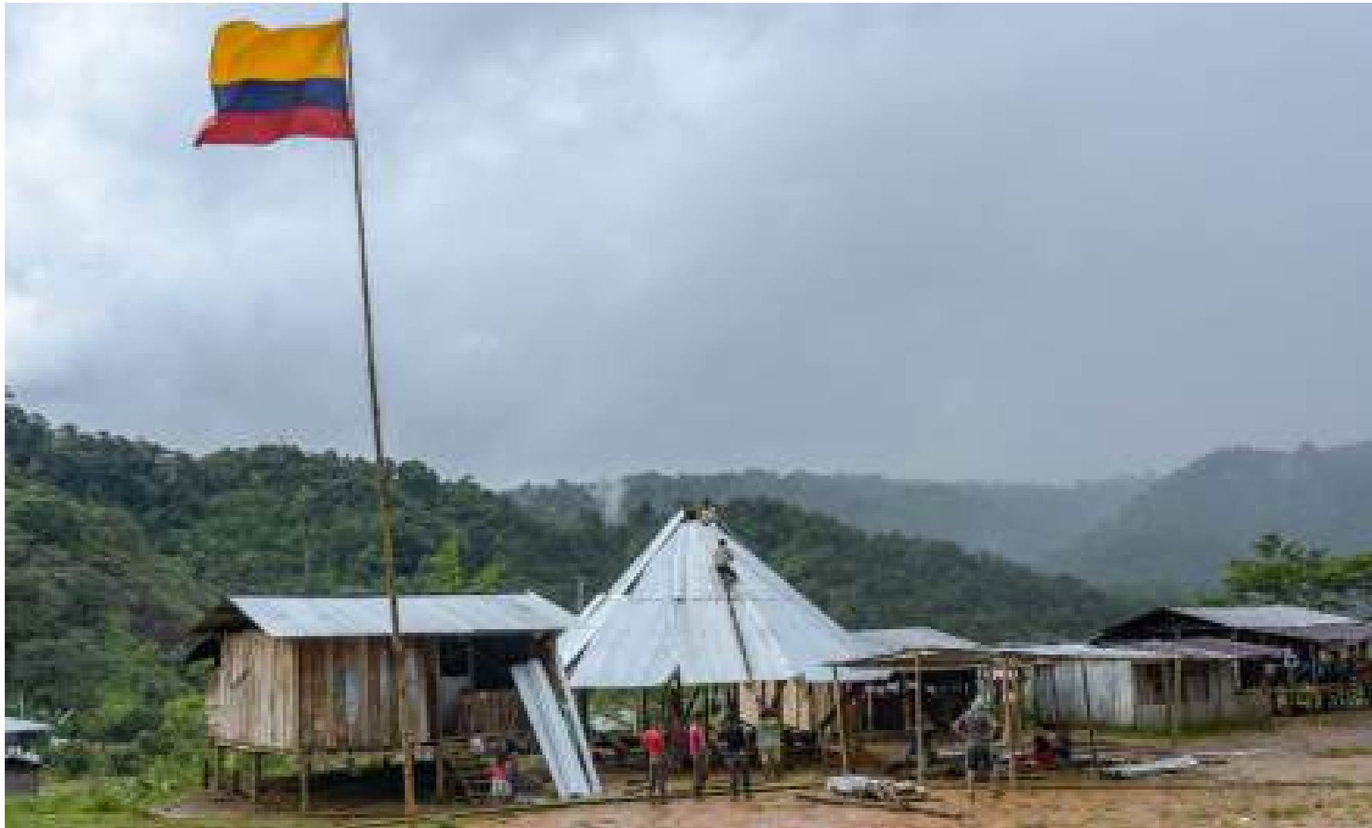
Fotos Alexis Munera_ Proceso de obra.
