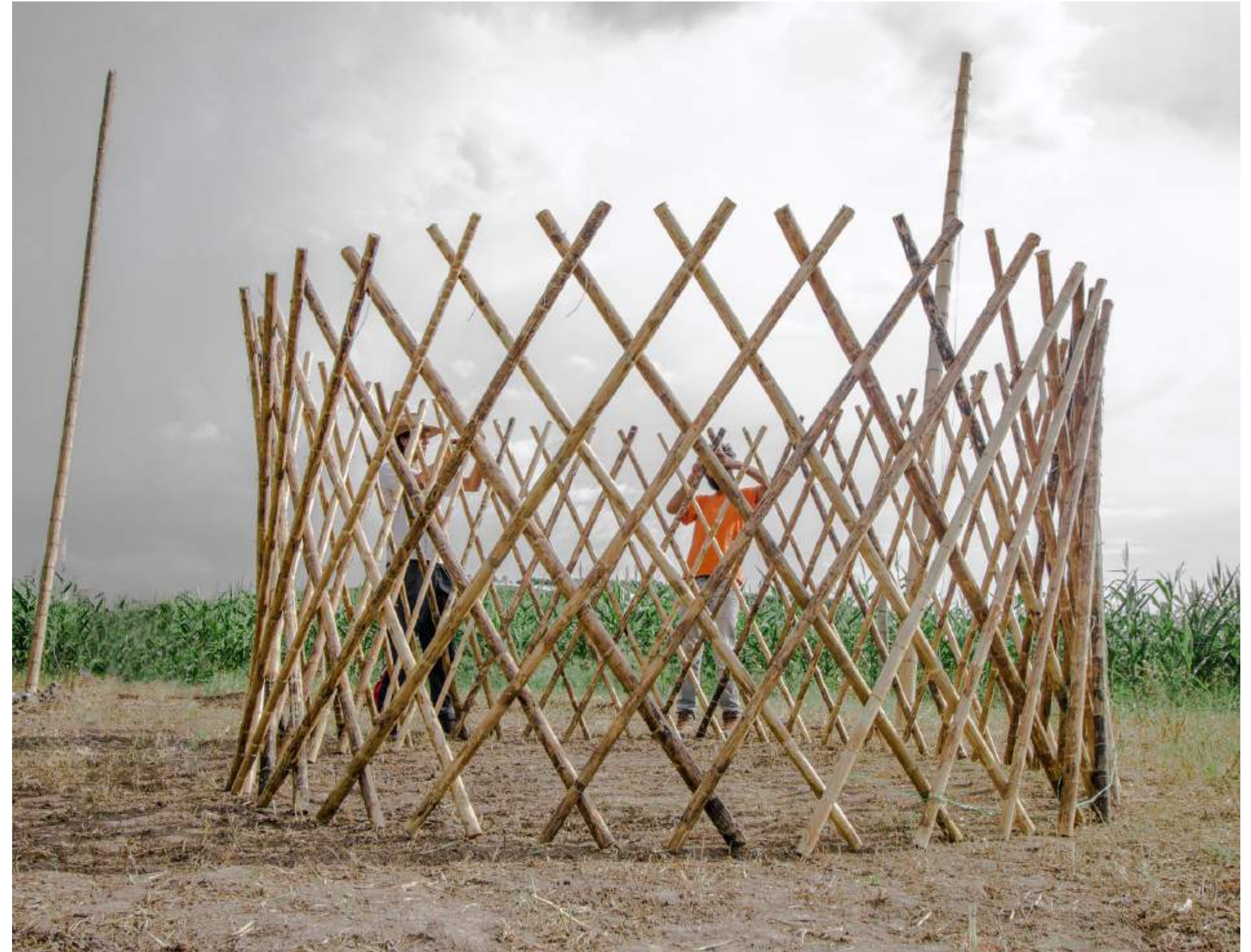
Foto ruta4 taller_Yurta armada y lista para tensar
