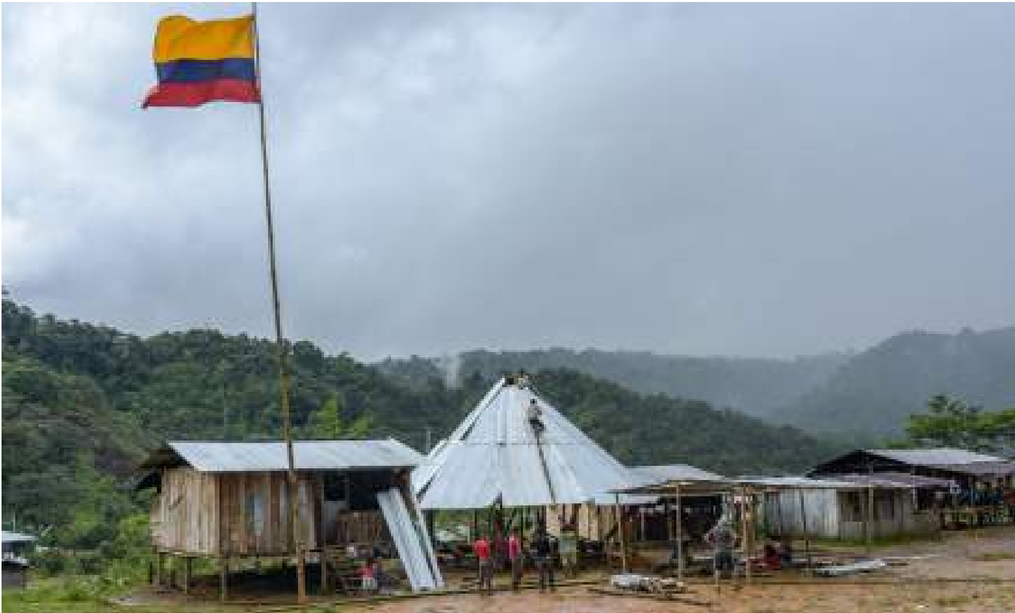
Fotos Alexis Munera_ Proceso de obra.
