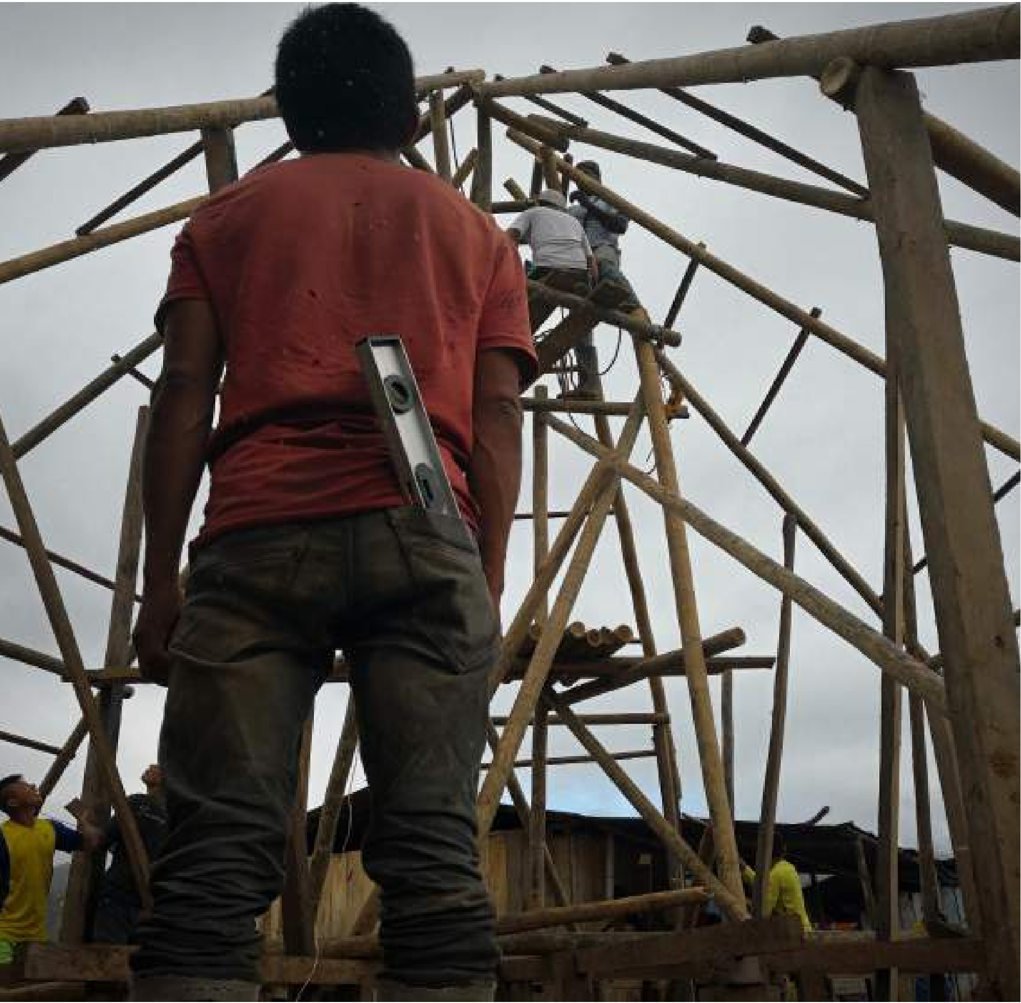
Fotos Alexander Santibañez_ Proceso de Obra.
