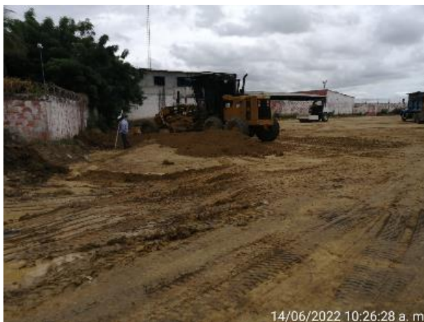
Compactación de subrasante en parqueadero
