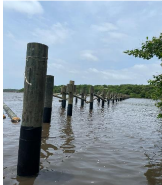
Cortes de pilotes modulo 9 y 10.
