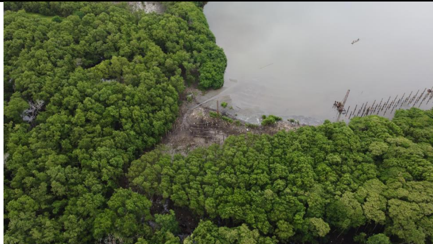
Hincado de pilotes estación la playita.
