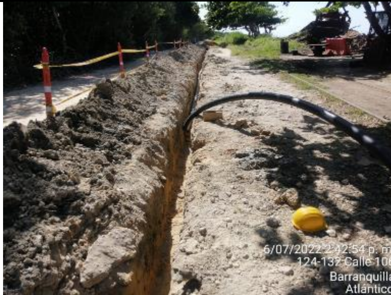
Instalación tubería PEAD 110mm.
