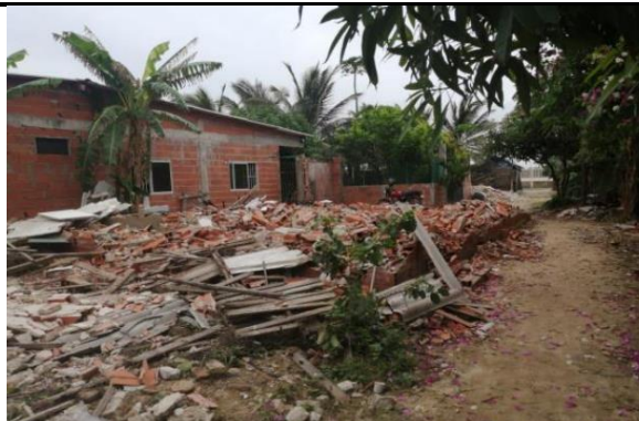
Demolición de viviendas en el lugar del proyecto.
