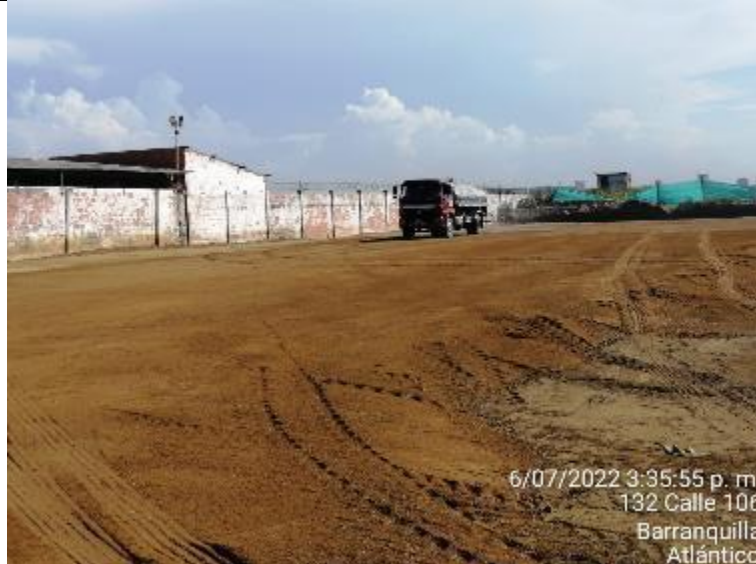
Subbase parqueadero estación Las Flores.
