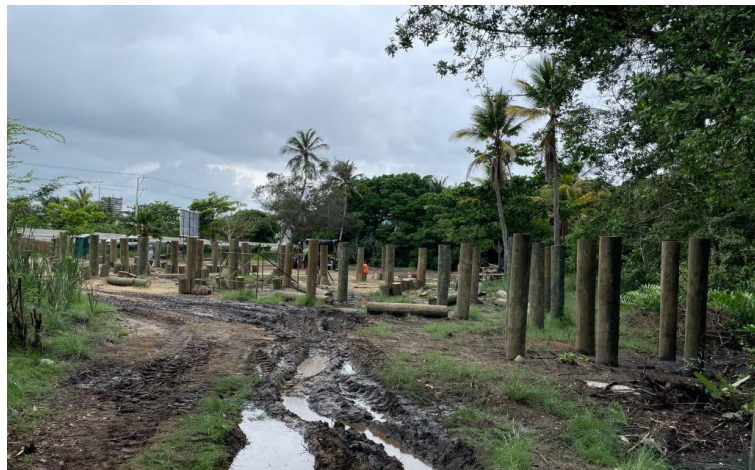
Corte de pilotes Estación III.
