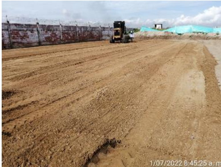
Conformación y compactación subbase granular.
