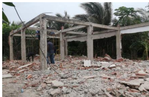
Demolición de viviendas en el lugar del proyecto.
