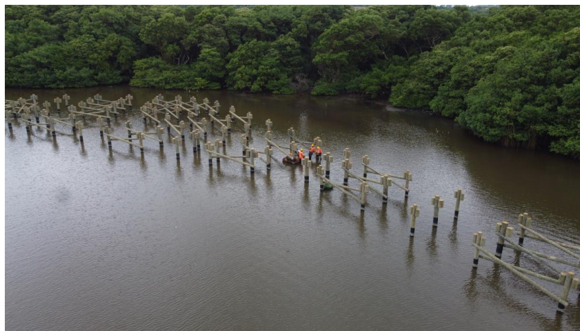
Instalación de Riostras módulo 8
