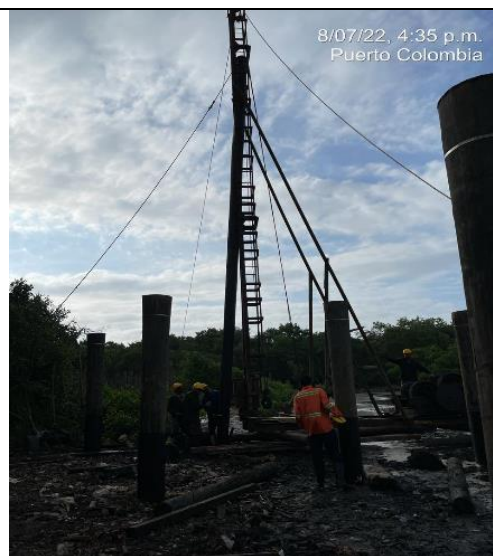
Hincado de módulo 11.
