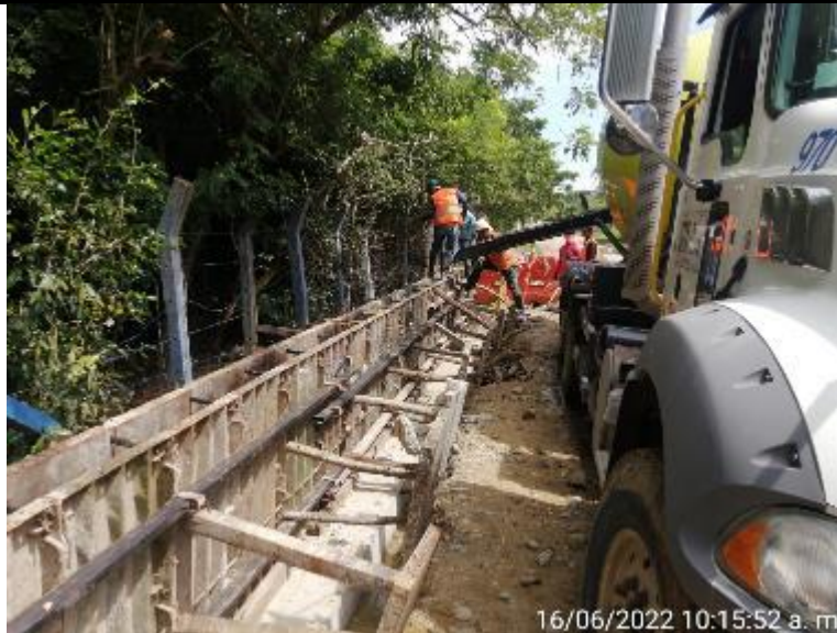
Vaciado de concreto 4000PSI
