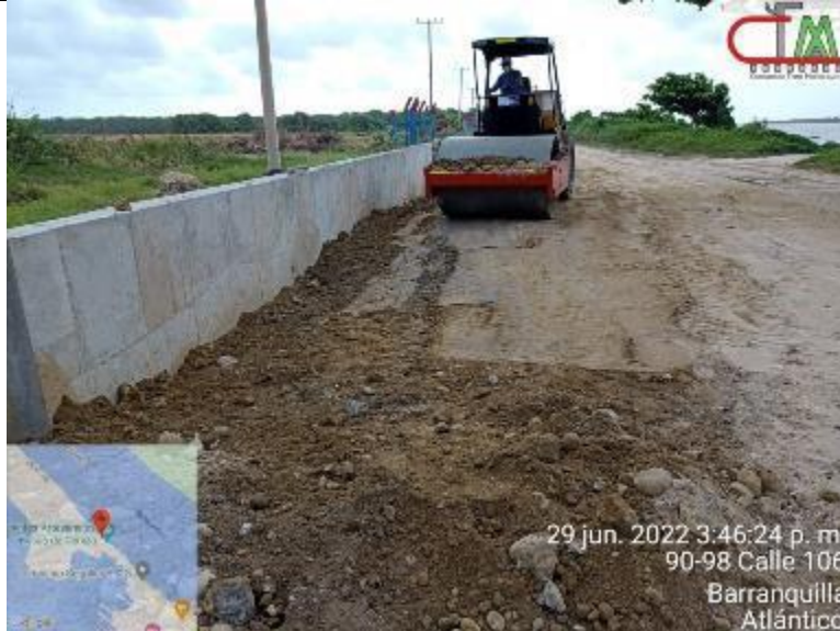
Compactación de rellenos.
