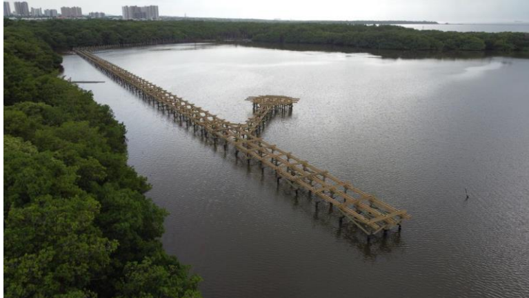
Instalación de riostras módulo 8
