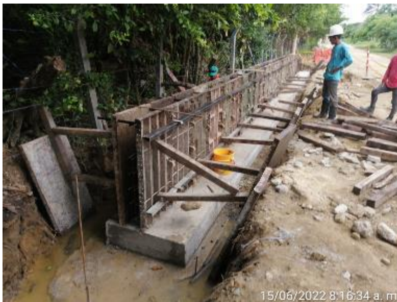
Construcción muro de contención.
