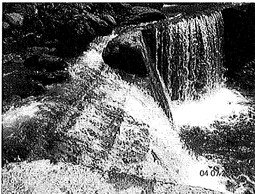
Captación Acueducto de Balboa en La Quebrada La Sirena
