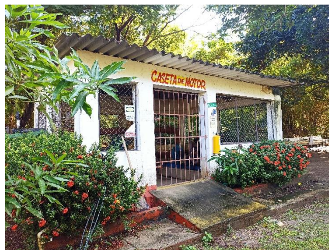
Figura 2. Sistema de Bombeo Finca La Feliciano.
