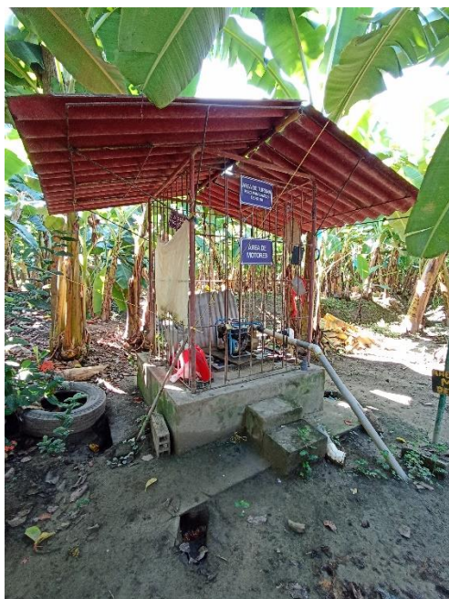
Figura 23. Pozo #1 La reforma 10°51'48.2" W74°11'40.6"
