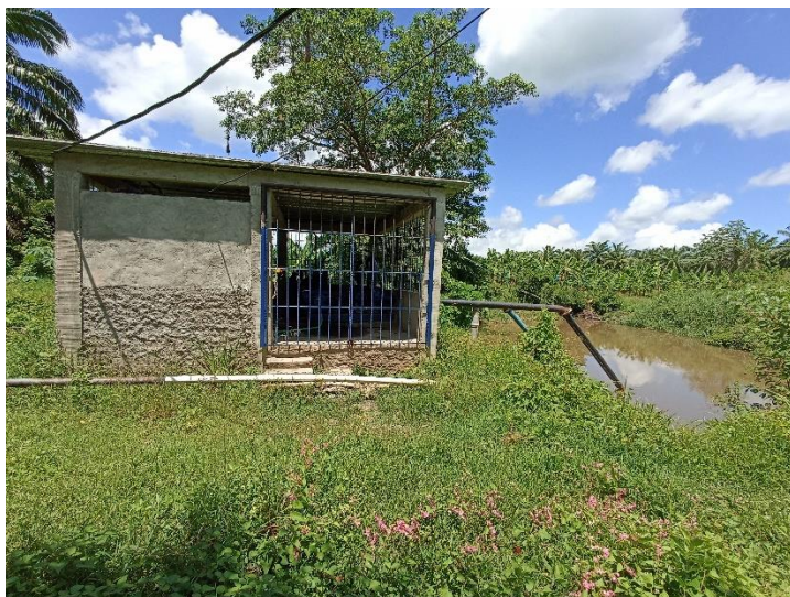
Figura 21. Pozo Aedronomo Pista la Fe N 10° 52' 08.1" W 74° 10' 20.2" 8 de Junio de 2022.
