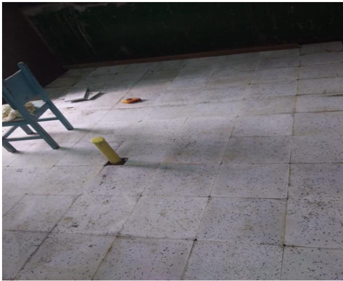
Actividad: Instalación de tubería de 2 " Lugar: Escuela la inmaculada
