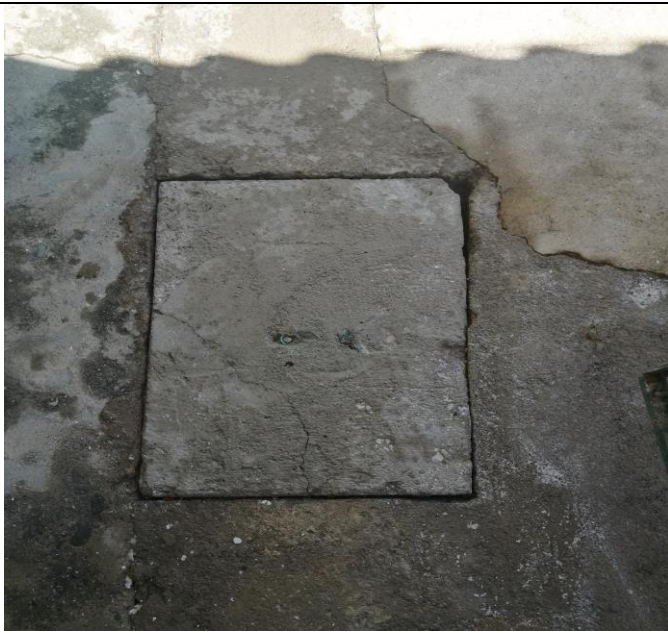
Actividad: Caja de inspección Lugar: Escuela la inmaculada
