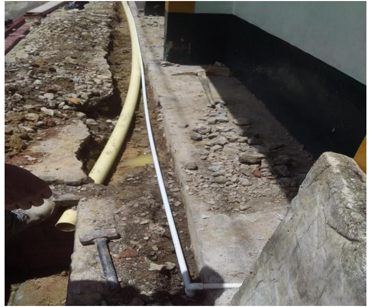
Actividad: Instalación de tubería 3 " Lugar: Escuela la inmaculada
