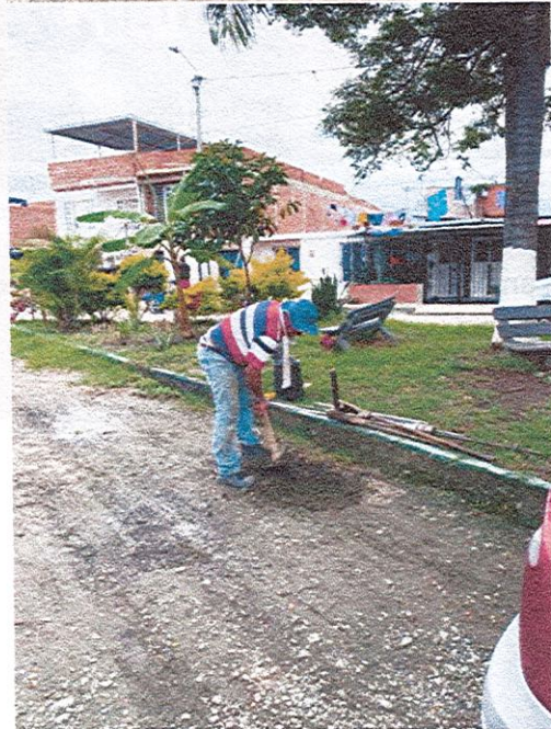
Figura 6 Prospección geotécnica Fuente: Propia
