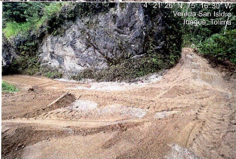
Imagen No.7 Remoción de derrumbes y nivelación de malla vial, vereda San Isidro.
