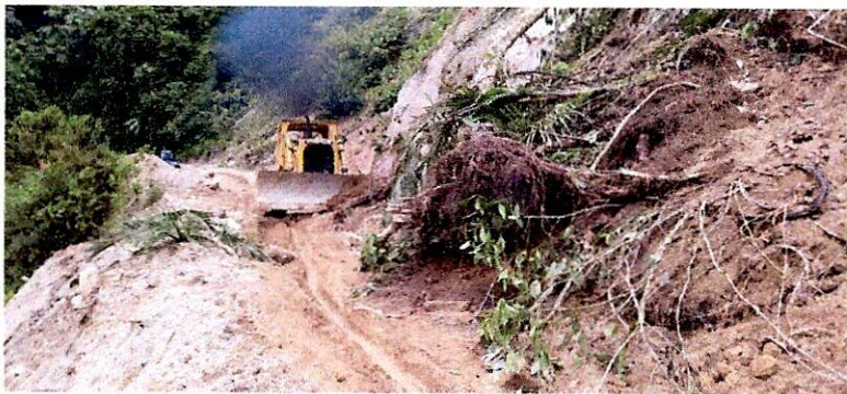
Imagen No.9 Nivelación del Corredor vial de las veredas Ambala, China alta y case banco
