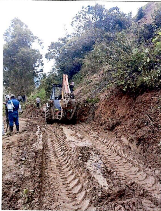
Imagen No.3 Remoción de derrumbes y mejoramiento puntos críticos, vereda Laureles
