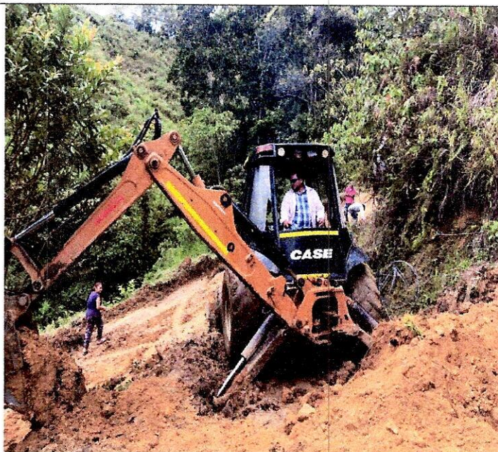
Imagen No.4 Remoción de derrumbes y mejoramiento puntos críticos, vereda la Martinica
