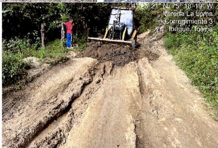
Imagen No.1 Remoción de derrumbes y mejoramiento puntos críticos, vereda la Loma.
