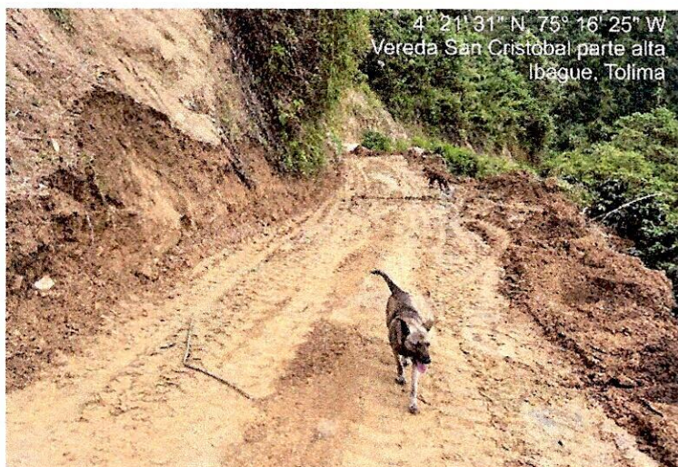
Imagen No.5 Remoción de derrumbes y mejoramiento puntos críticos, vereda San Cristóbal alto
