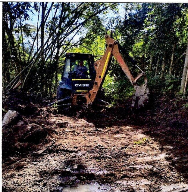
Imagen No.4 Remoción de derrumbes y mejoramiento puntos críticos, vereda la Martinica
