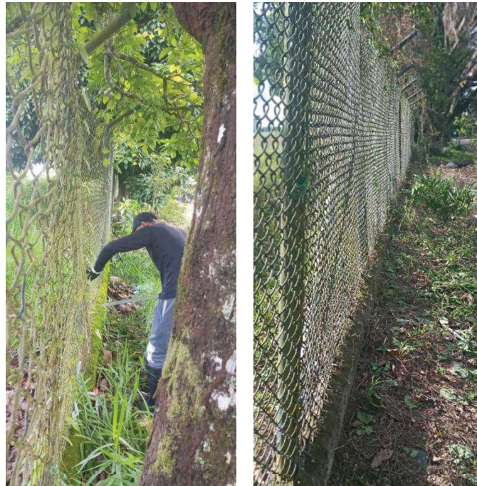
Actividad: Limpieza de Mallas
