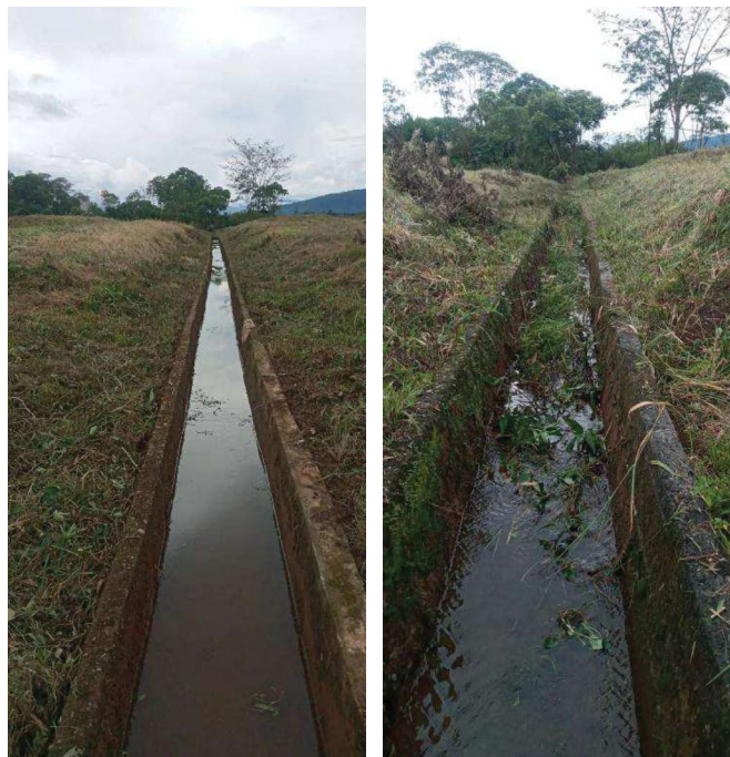
Actividad: Limpieza de Canales
