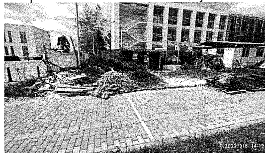
Zona contigua al comedor prestada para ejecución de obras
