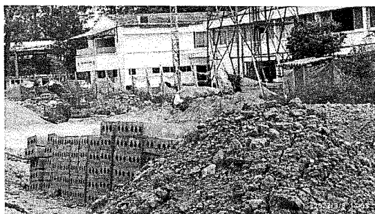
Materiales dispuestos en el bloque 5. Estado del cerramiento en la zona.
