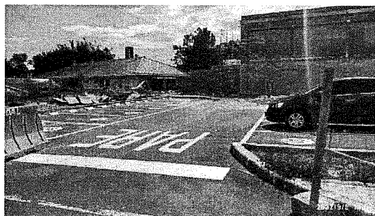
Acopio de materiales en bloque A
