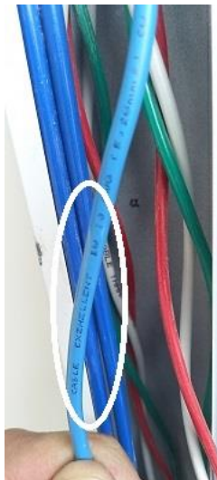
Foto No 1: Conductor No 10 AWG ExZHellent BW con especificaciones de bajo contenido de halógenos.
