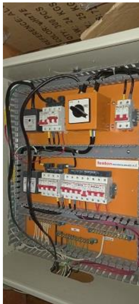
Foto No 5: Modelo de tablero eléctrico bifásico regulado como el que se requirió en el ítem NP8.
