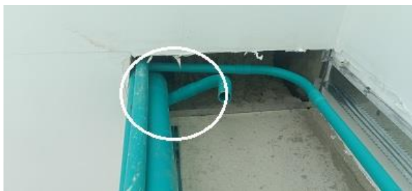
Foto No 8: Tuberías en PVC liviano embebidas en cielo raso.
