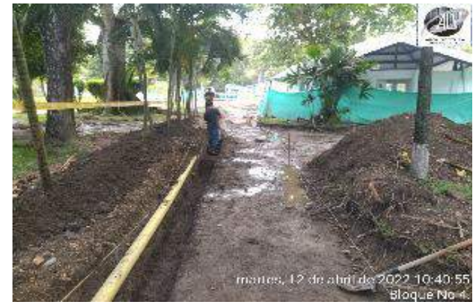
INSTALACION DE TUBERIA DE DRENAJE AGUAS LLUVIAS Y CONFORMACION TERRENO PARA CONSTRUCCION DE ANDEN DE CONEXIÓN BLOQUES
