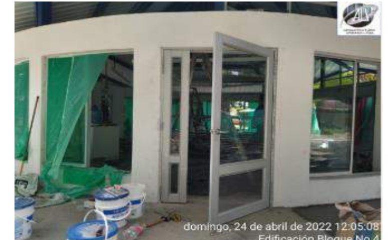
PUERTAS Y VENTANAS EN ALUMINIO INSTALADAS
