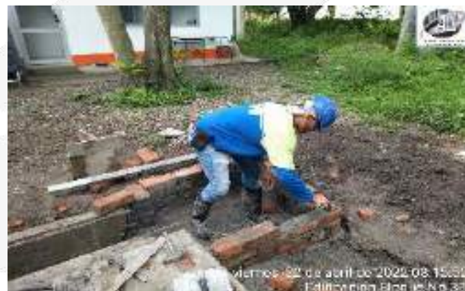
CONSTRUCION CAJA DE CONTROL DRENAJE CUNETA PERIMETRAL
