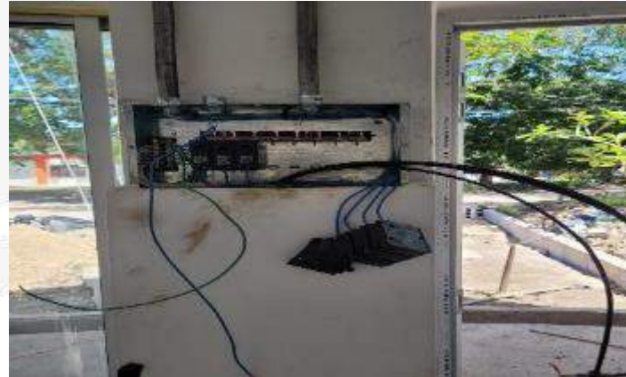
INSTALACION DE TABLERO ELECTRICO
