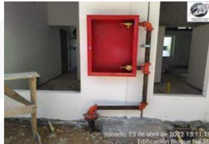
INSTALACION DE GABINETE Y TUBERIA DE RED CONTRA INCENDIOS
