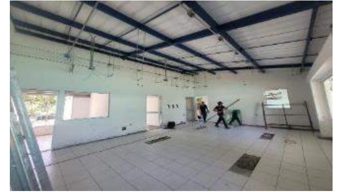
INSTALACION ENCHAPE PISOS
