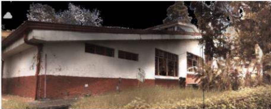
CONDICIONES ACTUALES – FACHADA NORTE
