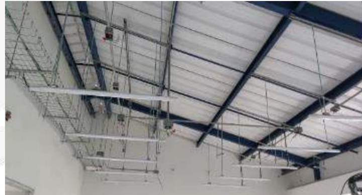
INSTALACION DE BANDEJAS PARA CABLEADOS
