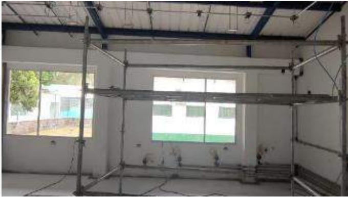
INSTALACION D ETUBERIA MT PARA LUMINARIAS
