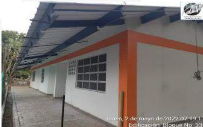
ACABADO DE FACHADAS CON PINTURA INSTITUCIONAL
