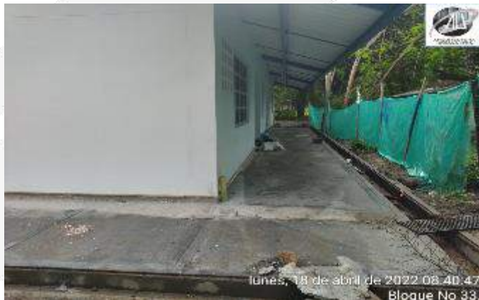
CONSTRUCION Y AFINADO DE ANDEN PERIMETRAL
