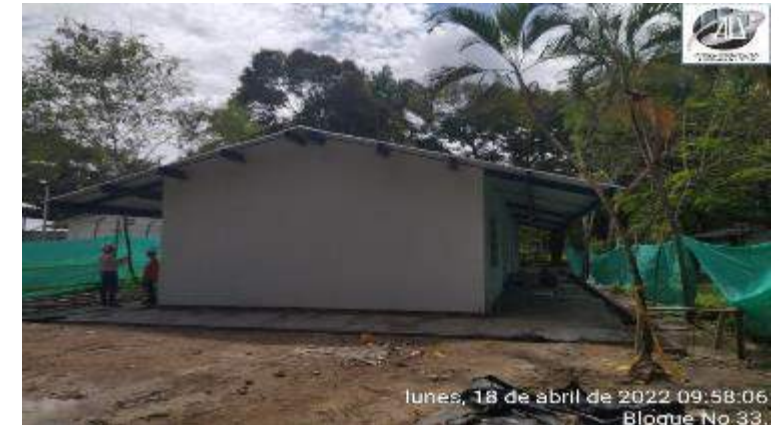
ACABADO DE ANDEN PERITRAL EN CONCRETO DILATADO Y ESCOBIADO
