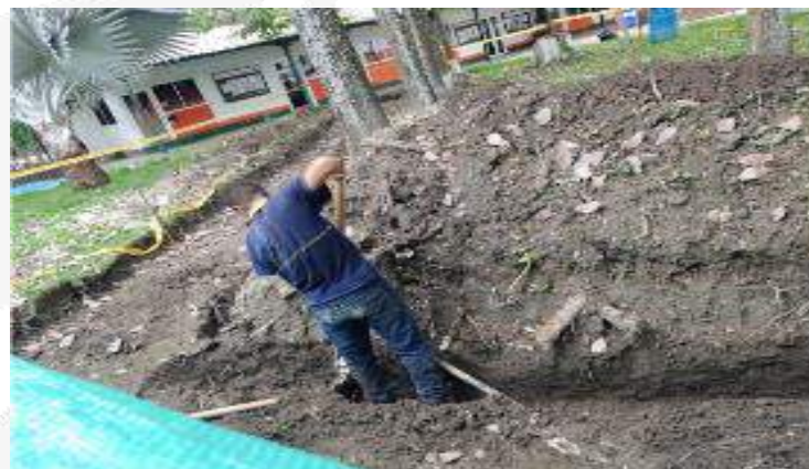
EXCAVACION MANUAL PARA INSTALACION TUBERIA DE DRENAJE AGUAS LLUVIAS
