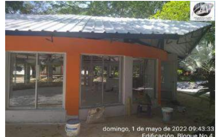
ACABADO DE FACHADAS CON PINTURA INSTITUCIONAL
