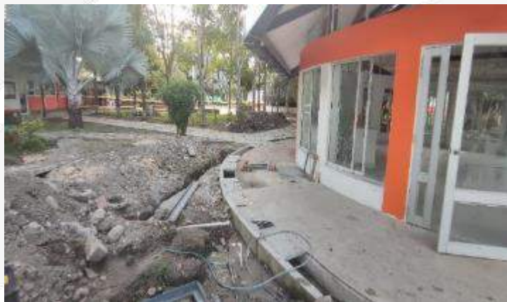
INSTALACION DE REJILLAS METALICAS CARCAMO PERIMETRAL
