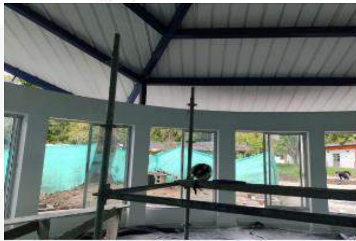
INSTALACION DE VENTANERIA EN ALUMINIO
