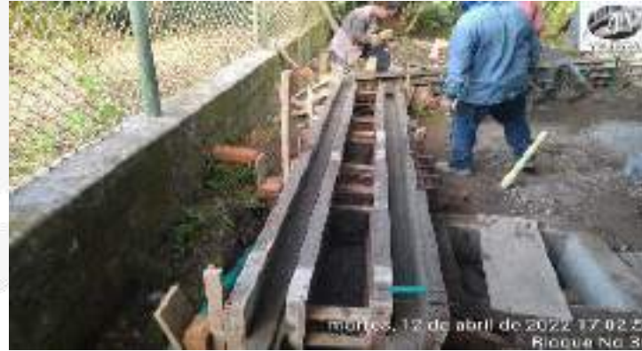
CONSTRUCCION DE CARCAMO DE DRENAJE AGUAS LLUVIAS
