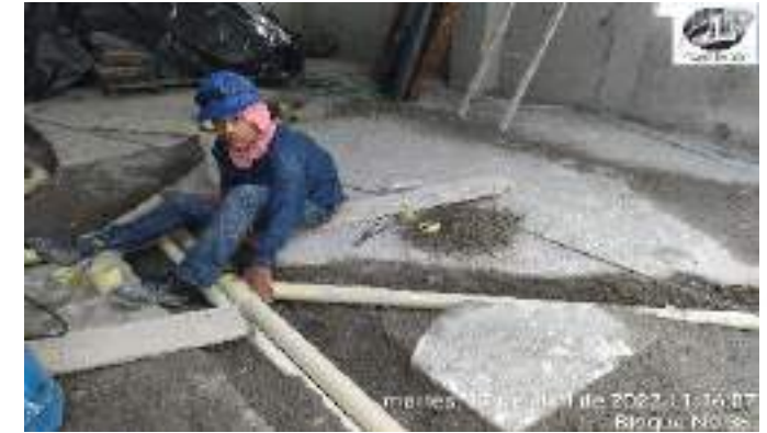
INSTALACION DE TUBERIA SANITARIA
