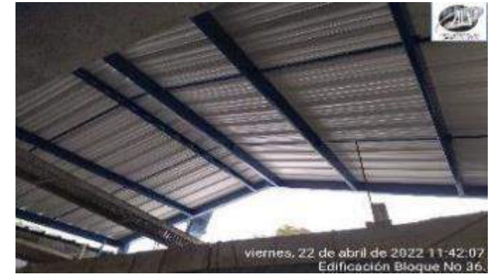
INSTALACION DE CUBIERTA UPVC
