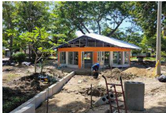
CONSTRUCCION DE ANDEN DE ACCESIBILIDAD ENTRADA PRINCIPAL
