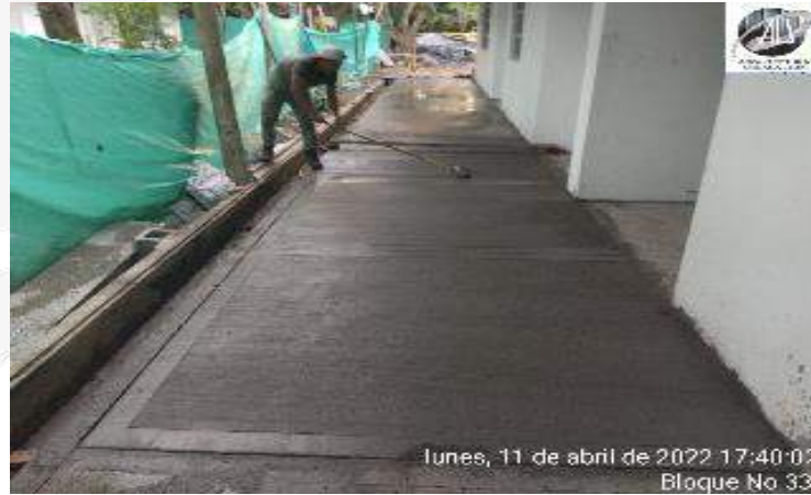
CONSTRUCION Y AFINADO DE ANDEN PERIMETRAL
