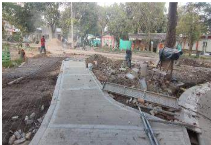
CONSTRUCCION DE ANDEN DE ACCESIBILIDAD ENTRADA PRINCIPAL
