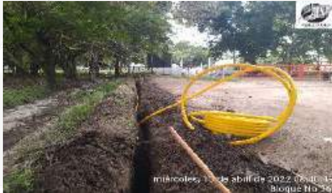
INSTALACION ACOMETIDA DE GAS
