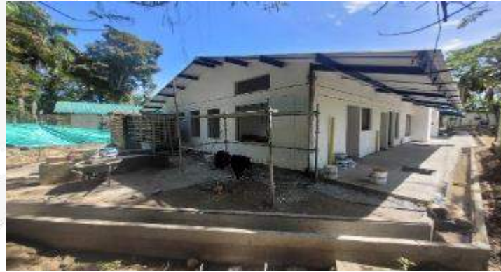
CONSTRUCCION DE ANDEN PERIMETRAL
