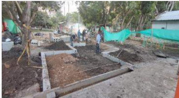
CONFORMACION E INSTALACION DE SARDINEL PREFABRICADO PARA CONSTRUCCION TERRAZA DE ACCESIBILIDAD
