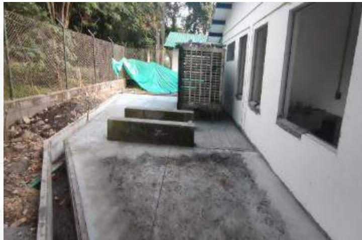
CONSTRUCCION DE ANDEN PERIMETRAL
