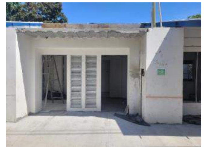
AVANCE DE OBRA DIFERENTES COMPONENTES TECNICOS
