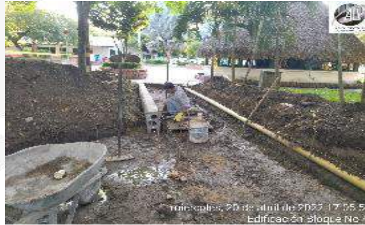
INSTALACION DE SARDINEL PREFABRICADO CONFINAMIENTO DE ANDEN DE CONEXION TERRAZAS Y BLOQUE
