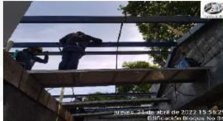
TERMINACION DE INSTALACION ESTRUCTURA METALICA
