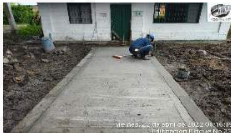
CONSTRUCCION DE ANDEN DE CONEXION
