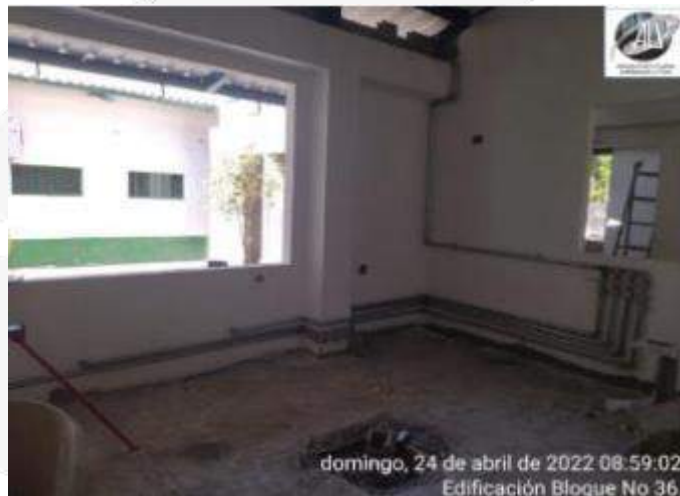
INSTALACION TUBERIA DE GAS INTERNA
