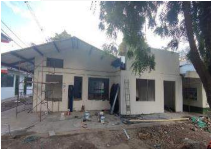
CONSTRUCCION DE DILATACIONES Y ACABADO DE FILOS FACHADA PRINCIPAL
