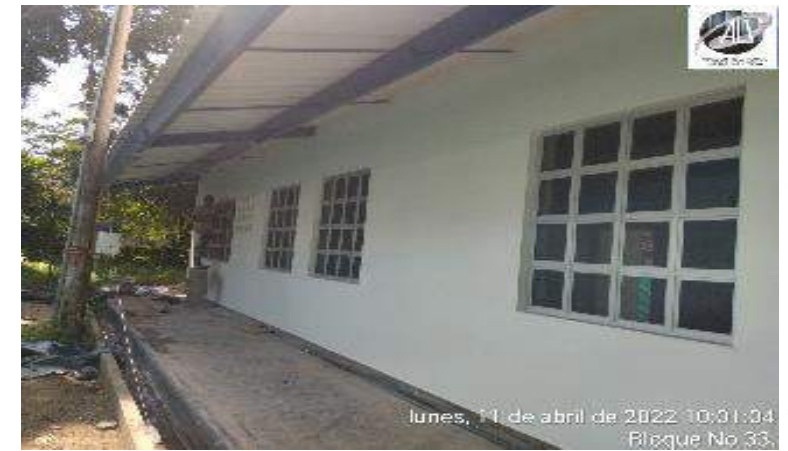
INSTALACION DE VENTANERIA EN ALUMINIO
