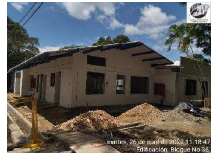
AVANCE DE OBRA DIFERENTES COMPONENTES TECNICOS
