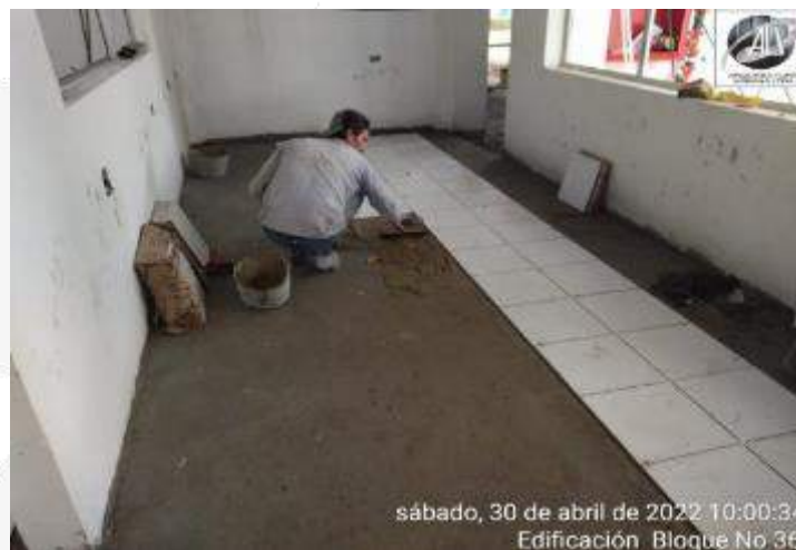
INSTALACION DE ENCHAPES PISOS
