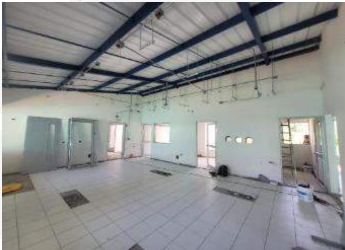
INSTALACION PUERTAS Y VENTANAS EN ALUMINIO
