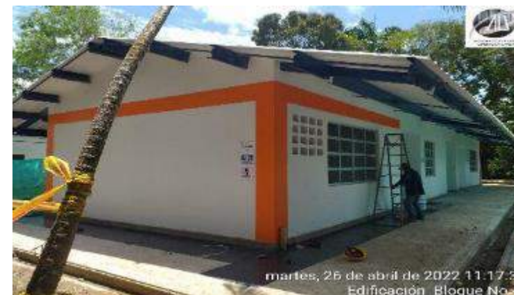
PINTURA DE ACABADO FACHADAS
