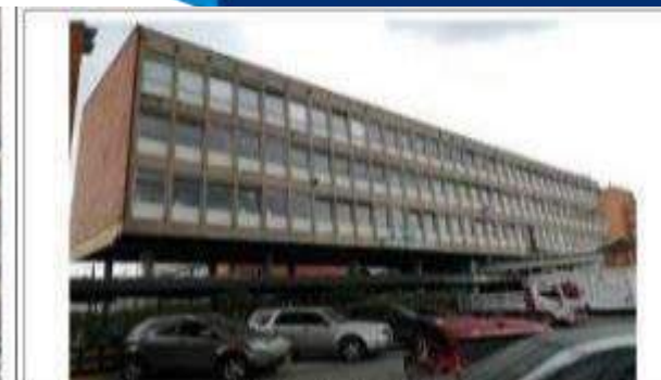
Fotografía 4. Parte de Fachada de la Torre Oriental
