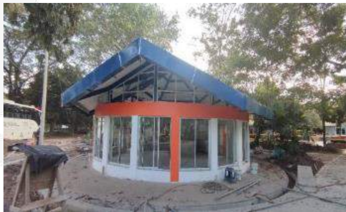
INSTALACION DE CANAL DE AGUAS LLUVIAS CUBIERTA
