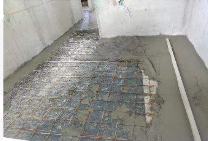
CONSTRUCCION PLACA CONTRAPISO
