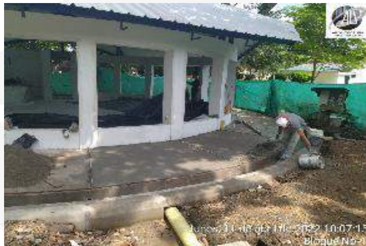
CONSTRUCCION DE DILATACIONES ANDEN PERIMETRAL
