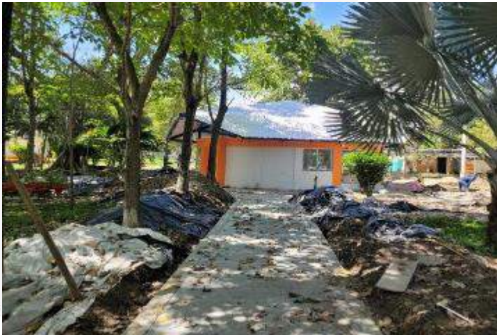
CONSTRUCCION PLACA ANDEN DE ACCESIBILIDAD
