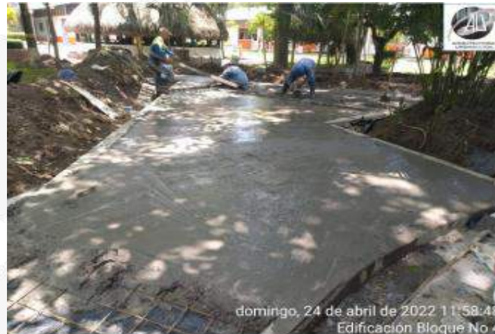
CONSTRUCCION DE ANDEN DE TERRAZAS DE URBANISMO
