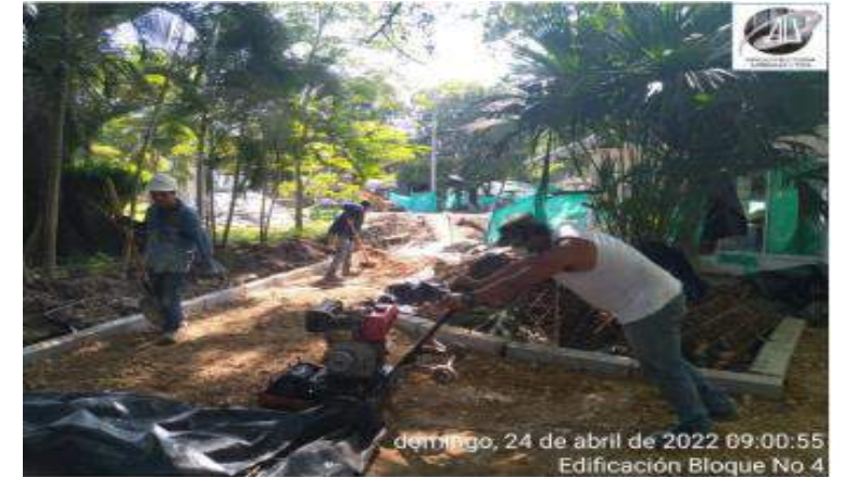
CONFORMACION DE ESTRUCTURA EN RECEBO SELECCIONADO PARA CONSTRUCCION DE ANDEN DE CONEXION TERRAZAS
