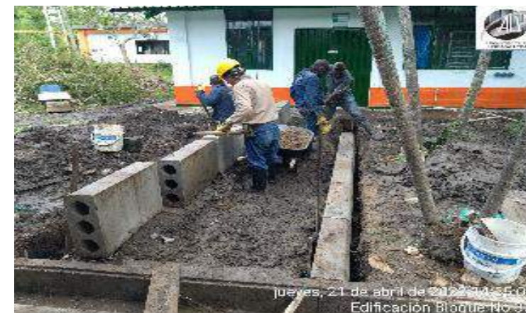
INSTALACION DE SARDINEL PREFABRICADO CONFINAMIENTO DE ANDEN DE COEXION BLOQUE
