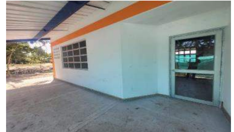
INSTALACION DE VENTANERIA Y PUERTAS EN ALUMINIO
