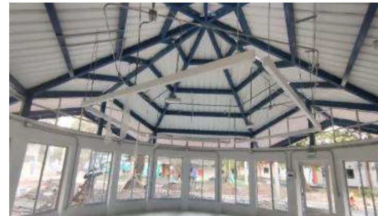
INSTALACION DE LUMINARIAS
