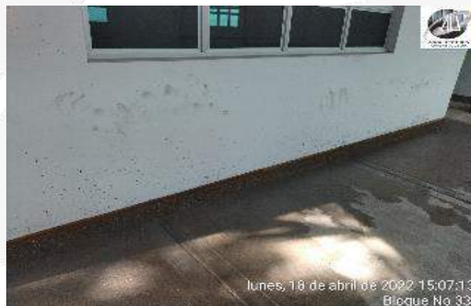
CONSTRUCION DE GUARDAESCOBA EN GRANITO LAVADO
