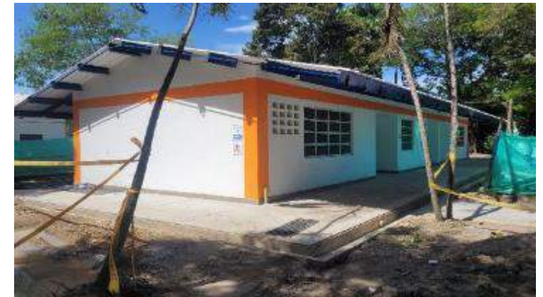
PINTURA DE ACABADO FACHADAS INSTITUCIONAL
