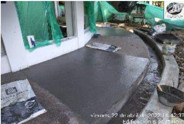
CONSTRUCCION PLACA EN GRANITO LAVADO ANDEN PERIMETRAL
