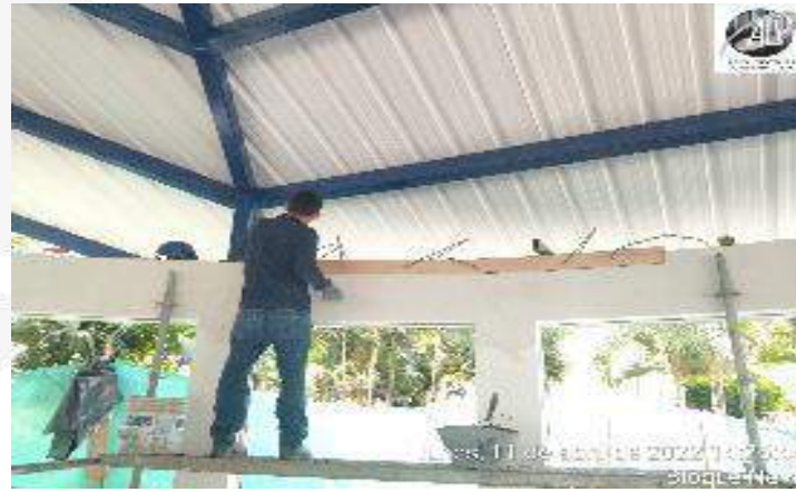
ACABADO DE FILOS EN ESTUCO Y PINTURA
