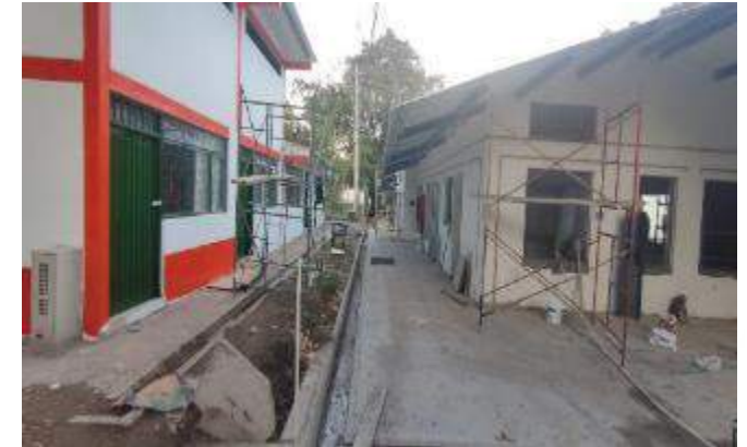
CONSTRUCCION DE DILATACIONES Y ACABADO DE FILOS FACHADAS LATERALES
