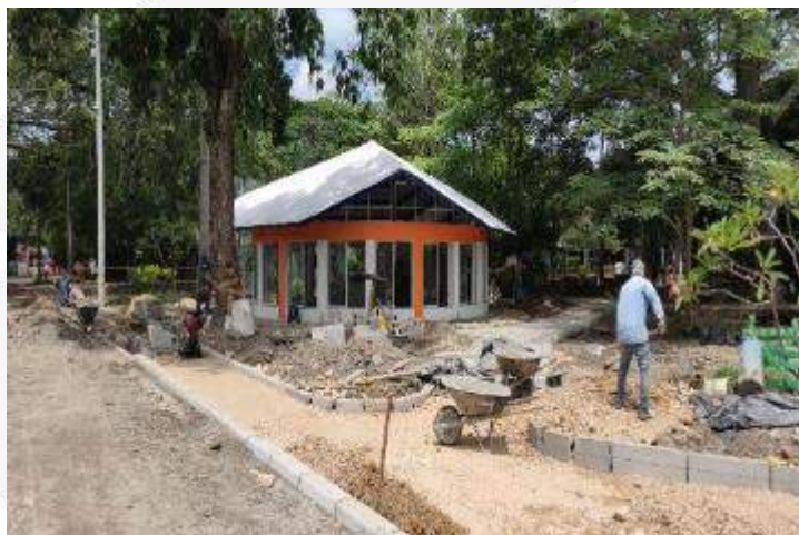
CONFORMACION DE ESTRUCTURA E INSTALACION DE SARDINEL PARA PLACA ANDEN DE ACCESIBILIDAD
