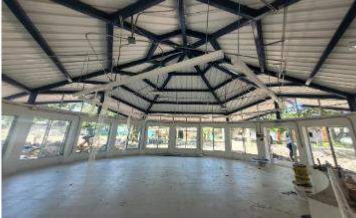
INSTALACION DE LUMINARIAS Y ACABADO DE PISOS
