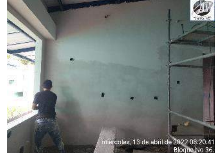
ESTUCO Y PINTURA SOBRE MUROS INTERNOS
