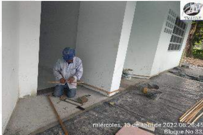
CONSTRUCION DE ANDEN PERIMETRAL
