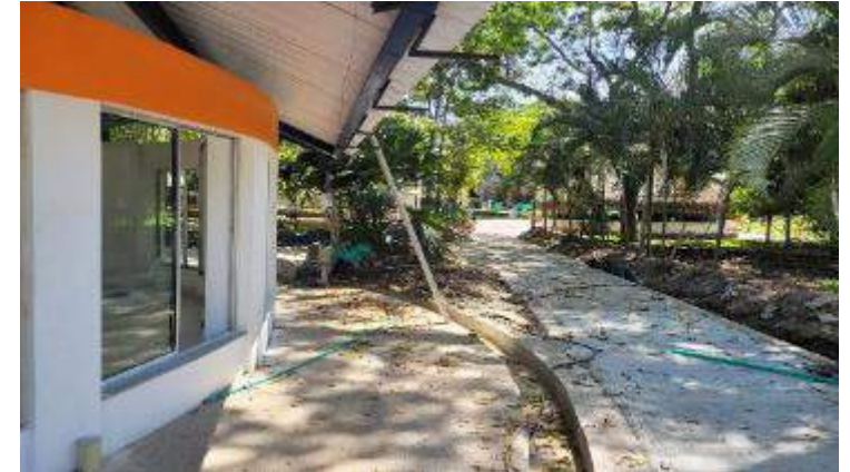
PINTURA INSTITUCIONAL ACABADO DE FACHADAS
