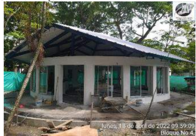
INSTALACION DE VENTANERIA EN ALUMINIO
