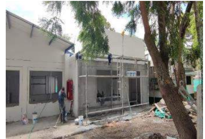
ESTUCO Y PINTURA FACHADA PRINCIPAL
