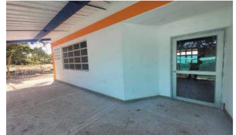
INSTALACION DE VENTANERIA Y PUERTAS EN ALUMINIO
