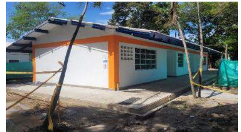
PINTURA DE ACABADO FACHADAS INSTITUCIONAL
