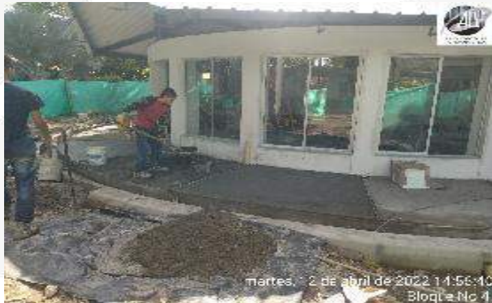
CONSTRUCCION DE ANDEN PERIMETRAL
