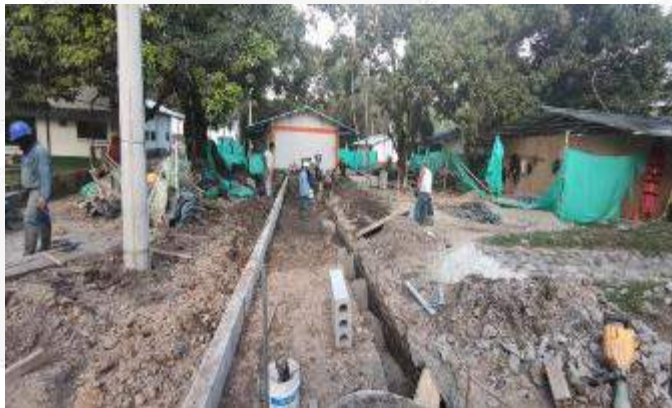
INSTALACION DE BORDILLO PREFABRICADO PARA CONFINAR EL ANDEN DE ACCESIBILIDAD
