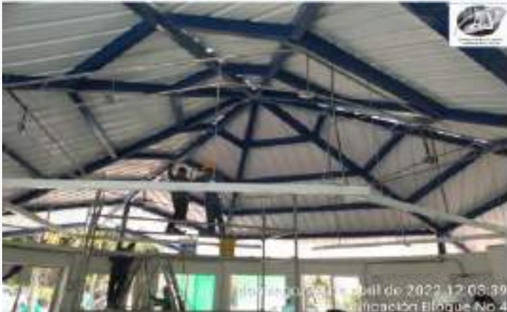
INSTALACION DE LUMINARIAS
