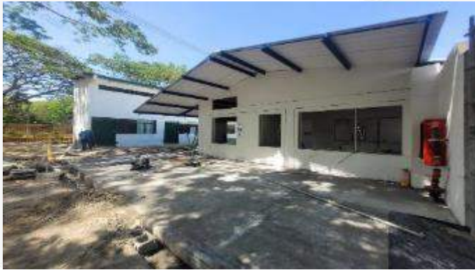
CONSTRUCCION DE ANDEN TERRAZA FACHADA PRINCIPAL
