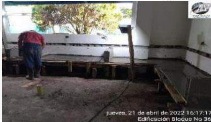
CONSTRUCCION DE MESONES EN CONCRETO
