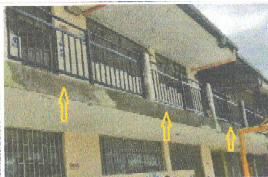
Foto 5. <PLATINA PARA SOPORTE BARANDA INC. ANCLAJES Y ADHESIVO DE ANCLAJE>
