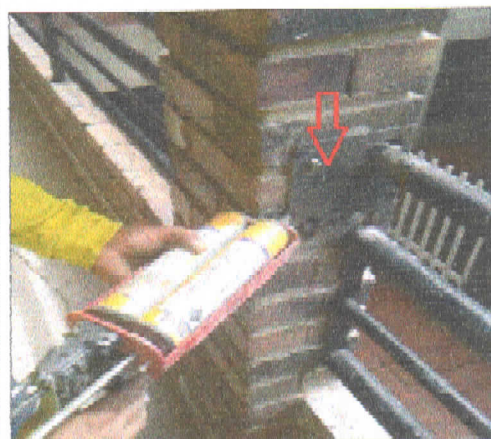
Foto 5. <PLATINA PARA SOPORTE BARANDA INC. ANCLAJES Y ADHESIVO DE ANCLAJE>
