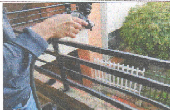
Foto 2. <DEMOLICIÓN ALFAJIA CONCRETO (INCLUYE RETIRO)>
