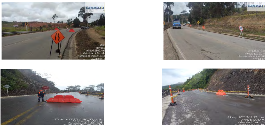
Figura 2. Señalización de frentes de obra.
