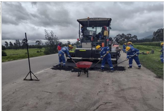
EXTENSION DE MEZCLA PARA PARCHEO VARIANTE DE ZIPAQUIRA
