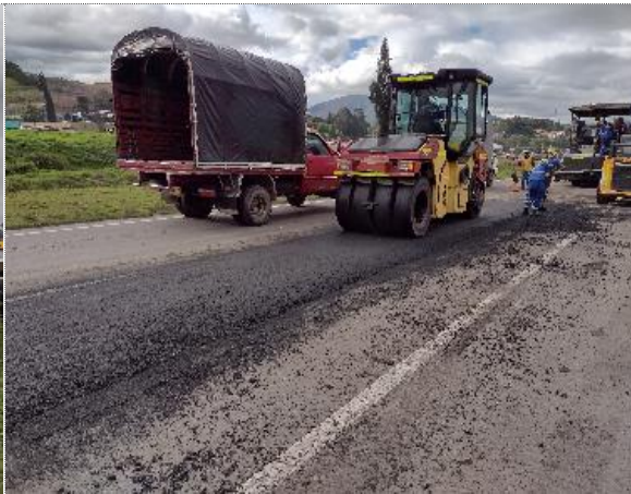
COMPACTACIÓN DE MEZCLA PARA PARCHEO EN EL PR 6+375 DE LA VARIANTE DE ZIPAQUIRA
