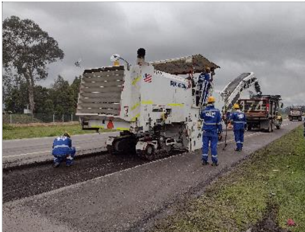
FRESADO DE PAVIMENTO PR 1+290 VARIANTE DE ZIPAQUIRA
