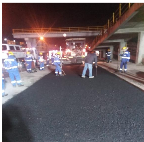
EXTENSION Y COMPACTACION DE MEZCLA MDC -25 EN EL CRUCE DE LA CALLE 8 CON CARRERA 36 RUTA 45ACND
