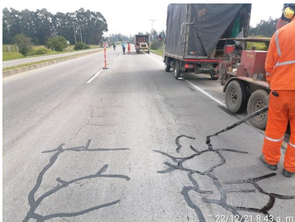
SELLO DE GRIETAS PR 38+500 CALZADA DERECHA ZIQUAIRA - UBATE RUTA 45A04
