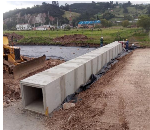
INSTALACION Y EMBOQUILLADO DE BOX CULVERT PREFABRICADO k 6+250 VARIANTE ZIQUAIRA RUTA 45ACND
