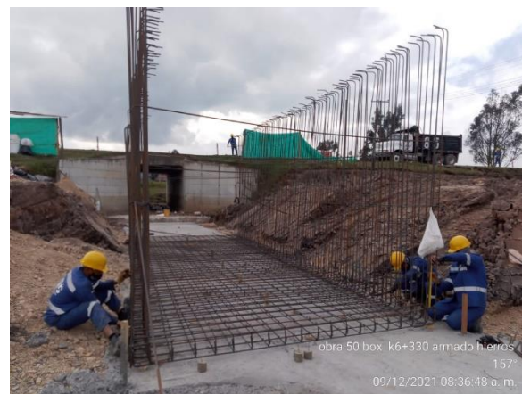
AMARRE DE ACERO BOX CULVERT K 6+330. VARIANTE DE ZIQUAIRA RUTA 45ACND
