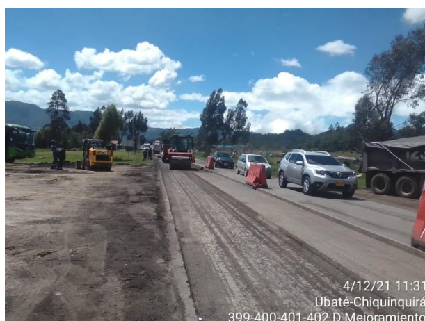
COMPACTACIÓN DE TERRENO PARA MEJORAMIENTO. UBATE - CHIQUINQUIRA
