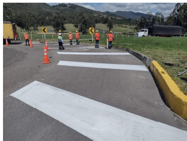
DEMACACION HORIZONTAL RETORNO PR 39+500 / ZIQUAIRA- PEAJE DE CASABLANCA RUTA 45A04
