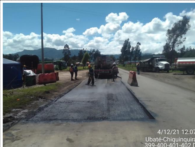
RIEGO DE LIGA ENTRE CAPAS ASFÁLTICAS UBATE - CHIQUINQUIRA
