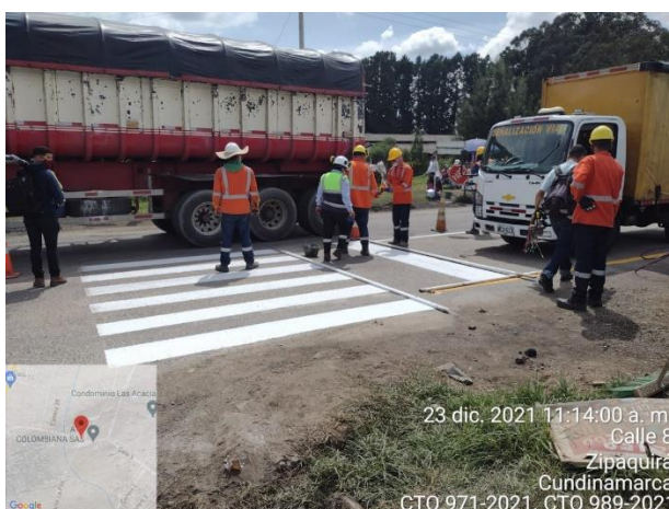
MARCA VIAL DE CRUCE PEATONAL INTERSECCION AVE COLOMBIANA
