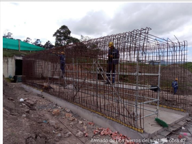
Armado de Los fierros del vantage obra 42
