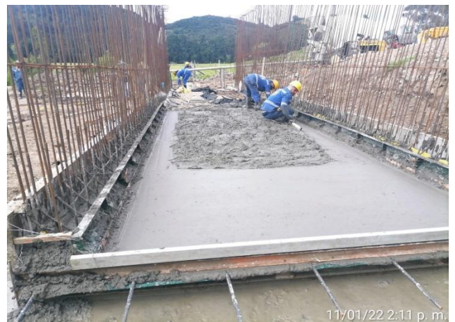
FRESADO Y LIMPIEZA DE PAVIMENTO PR 34+500 UBATE - CHIQUINQUIRA RUTA 45A050
