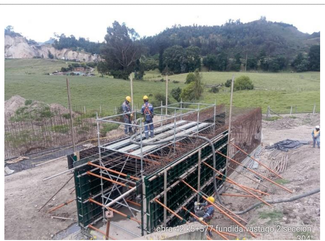
FUNDIDA DE VASTAGOS BOX CULVERT 3X3 K5+595 VARIANTE DE ZIQUAIRA
