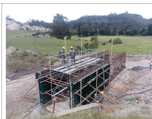
Construccion de prolongacion de obra No 42 box culvert 3x3 K 5+595 (21/01/22)
