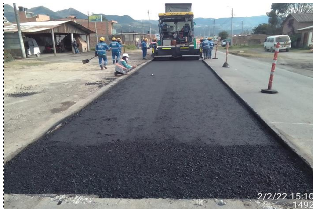
EXTENSION DE MEZCLA ASFALTICA MDC -25 PRIMERA CAPA UABTE - CHIQUINQUIRA RUTA 45A05.
