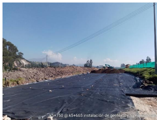
Intalacion de geotextil T 2400 para separacion de pedraplen y terraplen K 5+665 – K 5+750 (Febrero 2022)
