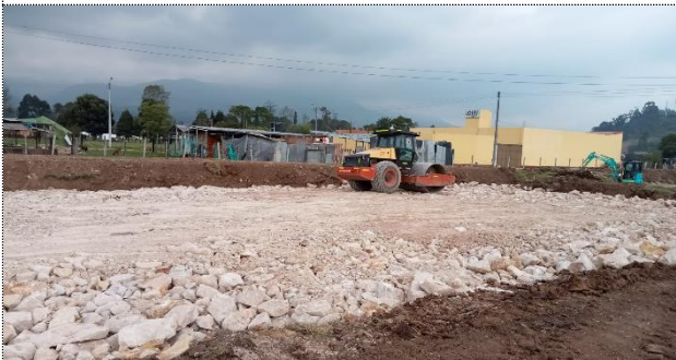
COMPACTACIÓN DE PEDRAPLÉN K 4+360 - K 4+475 - VARIANTE DE ZIQAQUIRÁ
