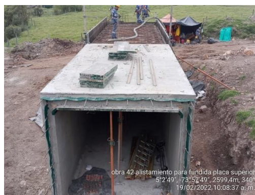
Construccion de prolongacion de obra No 42 box culvert 3x3 K 5+595 (25/01/22)
