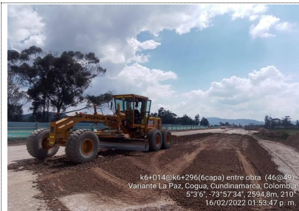
EXTENSION DE CAPA NO 6 DE TERRAPLEN ENTRE EL K 6+014 -K 6+296 - VARIANTE DE ZIQAQUIRA
