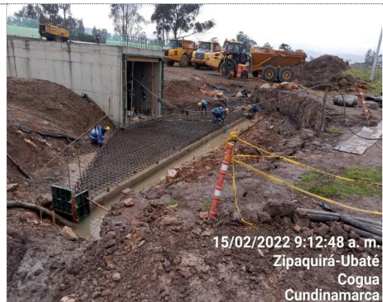
AMARRE DE ACERO DE LA LOSA ENTRE ALETAS DEL BOX CULVERT 3X3 OBRA NO 50 - VARIANTE DE ZIQAQUIRA
