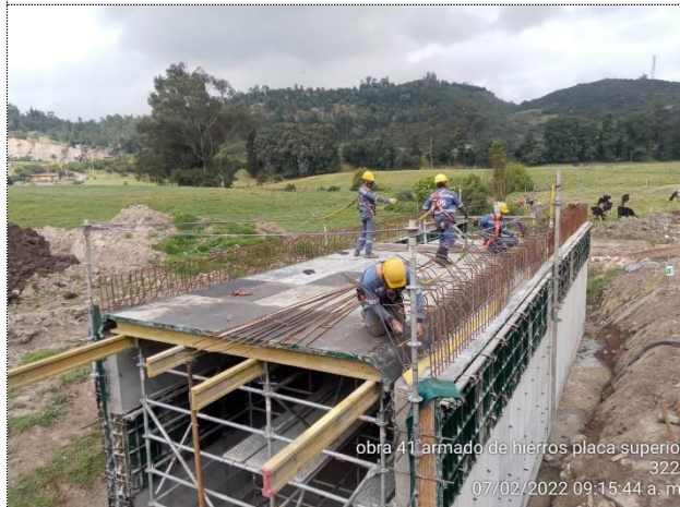
AMARRE DE ACERO PLACA SUPERIOR BOX K 5+577 VARIANTE DE ZIQAUIRÁ
