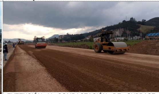
EXTENSIÓN Y COMPACTACIÓN DE SUBBASE GRANULAR ENTRE EL K 6+030 - K 6+297 - VARIANTE DE ZIQAQUIRÁ
