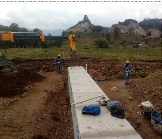
IAJE E INSTALACION DE PREFABRICADOS BOX CULVERT K 5+096
