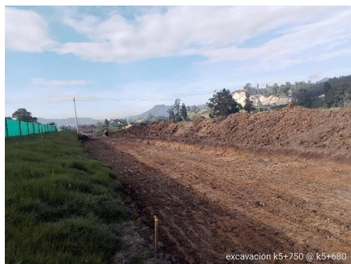
Excavacion y construccion de pedraplen K 5+665 – K 5+750 (enero 2022)
