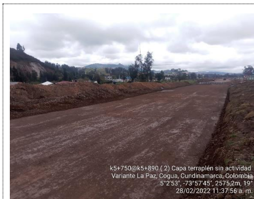
Extension y compactacion de capa No. 2 de terraplen K 5+750 – K 5+890 (28/02/2022)
