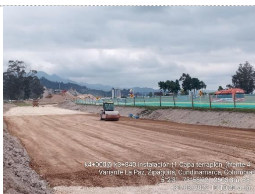
Compactacion de capa No 1 de terraplen K 3+850 – K 4+000. (26/03/2022)
