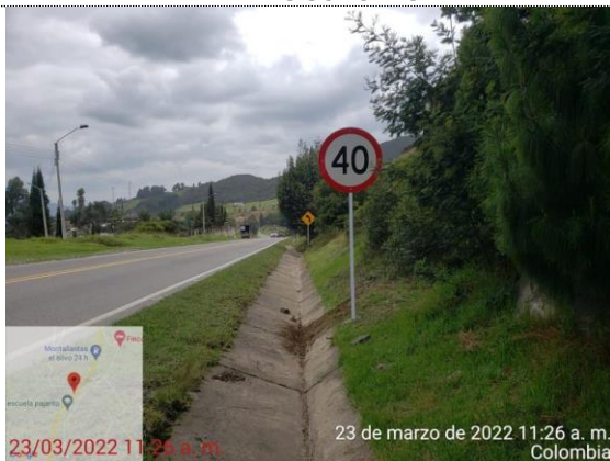
PR43+0900 - PR44+0800 RUTA 45A04 INSTALACIÓN DE SEÑALES VERTICALES
