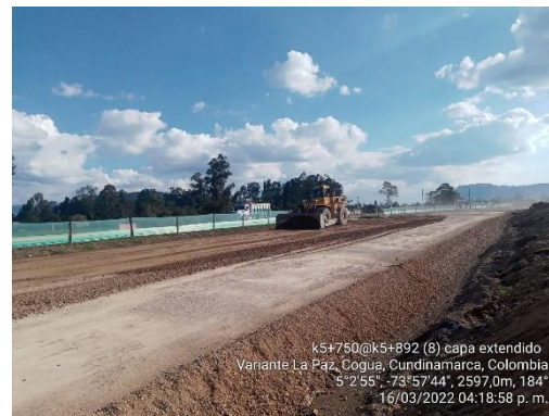
Extension y compactacion de capa No. 8 de terraplen K 5+750 – K 5+890 (16/03/2022)
