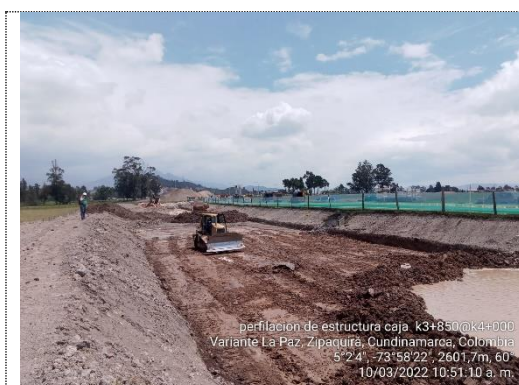
Excavacion de la explanacion K 3+850 – K4+000. (10/03/2022)
