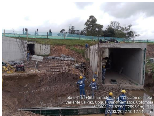
Amarre de acero de la losa entre aletas en el Box culvert 4x4 K 5+577 (02/03/2022)
