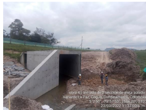
Excavacion para segunda mitad de la losa del Box culvert 4x4 K 5+577 (07/03/2022)
