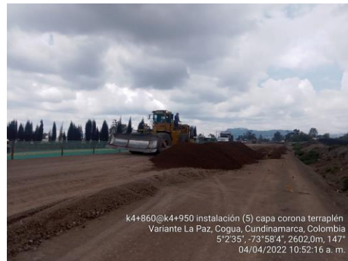
Instalación y compactación de 5 a . capa de terraplén, corona K 4+860 – K 4+950 (04/04/22)
