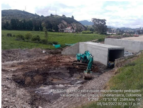
Excavación en área destinada para geobloques K 5+530 – K 5+570 (08/04/22)
