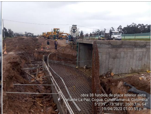
FUNDIDA DE LOSA ENTRE ALETAS OBRA NO 38 BOX CULVERT 3X3 K 5+154
