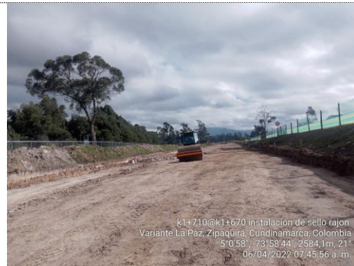
Instalación y compactación de sello rajón K 1+670 – K 1+710 (06/04/22)
