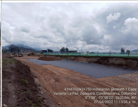
INSTALACIÓN DE GEOTEXTIL Y PRIMER CAPA DE TERRAPLÉN K 3+670 - K 3+750
