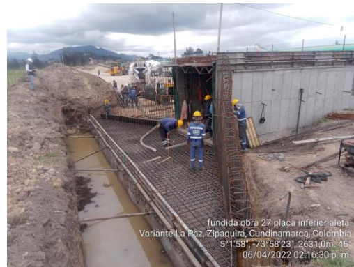
Fundida de placa inferior encole Obra No. 27 Box Culvert 3X3 K 3+641. (06/04/22)
