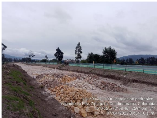
Instalación de pedraplén K 1+590 – K 1+990 (07/04/22)
