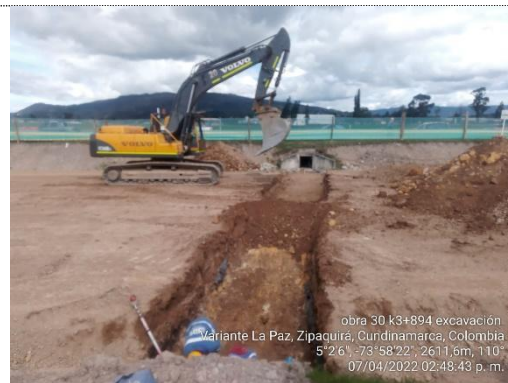
Excavación para Obra No. 30 Box Culvert 1X1 K 3+892. (07/04/22)
