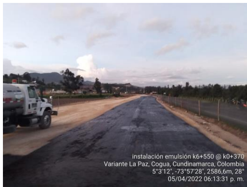
Riego de imprimación con emulsión asfáltica K 6+550 – K0+370 Intersección Noventa Grados (05/04/22)
