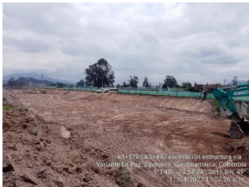
Excavación para estructura de vía K 3+370 – K 3+490 (11/04/22)
