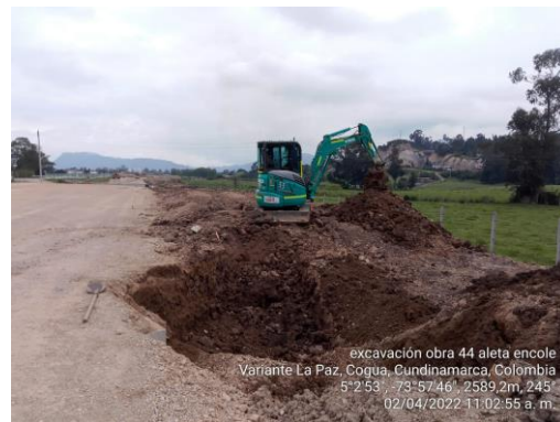
Excavación encole Obra No. 44 Box Culvert 1X1 K 5+751 (02/04/22)
