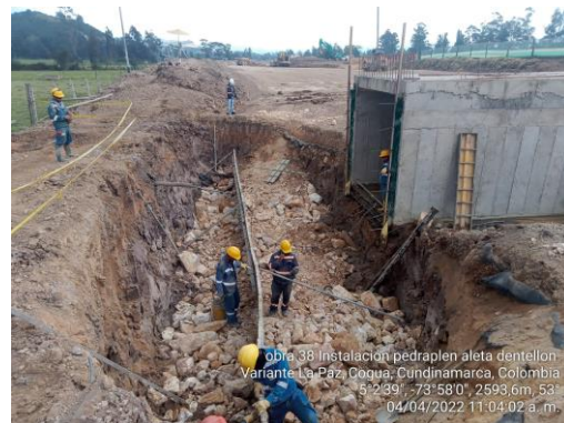
Instalación pedraplén encoche Obra No. 38 Box Culvert 3x3 K 5+194 (04/04/22)
