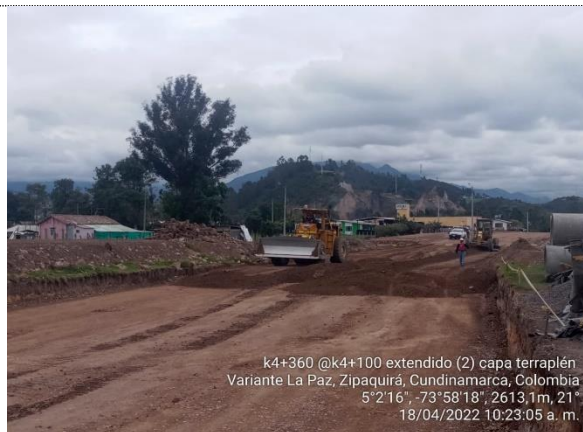
EXTENSIÓN DE MATERIAL DE TERRAPLÉN K 4+360 - K 4+100 - VARIANTE DE ZIPAQUIRÁ
