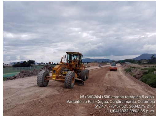
Instalación y compactación de 5ª. capa de terraplén K 5+360 – K 5+500 (11/04/22)
