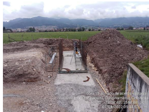
Armado de acero muros módulo 2 Obra No. 15 Box Culvert 3X3 K 2+138 (07/04/22)
