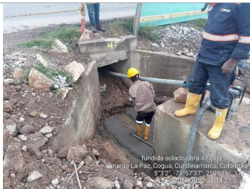
Fundida de solado Obra No. 47 Box Culvert 1X1 K 6+120 (18/04/22)
