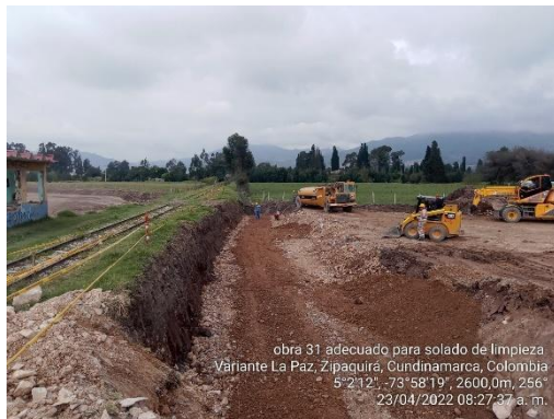
Instalación de material adecuado Obra No. 31 Box Culvert 1X1 K 4+075 (23/04/22)
