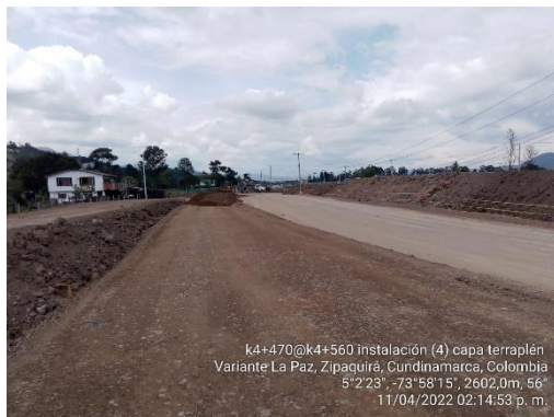
Instalación y compactación de 4 a . capa de terraplén K 4+470 – K 4+560 (11/04/22)
