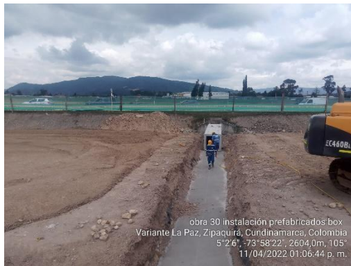
Instalación de módulos prefabricados de Obra No. 30 Box Culvert 1X1 K 3+892 (11/04/22)
