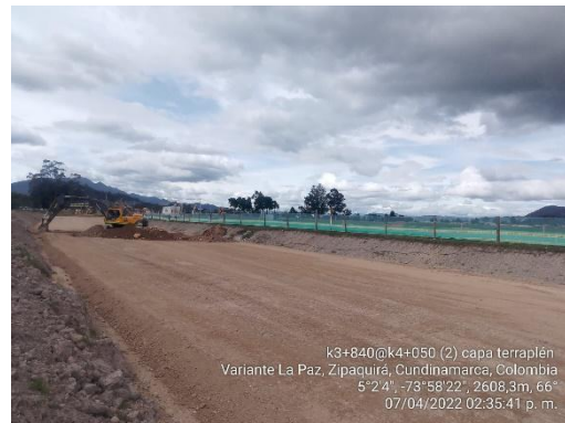
Extensión y compactación 2ª. capa de terraplén K 3+840 – K4+050 (07/04/22)
