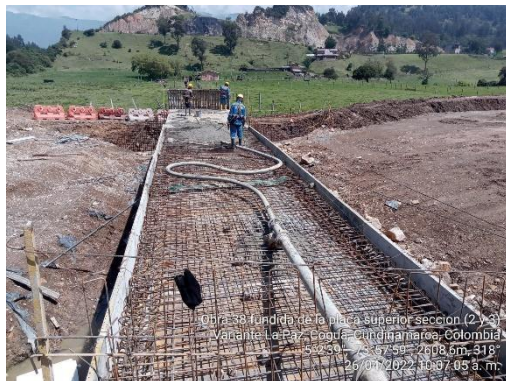
Fundida de placa superior módulos 2 y 3 Obra No. 38 Box Culvert 3x3 K 5+194 (26/04/22)
