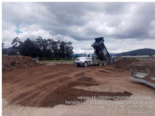
Instalación y compactación 2ª. capa de terraplén en el retorno K 5+300 (08/04/22)
