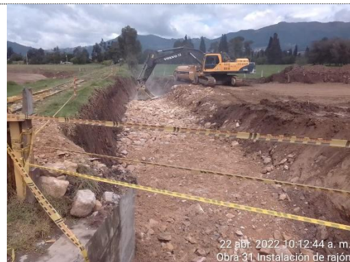
Instalación de pedraplén Obra No. 31 Box Culvert 1X1 K 4+075 (22/04/22)
