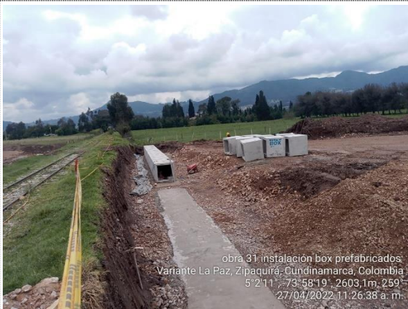
INSTALACIÓN DE MÓDULOS PREFABRICADOS DE BOX CULVERT OBRA NO. 31 K 4+075
