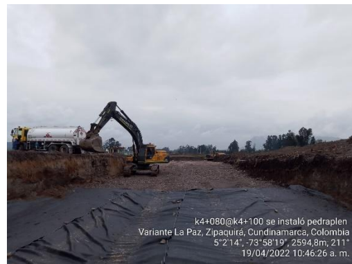
Instalación de pedraplén K 4+080 – K 4+100 (19/04/22)
