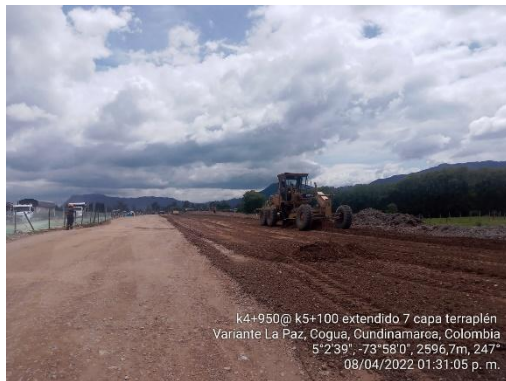
Extensión y compactación de 7 a . capa de terraplén K 4+950 – K 5+100 (08/04/22)
