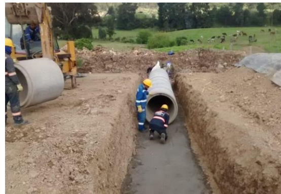
Instalación de tubería Obra No. 43 Alcantarilla D=0.90 K 5+637 (23/04/22)
