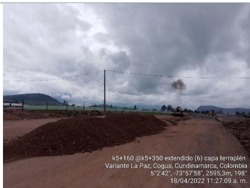
Instalación y compactación 6ª. capa de terraplén K 5+160 – K 5+350 (18/04/22)
