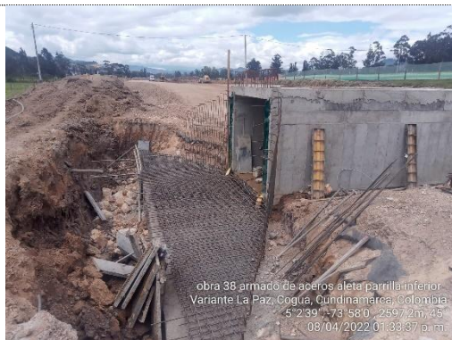
Armado de acero losa inferior encole Obra No. 38 Box Culvert 3x3 K 5+194 (08/04/22)
