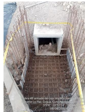
Armado de acero de caja Obra No. 48 Box Culvert 1X1 K 6+240 (08/04/22)
