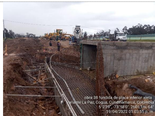
Fundida de losa inferior encole Obra No. 38 Box Culvert 3x3 K 5+194 (19/04/22)
