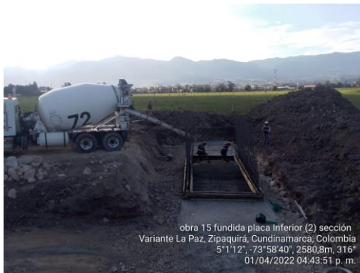
Fundida placa inferior módulo 2 Obra No. 15 Box Culvert 3X3 K 2+138 (01/04/22)
