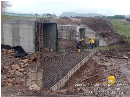
Fundida placa inferior encole Obra No. 42 Box Culvert 3x3 K 5+595 (25/04/22)
