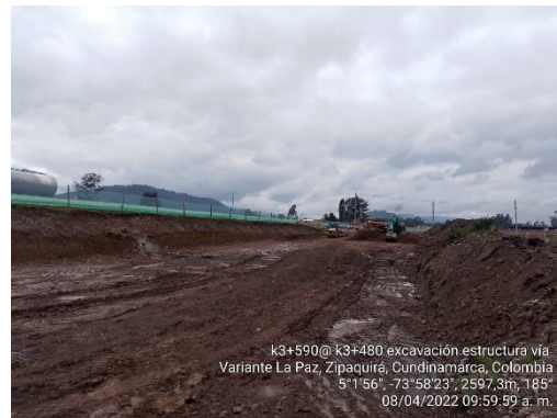
Excavación para estructura de la vía K 3+590 – K 3+480 (08/04/22)
