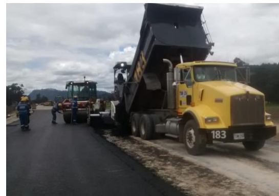
Instalación y compactación de Base Tratada con Asfalto BTA K 6+550 – K0+370 Intersección Noventa Grados (05/04/22)
