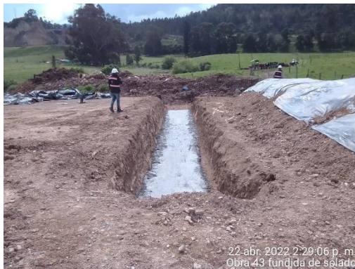
Fundida de solado Obra No. 43 Alcantarilla D=0.90 K 5+637 (22/04/22)
