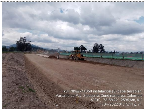
Extensión y compactación 3ª. capa de terraplén K 3+789 – K4+050 (11/04/22)
