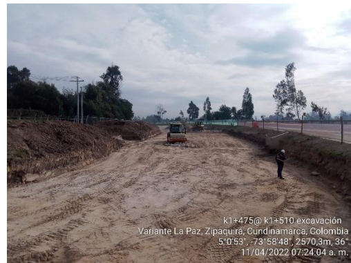
Excavación para estructura de la vía K 1+475 – K 1+510 (11/04/22)
