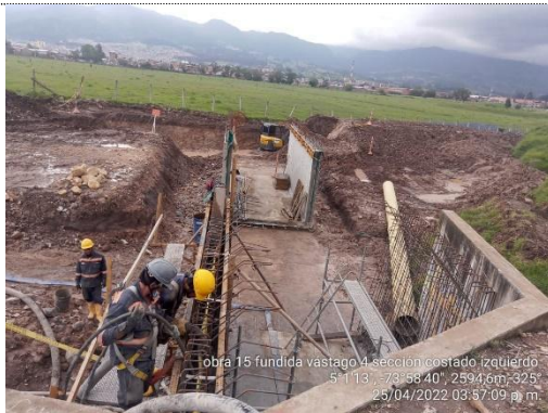
Fundida de vástago derecho módulo 4 Obra No. 15 Box Culvert 3X3 K 2+138 (25/04/22)
