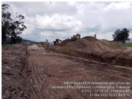
Excavación para estructura de la vía K 4+070 – K 4+100 (11/04/22)
