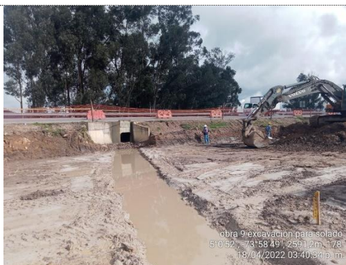
Excavación para Obra No 9. Box Culvert 1X1 K 1+420 (18/04/22)
