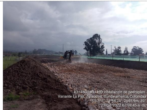
Instalación de pedraplén K 3+450 – K 3+490 (23/04/22)
