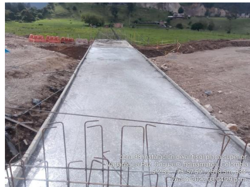
Instalación de antisol módulos 2 y 3 Obra No. 38 Box Culvert 3x3 K 5+194 (26/04/22)
