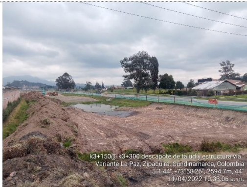
Descapote de talud y estructura de vía K 3+150 – K 3+300 (11/04/22)
