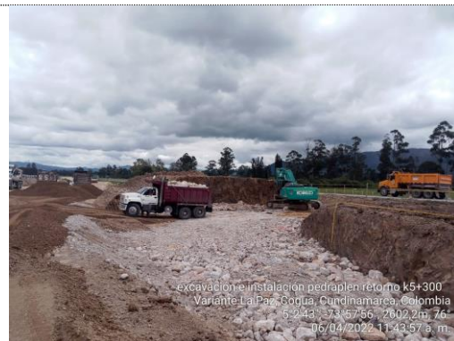
Instalación de pedraplén en el retorno K 5+300 (06/04/22)
