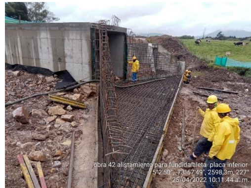
Amarre de acero losa y aletas encofe Obra No. 42 Box Culvert 3x3 K 5+595 (25/04/22)
