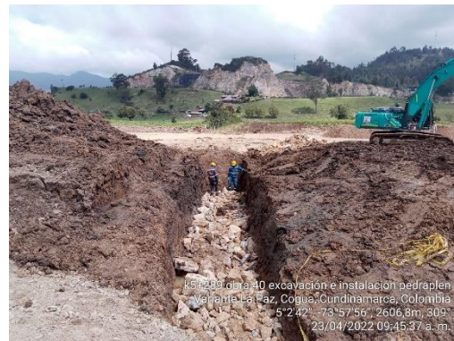
Instalación de pedraplén Obra No. 40 Alcantarilla D=0.90m K 5+289 (23/04/22)
