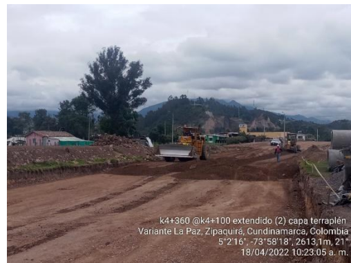
Instalación y compactación 2 a . capa de terraplén K 4+100 – K 4+360 (18/04/22)
