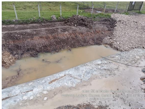
Colocación de enrocado en encole de Obra No. 50 Pasa ganado 3X3 K 6+330 (23/04/22)
