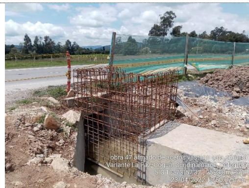
Armado de acero caja Obra No. 47 Box Culvert 1X1 K 6+120 (18/04/22)
