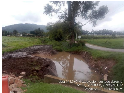
Excavación Obra No. 14 Box Culvert 2X2 K 2+014 (25/04/22)
