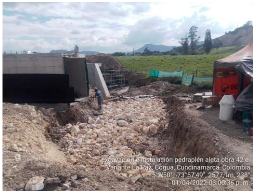
Instalación de pedraplén Obra No. 42 Box Culvert 3x3 K 5+595 (01/04/22)
