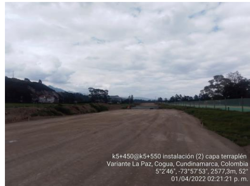
Instalación y compactación de 2ª. capa de terraplén K 5+450 – K 5+550 (01/04/22)
