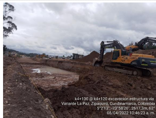
Excavación para estructura de la vía K 4+100 – K 4+120 (08/04/22)
