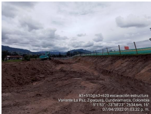
Excavación para la estructura de la vía K 3+510 – K 3+620. (07/04/22)
