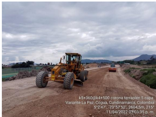
Instalación y compactación 5ª. capa de terraplén K 5+360 – K 5+500 (11/04/22)
