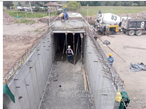
Fundida de placa superior módulo 2 Obra No. 27 Box Culvert 3X3 K 3+641. (12/04/22)
