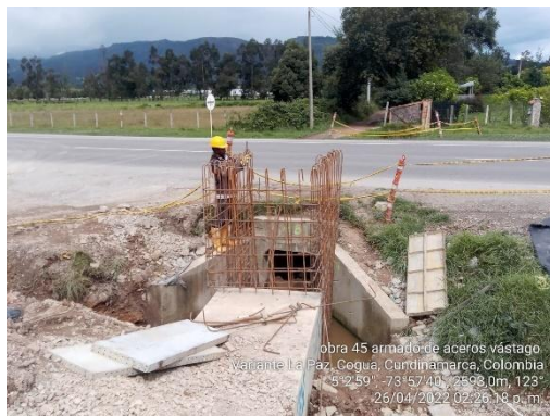
Armado de acero de caja Obra No. 45 K 5+894 (26/04/22)
