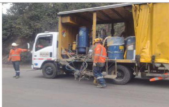
PR53+0000 – PR55+0000 Ruta 45A04 demarcación horizontal líneas de eje
