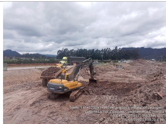
Excavación e instalación de pedraplén K1+120 – K1+140 (16/05/22)
