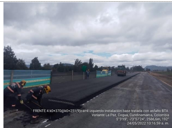
Instalación de Base Tratada con Asfalto BTA K0+370 – K0+260 Intersección Noventa Grados (24/05/22)
