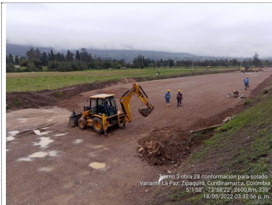
Obra No 28 Box culvert 1X1 K3+675 conformación para solado de limpieza (18/05/22)
