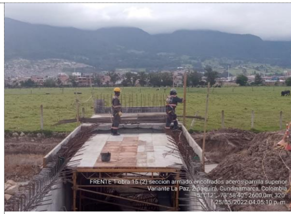
OBRA No 15 ARMADO DE ACERO Y ENCOFRADO PLACA SUPERIOR MÓDULO 2
