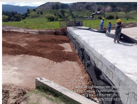
Obra No. 38 Box Culvert 3x3 K 5+194 conformación de geodren planar (03/05/22)
