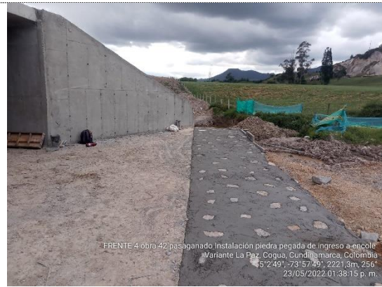
Obra No. 42 Pasa ganado 3x3 K 5+595 instalación de piedra pegada en encofe (23/05/22)
