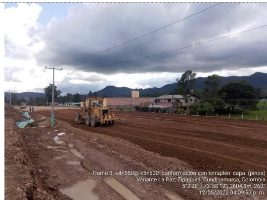
Instalación y compactación de terraplén K 4+550 – K 4+600 (12/05/22)
