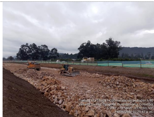
Instalación de pedraplén K1+170 – K1+200 (14/05/22)
