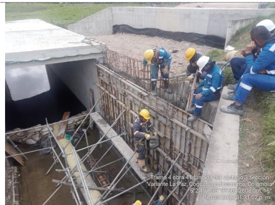
Obra No. 41 Box culvert 4X4 K 5+557 fundida de vástago módulo 3 (16/05/22)
