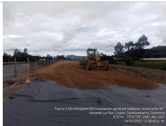
Instalación de geotextil y subbase granular K0+360 – K0+300 Intersección Noventa Grados (14/05/22)
