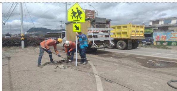
Instalación de señal vertical en sector del Colegio Colombo Británico (24/05/22)
