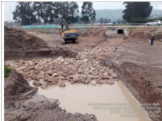
Obra No 8 Box culvert 2X2 K1+299 instalación de pedraplén (06/05/22)
