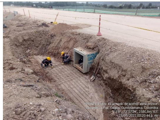
Obra No. 49 Box Culvert 1X1 K 6+295 armado de acero en encoque (23/05/22)
