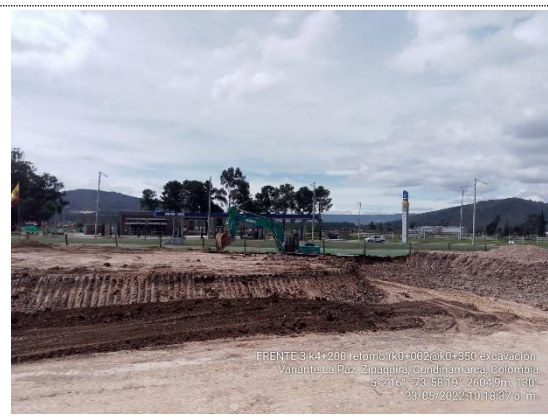
Excavación para retorno K 4+200 (23/05/22)
