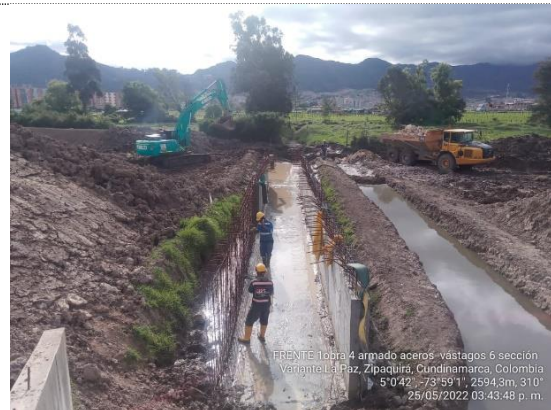
Obra No 4 Box culvert 2X2 K+0956 armado de acero vástago módulo 6 (25/05/22)
