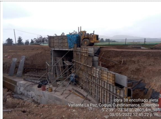
Obra No. 38 Box Culvert 3x3 K 5+194 encofrado de aleta de encole (05/05/22)
