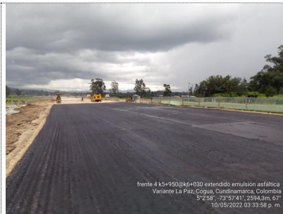
Instalación de emulsión asfáltica K5+950 – K6+080 (10/05/22)
