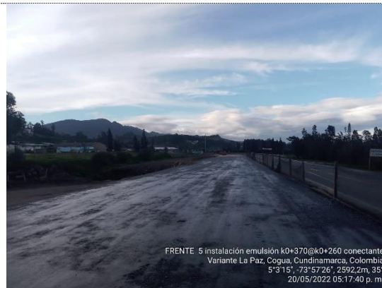
Riego de imprimación con emulsión asfáltica K0+370 – K0+260 Intersección Noventa Grados (20/05/22)
