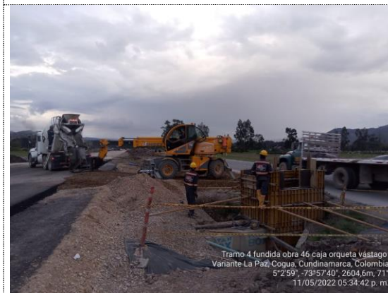
Obra No. 46 Box Culvert 1X1 K 6+020 fundida de muros caja arqueta (11/05/22)
