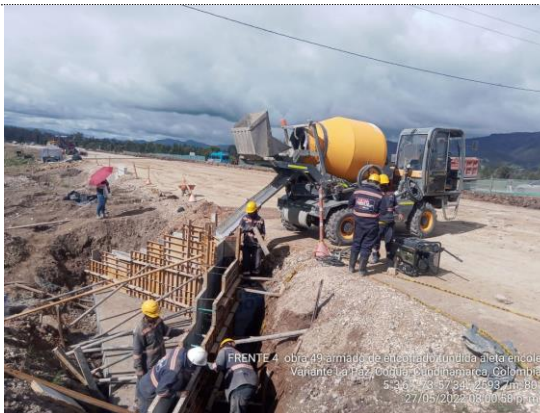
Obra No. 49 Box Culvert 1X1 K 6+295 fundida de aletas de encoque (27/05/22)
