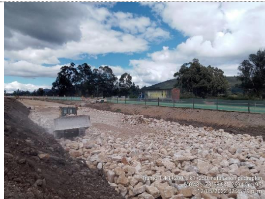
Instalación de pedraplén K1+200 – K1+250 (12/05/22)
