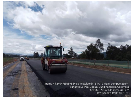
Compactación de base tratada con asfalto K5+834 – K5+964 (12/05/22)
