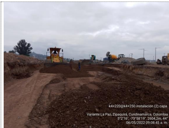
Instalación 2da capa de terraplén K4+220 – K4+250 (06/05/22)
