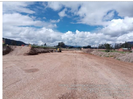
Instalación 2da capa de terraplén K3+500 – K3+610. (21/05/22)
