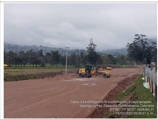
Instalación 5ta capa de terraplen K3+670 – K3+900 (18/05/22)
