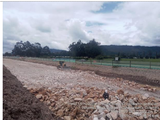
Excavación e instalación de pedraplén K1+120 – K1+140 (16/05/22)
