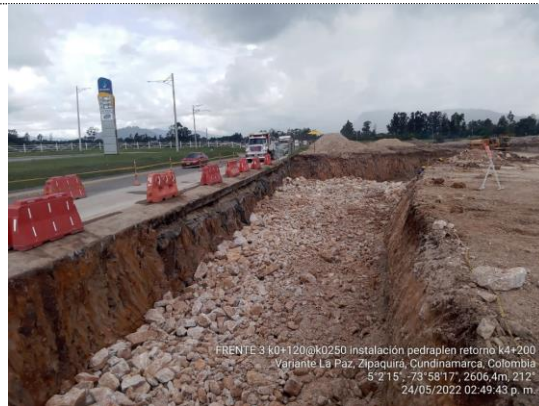
Instalación de pedraplén en retorno K4+200 (24/05/22)
