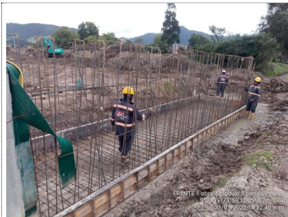
Obra No 4 Box culvert 2X2 K+0956 armado de acero placa inferior módulo 4 (31/05/22)
