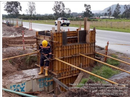
Obra No. 46 Box Culvert 1X1 K 6+020 encofrado de muros caja arqueta (09/05/22)
