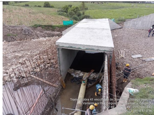
Obra No. 41 Box culvert 4X4 K 5+557 encofrado de vástago módulo 3 (14/05/22)
