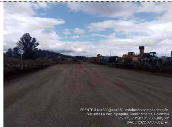
Instalación y compactación capa corona de terraplén K 4+300 – K 4+350 (18/04/22)
