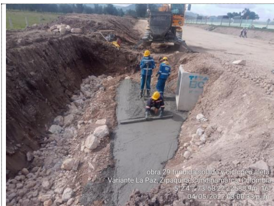
Obra No 29 Box culvert 1X1 K3+829 fundida de solado y enrocado en encole (04/05/22)
