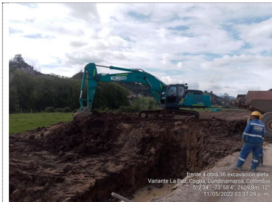
Obra No 36 Box culvert 1X1 K4+951 excavación para aletas de encole (11/05/22)
