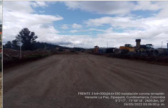
INSTALACIÓN DE CAPA CORONA DE TERRAPLÉN K4+300 - K4+350
