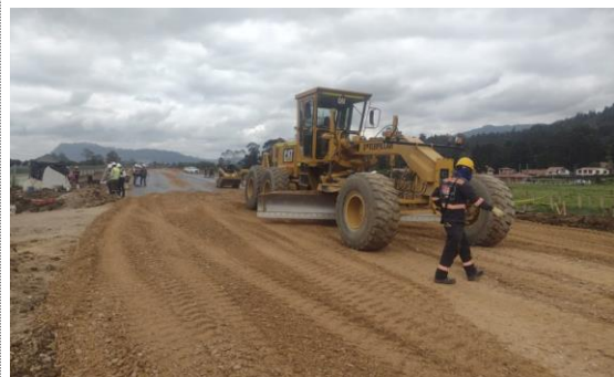
Instalación de subbase granular K5+910 – K6+035 (09/05/22)
