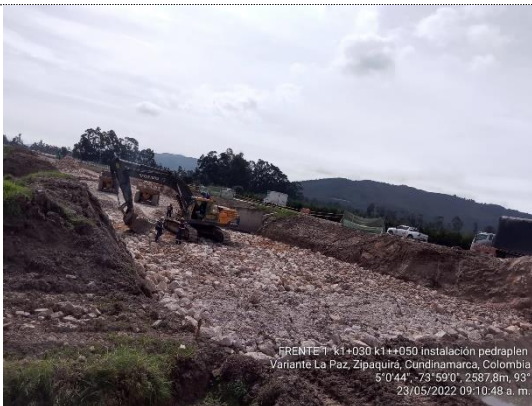
Instalación de pedraplén K1+030 – K1+050 (23/05/22)
