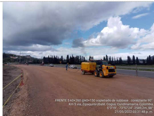
Sopleteado de subbase granular K0+140 – K0+260 conectante 90 grados (21/05/22)
