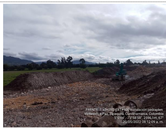
Instalación de pedraplén K1+050 – K1+100 (20/05/22)
