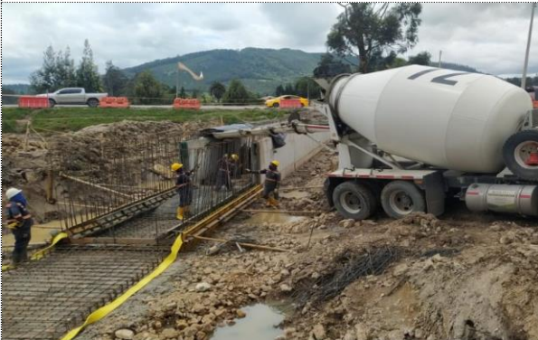
OBRA No 14 FUNDIDA DE PLACA INFERIOR MÓDULO 6
