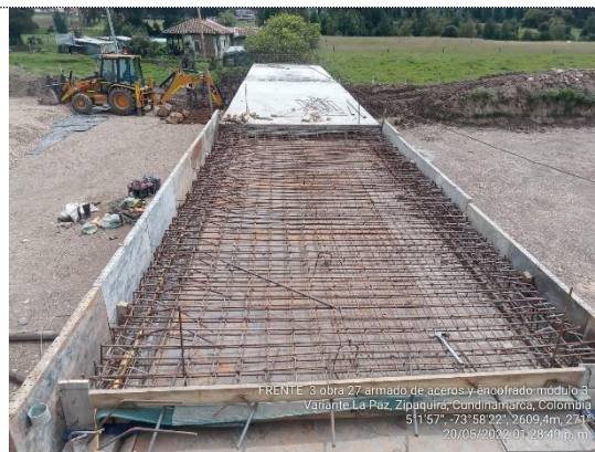
Obra No. 27 Box Culvert 3X3 K 3+641 armado de acero y encofrado placa superior módulo 3. (20/05/22)
