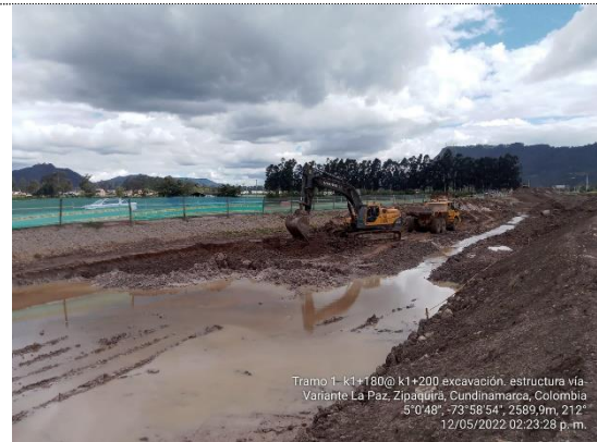
Excavación para estructura de vía K1+180 – K1+200 (12/05/22)
