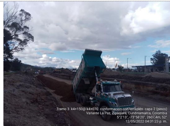
Instalación de 2da capa de terraplén K4+070 – K4+150 (12/05/22)
