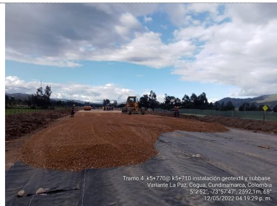
Instalación geotextil y subbase granular K4+710 – K4+770 (12/05/22)
