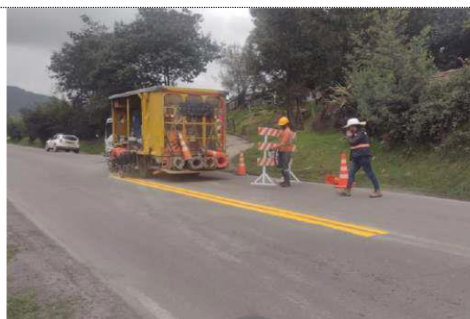
PR53+0000 – PR55+0000 Ruta 45A04 demarcación horizontal líneas de eje
