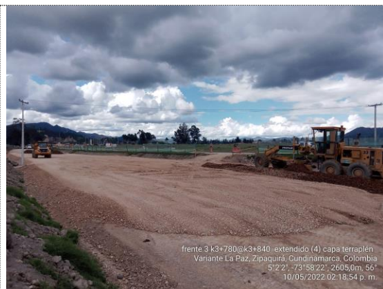
Instalación 4ta capa de terraplen K3+780 – K3+840 (10/05/22)
