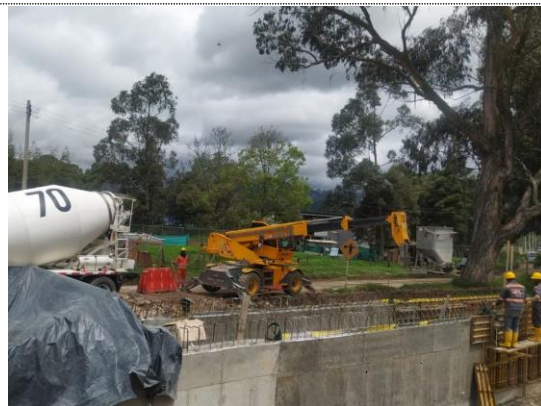
Obra No. 14 Box Culvert 2X2 K 2+014 encofrado y fundida de vástago módulo 7 (27/05/22)
