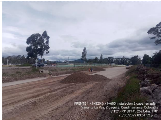
Instalación 2da capa de terraplén K1+600 – K1+820 (25/05/22)
