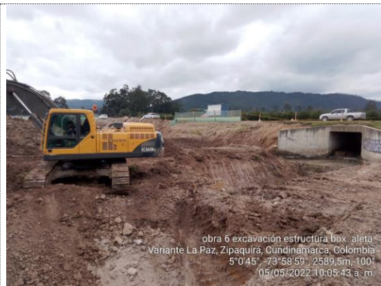
Obra No 6 Pasa ganado 3X3 K1+069 excavación (05/05/22)
