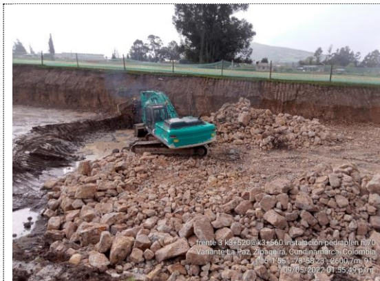
Instalación de pedraplén K3+520 – K3+560 (09/05/22)
