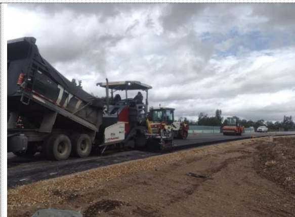
INSTALACIÓN Y COMPACTACIÓN DE BTA K0+275 - K0+160
