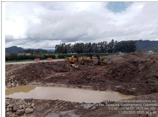
Excavación para estructura de vía K1+100 – K1+120 (17-05-22)
