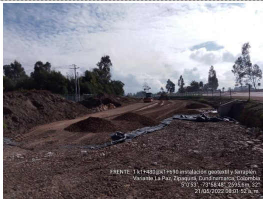
Instalación geotextil y 1er capa de terraplén K1+470 – K1+690 (21/05/22)
