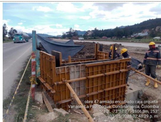
Obra No 47 Box culvert 1X1 K6+120 encofrado de muros de caja arqueta (03/05/22)
