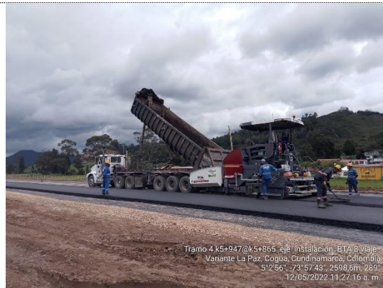
Instalación de base tratada con asfalto K5+834 – K5+964 (12/05/22)
