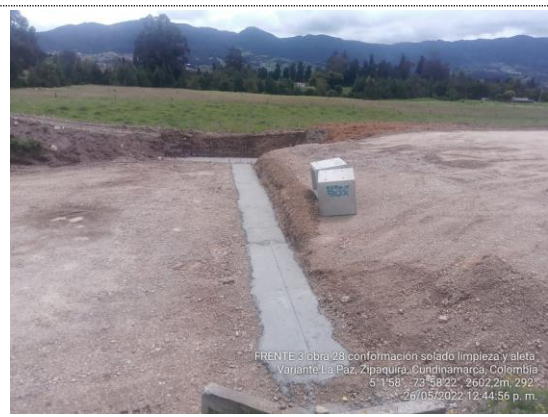
Obra No 28 Box culvert 1X1 K3+675 fundida de solado de limpieza (26/05/22)
