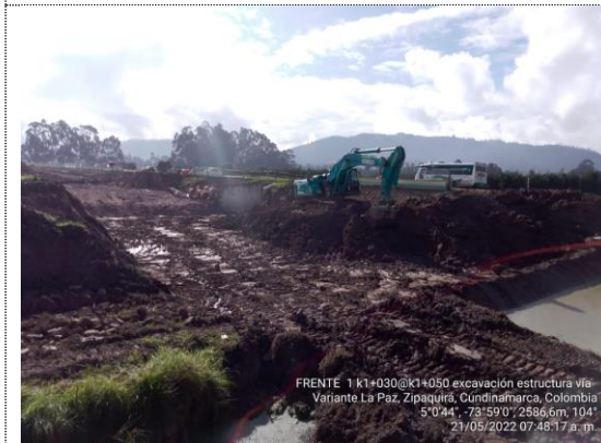
Excavación para estructura de vía K1+030 – K1+050 (21/05/22)
