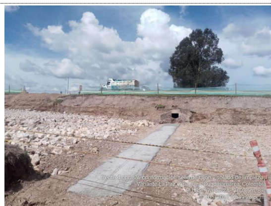
Obra No 26 Box culvert 1X1 K3+568 fundida de solado (11/05/22)
