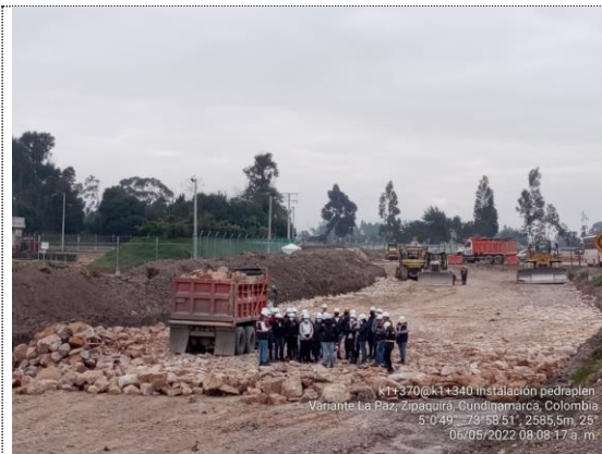
Instalación de pedraplén K1+340 – K1+370 (06/05/22)
