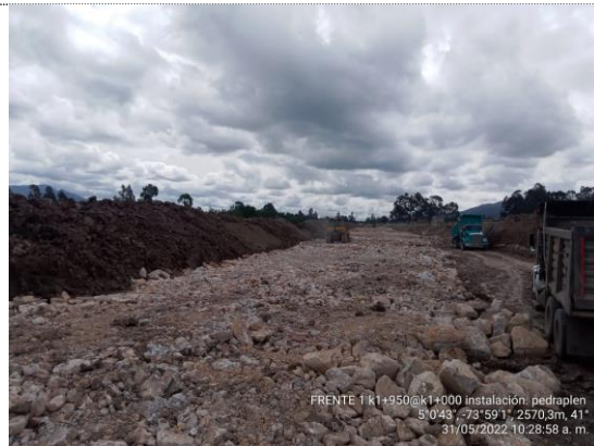
Instalación de pedraplén K1+000 – K1+050 (31/05/22)
