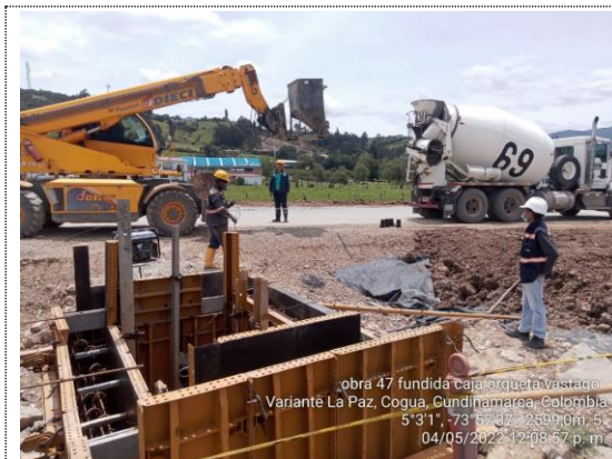
Obra No. 47 Box culvert 1X1 K6+120 fundida de muros de caja arqueta (04/05/22)
