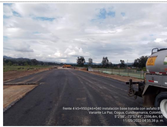
Instalación de base tratada con asfalto K5+980 – K6+040 (11-05-22)
