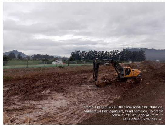
Excavación para estructura de vía K1+160 – K1+180 (14/05/22)
