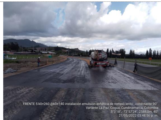
Instalación de emulsión asfáltica K0+140 – K0+260 conectante 90 grados (21/05/22)
