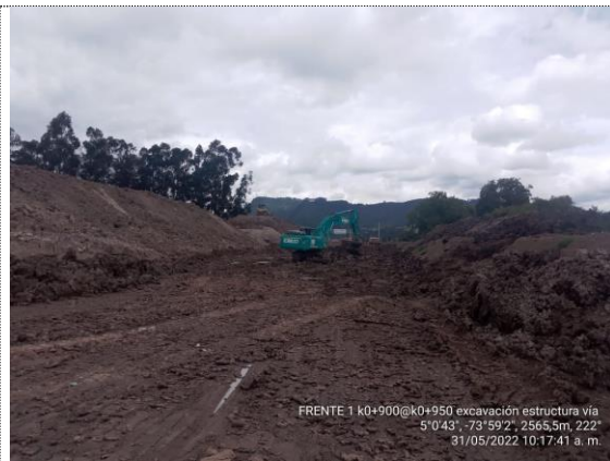
Excavación para estructura de vía K0+900 – K0+950 (31/05/22)
