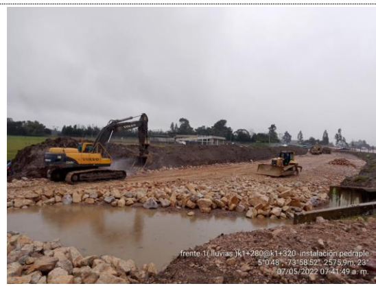
Instalación de pedraplén K1+280 – K1+320 (07/05/22)
