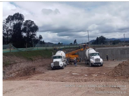
Obra No. 27 Box Culvert 3X3 K 3+641 fundida de placa superior módulo 3. (20/05/22)
