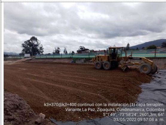
Instalación 2da capa de terraplen K3+700 – K3+740 (03/05/22)
