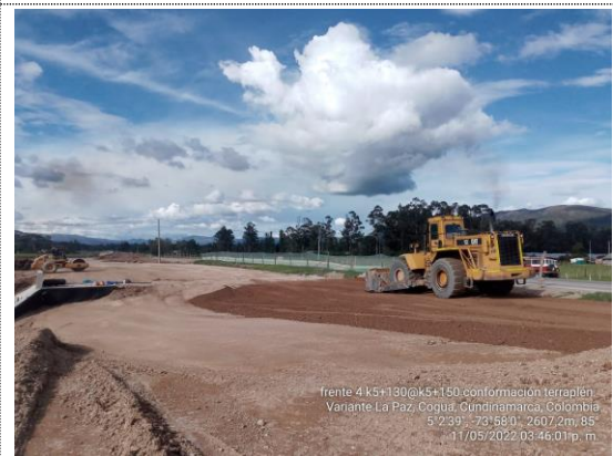
Conformación de terraplén K5+130 – K5+150 (11/05/22)
