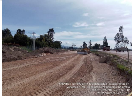
Instalación 1er capa de terraplén K1+470 – K1+690 (23/05/22)
