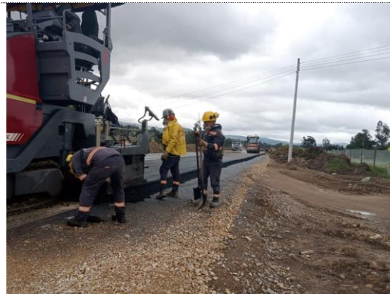
K5+640 – k5+690 instalación y compactación de BTA (11/07/22)
