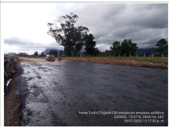
K4+130 – K4+270 instalación de emulsión asfáltica (18/07/22)
