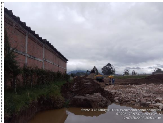
K3+300 – K3+350 excavación para canal de desagües (17/07/22)
