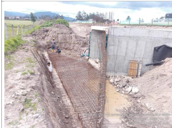
Obra No 15 Pasaganado 3X3 K2+138 Armado de acero placa inferior encole (06/07/22)
