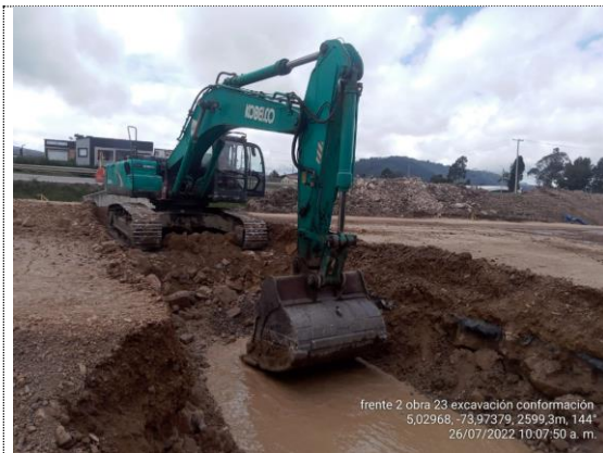
Obra No 23 Box culvert 1x1 K3+280 excavación (26/07/22)
