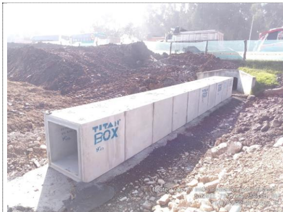
Obra No 17 Box culvert 1x1 K2+618 instalación de módulos prefabricados de box culvert (15/07/22)
