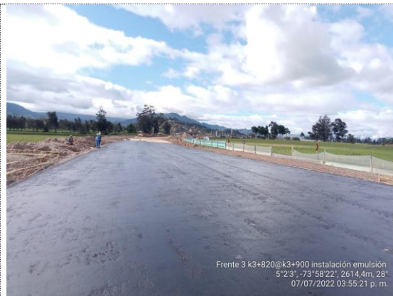
K3+800 – K3+900 instalación de emulsión asfáltica (07/07/22)
