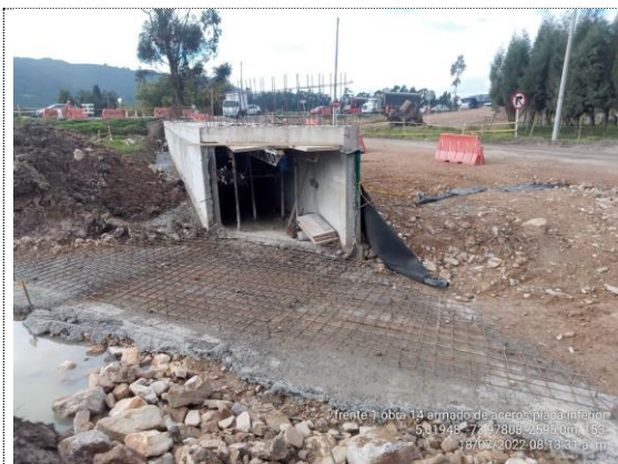
Obra No. 14 Box Culvert 2X2 K 2+014 armado de acero placa inferior encole (18/07/22)
