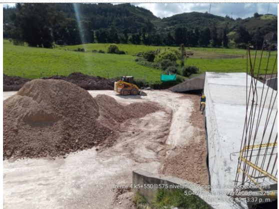
K5+550 – K5+575 instalación 2da capa de terraplén en sector geobloques (15/07/22)
