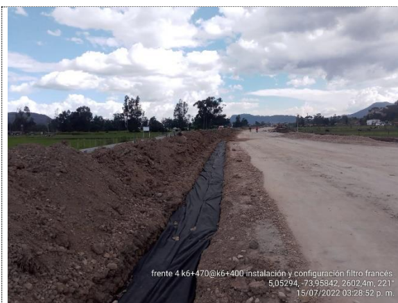
K6+400 - K6+470 INSTALACIÓN DE FILTRO FRANCÉS
