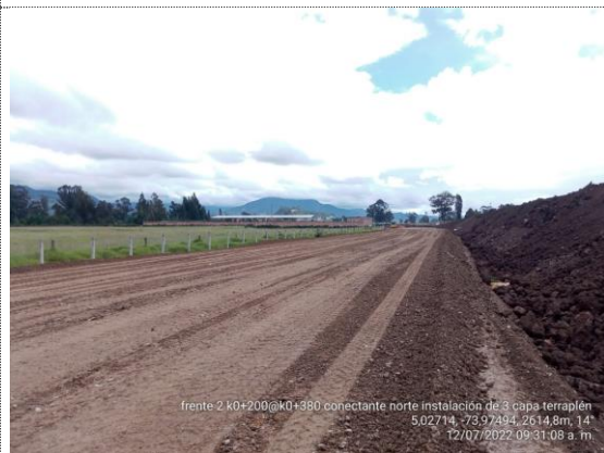
Conectante norte K0+200 – K0+380 instalación 3er capa de terraplén (12/07/22)
