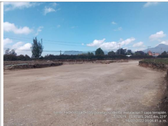
Glorieta K0+135 – K0+185 instalación 1er capa de terraplén (16/07/22)
