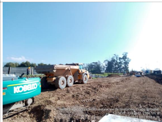
Conectante sur K0+060 – K0+150 instalación 2da capa de terraplén (15/07/22)
