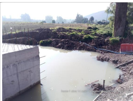
Obra No. 14 Box Culvert 2X2 K 2+014 retiro de aguas empozadas con motobomba (15/07/22)
