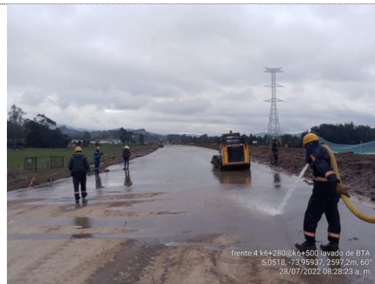
K6+280 – K6+500 lavado de superficie en BTA (28/07/22)
