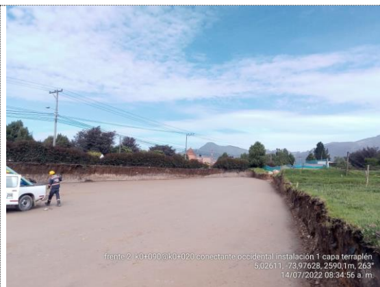
Conectante occidental K0+020 – K0+090 instalación 1er capa de terraplén (14/07/22)
