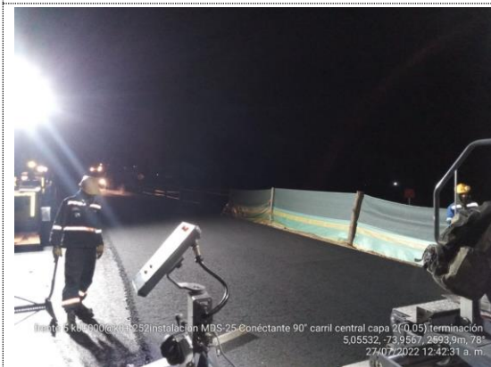
K0+250 – K0+310 conectante 90 grados instalación 2da capa de MSC-25 (26/07/22)
