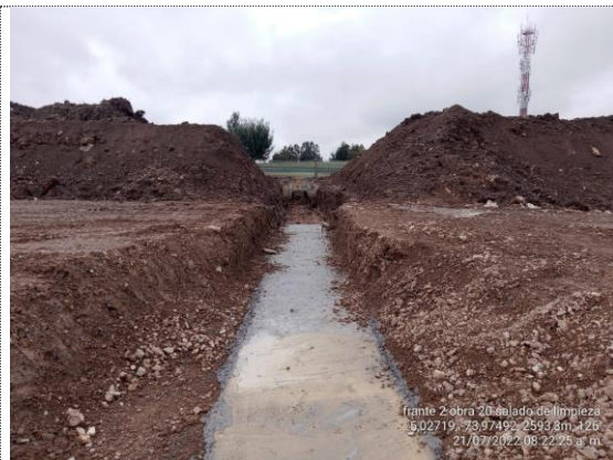
Obra No 20 Box culvert 1x1 K2+970 fundida de solado de limpieza (21/07/22)
