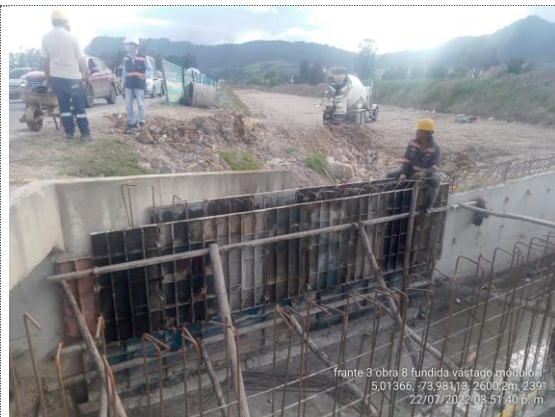
Obra No 8 Box culvert 2X2 K1+299 fundida de vástago sur módulo 1 (22/07/22)
