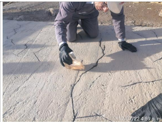
Obra No 38 Pasaganado 3x3 K5+194 reparación de placa superior, aplicación de Sikadur 35 (12/07/22)
