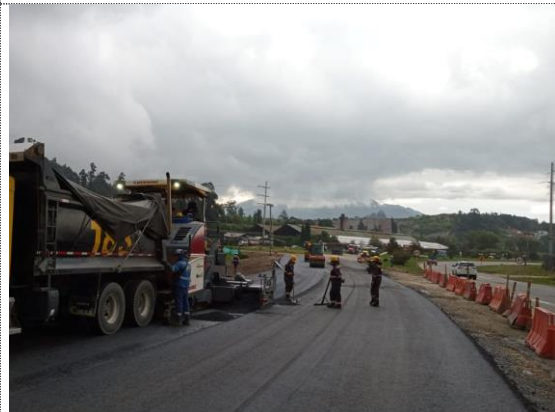
K0+000 – K0+310 conectante 90 grados instalación 2da capa de MSC-25 (27/07/22)
