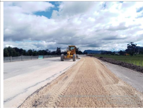
K6+540 – K6+610 instalación de subbase granular (07/07/22)
