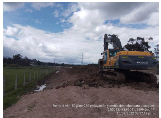
K6+150 – K6+280 perfilado de talud para desagües (15/07/22)
