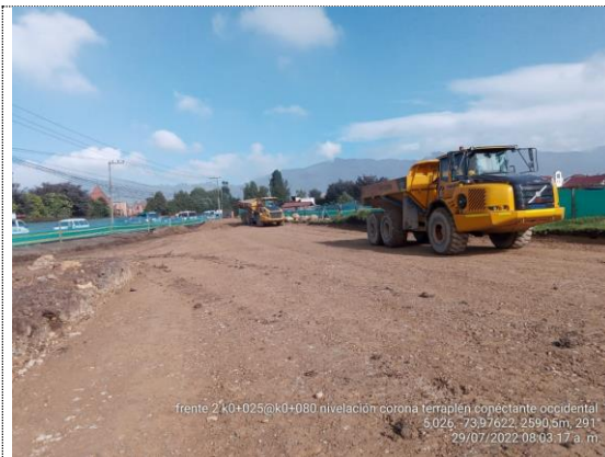
Conectante occidental K0+025 – K0+080 nivelación corona de terraplén (29/07/22)
