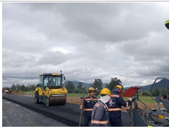
K3+900 – K4+000 instalación y compactación de BTA (13/07/22)
