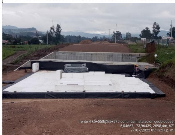
K5+550 - K5+575 CONTINÚA INSTALACIÓN DE GEOBLOQUES
