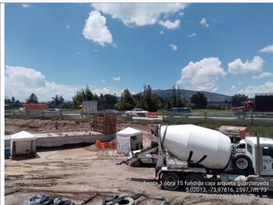
Obra No 15 Pasaganado 3X3 K2+138 fundida de caja de inspección (15/07/22)
