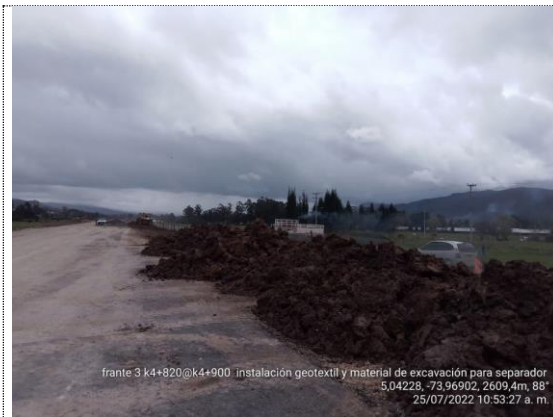
K4+820 – K4+900 instalación geotextil y material de excavación para separador (25/07/22)
