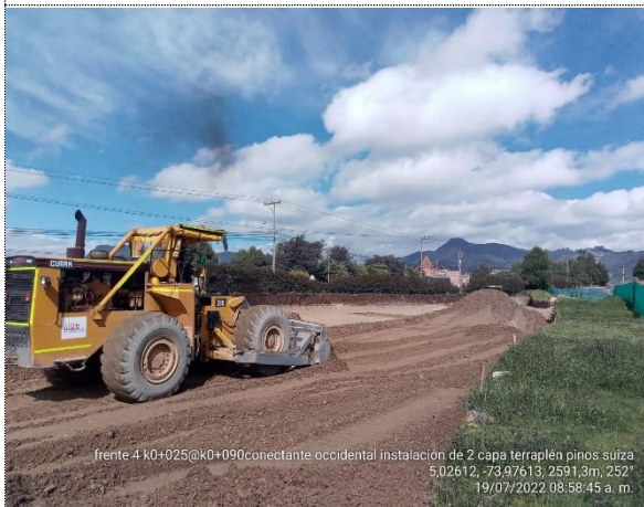
CONECTANTE OCCIDENTAL K0+025 - K0+090 INSTALACIÓN 2DA CAPA DE TERRAPLÉN
