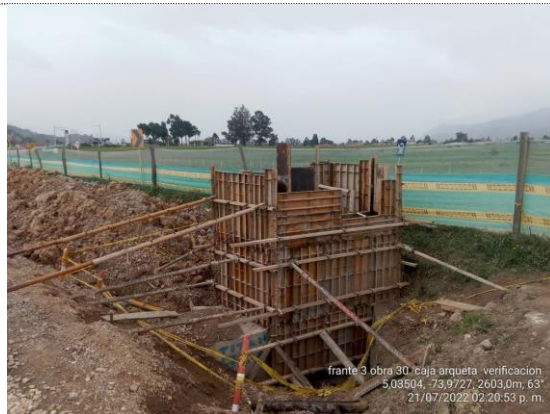
Obra No 30 Box culvert 1x1 K3+892 armado de acero caja arqueta (21/07/22)
