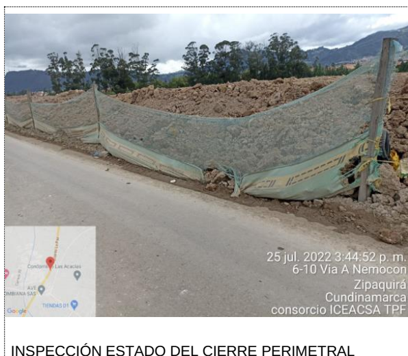
INSPECCIÓN ESTADO DEL CIERRE PERIMETRAL
