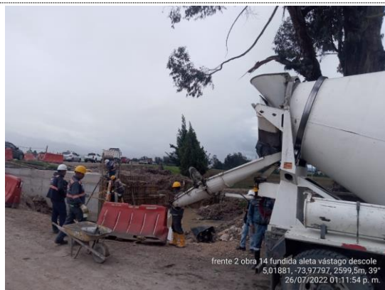
Obra No. 14 Box Culvert 2X2 K 2+014 fundida de aletas descole (26/07/22)
