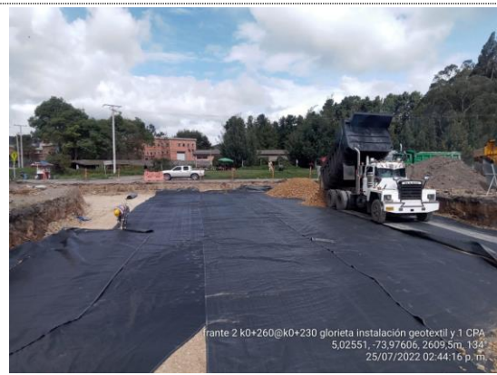
Glorieta K0+230 – K0+260 instalación de geotextil y 1er capa de terraplén (25/07/22)
