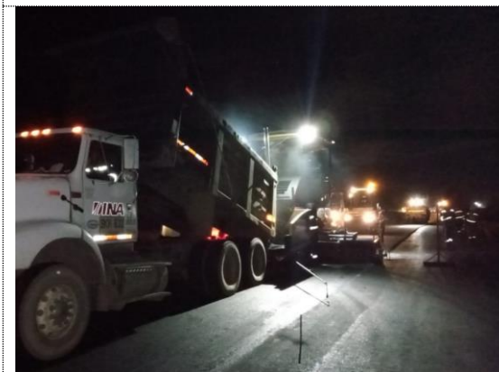
K6+030 – K6+580 instalación 2da capa de MSC-25 (29/07/22)
