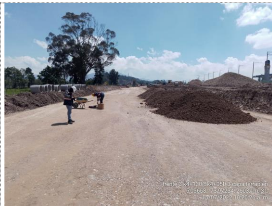
K4+050 – K4+130 instalación 3er capa de terraplen (15/07/22)
