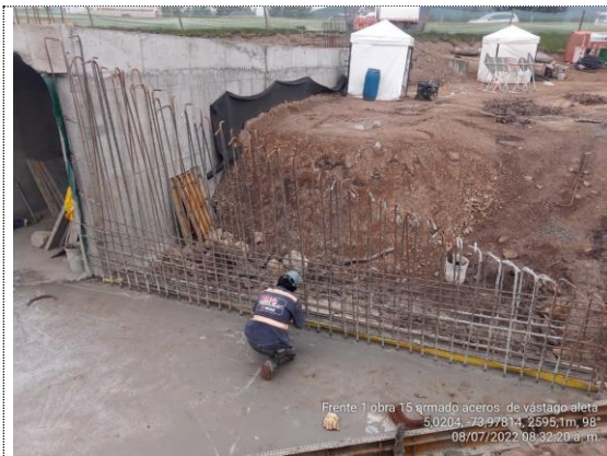
Obra No 15 Pasaganado 3X3 K2+138 Armado de acero aleta encole (08/07/22)
