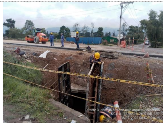
Obra No 35 Box culvert 1x1 K4+765 armado de acero y encofrado caja arqueta (28/07/22)
