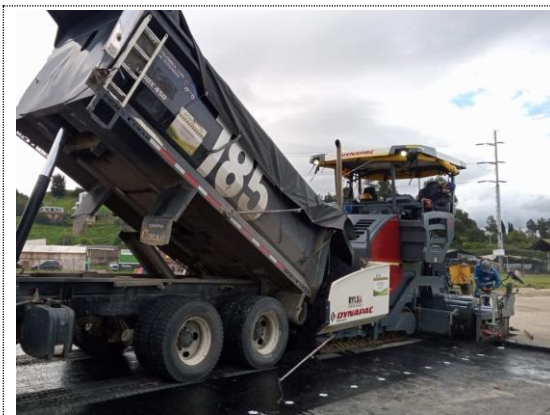
K0+000 – K0+250 conectante 90 grados instalación 1er capa de MSC-25 (25/07/22)
