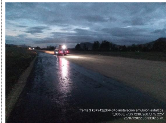
K4+000 – K4+050 instalación de emulsión asfáltica (26/07/22)
