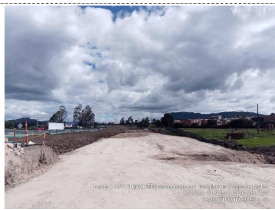
Conectante sur K0+000 – K0+140 instalación 3er capa de terraplén (16/07/22)
