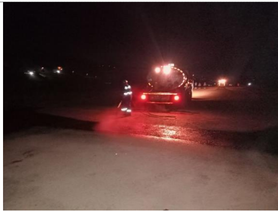
K5+020 – K5+170 instalación de emulsión asfáltica (18/07/22)
