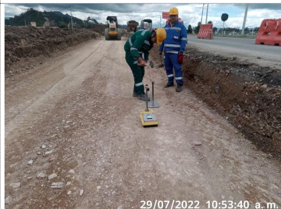
Retorno K4+200: K0+150 – K0+240 toma de densidades 2da capa de terraplén (29/07/22)
