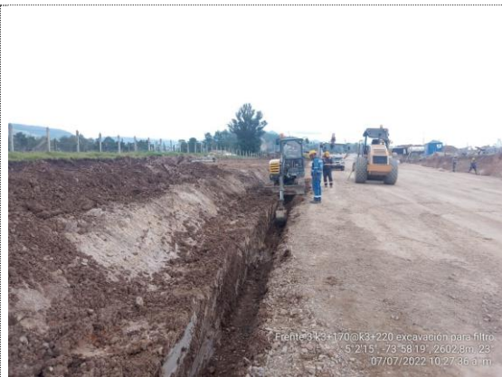
K3+170 – K3+220 excavación para filtro francés (07/07/22)
