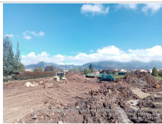
Conectante occidental K0+050 – K0+080 excavación para estructura de vía (01/07/22)
