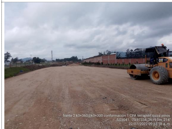
K3+300 – K3+360 instalación 1er capa de terraplén (22/07/22)
