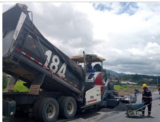
K6+580 – K0+310 margen izquierda instalación 1er capa de MSC-25
