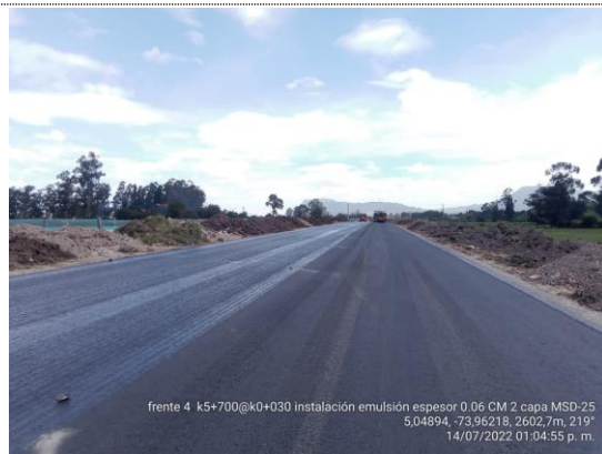
K5+700 – K6+030 instalación de emulsión asfáltica para 2da capa de MSC-25 (14/07/22)
