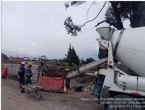
OBRA NO 14 FUNDIDA DE ALETAS DE DESCOLE
