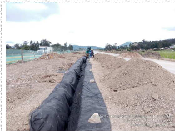
K6+200 – K6+250 instalación de filtro francés (07/07/22)
