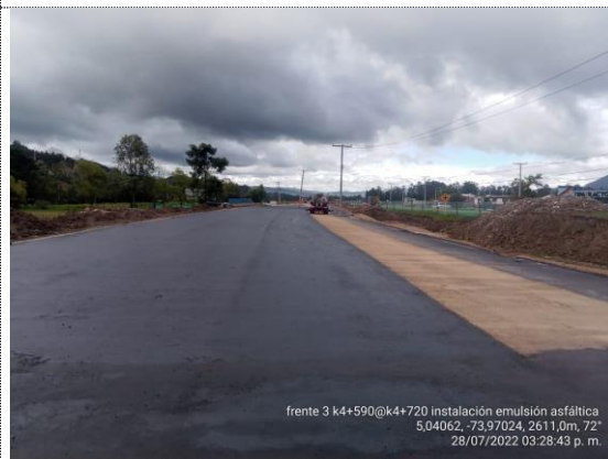
K4+590 – K4+720 instalación de emulsión asfáltica (28/07/22)
