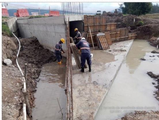
Obra No. 14 Box Culvert 2X2 K 2+014 armado de acero y encofrado aletas descole (26/07/22)
