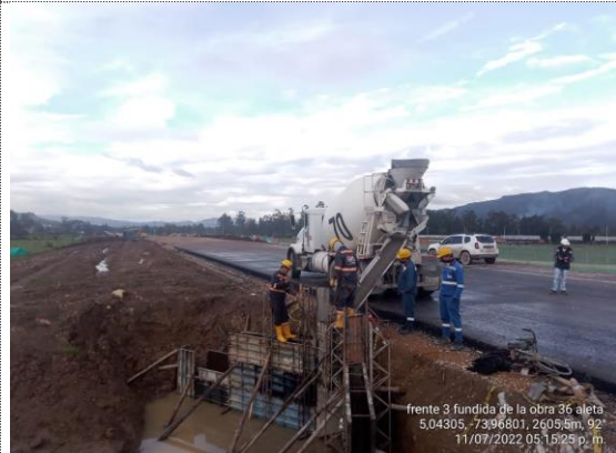
Obra No 36 Box culvert 1x1 K4+951 fundida de aleta de encole (11/07/22)
