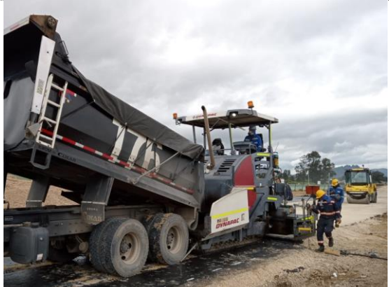
K4+000 – K4+050 instalación y compactación de BTA (27/07/22)
