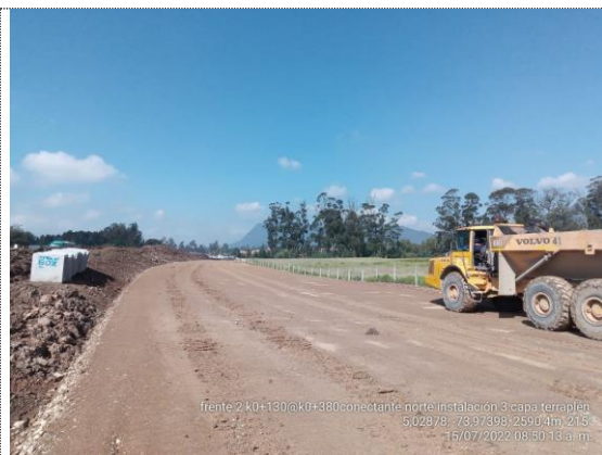
Conectante norte K0+130 – K0+380 instalación 3er capa de terraplén (15/07/22)
