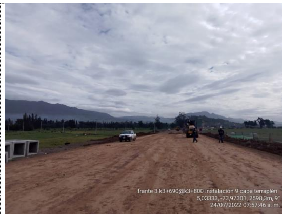
K3+690 – K3+800 instalación 9na capa de terraplén (24/07/22)
