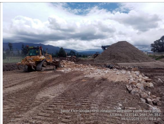
K3+300 – K3+350 instalación pedraplén y sello (19/07/22)
