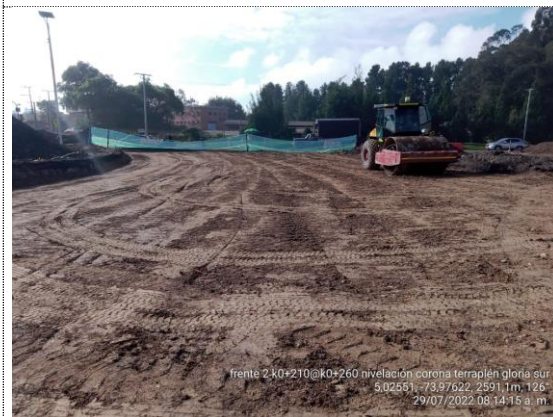
Glorieta K0+210 – K0+260 nivelación corona de terraplén (29/07/22)
