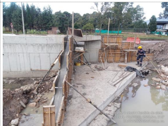
Obra No. 14 Box Culvert 2X2 K 2+014 fundido de aletas de encole (21/07/22)
