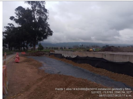
K2+000 – K2+010 instalación de geotextil y filtro adyacente a obra No 14 (08/07/22)
