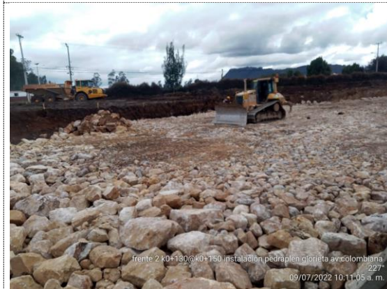
Glorieta K0+130 – K0+160 instalación de pedraplén (07/06/22)
