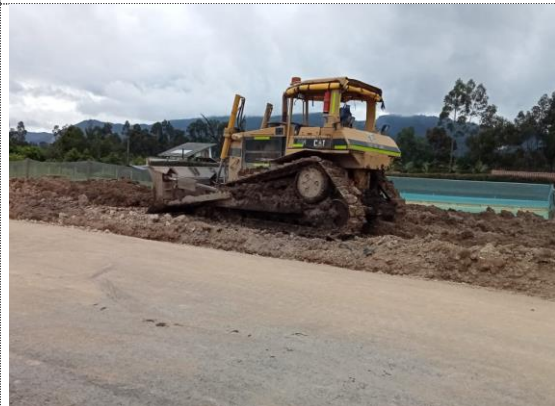
Adecuación de talud entre obras No 45 y 46 (K5+894 – K6+020)
