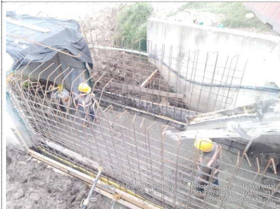
Obra No. 14 Box Culvert 2X2 K 2+014 fundida placa inferior módulo 8 (07/07/22)
