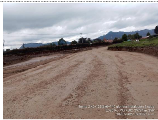
Glorieta K0+135 – K0+185 instalación 2da capa de terraplén (18/07/22)
