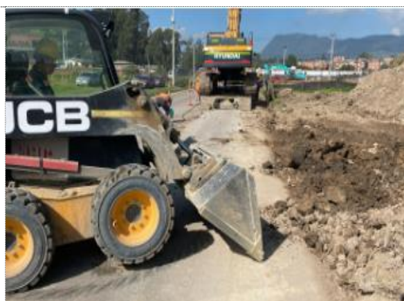
LIMPIEZA DE CARRIL IZQUIERDO CON MINICARGADOR
