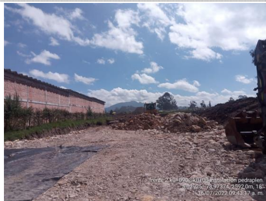
Conectante norte K0+000 – K0+090 instalación de pedraplén (16/07/22)
