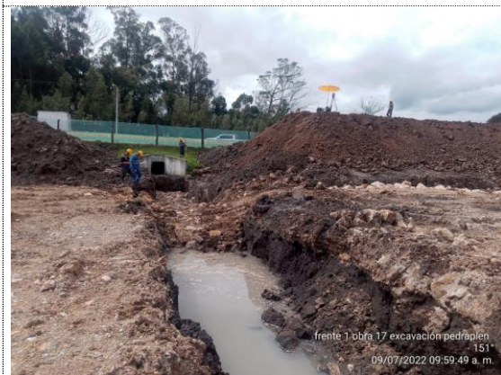
Obra No 17 Box culvert 1x1 K2+618 excavación e instalación de pedraplén (09/07/22)
