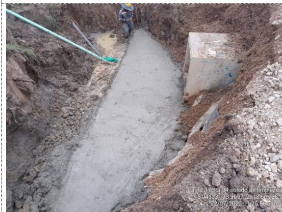
Obra No 34 Box culvert 1x1 K4+686 fundida de solado de limpieza en encofrado (22/07/22)
