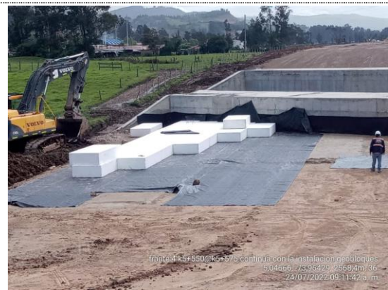
K5+550 – K5+575 instalación de 1er capa de geobloques (24/07/22)
