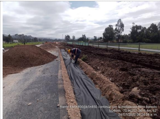
K5+800 – K5+850 instalación de filtro francés (24/07/22)
