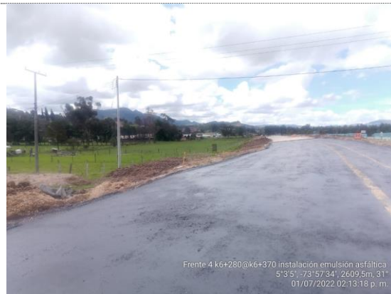
K6+280 – K6+370 instalación de emulsión asfáltica (01/07/22)
