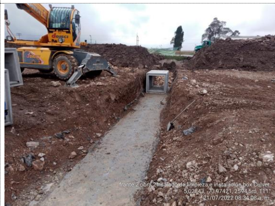
Obra No 21 Box culvert 1x1 K3+135 fundida de solado e instalación de módulos prefabricados (21/07/22)
