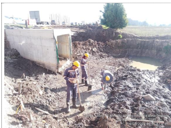
Obra No. 14 Box Culvert 2X2 K 2+014 conformación de terreno para fundir solado de limpieza encofe (14/07/22)
