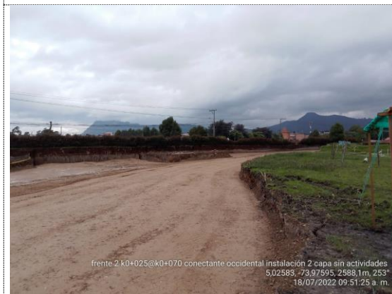
Conectante occidental K0+025 – K0+070 instalación 2da capa de terraplén (18/07/22)
