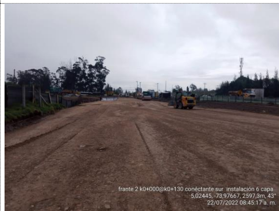
Conectante sur K0+000 – K0+130 instalación 6ta capa de terraplén (22/07/22)
