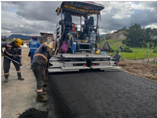
K5+640 – K5+700 instalación y compactación de BTA (22/07/22)
