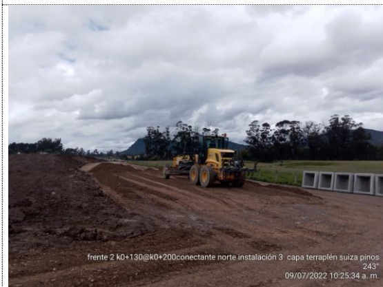
Conectante norte K0+130 – K0+200 instalación 3er capa de terraplén (09/07/22)
