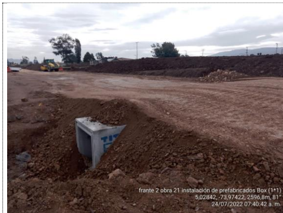
Obra No 21 Box culvert 1x1 K3+135 instalación de módulos prefabricados de box culvert (21/07/22)
