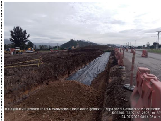
Retorno K4+200 K0+100 – K0+230 instalación de geotextil y 1er capa de terraplén (24/07/22)
