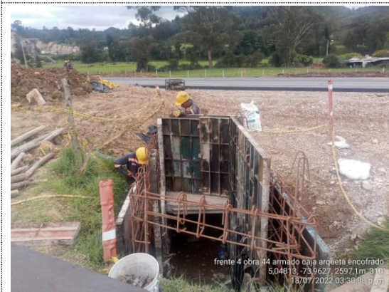
Obra No 44 Box culvert 1x1 K5+751 armado de acero y encofrado caja arqueta (18/07/22)
