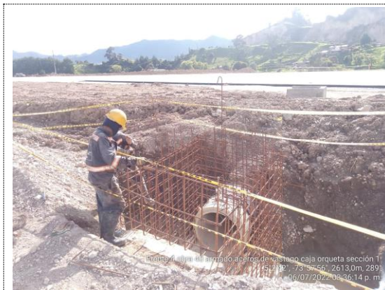
Obra No. 40 Alcantarilla D=0.90m K5+289 armado de acero caja arqueta (06/07/22)
