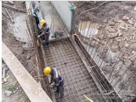
Obra No 8 Box culvert 2X2 K1+299 armado de acero y encofrado placa inferior módulo 1 (21/07/22)
