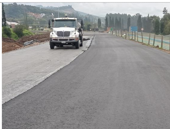
K6+580 – K0+310 instalación de emulsión asfáltica (28/07/22)
