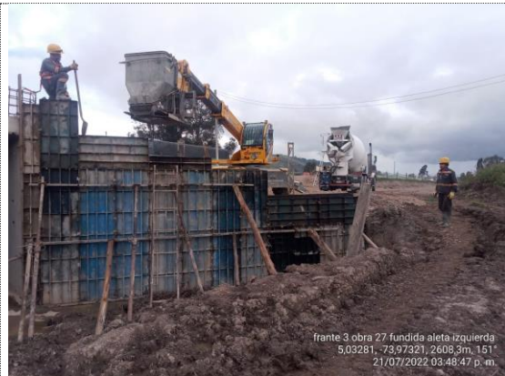
Obra No 27 Pasaganado 3x3 K3+641 fundida de aleta sur de encole (21/07/22)
