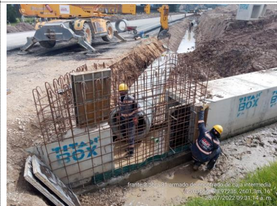
Obra No 31 Box culver 1x1 K4+075 armado de acero y encofrado caja intermedia (25/07/22)
