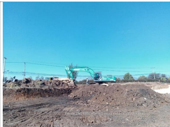
Glorieta Ave Colombiana K0+130 – K0+160 inicia excavación (07/07/22)
