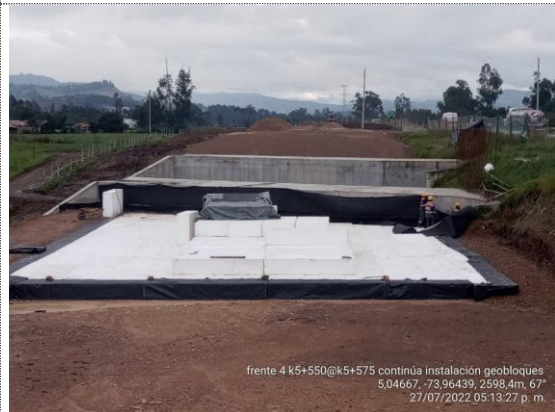
K5+550 – K5+575 instalación de 1er capa de geobloques (27/07/22)
