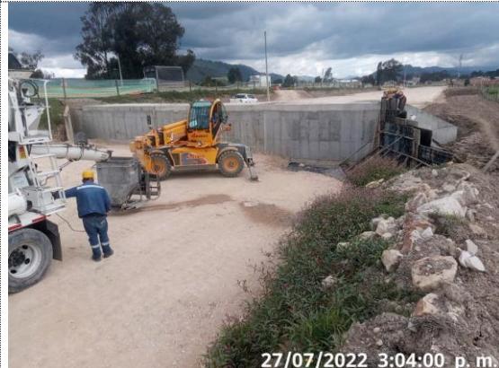
Obra No 27 Pasaganado 3x3 K3+641 fundida de aleta norte de encole (27/07/22)
