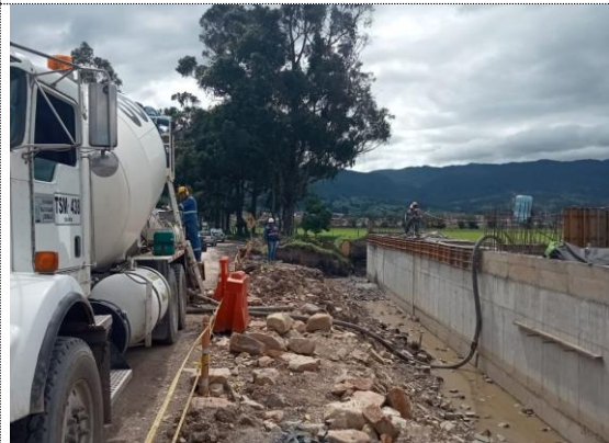
Obra No. 14 Box Culvert 2X2 K 2+014 fundida de placa superior módulo 6 y 7 (05/07/22)
