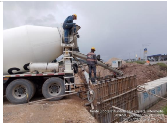
Obra No 31 Box culver 1x1 K4+075 fundida de caja de intermedia (26/07/22)
