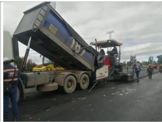
K6+140 – K6+710 instalación 2da capa de MSC-25 (30/07/22)
