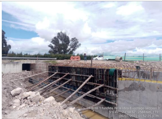
Obra No 8 Box culvert 2X2 K1+299 fundida de vástago módulo 3 (06/07/22)
