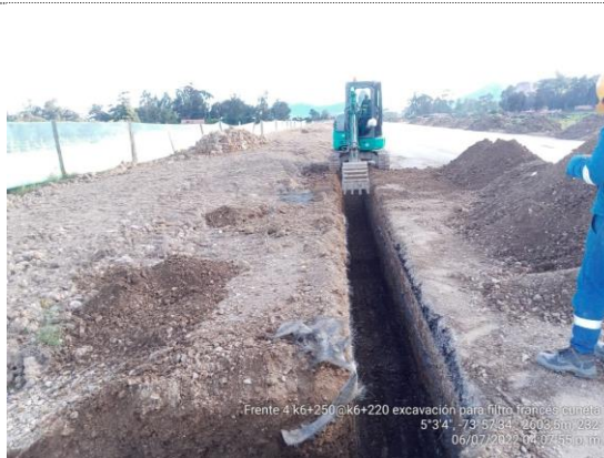
K6+220 – K6+250 excavación para filtro francés (06/07/22)
