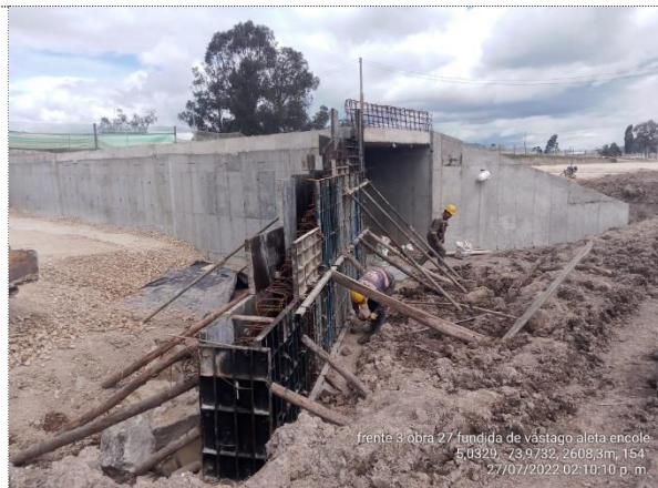
OBRA NO 27 ARMADO DE ACERO, ENCOFRADO Y FUNDIDA DE ALETA NORTE DE ENCOLE
