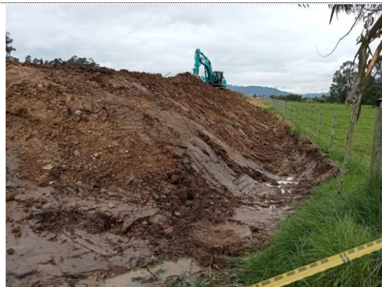
Adecuación de talud entre obras No 44 y 45 (K5+751 – K5+894)
