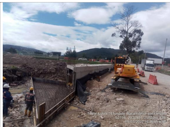
Obra No. 14 Box Culvert 2X2 K 2+014 fundido placa inferior encole (18/07/22)
