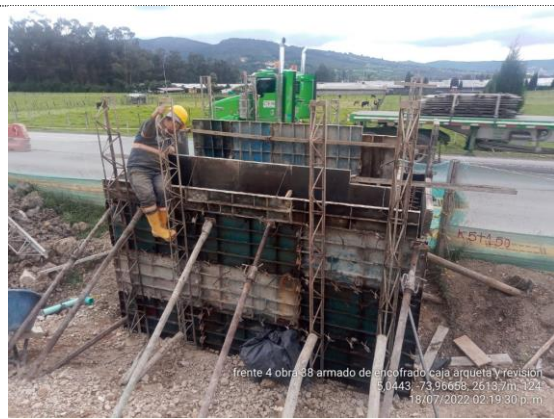
Obra No 38 Pasaganado 3x3 K5+194 armado de acero y encofrado caja de inspección (18/07/22)
