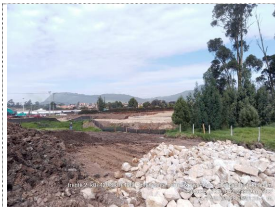
Conectante norte K0+420 – K0+490 excavación para estructura de vía (13/07/22)
