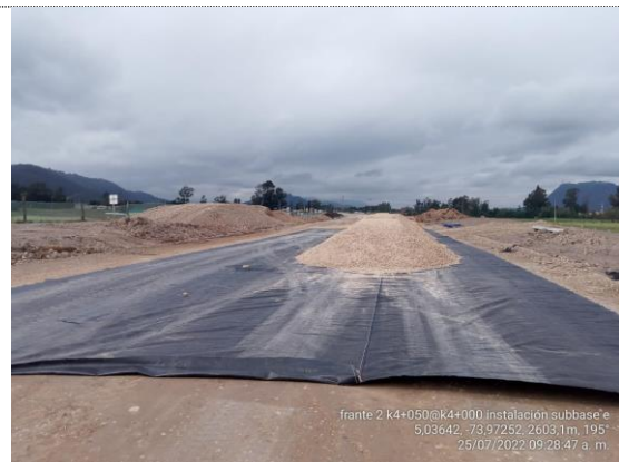
K4+000 – K4+050 instalación de geotextil y subbase granular (25/07/22)
