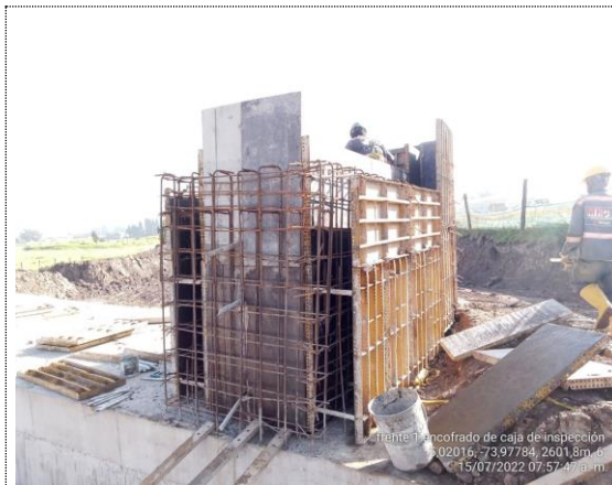
Obra No 15 Pasaganado 3X3 K2+138 armado de acero y encofrado caja de inspección (15/07/22)
