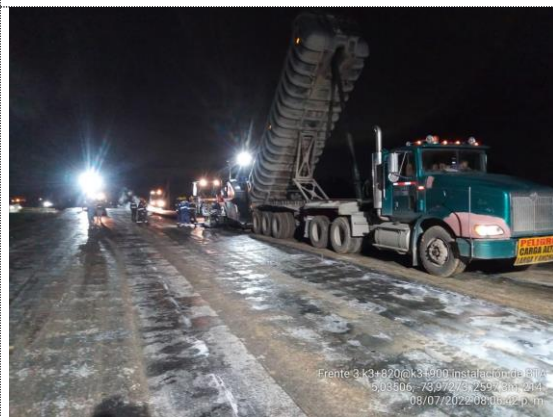
K3800 – K3+900 instalación y compactación de BTA (08/07/22)
