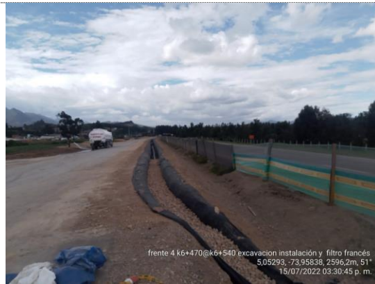
K6+470 – K6+540 instalación de filtro francés (15/07/22)
