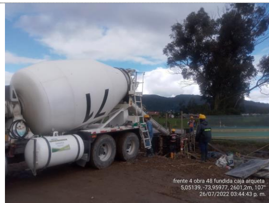
Obra No 48 Box culvert 1X1 K6+240 fundida de caja arqueta (26/07/22)
