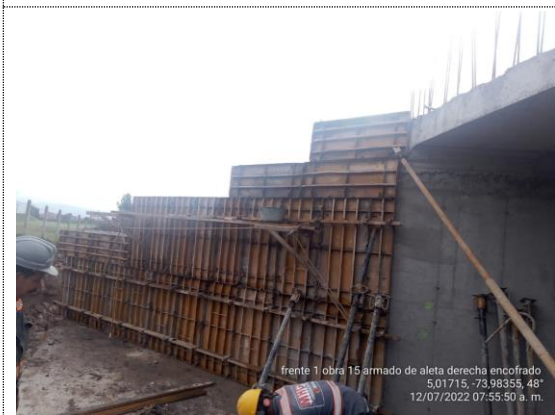
Obra No 15 Pasaganado 3X3 K2+138 armado de acero y encofrado aleta norte de encole (12/07/22)
