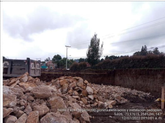
Glorieta K0+130 – K0+200 excavación e instalación de pedraplén (12/07/22)
