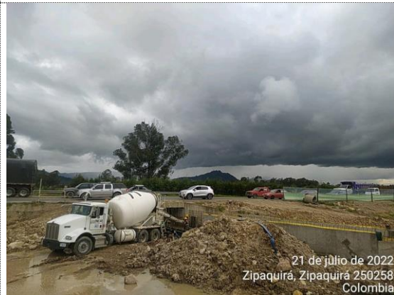
Obra No 8 Box culvert 2X2 K1+299 fundida de placa inferior módulo 1 (21/07/22)
