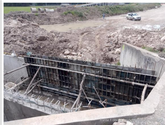
Obra No 8 Box culvert 2X2 K1+299 fundida de vástago norte módulo 1 (23/07/22)
