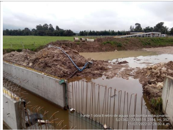
Obra No 8 Box culvert 2X2 K1+299 retiro de agua empozada con motobomba (21/07/22)
