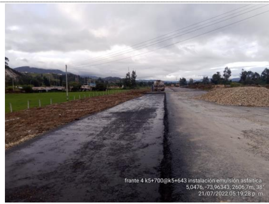
K5+640 – K5+700 Instalación de emulsión asfáltica (21/07/22)
