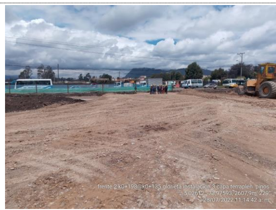
Glorieta K0+135 – K0+200 instalación 3er capa de terraplén (28/07/22)
