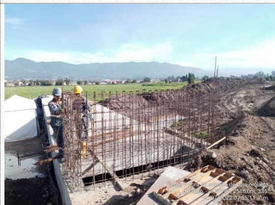
Obra No 15 Pasaganado 3X3 K2+138 armado de acero caja de inspección (14/07/22)
