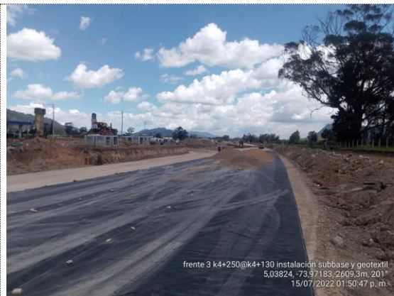
K4+130 – K4+250 instalación de geotextil y subbase granular (15/07/22)
