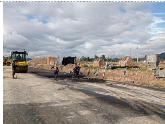
K4+268 – K4+308 instalación y compactación de BTA (22/07/22)
