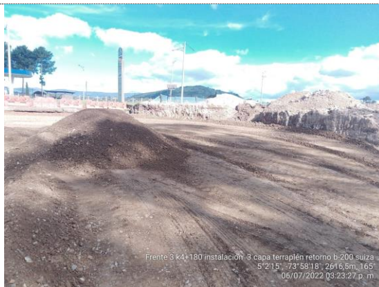
Retorno K4+200 instalación 3er capa de terraplén (06/07/22)
