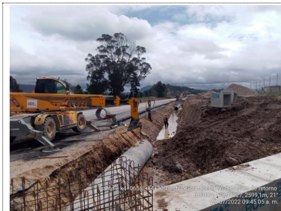
K4+065 – K4+300 instalación de tubería de 36" para desagüe de Retorno K4+200 (25/07/22)
