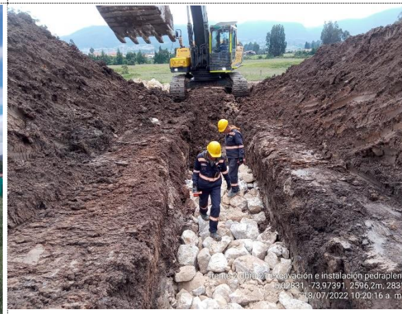
RETIRO DE AGUA EMPOZADA A NIVEL DE TERRAPLÉN K1+700 - K1+900
