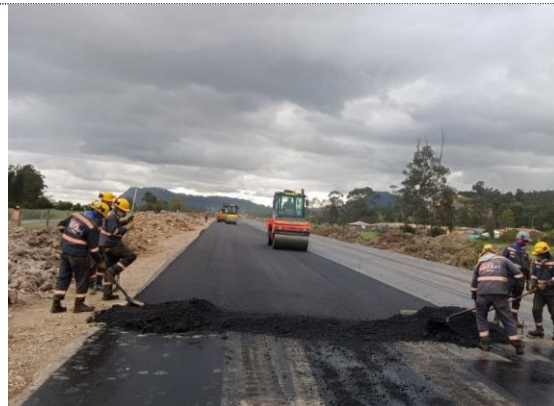
K5+700 – K6+030 instalación y compactación 1er capa de MSC-25 (13/07/22)
