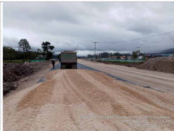
K4+590 – K4+700 instalación de geotextil y subbase granular (25/07/22)
