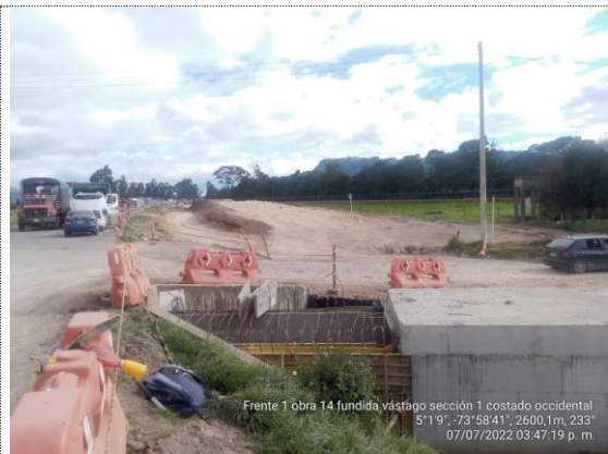
Obra No. 14 Box Culvert 2X2 K 2+014 fundida de vástago módulo 1 (07/07/22)
