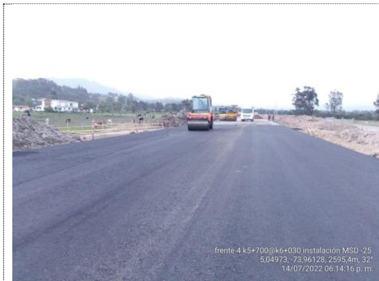
K5+700 – K6+030 margen derecha instalación 2da capa de MSC-25 (14/07/22)
