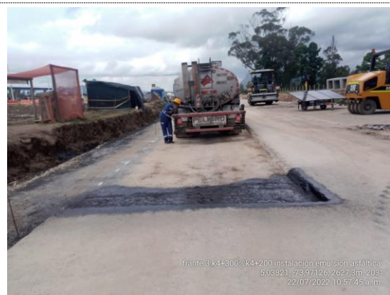
K4+200 – K4+300 instalación de emulsión asfáltica (22/07/22)
