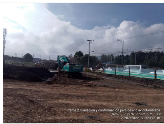
Desvío glorieta Ave Colombiana nivelación y conformación (29/07/22)
