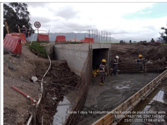
Obra No. 14 Box Culvert 2X2 K 2+014 fundida de placa inferior descole (23/07/22)
