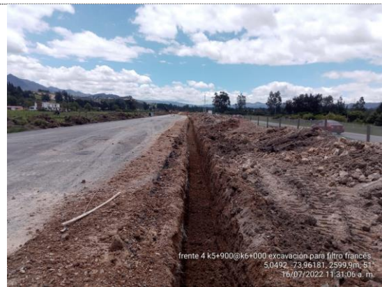
K5+900 – K6+000 excavación para filtro francés (16/07/22)
