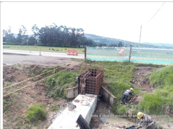
Obra No 39 Box culvert 1x1 K5+218 armado de acero y encofrado caja arqueta (01/07/22)
