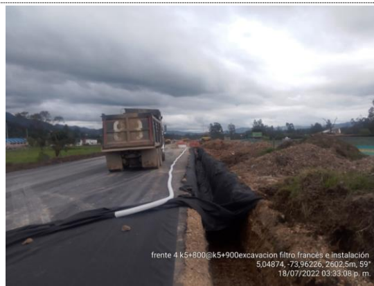
K5+800 – K5+900 excavación e instalación de filtro francés (18/07/22)
