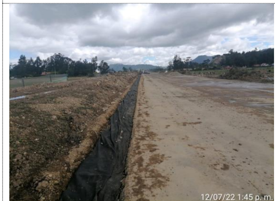
K6+100 – K6+220 instalación de filtro francés (12/07/22)
