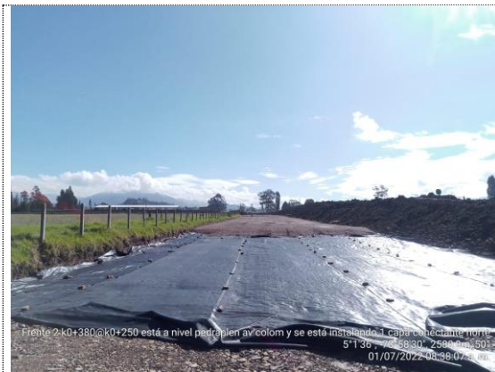
Conectante norte K0+250 – K0+380 instalación de geotextil y 1er capa de terraplén (01/07/22)
