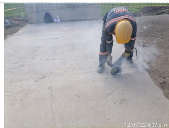
Obra No 38 Pasa ganado 3x3 K5+194 reparación de grietas en placa superior, profundización (12/07/22)
