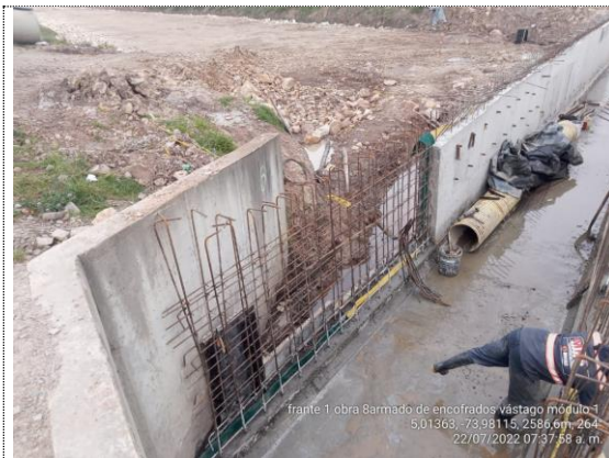
Obra No 8 Box culvert 2X2 K1+299 armado de acero y encofrado vástago sur módulo 1 (22/07/22)
