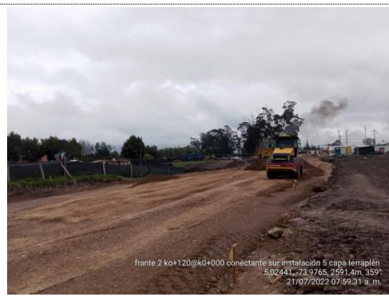
Conectante sur K0+000 – K0+120 instalación 5ta capa de terraplén (21/07/22)
