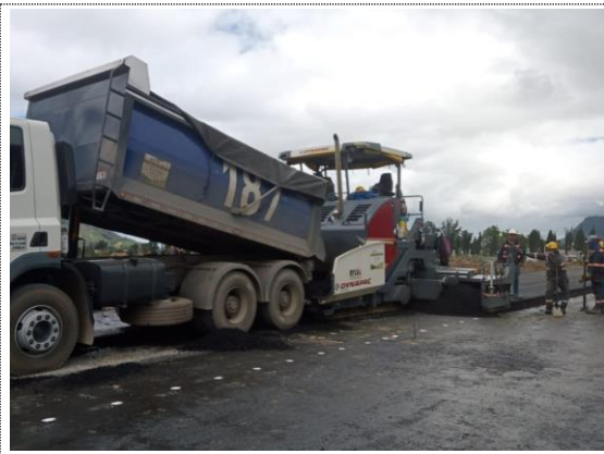
K5+020 – K5+170 instalación y compactación de BTA (19/07/22)
