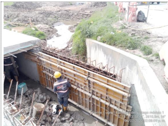
Obra No. 14 Box Culvert 2X2 K 2+014 armado de acero y encofrado vástago módulo 1 (06/07/22)
