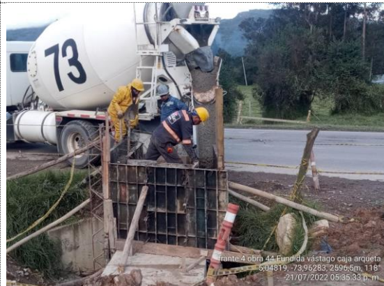
Obra No 44 Box culvert 1x1 K5+751 fundida de caja arqueta (21/07/22)
