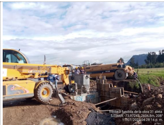
Obra No 31 Box culver 1x1 K4+075 fundida de aleta de encole (11/07/22)
