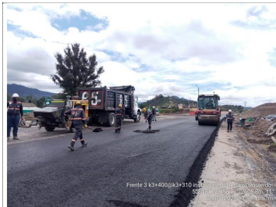
K4+280 – K4+400 instalación y compactación de BTA (06/07/22)
