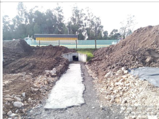
Obra No 17 Box culvert 1x1 K2+618 fundida de solado de limpieza (13/07/22)
