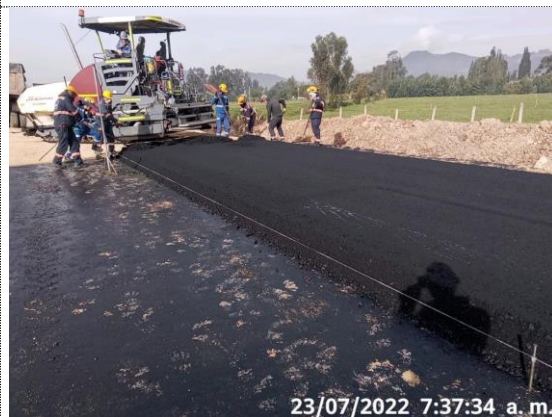
K4+080 – K4+130 instalación y compactación de BTA (23/07/22)
