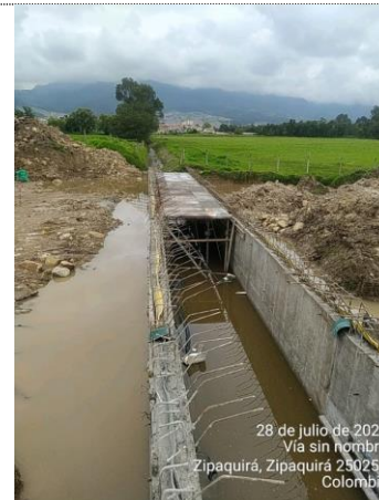
Obra No 8 Box culvert 2X2 K1+299 encofrado y armado de acero placa superior módulos 3 y 4 (28/07/22)
