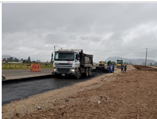
Retorno K5+300 instalación y compactación de BTA (26/07/22)
