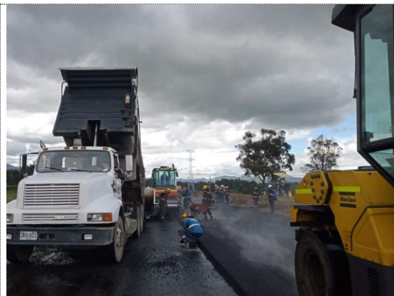
K6+000 – K6+130 instalación 1er capa de MSC-25 (29/07/22)
