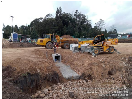
Obra No 18 Box culvert 1x1 K2+695 instalación de módulos prefabricados de box culvert (18/07/22)
