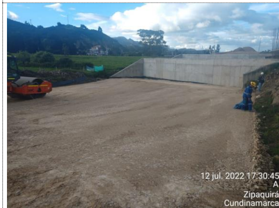
K5+550 – K5+575 instalación de geotextil y 1er capa de terraplén en sector geobloques (12/07/22)
