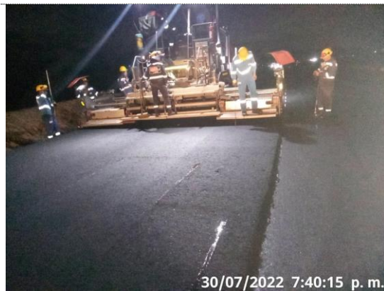
K6+590 – K6+710 margen izquierda instalación MDC-19 (30/07/22)
