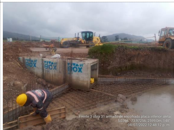
Obra No 31 Box culver 1x1 K4+075 armado de acero y encofrado placa inferior encoleta (08/07/22)
