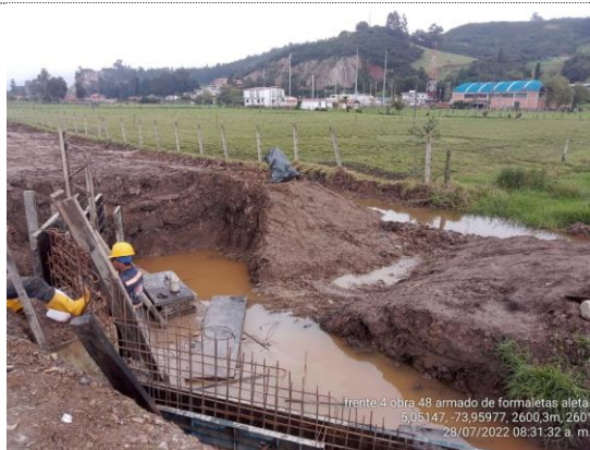
Obra No 48 Box culvert 1X1 K6+240 armado de acero y encofrado aletas de encole (28/07/22)
