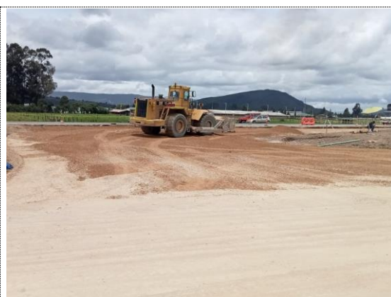
Retorno K5+300 K0+020 – K0+220 instalación de subbase granular (23/07/22)
