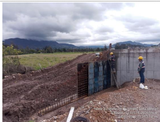
Obra No 27 Pasaganado 3x3 K3+641 armado de acero y encofrado aleta de encole (18/07/22)
