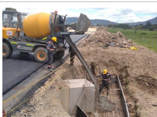
Obra No 44 Box culvert 1X1 K5+751 fundida placa inferior encole (16/07/22)
