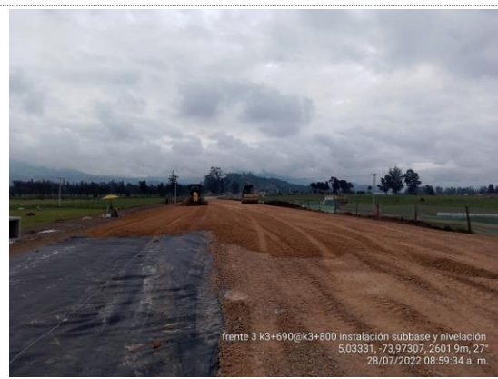
K3+690 – K3+800 instalación de geotextil y subbase granular (28/07/22)
