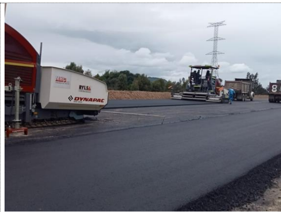
K6+280 – K6+590 instalación y compactación capa de rodadura en MDC-19 (31/07/22)
