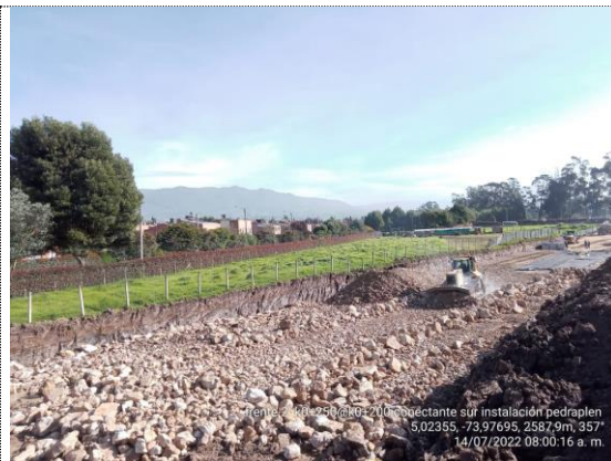
Conectante sur K0+200 – K0+250 instalación de pedraplén (14/07/22)
