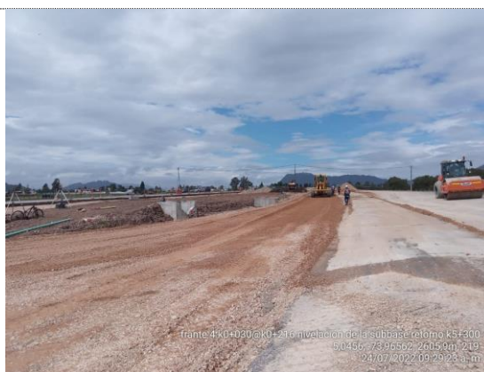
Retorno K5+300 K0+030 – K0+216 nivelación de subbase granular (24/07/22)
