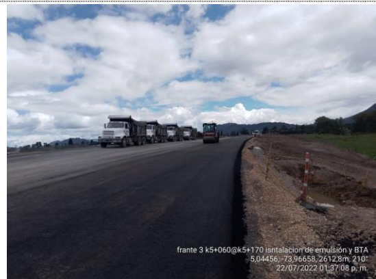
K5+070 – K5+170 instalación y compactación de BTA margen izquierda (22/07/22)
