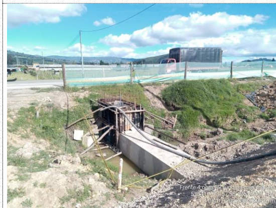
Obra No 39 Box culvert 1x1 K5+218 fundida de caja arqueta (06/07/22)
