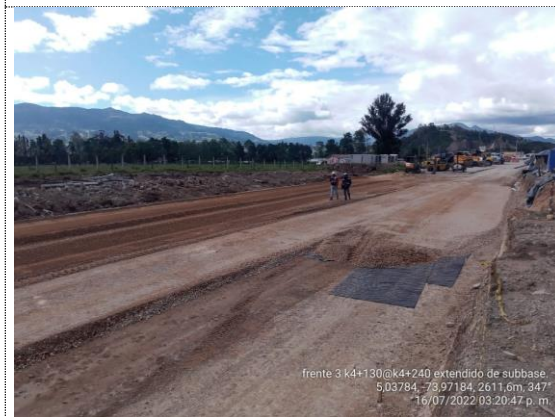
K4+130 – K4+240 instalación de geotextil y subbase granular (16/07/22)
