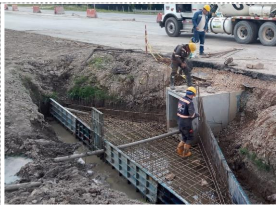
Obra No 54 Box culvert 1x1 K6+920 armado de acero y encofrado placa inferior encofe (22/07/22)
