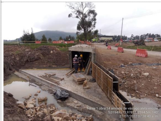
Obra No. 14 Box Culvert 2X2 K 2+014 armado de acero y encofrado aletas de encole (21/07/22)
