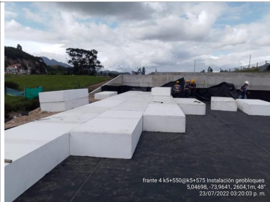
K5+550 – K5+575 instalación de geobloques (23/07/22)
