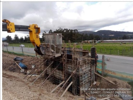
Obra No 38 Pasaganado 3x3 K5+194 fundida de caja de inspección (18/07/22)
