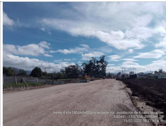
Conectante sur K0+000 – K0+140 instalación 4ta capa de terraplén (19/07/22)
