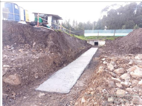
Obra No 18 Box culvert 1x1 K2+695 fundida de solado de limpieza (05/07/22)
