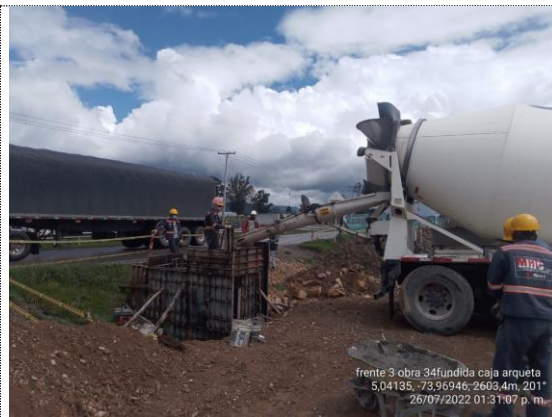
Obra No 34 Box culvert 1x1 K4+686 fundida de caja arqueta (26/07/22)
