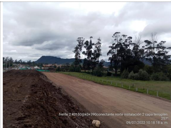
Conectante norte K0+200 – K0+390 instalación 2da capa de terraplén (09/07/22)
