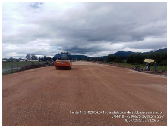
K5+020 – K5+170 instalación de subbase granular (18/07/22)
