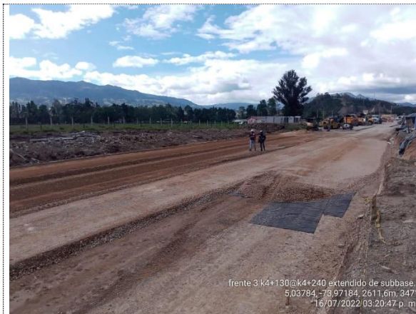
K4+130 - K4+240 INSTALACIÓN DE GEOTEXTIL Y SUBBASE GRANULAR
