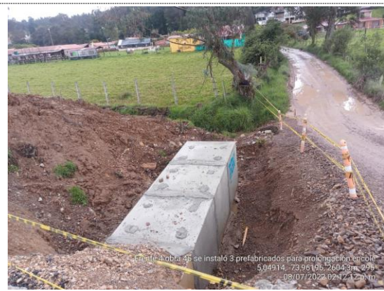
Obra No 45 Box culvert 1X1 K5+894 prolongación box culvert (08/07/22)
