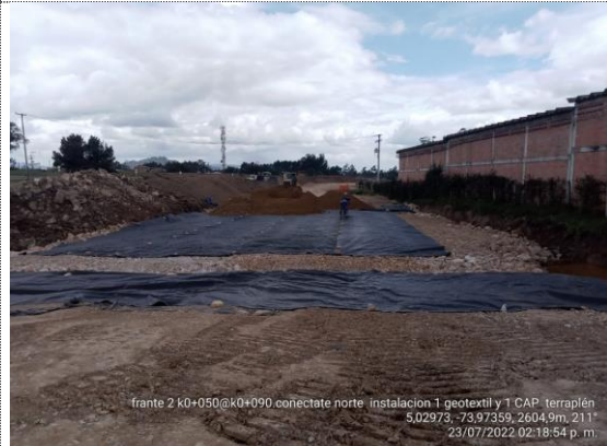
Conectante norte K0+050 – K0+090 instalación geotextil y 1er capa de terraplén (23/07/22)
