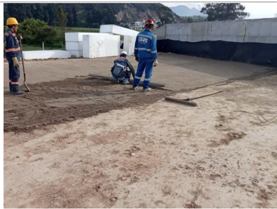
K5+550 – K5+575 nivelación de arena para instalación de geobloques (23/07/22)
