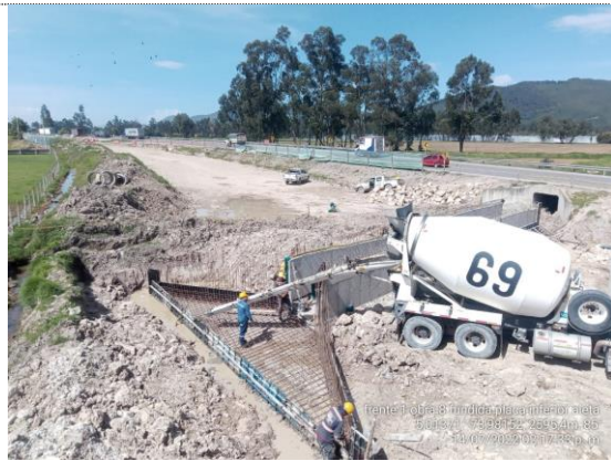
Obra No 8 Box culvert 2X2 K1+299 fundida de placa inferior encofe (15/07/22)
