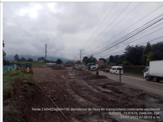
Conectante occidental K0+025 – K0+100 demolición de muro en mampostería (27/07/22)
