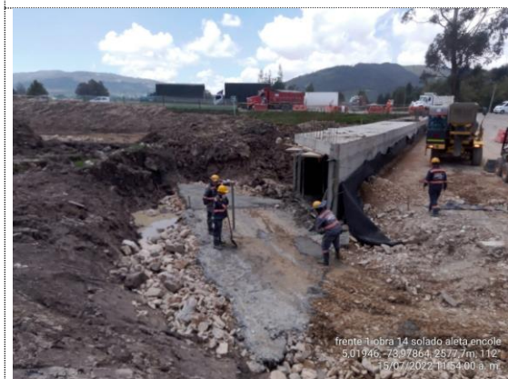
Obra No. 14 Box Culvert 2X2 K 2+014 fundida de solado de limpieza encofe (15/07/22)
