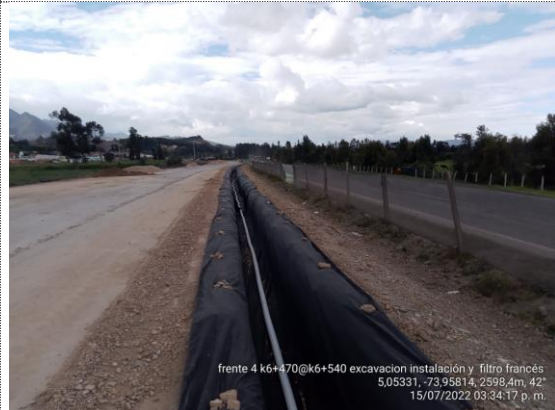
K6+470 – K6+540 instalación de filtro francés (15/07/22)
