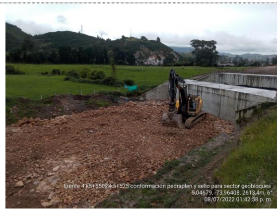
K5+550 – K5+575 conformación pedraplén y sello en sector geobloques (08/07/22)
