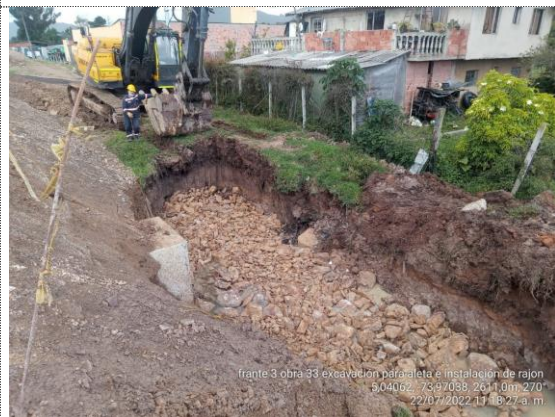
Obra No 33 Box culvert 1X1 K4+564 excavación e instalación de pedraplén en encole (22/07/22)
