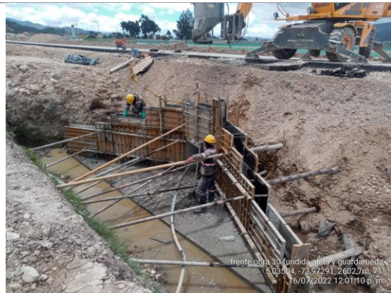
Obra No 30 Box culvert 1x1 K3+892 fundida de aletas de encole (16/07/22)
