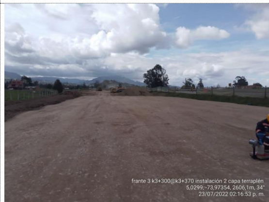
K3+300 – K3+370 instalación 2da capa de terraplén (23/07/22)
