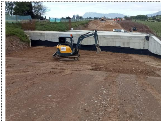
K5+600 – K5+620 nivelación de terraplén para iniciar instalación de geobloques (30/07/22)
