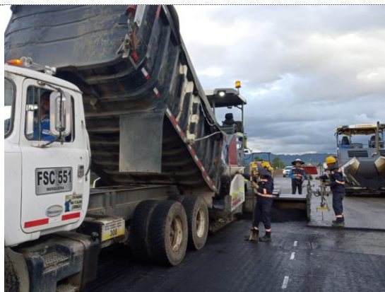
K6+580 – K0+310 instalación 2da capa MSC-25 (29/07/22)
