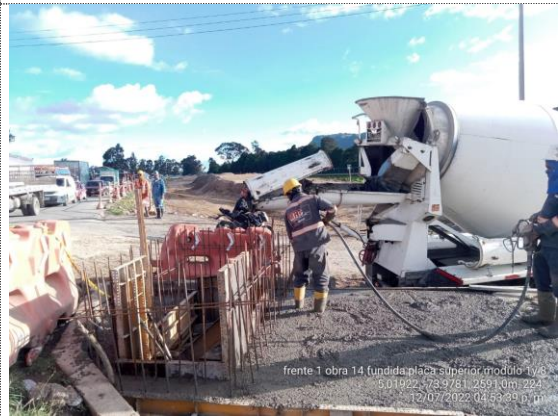
Obra No. 14 Box Culvert 2X2 K 2+014 fundida de placa superior módulo 1 (12/07/22)
