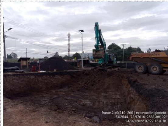
Glorieta K0+210 – K0+260 excavación para estructura de vía (24/07/22)
