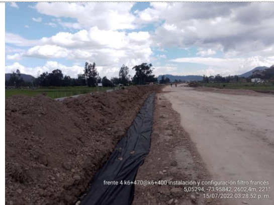
K6+400 – K6+470 instalación de filtro francés (15/07/22)
