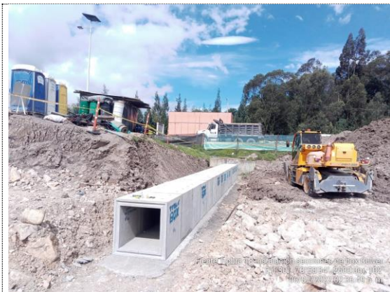
Obra No 18 Box culvert 1x1 K2+695 instalación de módulos prefabricados de box culvert (06/07/22)
