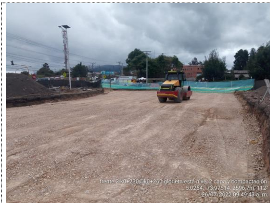
Glorieta K0+230 – K0+260 instalación de 2da capa de terraplén (26/07/22)
