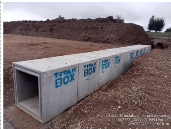
Obra No 20 Box culvert 1x1 K2+970 instalación de módulos prefabricados de box culvert (25/07/22)
