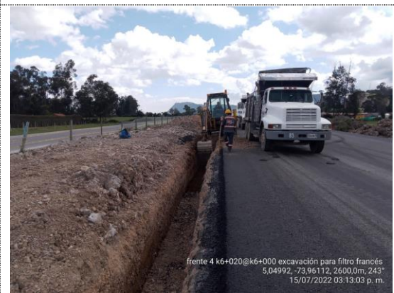
K6+000 – K6+020 excavación para filtro francés (15/07/22)
