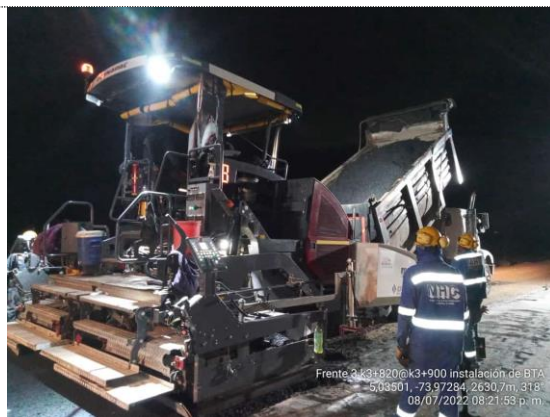
K3800 – K3+900 instalación y compactación de BTA (08/07/22)
