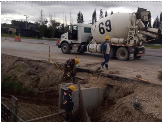
Obra No 54 Box culvert 1x1 K6+920 fundida de placa inferior encofe (22/07/22)
