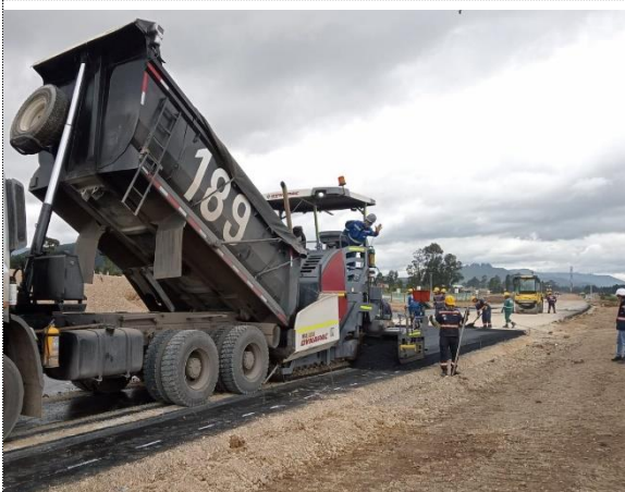
K3+990 - K4+045 INSTALACIÓN Y COMPACTACIÓN DE BTA
