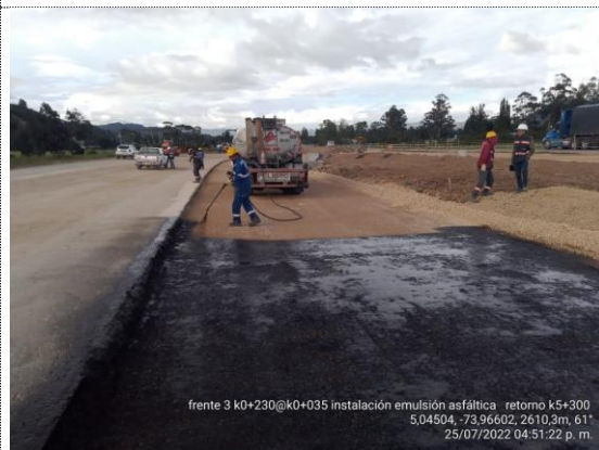
Retorno K5+300: K0+035 – K0+230 instalación de emulsión asfáltica (25/07/22)
