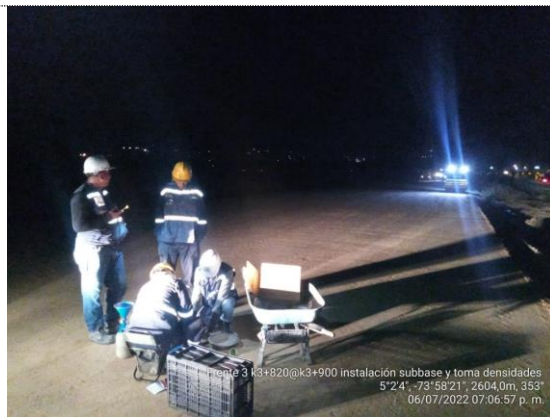
K3+820 – K3+900 instalación de subbase granular (06/07/22)
