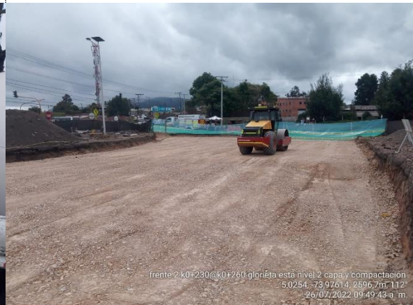
GLORIETA K0+230 - K0+260 INSTALACIÓN DE 2DA CAPA DE TERRAPLÉN
