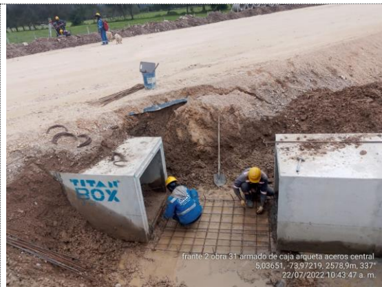
Obra No 31 Box culver 1x1 K4+075 armado de acero placa inferior caja intermedia (11/07/22)
