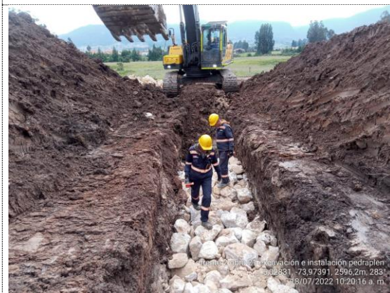
Obra No 21 Box culvert 1x1 K3+135 excavación e instalación de pedraplén (18/07/22)
