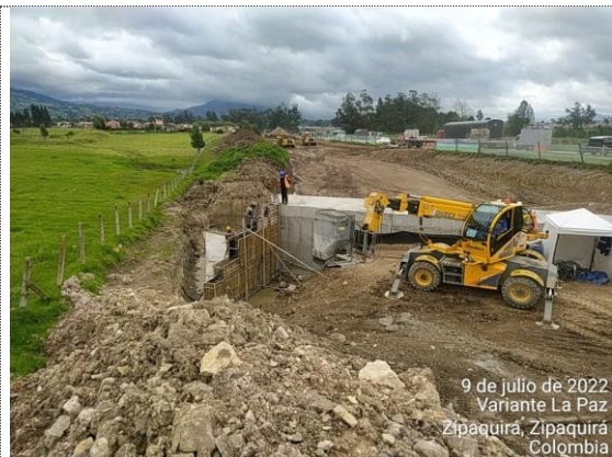
Obra No 15 Pasaganado 3X3 K2+138 fundida de aleta sur de encole (09/07/22)
