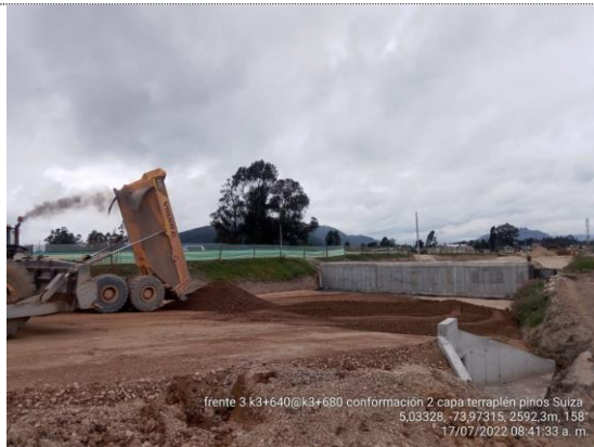
K3+640 – K3+680 instalación 2da capa de terraplén (17/07/22)
