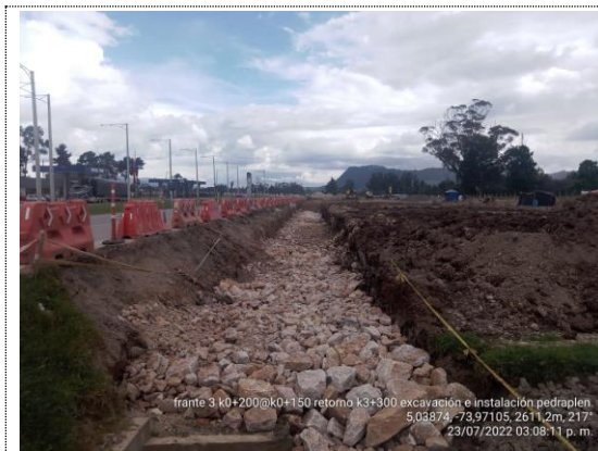
Retorno K4+200 K0+150 – K0+200 excavación e instalación de pedraplen (23/07/22)
