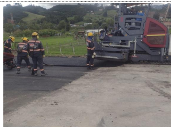
K6+280 – K6+370 instalación y compactación de BTA (05/07/22)
