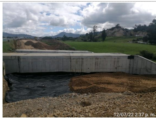
K5+600 – K5+620 instalación geotextil y 1er capa de terraplén (12/07/22)
