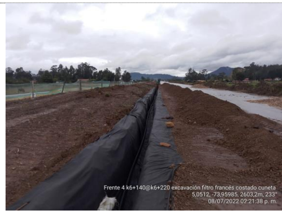
K6+140 – K6+200 instalación de filtro francés (08/07/22)
