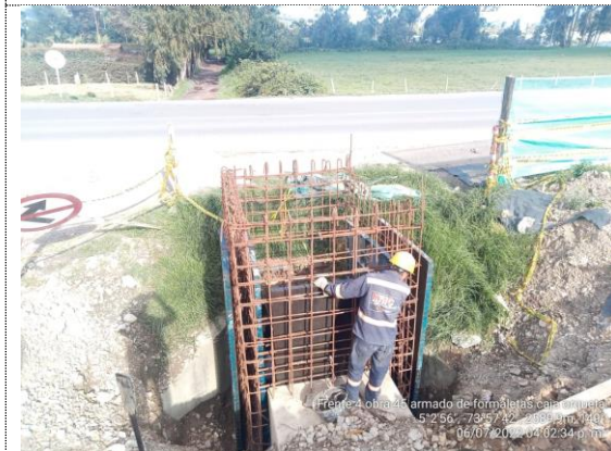
Obra No 45 Box culvert 1X1 K5+894 armado de acero y encofrado caja arqueta (06/07/22)
