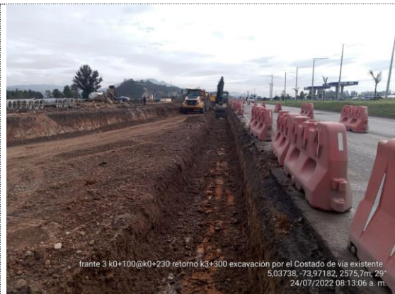
Retorno K4+200 K0+100 – K0+230 excavación para estructura de vía (24/07/22)
