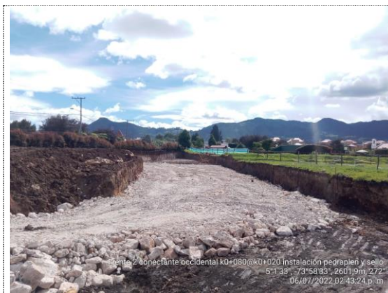
Conectante occidental K0+020 – K0+080 instalación de pedraplén y sello (06/07/22)
