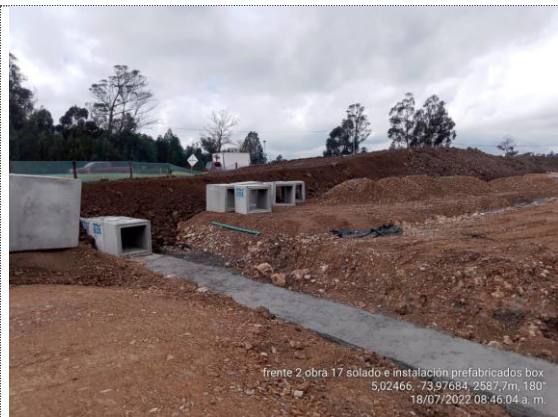
Obra No 17 Box culvert 1x1 K2+618 instalación de solado y módulos prefabricados de box culvert (18/07/22)
