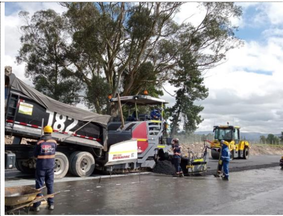
K4+120 – K4+280 instalación y compactación de BTA (19/07/22)
