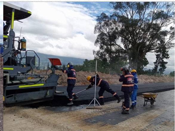
K4+120 - K4+280 INSTALACIÓN DE BTA
