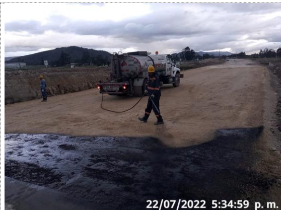
K4+080 – K4+130 instalación de emulsión asfáltica (22/07/22)
