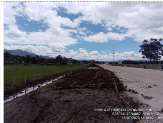
K6+100 – K6+280 nivelación de talud para control de desagües (16/07/22)
