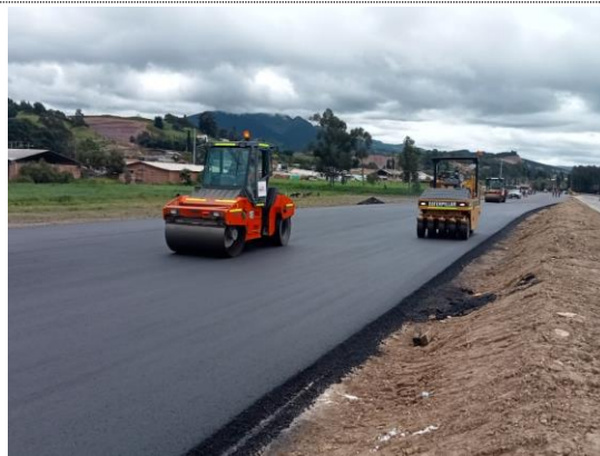
K6+280 – K6+590 instalación y compactación capa de rodadura en MDC-19 (31/07/22)
