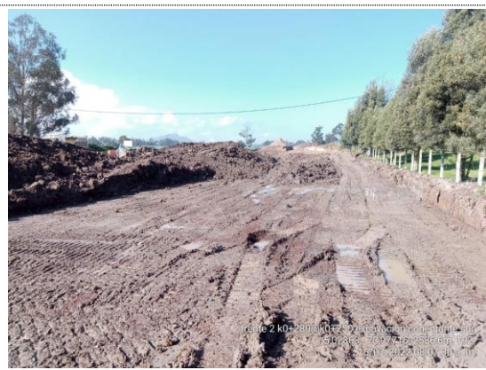
Conectante sur K0+250 – K0+280 excavación para estructura de vía (15/07/22)
