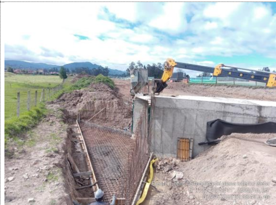
Obra No 15 Pasaganado 3X3 K2+138 fundida de placa inferior encole (07/07/22)
