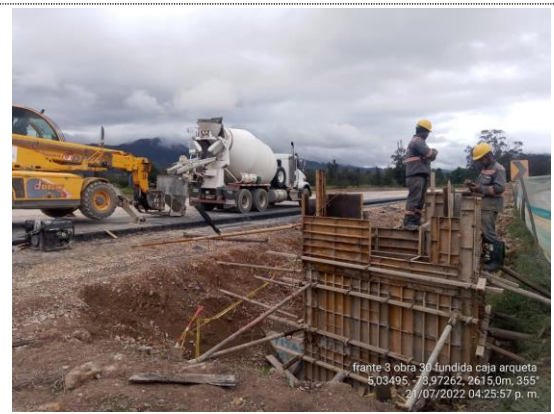
Obra No 30 Box culvert 1x1 K3+892 fundida de caja arqueta (21/07/22)
