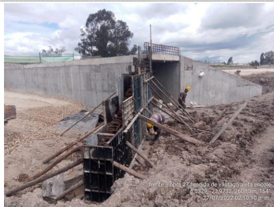
Obra No 27 Pasaganado 3x3 K3+641 armado de acero y encofrado aleta norte de encole (27/07/22)
