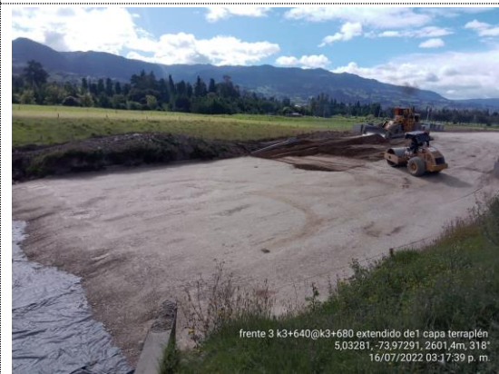
K3+640 – K3+680 instalación 1er capa de terraplén (16/07/22)
