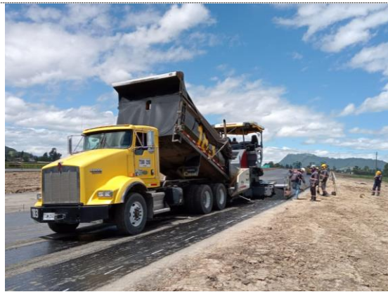
K5+108 – K5+380 instalación 1er capa de MSC-25 e=6cm (08/08/22)
