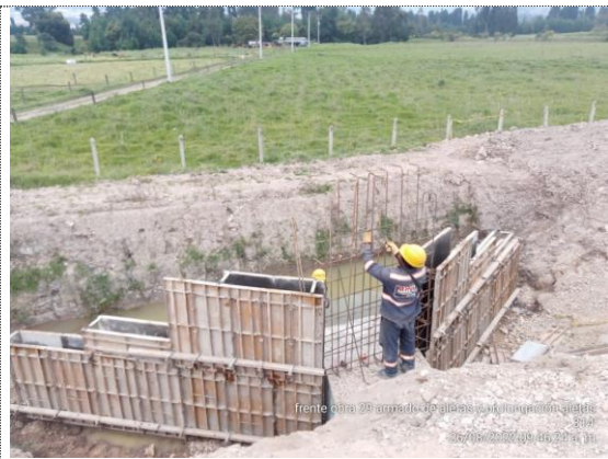
Obra No 29 Box culvert 1x1 K3+829 armado de acero y encofrado realce de aletas y guardarrueda (26/08/22)
