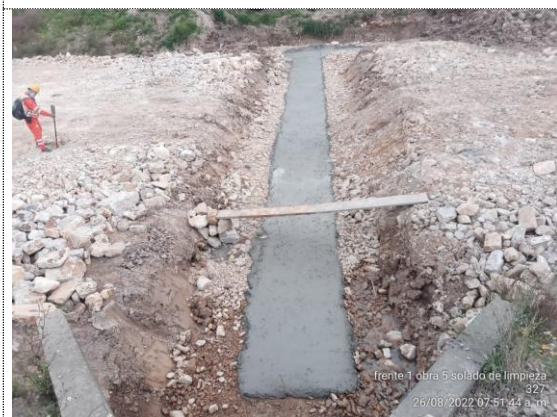
Obra No 5 Box culvert 1X1 K1+028 fundida de solado de limpieza (26/08/22)
