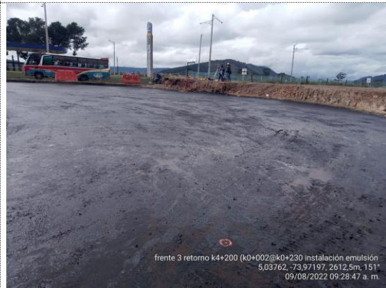
Retorno K4+200 K0+002 – K0+230 instalación de emulsión asfáltica (09/08/22)
