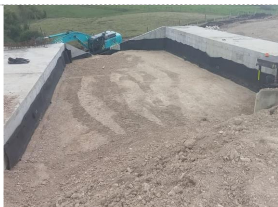
K5+580 – K5+595 instalación terraplén para instalación de geobloques (10/08/22)
