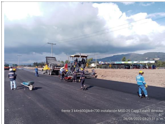
K4+690 – K4+730 instalación 1er capa de MSC-25 e=6cm (26/08/22)
