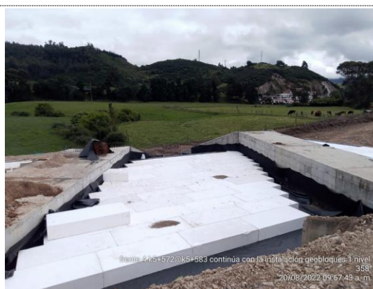
K5+580 – K5+595 instalación de 1er capa de geobloques (20/08/22)
