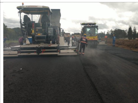
K4+790 – K5+108 instalación de BTA (05/08/22)
