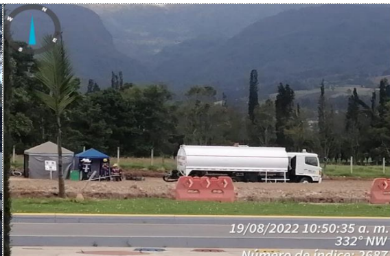
ABASTECIMIENTO DE AGUA PARA USO DE ACTIVIDADES CONSTRUCTIVAS
