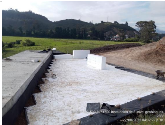
K5+600 – K5+620 inicia instalación 3er capa de geobloques (22/08/22)
