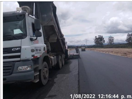
K5+700 – K6+280 instalación de capa de rodadura en MDC-19 (01/08/22)
