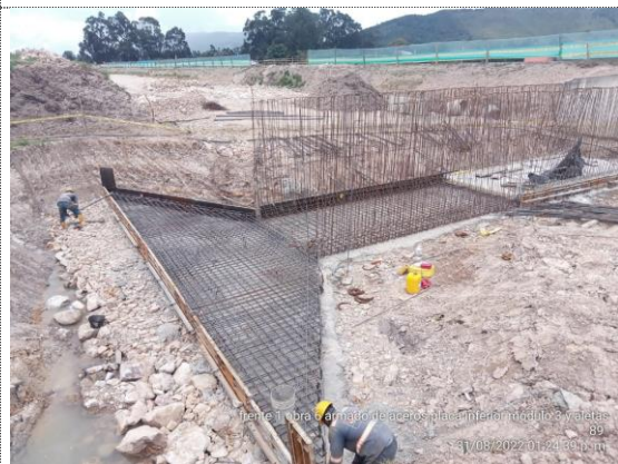
Obra No 6 Pasaganado 3X3 K1+069 armado de acero placa inferior encole y módulo 1 (31/08/22)
