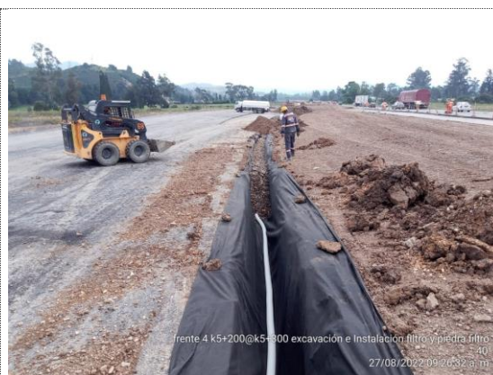
K5+200 – K5+300 instalación de filtro francés (27/08/22)
