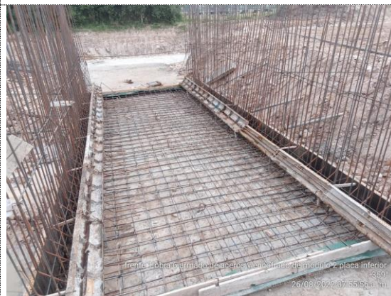
Obra No 6 Pasaganado 3X3 K1+069 armado de acero y encofrado placa inferior módulo 2 (26/08/22)
