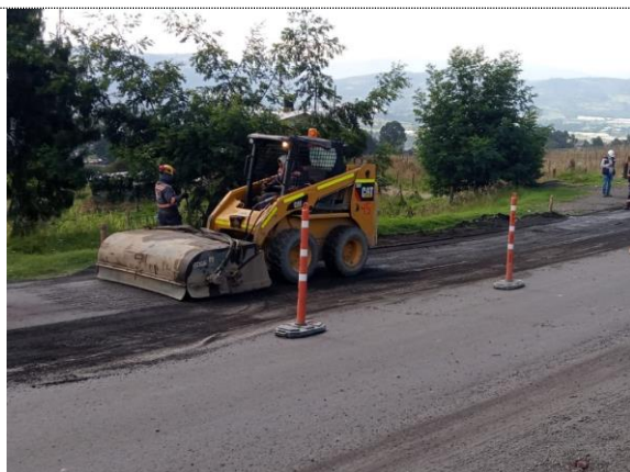
PR44+0300 limpieza de la caja de margen derecha (24/08/22)
