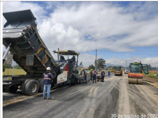
K3+440 – K3+560 instalación y compactación de BTA (30/08/22)
