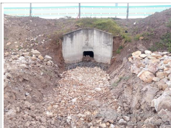
Obra No 5 Box culvert 1X1 K1+028 instalación de pedraplén (23/08/22)
