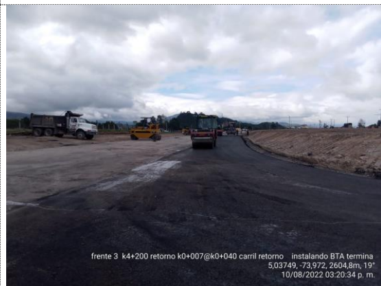
Retorno K4+200 K0+007 – K0+180 instalación de BTA (10/08/22)
