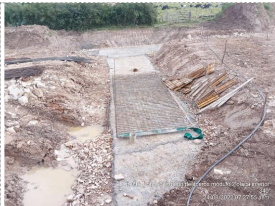
Obra No 6 Pasaganado 3X3 K1+069 armado de acero y encofrado placa inferior módulo 2 (24/08/22)
