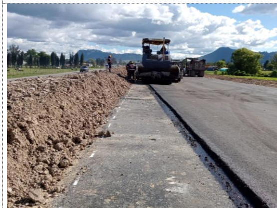
Retorno K5+300: instalación de 1er capa de MSC-25 (08/08/22)
