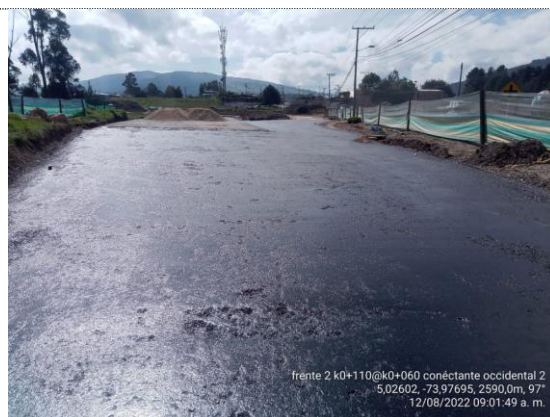
Conectante occidental K0+060 – K0+110 instalación de emulsión asfáltica (12/08/22)
