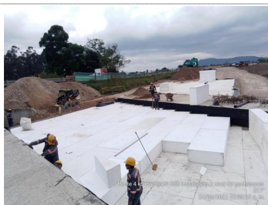
K5+580 – K5+595 inicia instalación de 2da capa de geobloques (24/08/22)
