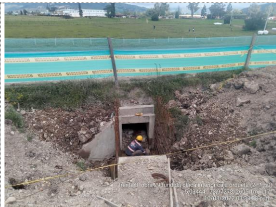
Obra No 29 Box culvert 1x1 K3+829 armado de acero y encofrado placa inferior caja arqueta (10/08/22)
