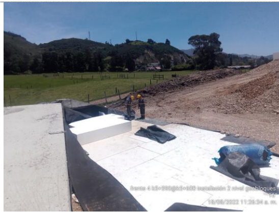
K5+600 – K5+620 inicia instalación 2da capa de geobloques (18/08/22)
