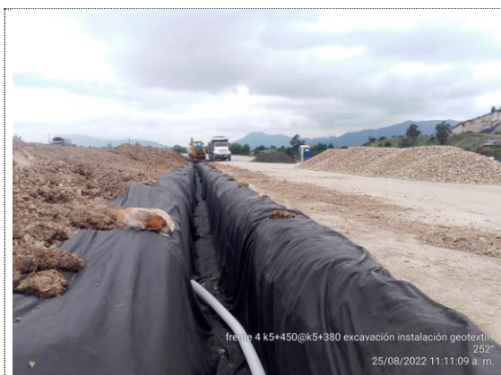
K5+380 – K5+450 Instalación de filtro francés (25/08/22)
