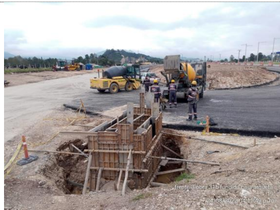
Obra No 31 Box culvert 1x1 K4+075 fundida de caja 31b (24/08/22)
