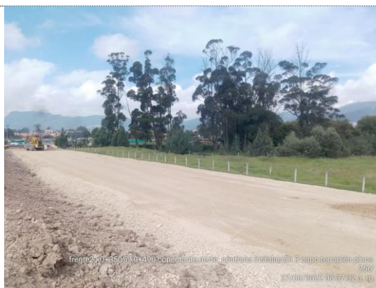
Conectante norte K0+350 – K0+490 instalación 3er capa de terraplen (29/08/22)
