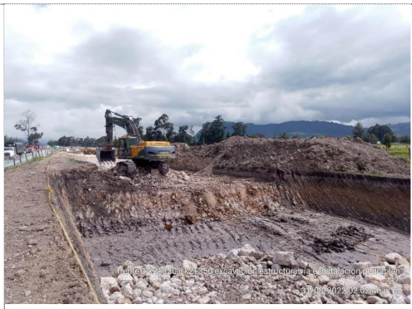
K2+320 - K2+350 EXCAVACIÓN PARA ESTRUCTURA DE VÍA
