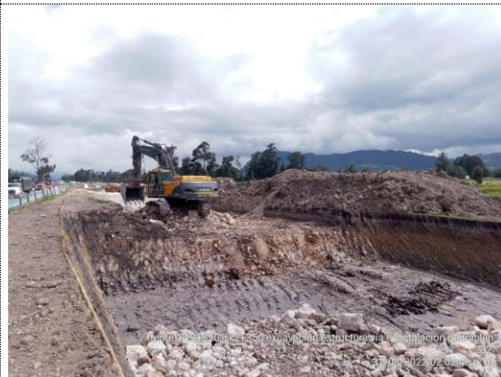
K2+300 – K2+320 excavación para estructura de vía (31/08/22)
