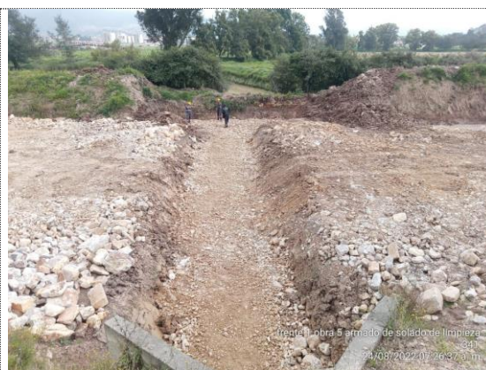
Obra No 5 Box culvert 1X1 K1+028 adecuación de terreno para fundir solado de limpieza (26/08/22)
