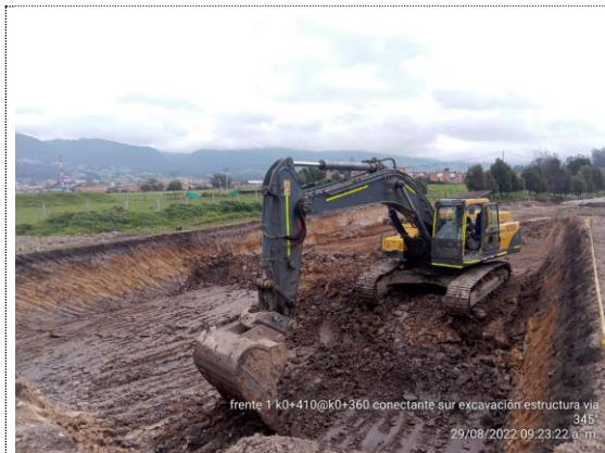
Conectante sur K0+360 – K0+410 excavación para estructura de vía (29/08/22)
