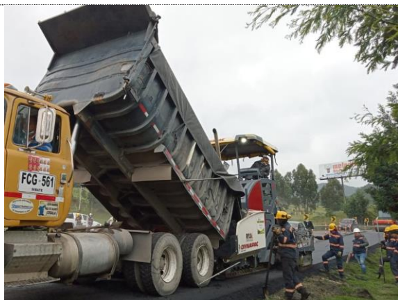
PR44+0300 instalación MDC-19 (24/08/22)
