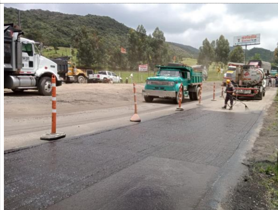
PR44+0300 riego de imprimación costado derecho (24/08/22)
