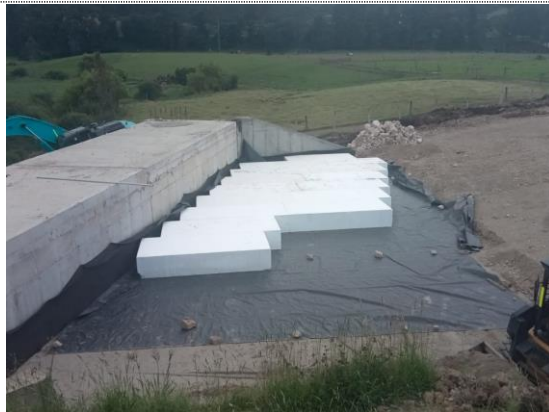
K5+600 – K5+620 instalación 1er capa de geobloques (10/08/22)
