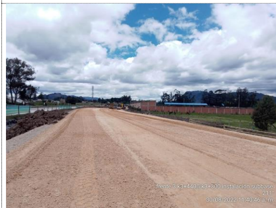
K3+300 – K3+440 instalación de subbase granular (30/08/22)
