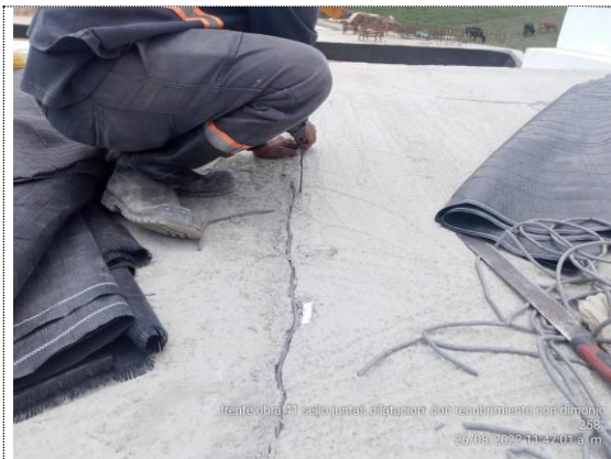
Obra No 41 Box culvert 4x4 K5+577 sello de juntas de dilatación (26/08/22)
