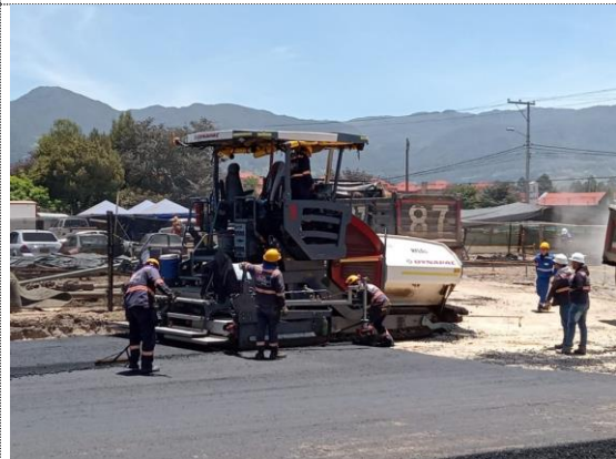
Conectante sur K0+020 – K0+100 instalación de BTA (18/08/22)
