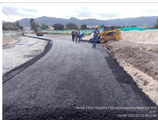
Conectante occidental K0+144 – K0+166 desvío instalación de BTA (16/08/22)
