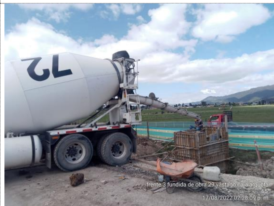
Obra No 29 Box culvert 1x1 K3+829 fundida de caja arqueta (17/08/22)
