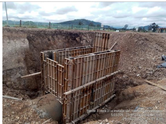
Obra No 31 Box culvert 1x1 K4+075 armado de acero y encofrado caja intermedia 31a (09/08/22)
