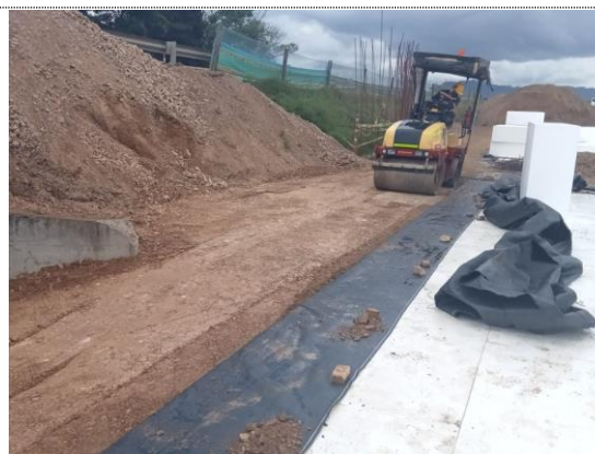
K5+580 – K5+595 compactación de terraplén por el costado de geobloques (31/08/22)
