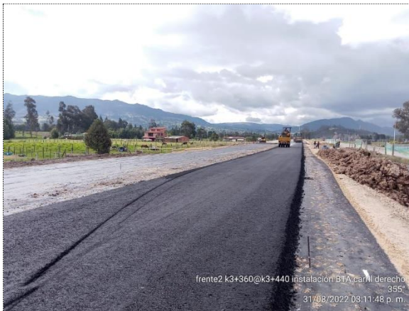
K3+360 - K3+440 INSTALACIÓN Y COMPACTACIÓN DE BTA
