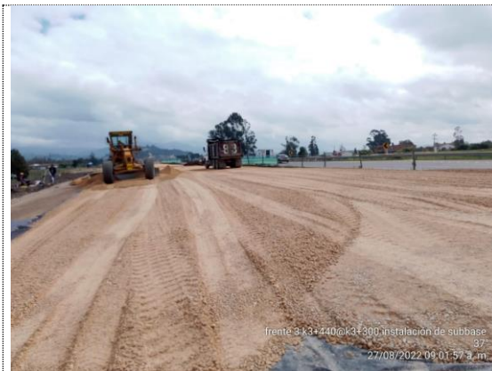
K3+300 – K3+440 instalación de geotextil y subbase granular (27/08/22)
