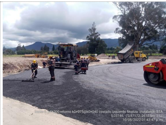
Retorno K4+200 K0+007 – K0+180 instalación de BTA (10/08/22)
