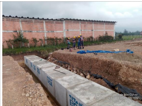
Obra No 23 Box culvert 1x1 K3+280 instalación de módulos prefabricados de box culvert (09/08/22)
