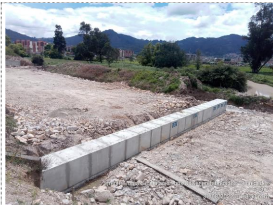
Obra No 5 Box culvert 1X1 K1+028 instalación de módulos prefabricados de box culvert (31/08/22)
