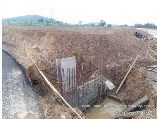
Obra No 31 Box culvert 1x1 K4+075 armado de acero caja 31b (24/08/22)
