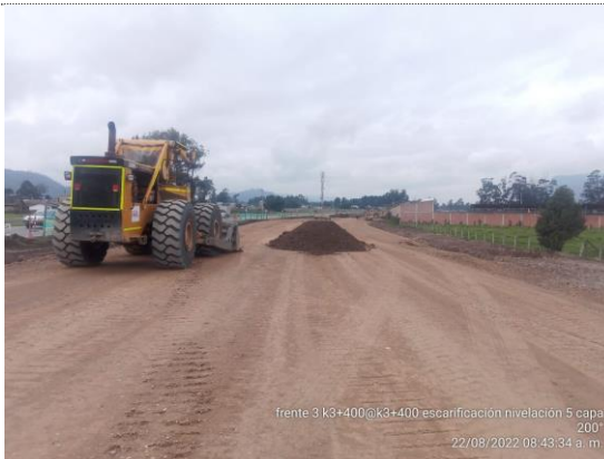
K3+300 – K3+400 nivelación 5ta capa de terraplén (22/08/22)
