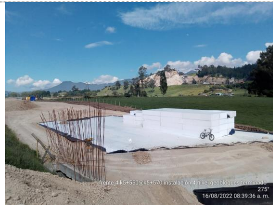
K5+550 – K5+575 instalación 4ta capa de geobloques (16/08/22)
