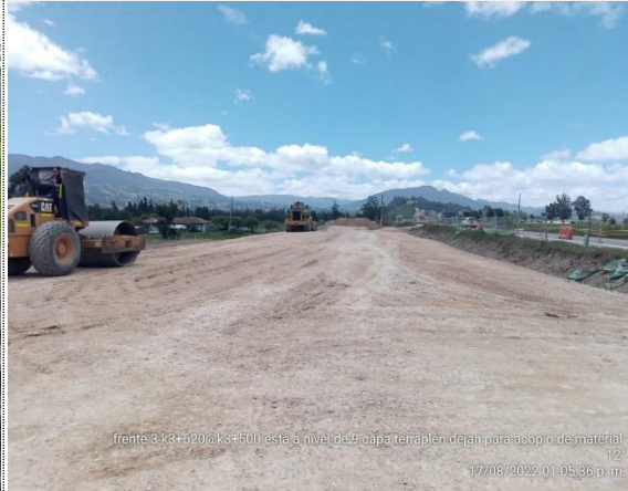
K3+500 - K3+620 SE ENCUENTRA EN UNA CAPA DE TERRAPLÉN
