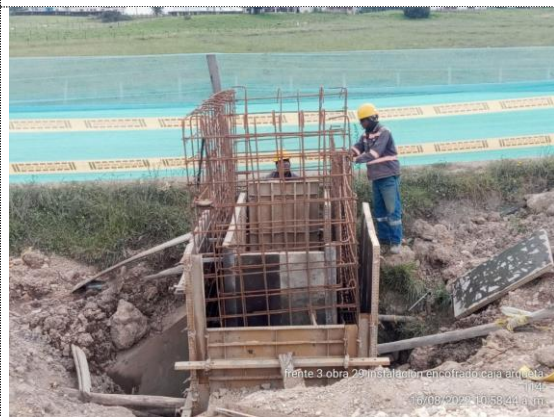
Obra No 29 Box culvert 1x1 K3+829 armado de acero y encofrado caja arqueta (16/08/22)
