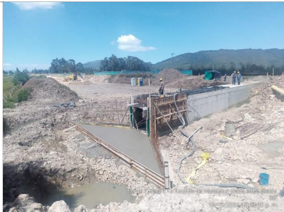
OBRA NO 4 FUNDIDA DE PLACA INFERIOR ENCOLE
