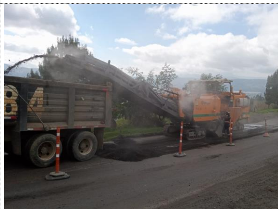
PR44+0300 fresado de carpeta asfáltica margen derecha (24/08/22)
