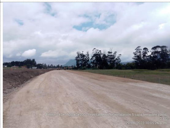
Conectante norte K0+200 – K0+350 instalación 5ta capa de terraplén (29/08/22)
