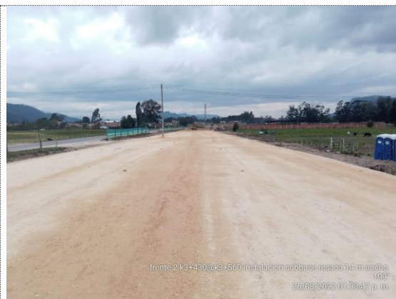
K3+440 – K3+560 instalación de subbase granular (25/08/22)
