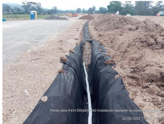
K5+350 – K5+460 instalación de filtro francés (26-08-22)
