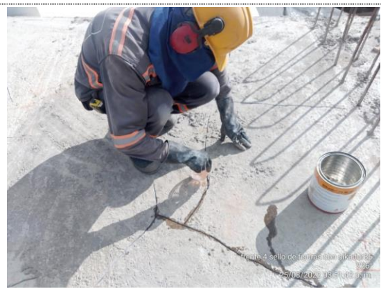
Obra No 42 Pasaganado 3X3 K5+595 sello de fisuras placa superior (25/08/22)
