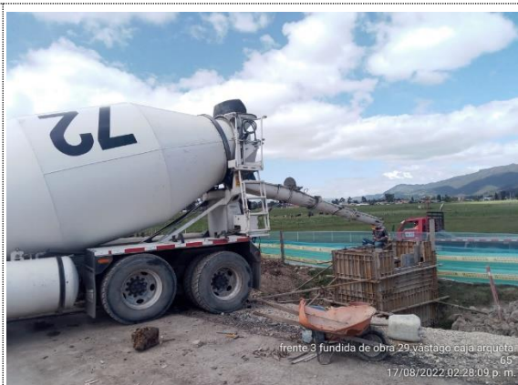
OBRA NO 29 FUNDIDA DE CAJA ARQUETA
