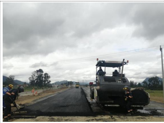
K3700 – K3+820 instalación y compactación de BTA (02/08/22)
