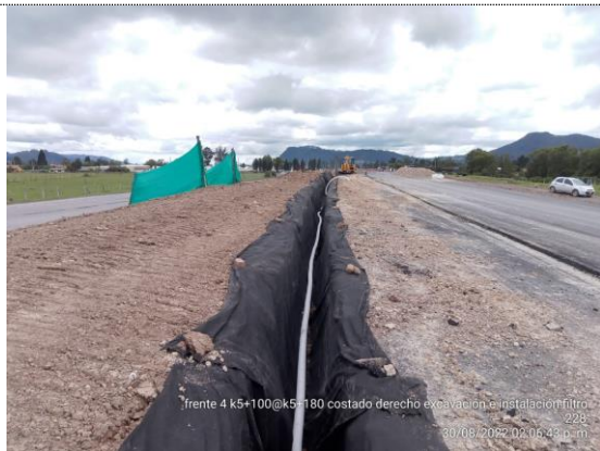
K5+100 – K5+180 instalación de filtro francés costado derecho (30/08/22)
