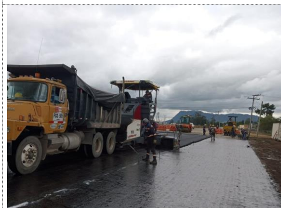
K4+790 – K5+108 instalación de BTA (05/08/22)
