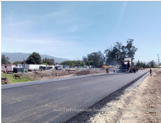
Conectante sur K0+020 – K0+100 instalación de BTA (18/08/22)
