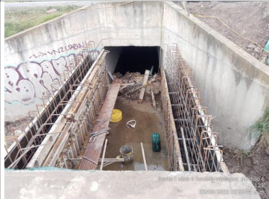
Obra No 4 Box culvert 2X2 K0+956 fundida de vástagos módulo 6 (22/08/22)
