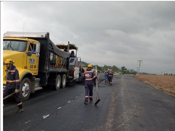
K4+270 - K4+600 INSTALACIÓN 2DA CAPA DE MSC-25 E=5CM
