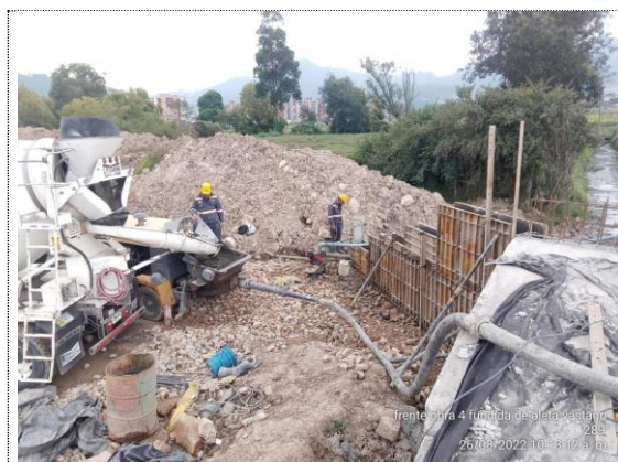
Obra No 4 Box culvert 2X2 K0+956 fundida de aletas de encofe (26/08/22)
