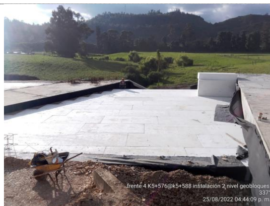
K5+580 – K5+595 termina instalación de 2da capa de geobloques (25/08/22)
