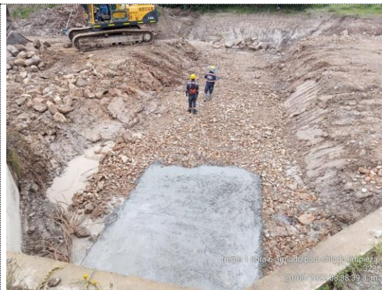
Obra No 6 Pasaganado 3X3 K1+069 fundida de solado de limpieza (20/08/22)
