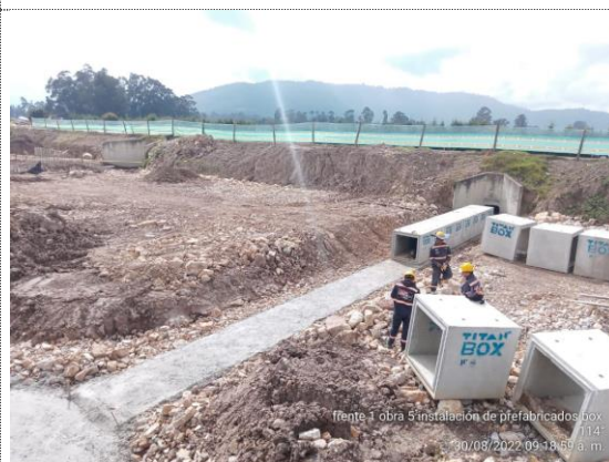
Obra No 5 Box culvert 1X1 K1+028 instalación de módulos prefabricados de box culvert (30/08/22)
