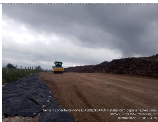
Conectante norte K0+380 – K0+460 instalación 1er capa de terraplen (09/08/22)
