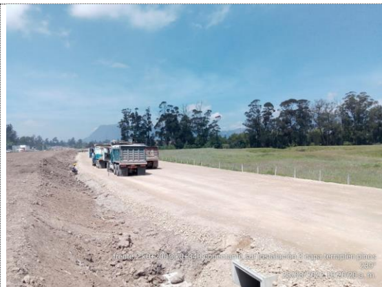
Conectante sur K0+200 – K0+340 instalación 3er capa de terraplén (23/08/22)
