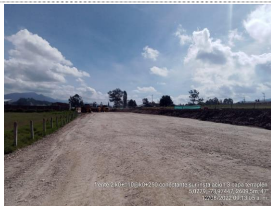
Conectante norte K0+110 – K0+250 instalación 3er capa de terraplén (12/08/22)
