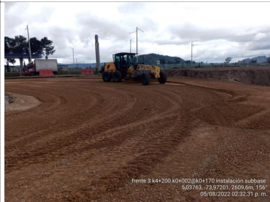
Retorno K4+200 K0+002 – K0+170 instalación de subbase granular (05/08/22)
