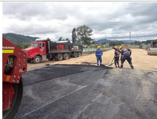
K3+440 – K3+560 instalación y compactación de BTA (30/08/22)
