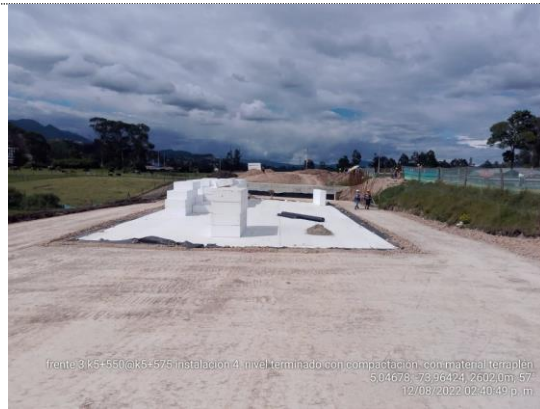
K5+550 – K5+575 instalación de capa de terraplén por los costados de 4ta capa de geobloques (12/08/22)
