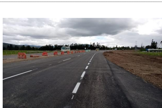
K5+700 – K6+280 demarcación horizontal línea de borde y eje blanca (03/08/22)
