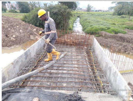
Obra No 4 Box culvert 2X2 K0+956 fundida de placa superior módulo 1 (22/08/22)
