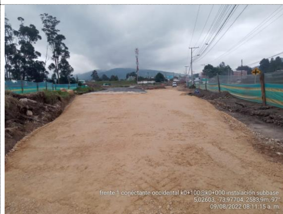
Conectante occidental K0+060 – K0+110 instalación de subbase granular (09/08/22)
