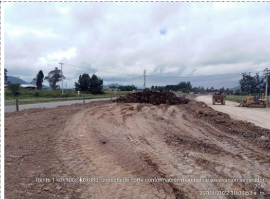
Conectante norte K0+080 – K0+100 conformación de separador con material de excavación (29/08/22)
