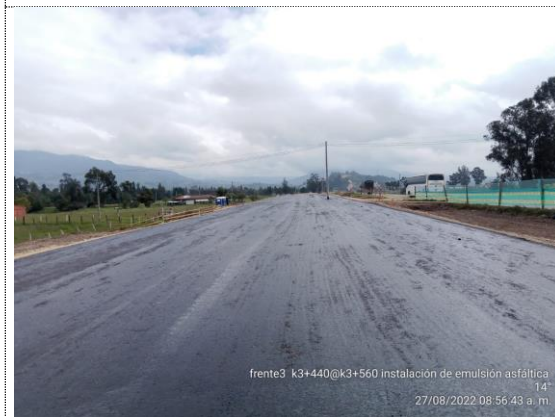
K3+440 – K3+560 instalación de emulsión asfáltica - imprimación (27/08/22)
