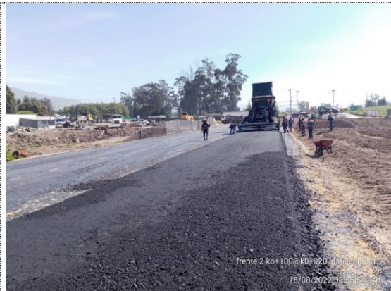
Conectante sur K0+020 – K0+100 instalación de BTA (18/08/22)
