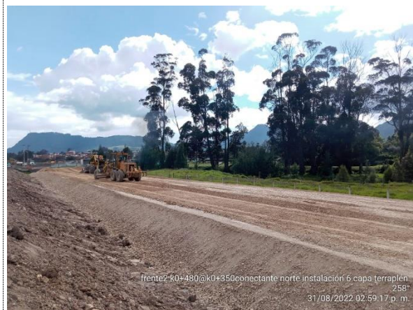
CONECTANTE NORTE K0+350 - K0+480 INSTALACIÓN 6TA CAPA DE TERRAPLÉN
