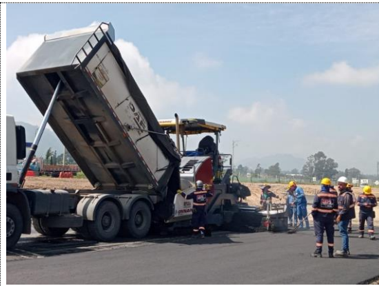
K4+460 – K4+600 sobreancho instalación de 1er capa de MSC-25 e=6cm (23/08/22)
