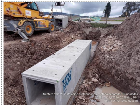
Obra No 21 Box culvert 1x1 K3+135 instalación de módulos prefabricados de box culvert (05/08/22)
