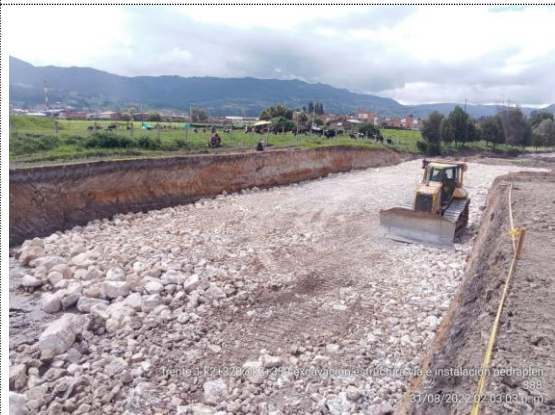
K2+320 – K2+350 instalación de pedraplén (31/08/22)
