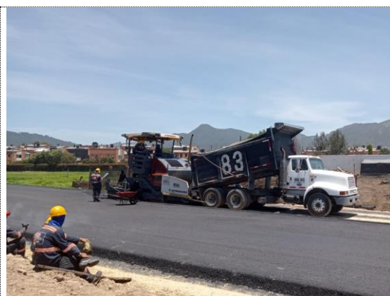
Conectante sur K0+020 – K0+100 instalación de BTA (18/08/22)
