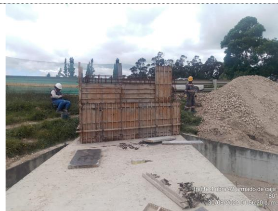
Obra No 42 Pasaganado 3X3 K5+595 armado de acero y encofrado caja de ventilación (30/08/22)
