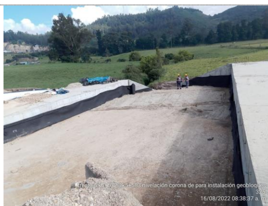
K5+580 – K5+595 Nivelación corona de terraplén para instalación de geobloques (16/08/22)
