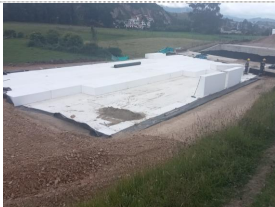
K5+550 – K5+575 instalación 4ta capa de geobloques (10/08/22)
