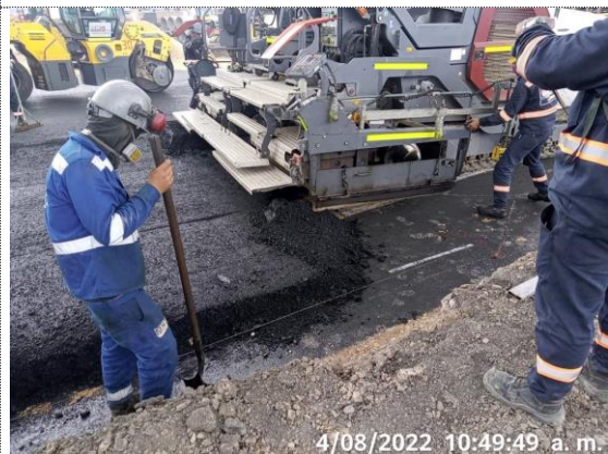
Glorieta K0+210 – K0+260 instalación de BTA (04/08/22)
