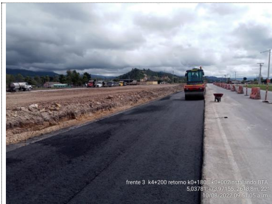
Retorno K4+200 K0+007 – K0+180 instalación de BTA (10/08/22)
