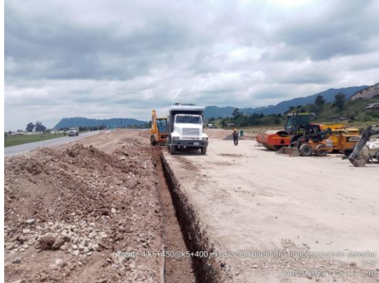
K5+400 – K5+450 excavación para filtro francés costado derecho (24/08/22)
