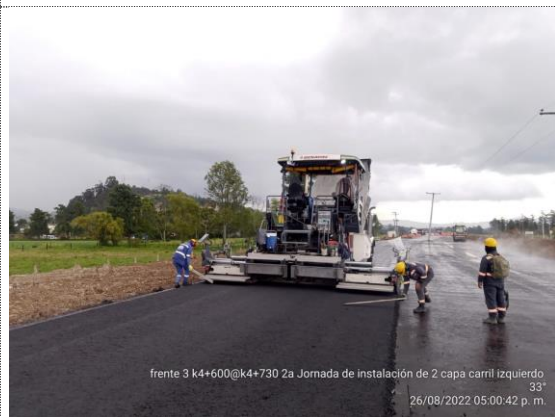
K4+690 – K4+730 instalación 2da capa de MSC-25 e=5cm (26/08/22)
