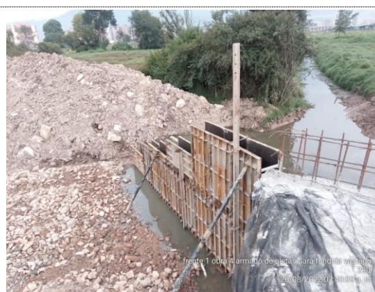
Obra No 4 Box culvert 2X2 K0+956 armado de acero y encofrado aletas de encofe (26/08/22)
