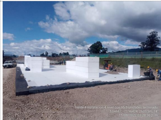
K5+550 – K5+575 termina instalación 4ta capa de geobloques
