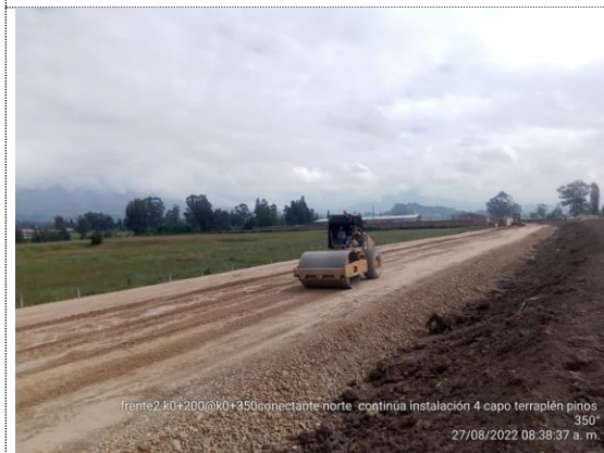
Conectante norte K0+200 – K0+350 instalación 4ta capa de terraplén (27/08/22)
