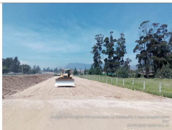
Conectante norte K0+350 – K0+490 instalación 2da capa de terraplen (23/08/22)
