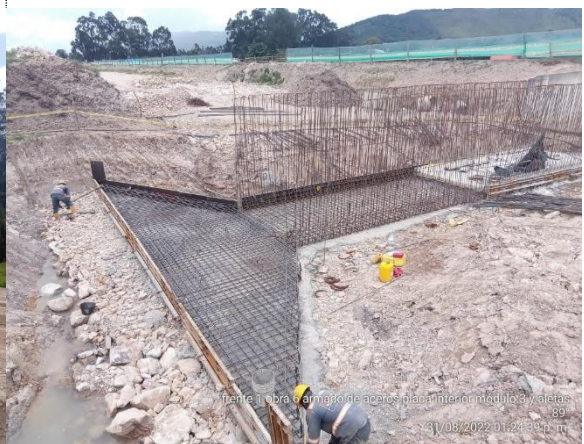
OBRA NO 6 ARMADO DE ACERO PLACA INFERIOR ENCOLE Y MÓDULO 1
