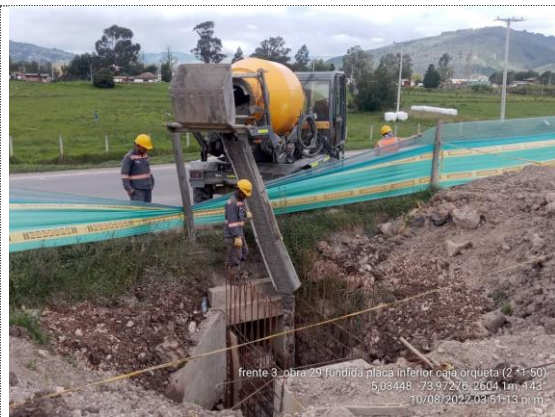
Obra No 29 Box culvert 1x1 K3+829 fundida placa inferior caja arqueta (10/08/22)
