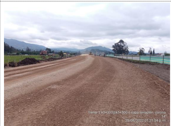
K3+300 – K3+430 instalación 6ta capa de terraplén (corona) (25/08/22)
