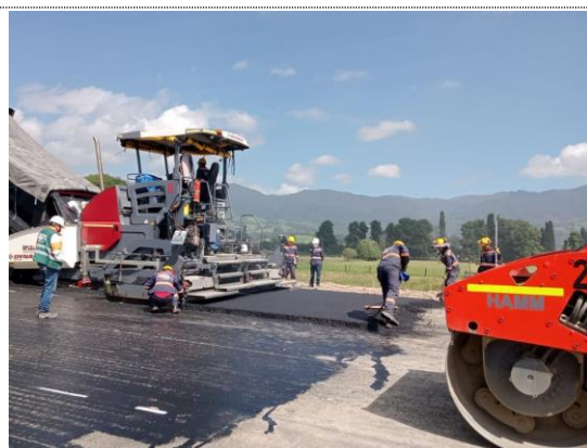
K5+230 – K5+540 instalación 1er capa de MSC-25 (19/08/22)
