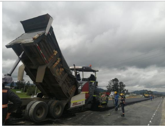
K3700 – K3+820 instalación y compactación de BTA (02/08/22)
