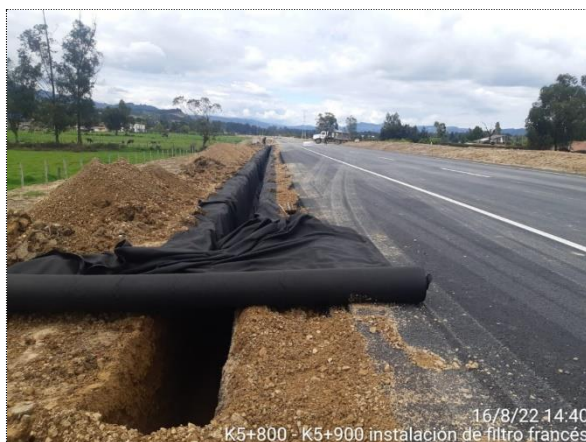
K5+800 - K5+900 INSTALACIÓN DE FILTRO FRANCÉS
