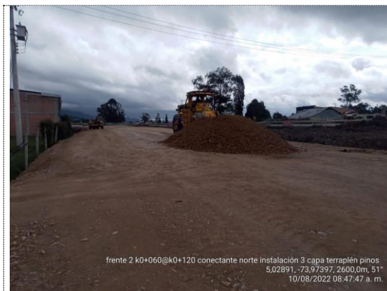
Conectante norte K0+060 – K0+120 instalación 3er capa de terraplén (10/08/22)
