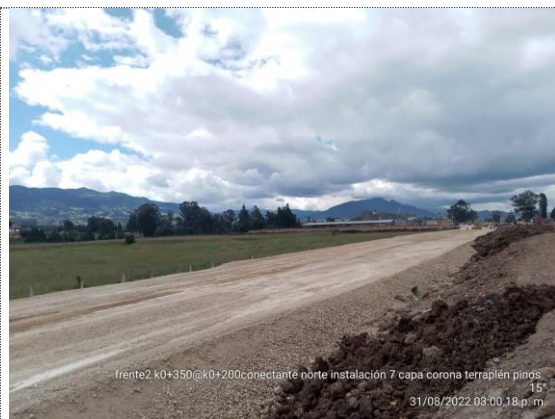
Conectante norte K0+200 – K0+350 instalación 7ma capa de terraplén (corona) (31/08/22)
