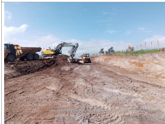
Conectante sur K0+360 – K0+410 excavación para estructura de vía (26/08/22)
