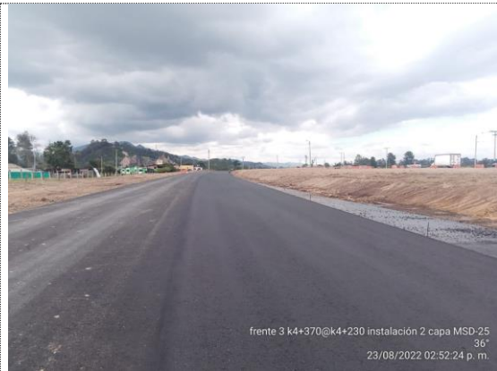
K4+230 – K4+270 instalación de dos capas de MSC-25 espesor total e=11cm (23/08/22)
