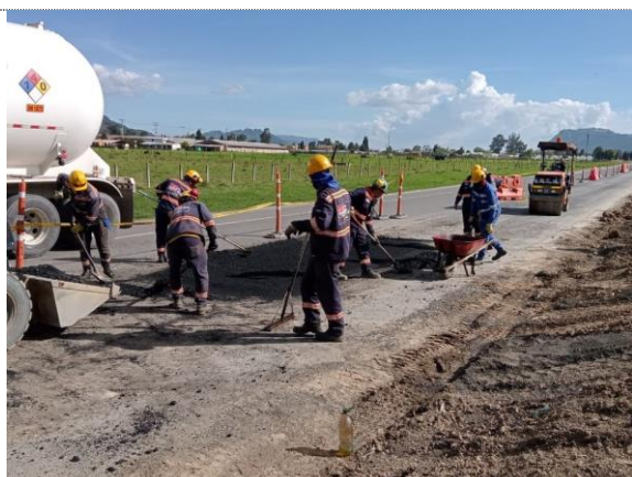
K5+290 instalación de BTA (18/08/22)
