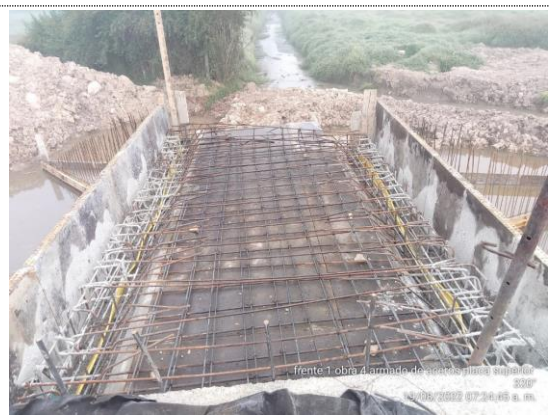
Obra No 4 Box culvert 2X2 K0+956 armado de acero y encofrado placa superior módulo 1 (19/08/22)
