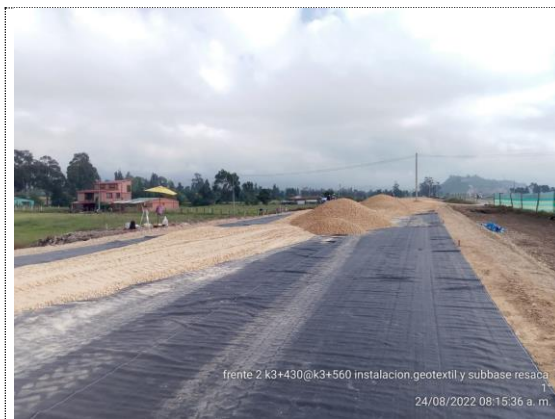
K3+440 – K3+560 instalación de geotextil y subbase granular (25/08/22)
