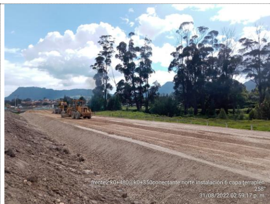
Conectante norte K0+350 – K0+480 instalación 6ta capa de terraplén (31/08/22)
