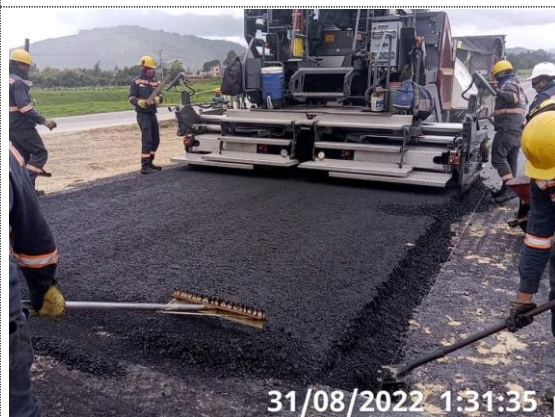
K3+360 – K3+440 instalación y compactación de BTA (31/08/22)
