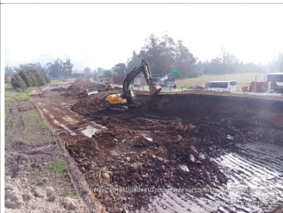
Conectante sur K0+360 – K0+410 excavación para estructura de vía (27/08/22)
