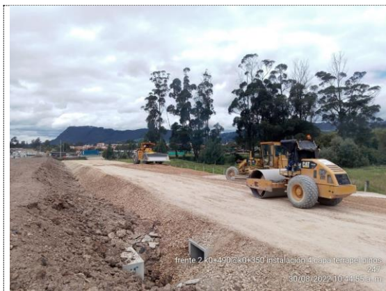
Conectante norte K0+350 – K0+490 instalación 4ta capa de terraplén (30/08/22)
