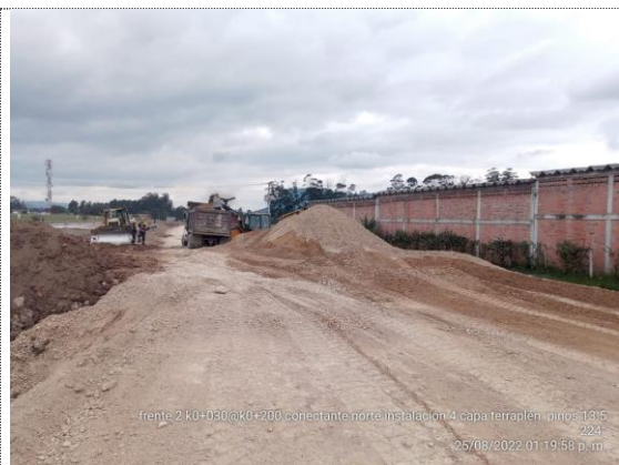
Conectante norte K0+030 – K0+200 instalación 4ta capa de terraplén (25/08/22)
