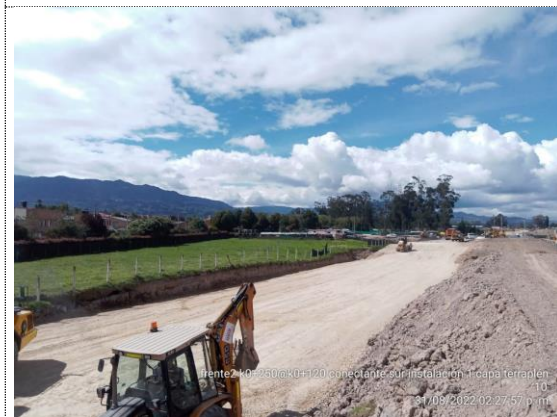
Conectante sur K0+120 – K0+250 instalación 1er capa de terraplén (31/08/22)
