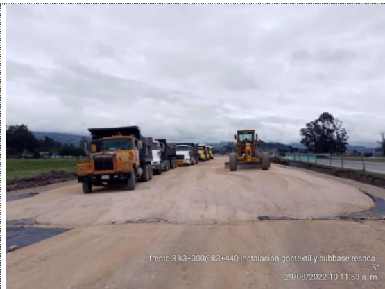
K3+300 – K3+440 instalación de geotextil y subbase granular (29/08/22)
