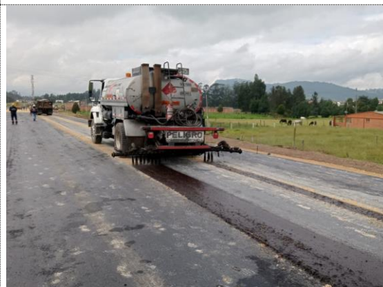
K3+420 – K3+560 instalación de emulsión asfáltica - imprimación (29/08/22)
