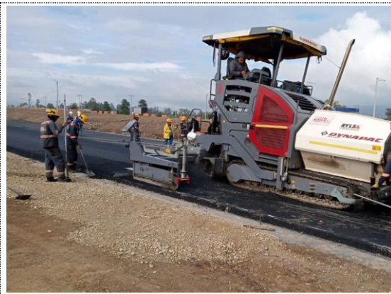
K4+230 – K4+600 instalación 2da capa de MSC-25 e=5cm (22/08/22)
