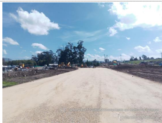
Conectante sur K0+020 – K0+110 nivelación de subbase granular (17/08/22)
