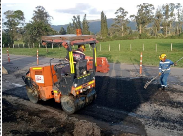
TAPAHUECOS VARIANTE ZIQAQUIRÁ CALZADA EXISTENTE, PARCHE EN EL K5+200
