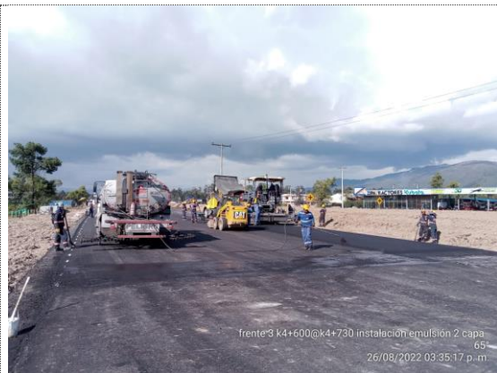
K4+690 – K4+730 instalación riego de liga sobre MSC-25 (26/08/22)
