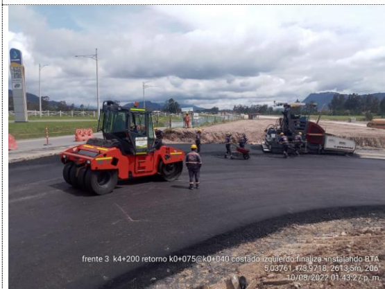
Retorno K4+200 K0+007 – K0+180 instalación de BTA (10/08/22)
