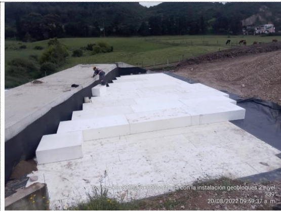
K5+600 – K5+620 instalación de 2da capa de geobloques (20/08/22)
