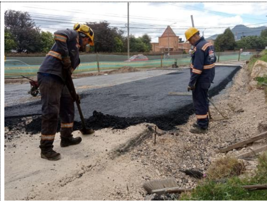
Conectante occidental K0+070 – K0+110 instalación de BTA (16/08/22)
