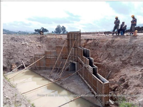
Obra No 29 Box culvert 1x1 K3+829 armado de acero y encofrado realce de aletas y guardarrueda (27/08/22)
