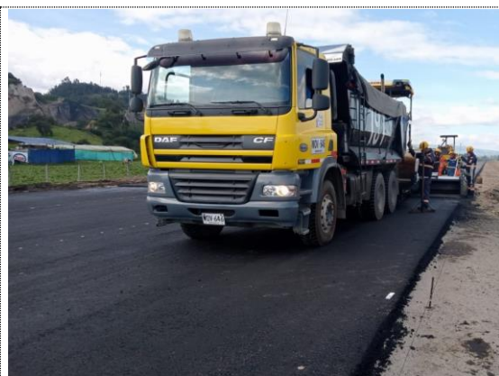
K4+730 – K4+790 instalación 2da capa de MSC-25 e=5cm (25/08/22)
