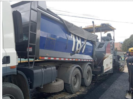
Conectante occidental K0+070 – K0+110 instalación de BTA (16/08/22)
