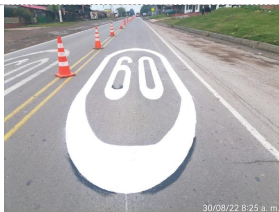
PR31+0700 – PR32+0460 Pictogramas de velocidad máxima permitida (30/08/22)
