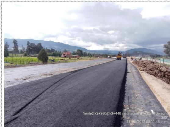
K3+360 – K3+440 instalación y compactación de BTA (31/08/22)
