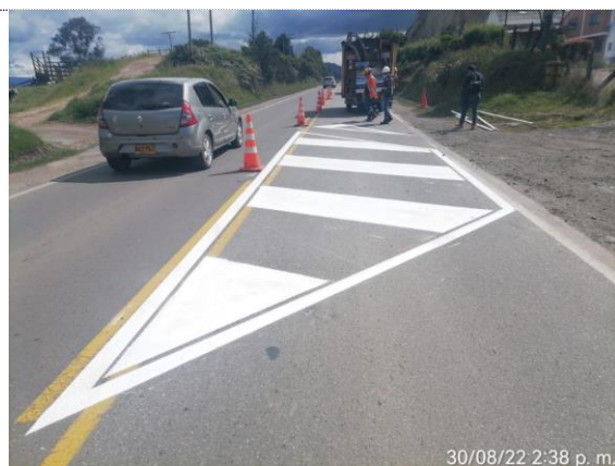
PR31+0700 – PR32+0460 demarcación de isleta (30/08/22)
