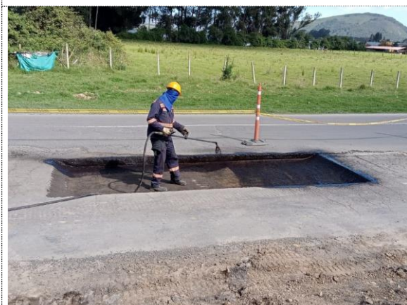
K5+290 instalación de emulsión asfáltica (18/08/22)
