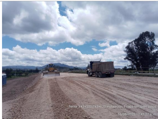
K3+500 – K3+620 instalación 9na capa de terraplén (16/08/22)
