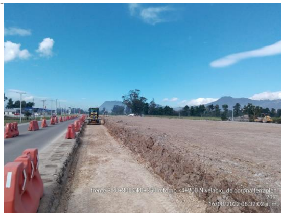
Retorno K4+200 nivelación corona de terraplén (16/08/22)
