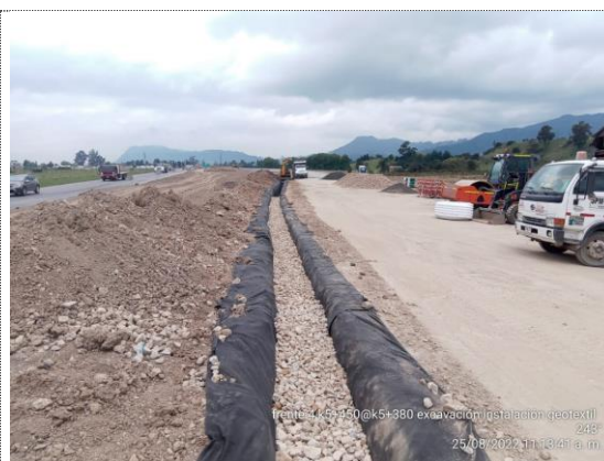
K5+380 – K5+450 Instalación de filtro francés (25/08/22)
