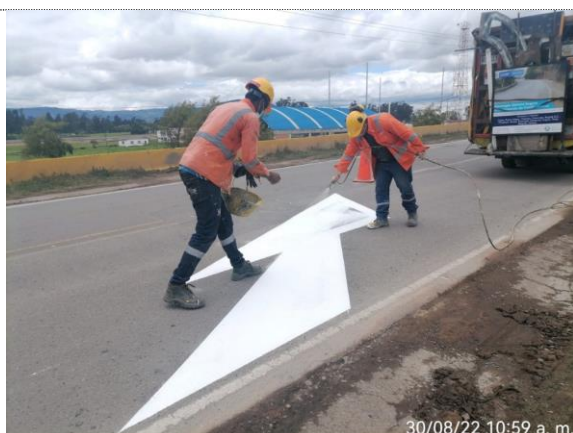
PR31+0700 – PR32+0460 Flecha de reducción de carril (30/08/22)
