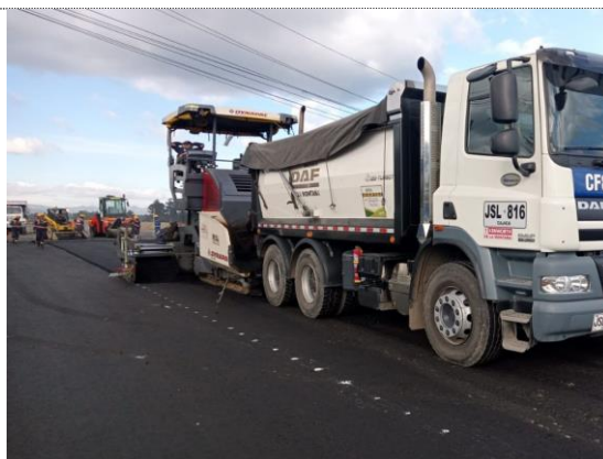
K4+730 – K4+790 instalación 2da capa de MSC-25 e=5cm (25/08/22)
