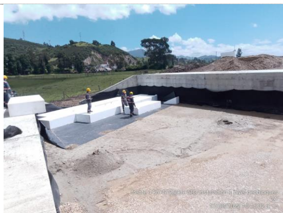
K5+580 – K5+595 inicia instalación de 1er capa de geobloques (17/08/22)
