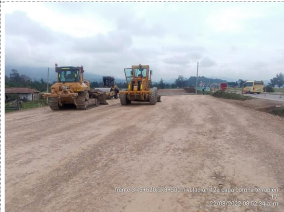
K3+500 – K3+620 nivelación de corona de terraplén (22/08/22)
