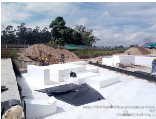
K5+580 – K5+595 inicia instalación de 3er capa de geobloques (27/08/22)
