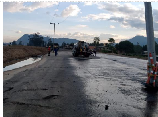
K4+690 – K4+730 instalación de emulsión asfáltica para 1er capa de MSC-25 (25/08/22)
