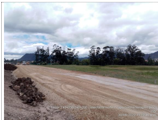
Conectante norte K0+200 – K0+350 instalación 7ma capa de terraplén (30/08/22)
