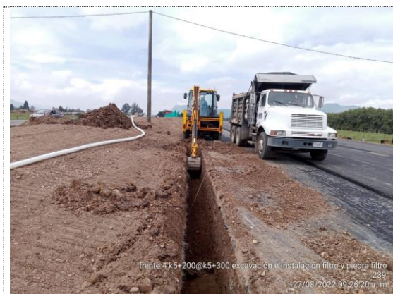
K5+200 – K5+300 excavación para filtro francés (27/08/22)
