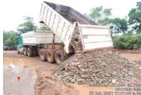
FOTO 2. Descargue de material crudo de rio en el K34+200.
