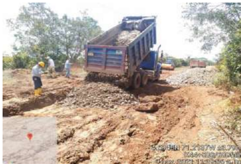
FOTO 5. : Instalación de material crudo de río en el PR44+520
