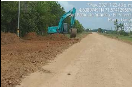
FOTO 3. Descapote en la margen izquierda de la vía sentido del absciso.
