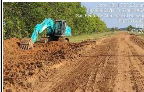
FOTO 4. Por medio de una retro excavadora sobre orugas se hace la actividad de descapote
