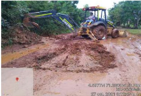
FOTO 1. Limpieza de material saturado en el K37+650
