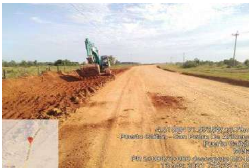
FOTO 5. : Descapote desde el PR2+000 – PR3+000
