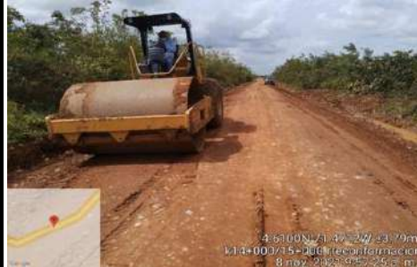
FOTO 2. Vibro compactador en la conformación del PR14+000 hasta el PR 15+000.
