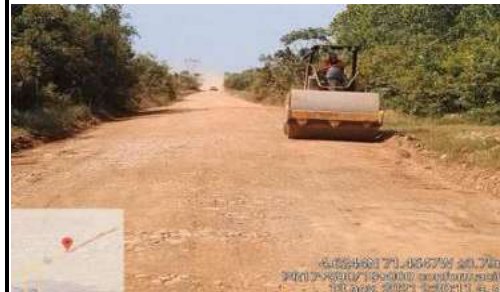
FOTO 4. Conformación de calzada entre el PR17+500 AL PR18+000
