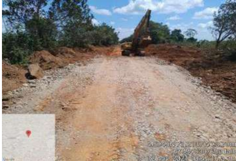
FOTO 1. Conformación y compactación del fallo PR44+530
