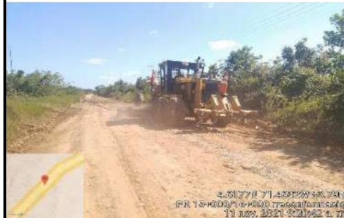
FOTO 2. Reconformación entre el PR15+000 – PR16+000
