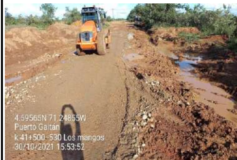
FOTO 4. Conformación del K41+500 hasta el K41+530
