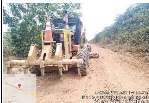
FOTO 6. Conformación de la vía existente desde el PR19+000 – PR 20+000
