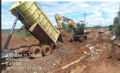
FOTO 5. : Descargue de material en el fallo del K41+530
