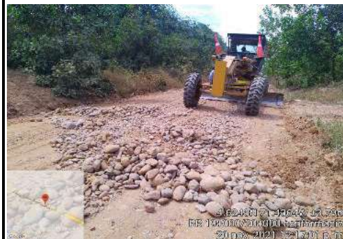
FOTO 4. Conformación de vía PR 19+000
