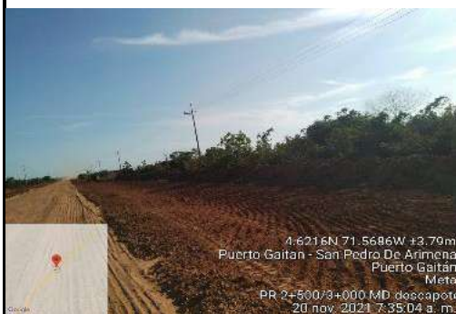
FOTO 5. : Se puede apreciar el descapote que se ha realizado en los primeros 3 Km
