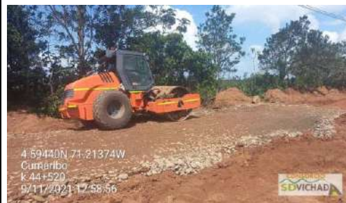
FOTO 6. Compactación del fallo del PR44+520
