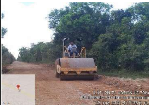
FOTO 3. Compactación de la vía en el PR 19+000
