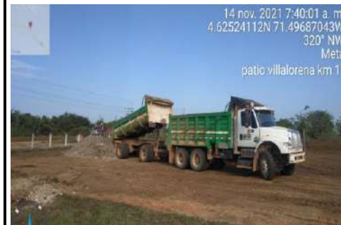
FOTO 6. Acopio de material crudo de río en el PR11+000
