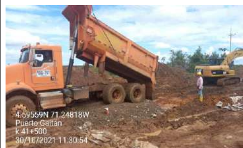
FOTO 6. Descargue de material crudo de rio en el K41+500
