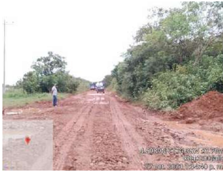
FOTO 3. Se puede verificar la conformación del K34+200
