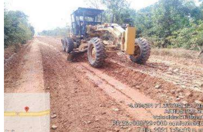
FOTO 4. Podemos apreciar la conformación de la vía PR 26+000 - PR 29+000
