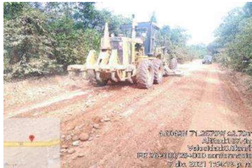
FOTO 3. Podemos apreciar la conformación de la vía PR 26+000 - PR 29+000
