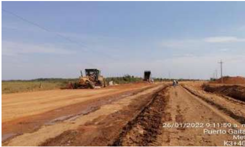
FOTO 6. Humectación del terraplen instalado en el K3+400
