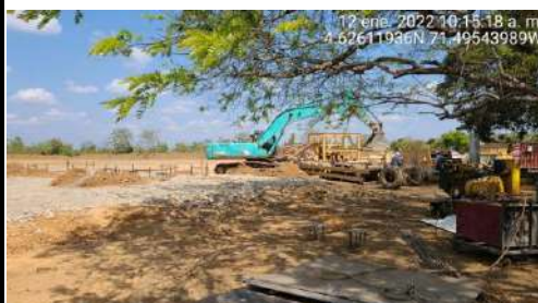
FOTO 2. Visita al campamento para verificación de construcción y armado de estructuras para montajes de plantas.
