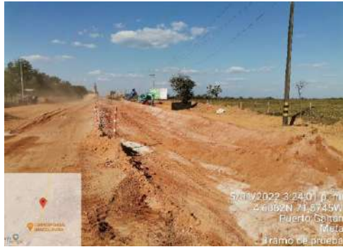
FOTO 1. Inician actividades de obra - estabilización con cal
