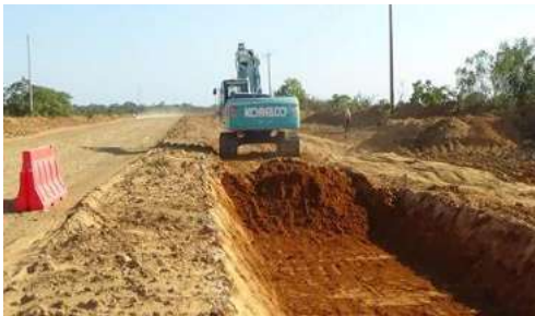
FOTO 4. Construcción del canal margen derecha por medio de retroexcavadora sobre orugas.
