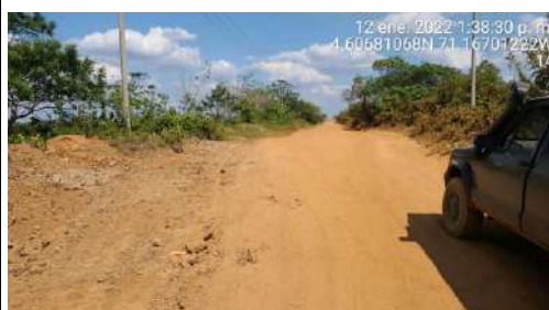
FOTO 6. Recorrido por el sector de los Mangos verificando los tramos críticos a intervenir.
