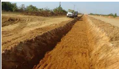
FOTO 3. Construcción del canal margen derecha
