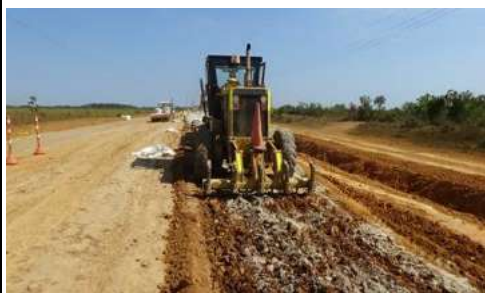
FOTO 5. : Instalación de terraplen con cal
