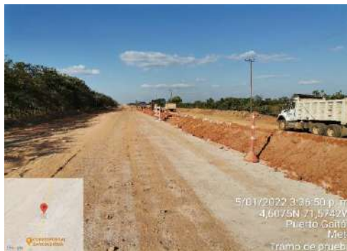
FOTO 3. Panorámica y señalización de la obra
