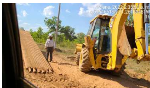
FOTO 3. Retiro de rejillas ubicadas en la vía.
