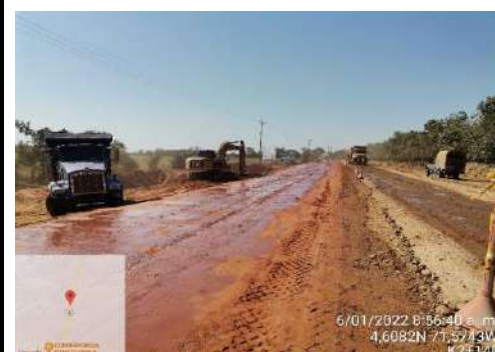
FOTO 6. Humectación y compactación de la capa de terraplen instalada. K2+140
