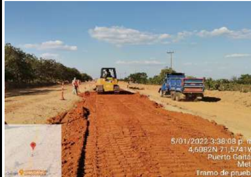
FOTO 2. Mediante uso del material de préstamo de la excavación, se conforma capa de terraplen estabilizado con cal
