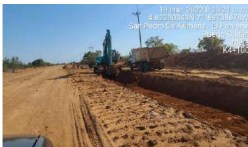
FOTO 5. : Excavación de canal a margen derecha de la vía
