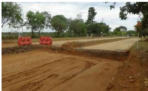
FOTO 3. Excavación e instalación de material de terraplen en el tramo de transición pavimento rígido.
