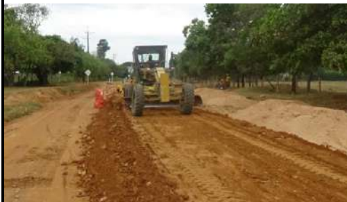
FOTO 4. Instalación material proveniente de préstamo lateral, con cal.
