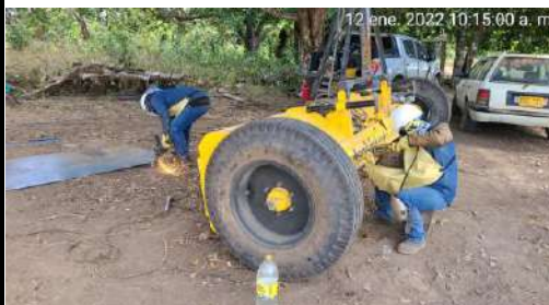
FOTO 4. Inspección de los trabajos en ejecución.
