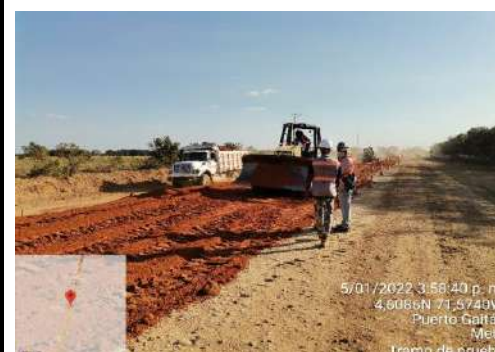
FOTO 4. Inspección de los trabajos en ejecución.
