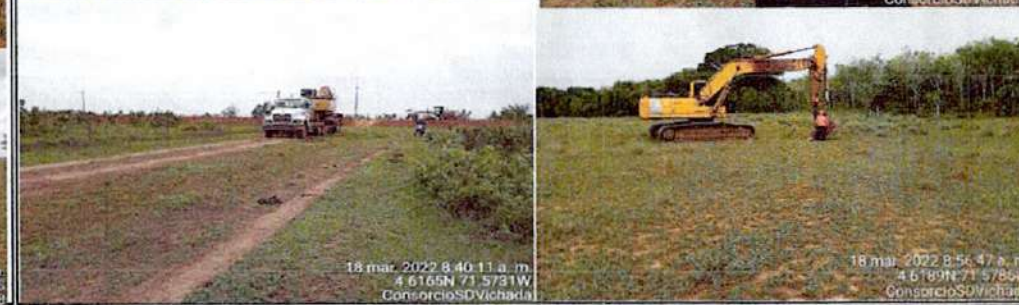
Ingreso de maquinaria para inicio de actividad (reservorio)
