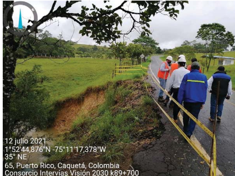
Fotografía 5 PR89+700 Perdida de Banca carril izquierdo Perto Rico- Caqueta Ruta 6503
