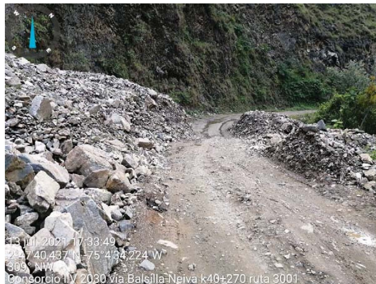
Fotografía 22. PR40+270 Flujo de material talud derecho Ruta 3001
