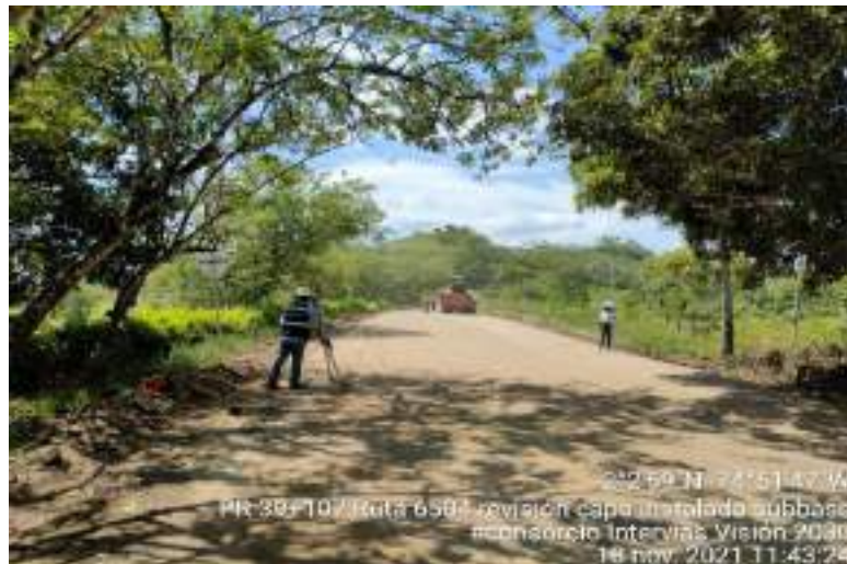
Fotografía 20. PR39+107, Ruta 6504, Nivelación terminado capa Sub Base granular.
