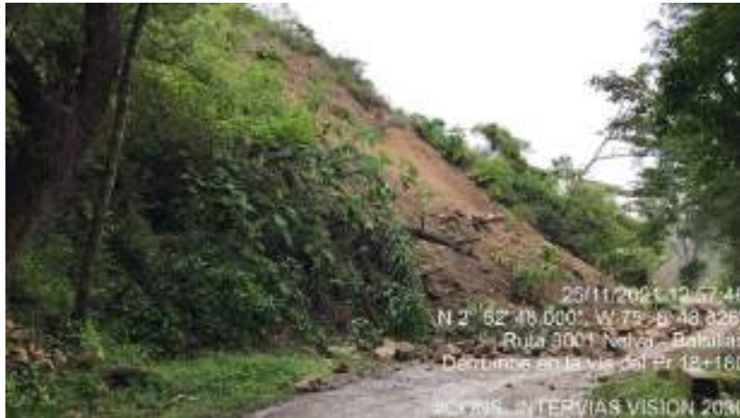
Fotografía 61. PR18+180 ruta 3001 derrumbe y restricción de paso vehicular 25 nov 2021
