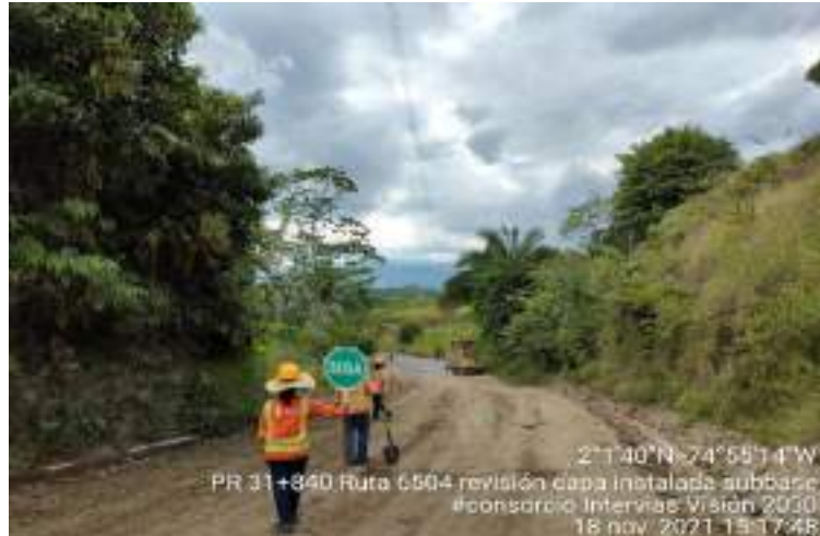
Fotografía 15. PR31+840 Ruta 6504, Instalación Sub Base granular.
