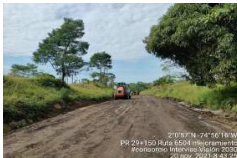
Fotografía 6. PR29+150 Ruta 6504, Conformación Sub Rasante.
