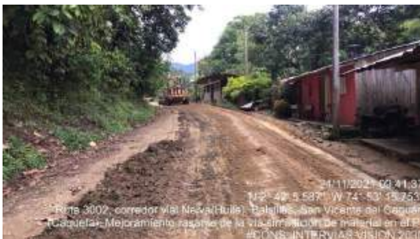
Fotografía 56. Ruta 3002, Mejoramiento rasante de la vía sin adición de material.
