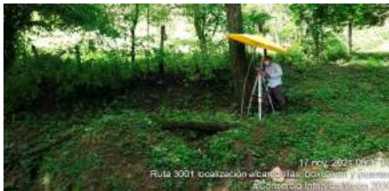
Fotografía 48. Ruta 3001 localización alcantarillas, boxculvert y puentes
