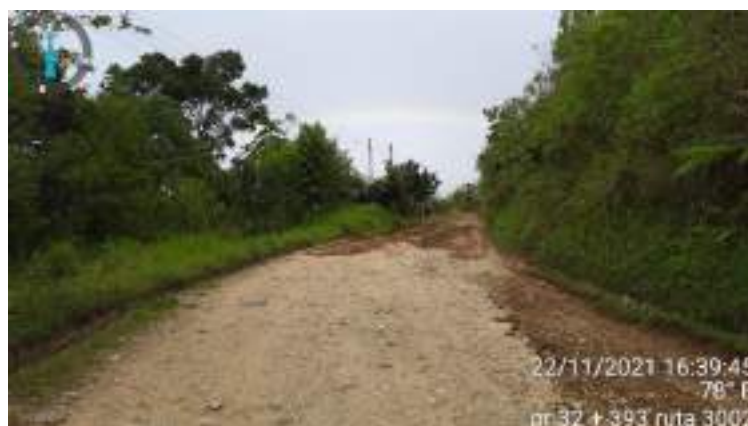
Fotografía 51. Ruta 3002 PR 32+393 mejoramiento de la vía sin adición de material
