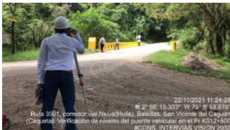
Fotografía 49. PR12+500 Ruta 3001 Verificación de niveles puente vehicular
