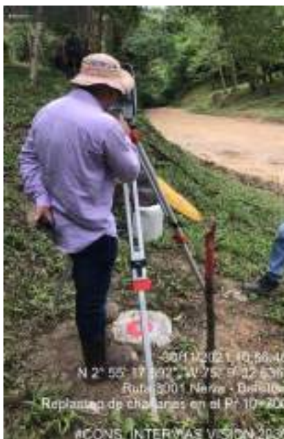
Fotografía 74. PR10+700 ruta 3001 replanteo de la vía con chaflane
