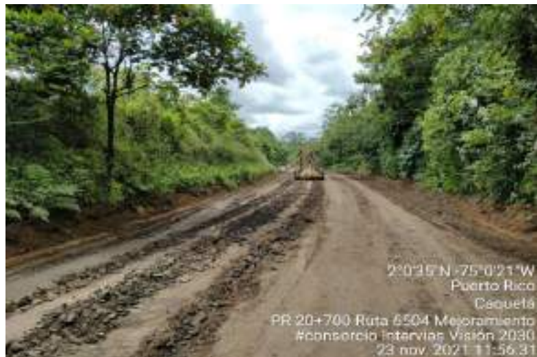
Fotografía 25. PR20+700 Ruta 6504, Escarificación terreno.
