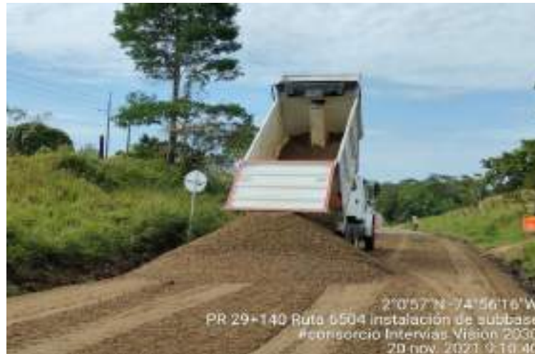
Fotografía 5. PR29+140 Ruta 6504, Instalación SubBase granular.
