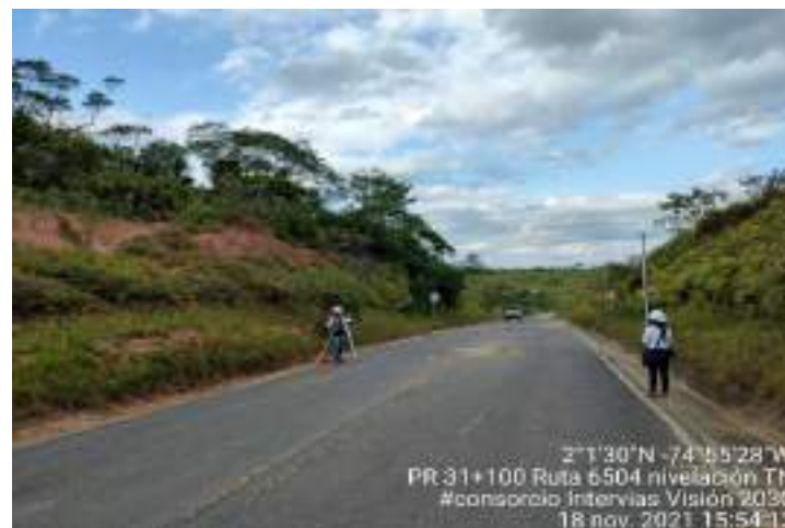
Fotografía 10. PR31+100 Ruta 6504, Nivelación tramos a intervenir.
