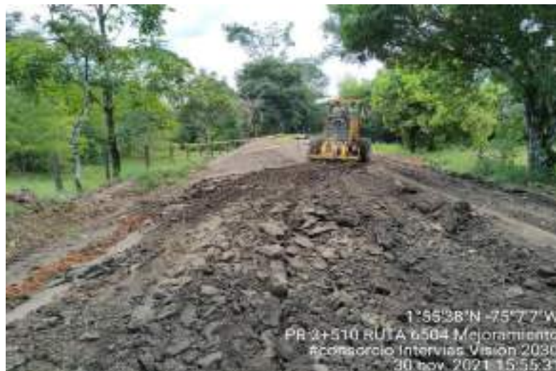
Fotografía 28. PR03+510 Ruta 6504, Escarificación terreno.
