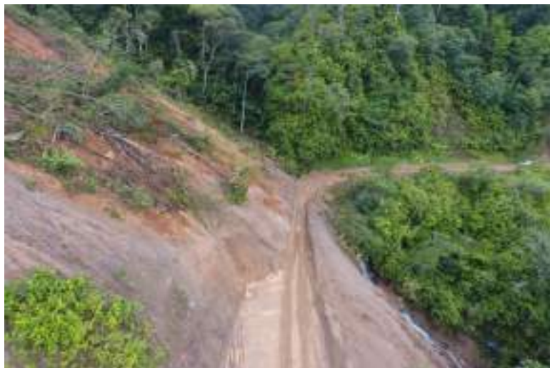
Fotografía 31. PR58+500 Ruta 3002, Remoción de derrumbes.
