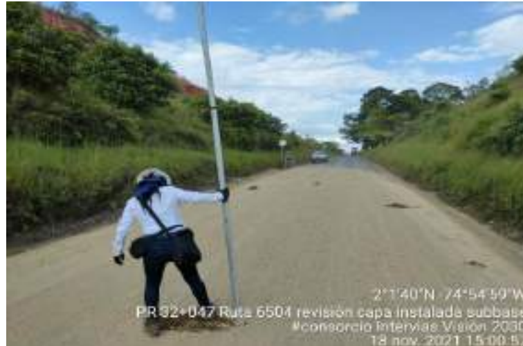
Fotografía 19. PR32+047 Ruta 6504, Nivelación terminado capa Sub Base granular.
