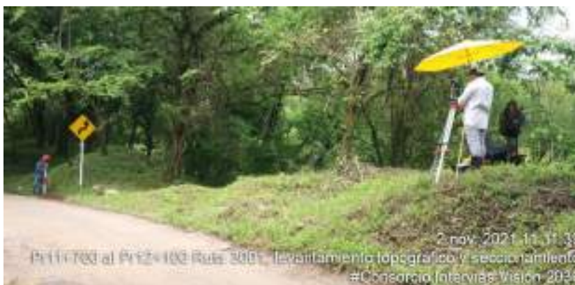
Fotografía 36. PR11+380.Ruta 3001 Localización y replanteo.
