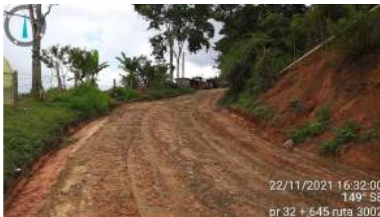
Fotografía 53. Ruta 3002 PR 32+645 mejoramiento de la vía sin adición de material
