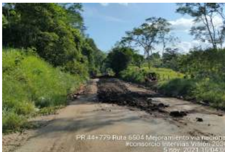
Fotografía 2. PR44+779 Ruta 6504, Mejoramiento vía.
