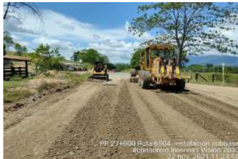
Fotografía 22. PR27+800 Ruta 6504, Instalación Sub Base granular.
