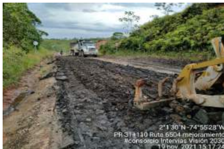
Fotografía 12. PR31+110 Ruta 6504, Conformación sub Rasante.
