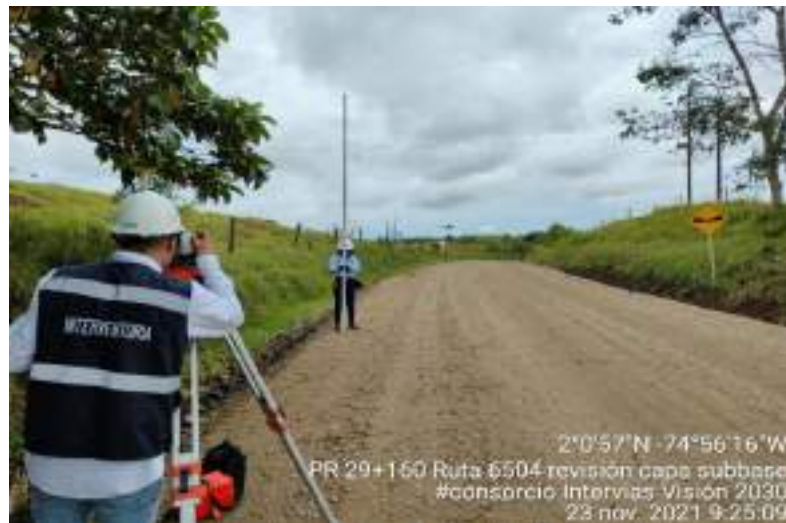
Fotografía 27. PR29+160 Ruta 6504, Nivelación terminado capa Sub Base granular.
