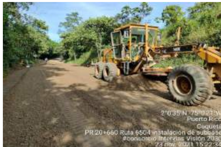
Fotografía 26. PR20+660, Ruta 6504, Instalación capa Sub Base granular.
