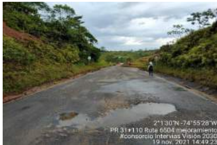
Fotografía 11. PR31+110 Ruta 6504, Tramos a intervenir.
