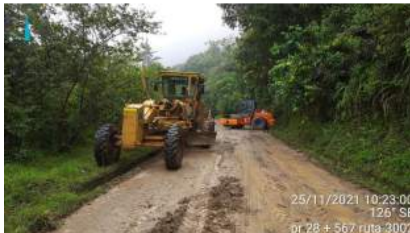
Fotografía 66. PR28+567 ruta 3002 mantenimiento de subrasante
