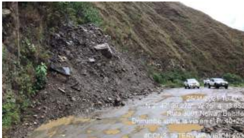
Fotografía 62. PR40+250 ruta 3001 supervisión a labores de remoción de derrumbe
