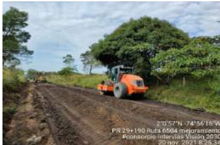
Fotografía 9. PR29+190 Ruta 6504, Conformación Sub Rasante.
