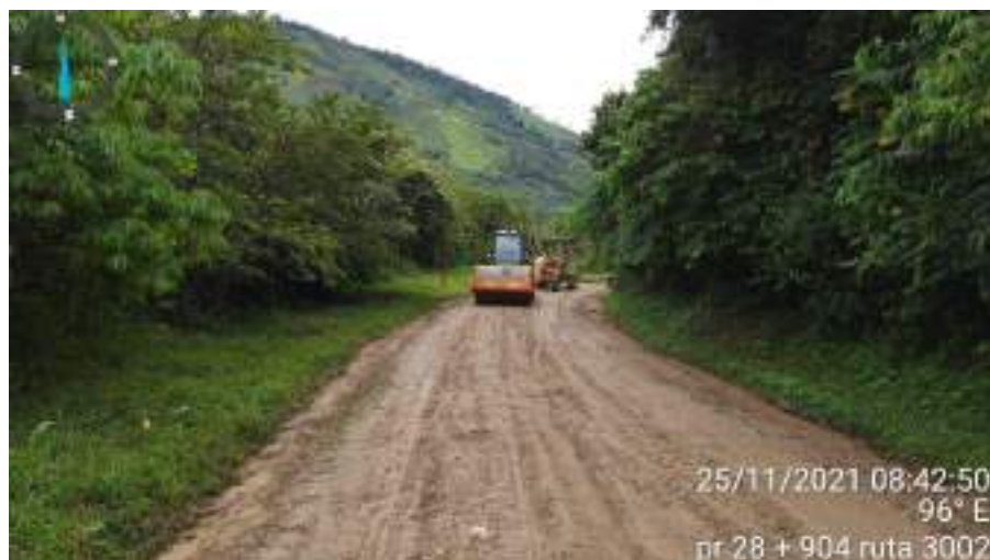
Fotografía 64. PR28+904 ruta 3002 mantenimiento de subrasante
