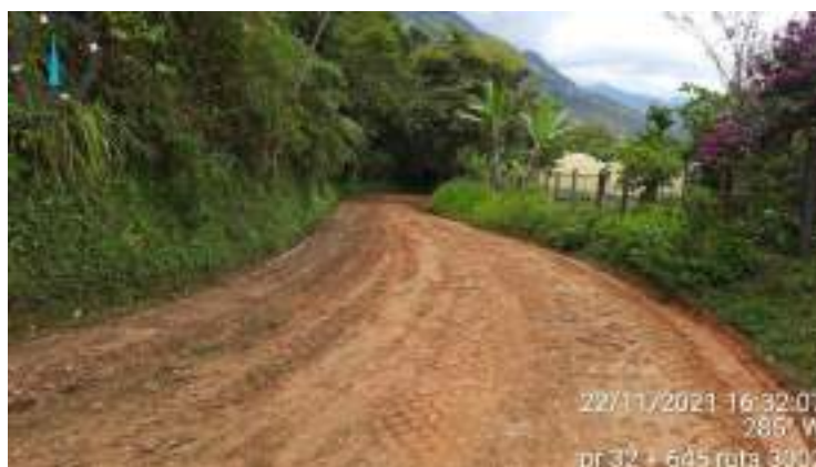
Fotografía 52. Ruta 3002 PR 32+645 mejoramiento de la vía sin adición de material
