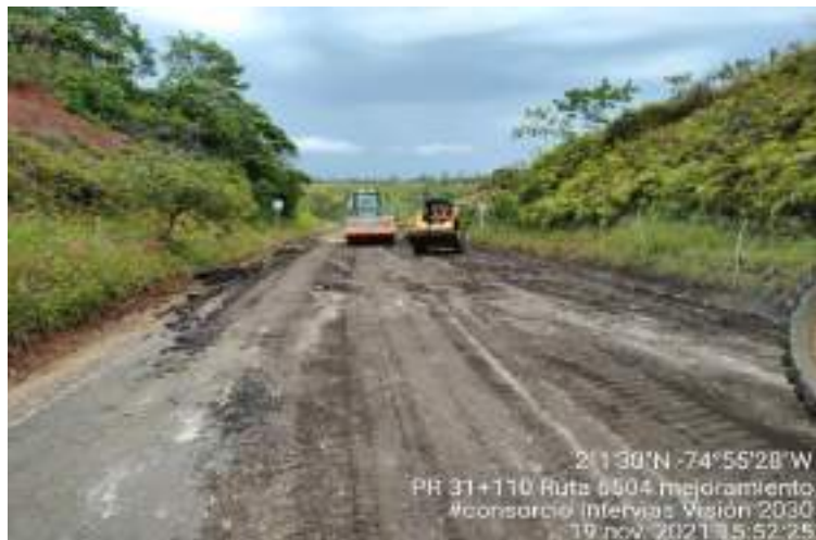
Fotografía 13. PR31+110 Ruta 6504, Conformación sub Rasante.
