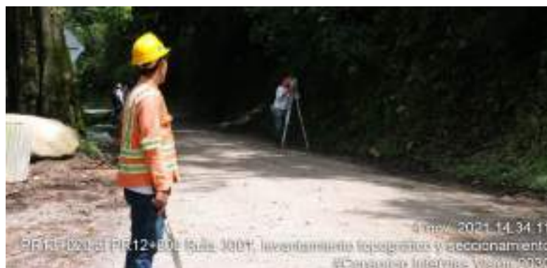
Fotografía 39. PR13+020 al PR12+800 Ruta 3001, levantamiento topográfico y seccionamiento.
