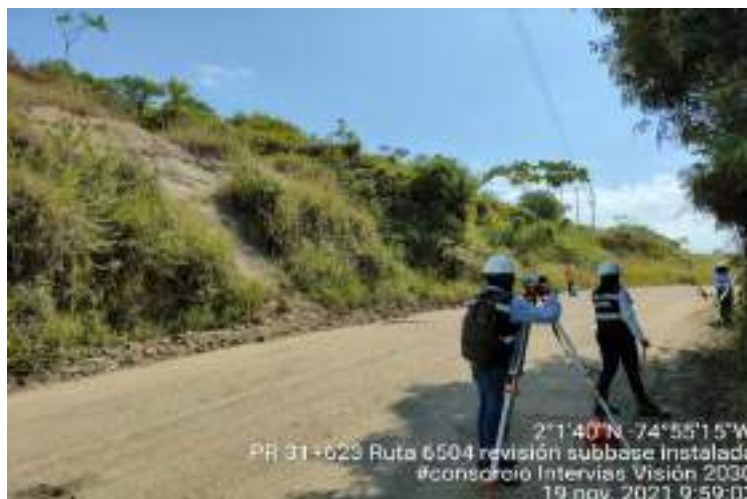
Fotografía 17. PR31+623 Ruta 6504, Nivelación terminado capa Sub Base granular.
