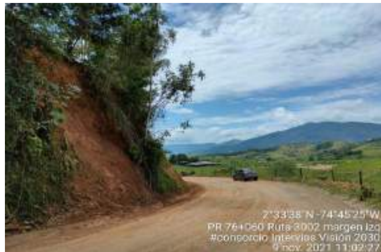
Fotografía 34. PR76+060 Ruta 3002, Remoción de derrumbes.
