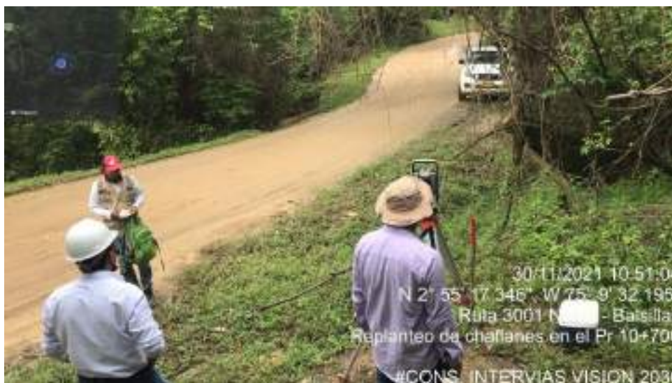
Fotografía 74. PR10+700 ruta 3001 replanteo de la vía con chaflane
