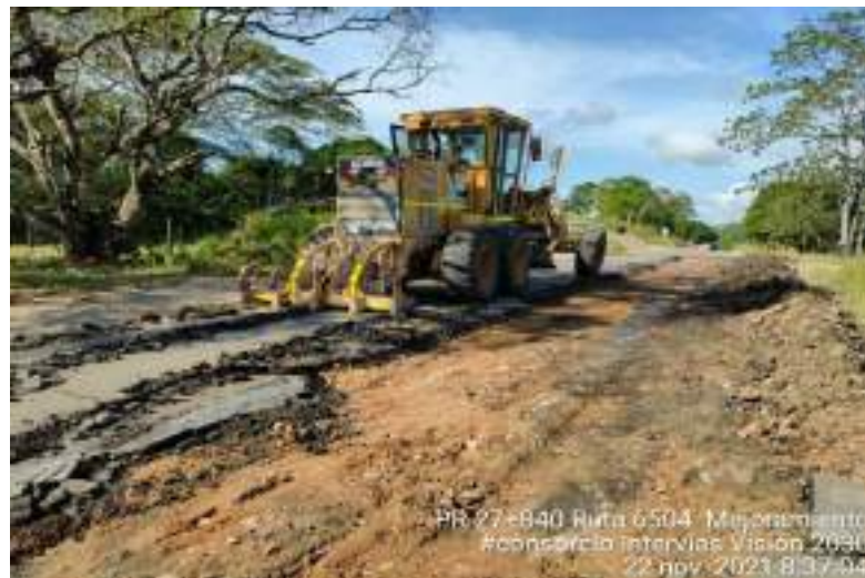
Fotografía 21. PR27+840 Ruta 6504, Escarificación terreno.
