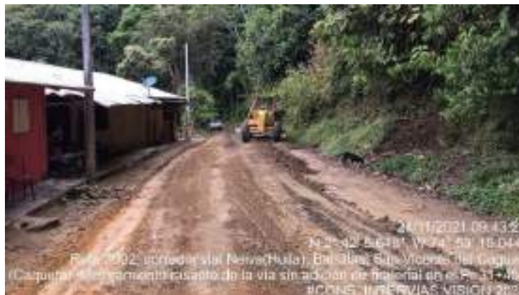
Fotografía 57. Ruta 3002, Mejoramiento subrasante de la vía sin adición de material.
