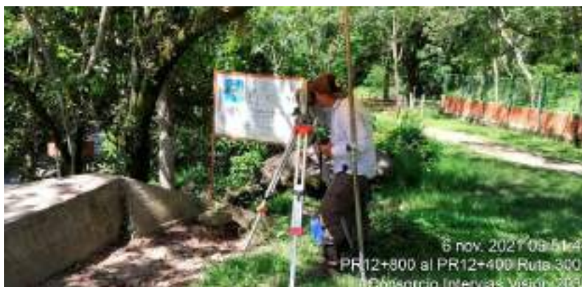
Fotografía 40. PR12+800 al PR12+400 Ruta 3001, levantamiento topográfico y seccionamiento.
