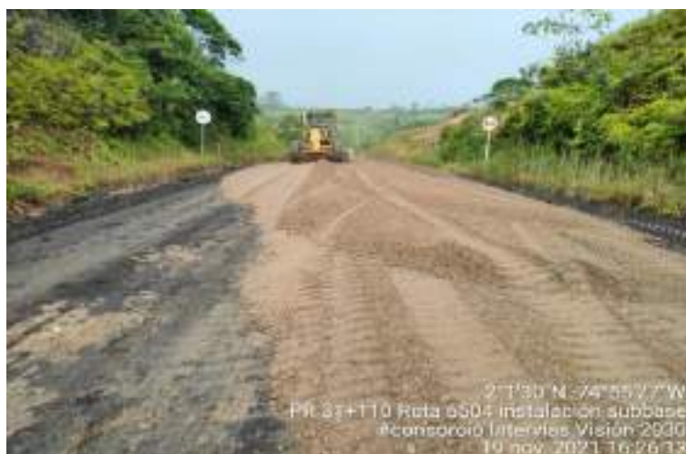
Fotografía 14. PR31+110 Ruta 6504, Instalación Sub Base granular.
