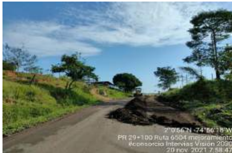
Fotografía 3. PR29+100 Ruta 6504, Escarificación, mejoramiento vía.
