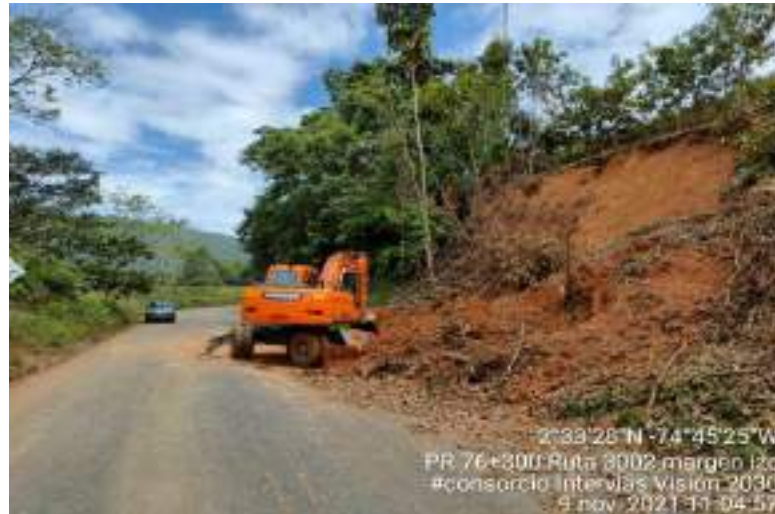
Fotografía 33. PR76+300 Ruta 3002, Remoción de derrumbes.
