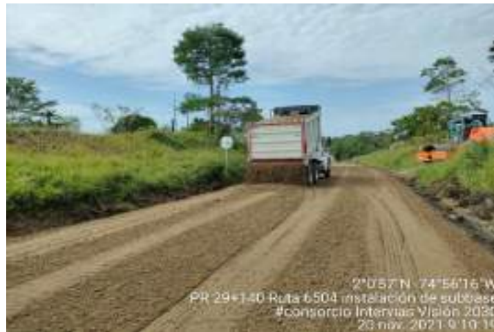
Fotografía 7. PR29+140 Ruta 6504, Instalación Sub Base granular.
