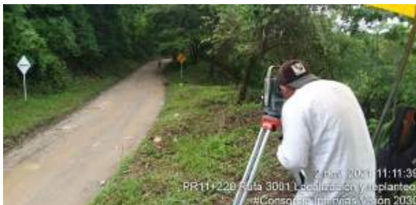
Fotografía 35. PR11+220 Ruta 3001 Localización y replanteo.
