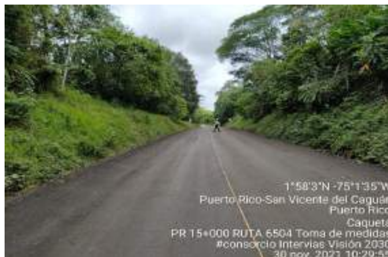
Fotografía 30. PR15+000, Ruta 6504, Mejoramiento.
