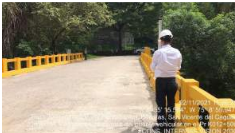
Fotografía 50. PR12+500 Ruta 3001 Verificación de niveles puente vehicular
