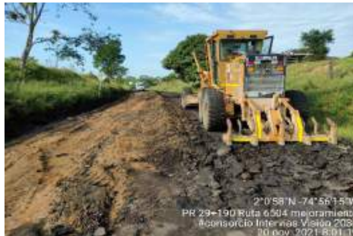
Fotografía 8. PR29+190 Ruta 6504, Escarificación terreno.
