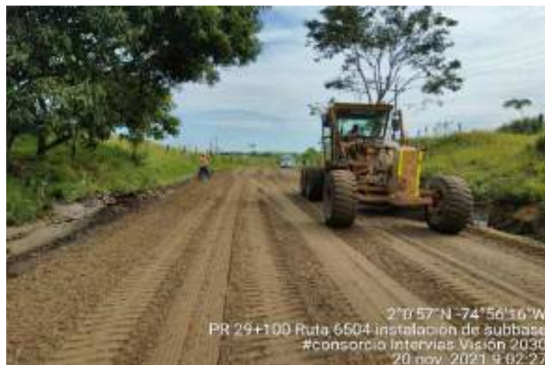
Fotografía 4. PR29+100 Ruta 6504, Instalación SubBase granular.
