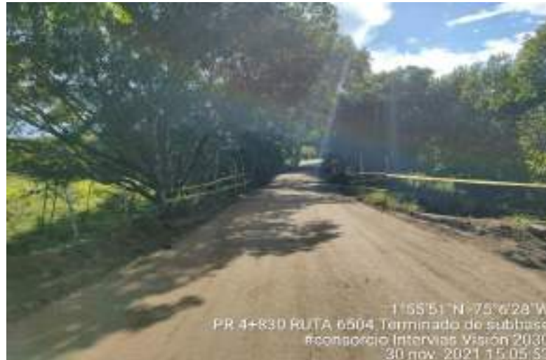
Fotografía 29. PR04+830 Ruta 6504, Sub Base granular.
