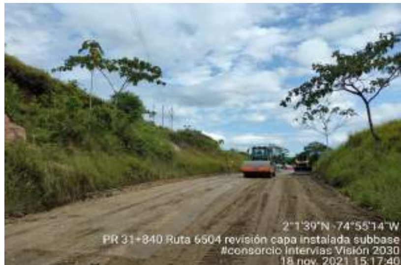
Fotografía 16. PR31+840 Ruta 6504, Compactación capa Sub Base granular instalada.
