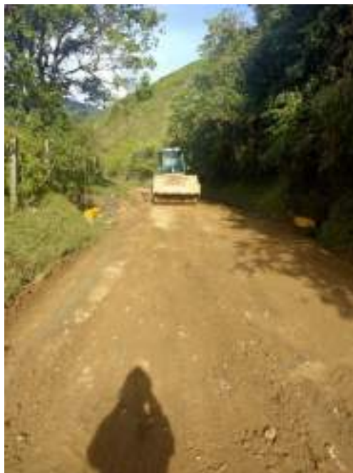
Fotografía 72. PR21 ruta 3001 mantenimiento de subrasante
