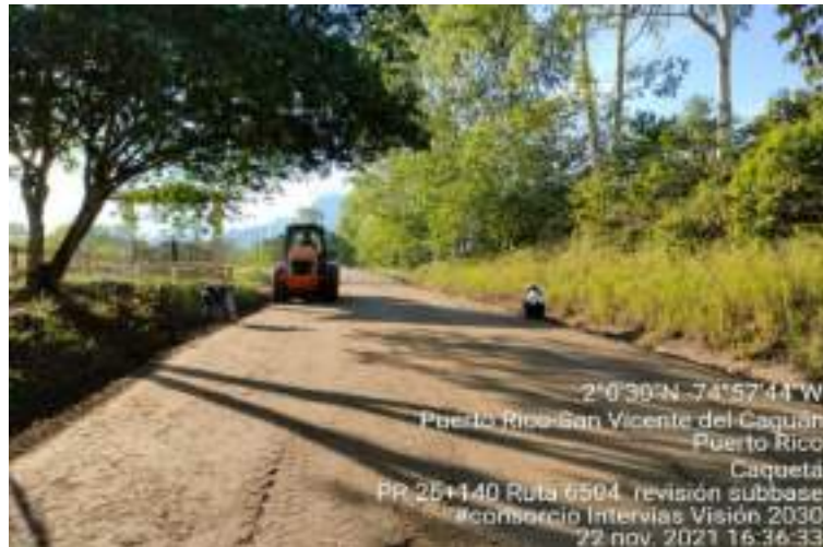
Fotografía 23. PR26+140 Ruta 6504, Sub Base granular.
