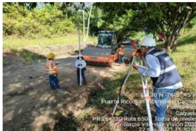
Fotografía 24. PR26+130 Ruta 6504, Nivelación Sub Rasante.
