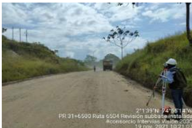
Fotografía 18. PR31+650, Ruta 6504, Nivelación terminado capa Sub Base granular.
