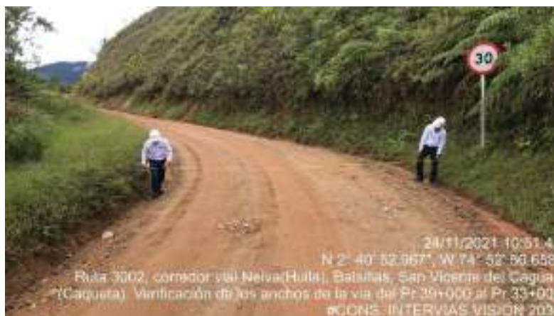
Fotografía 58. PR 33+000 Ruta 3002 verificación de medidas – ancho vía
