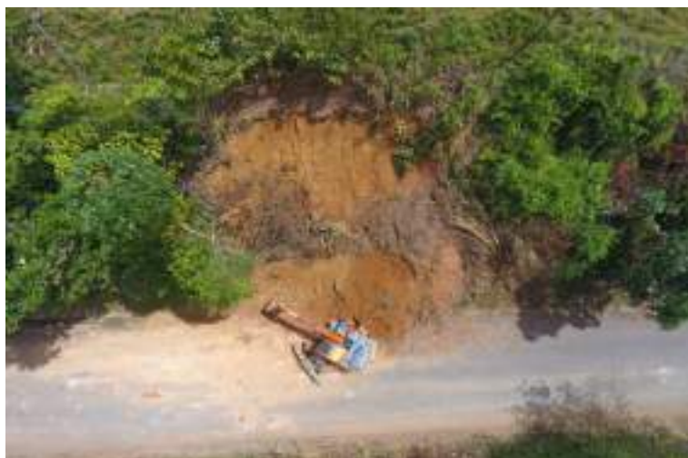
Fotografía 32. PR76+300, Ruta 3002, Remoción de derrumbes.
