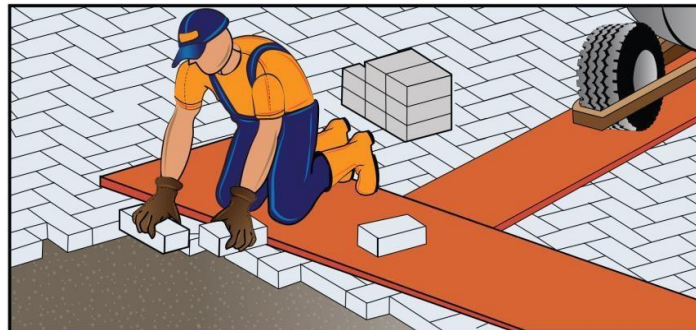
Figura 12. Colocación de los tramos del pavimento
